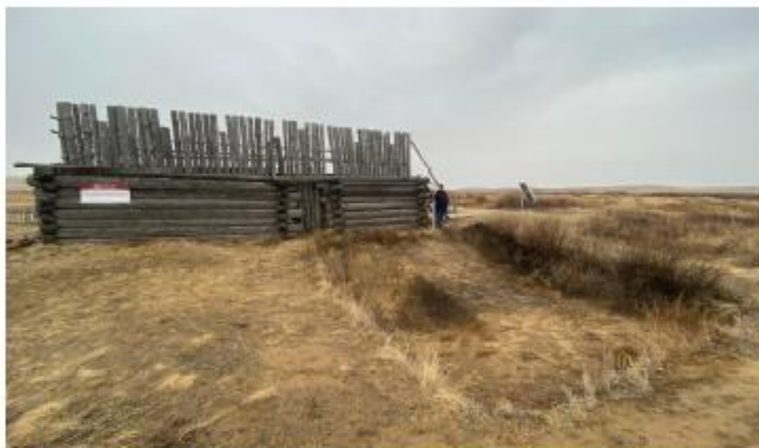
ОКН №3 «Укрепленное поселение «Аркаим». Музеефицированный раскоп. Вид на внешний ров и реконструкцию внешней стены
