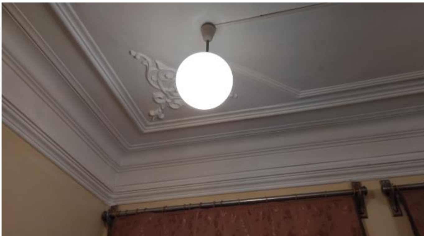
Фото 21. Интерьер выявленного объекта культурного наследия «Особняк купеческий», расположенного по адресу: Челябинская область, Миасский городской округ, г. Миасс, ул. Ленина, 6.
