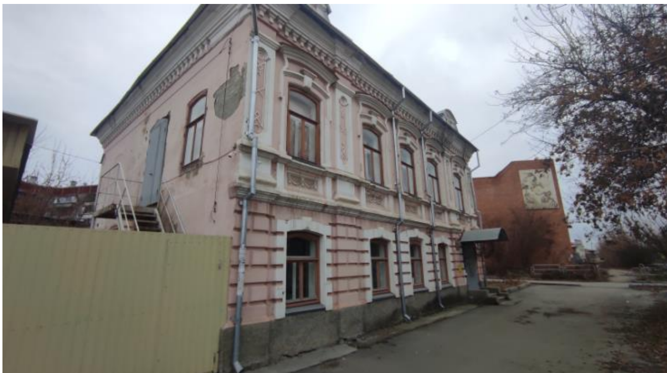
Фото 3. Вид на выявленный объект культурного наследия «Особняк купеческий», расположенный по адресу: Челябинская область, Миасский городской округ, г. Миасс, ул. Ленина, 6.
