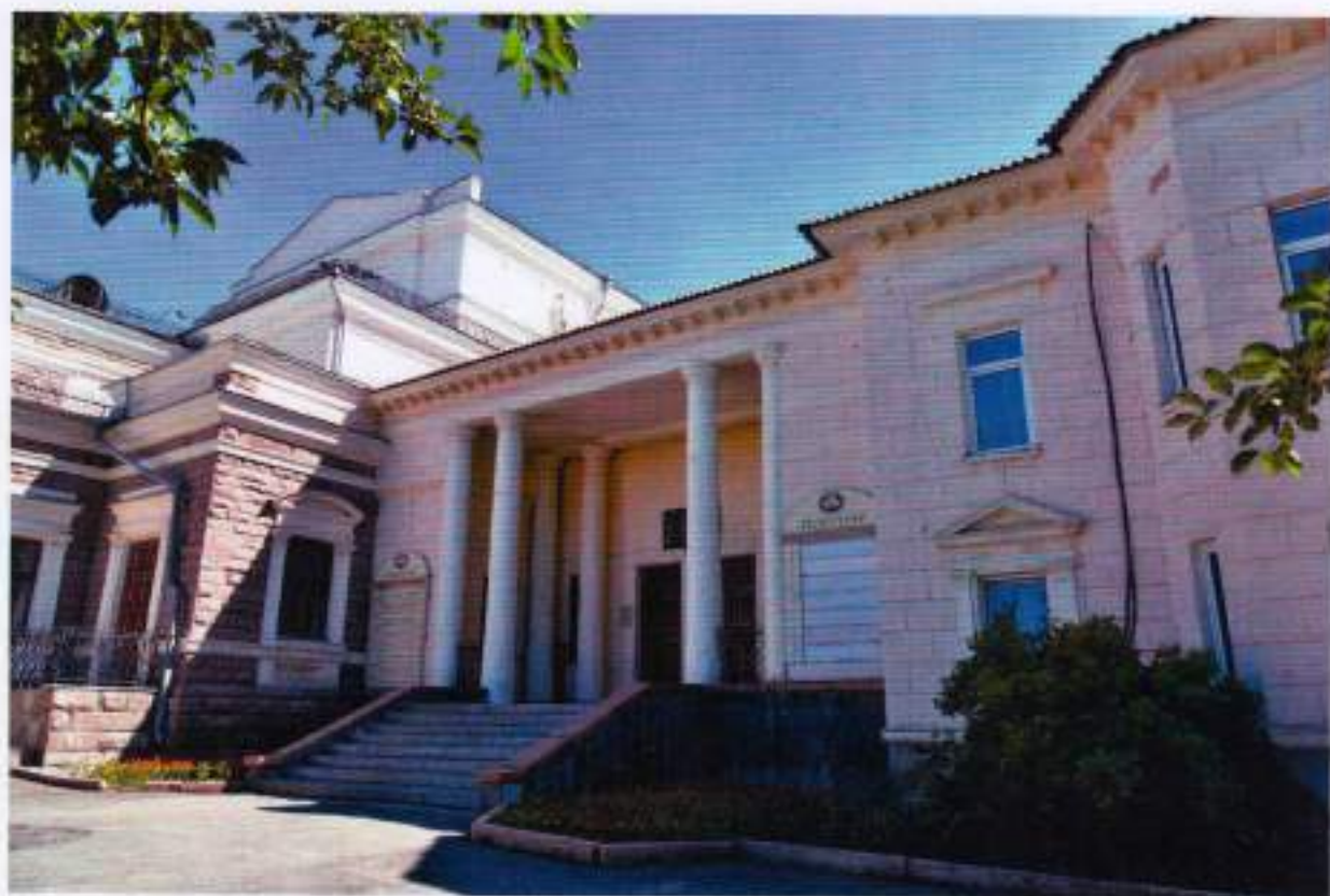
Рисунок 17. Здание объекта культурного наследия «Дом жилой для артистов с колонным портиком». Фото 2014 г.
