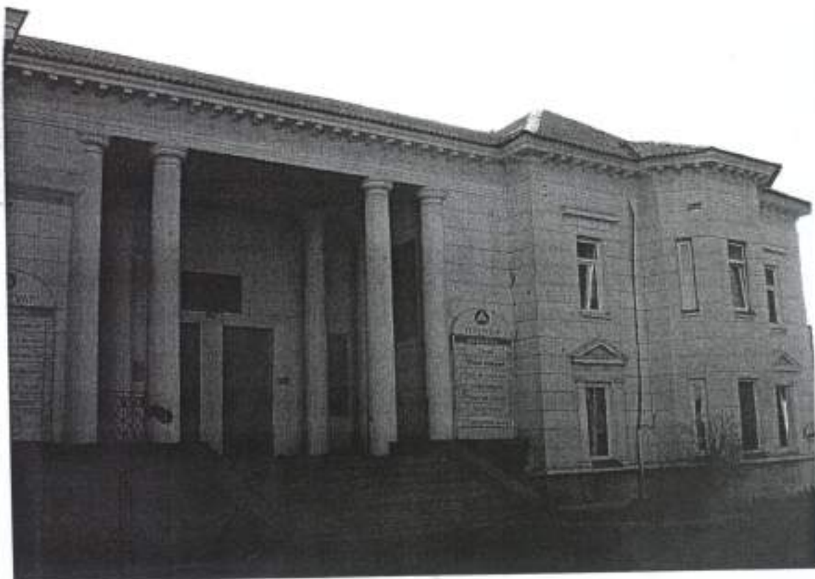
14. Здание театральных касс. Лицевой фасад. Соединение с жилым домом.
