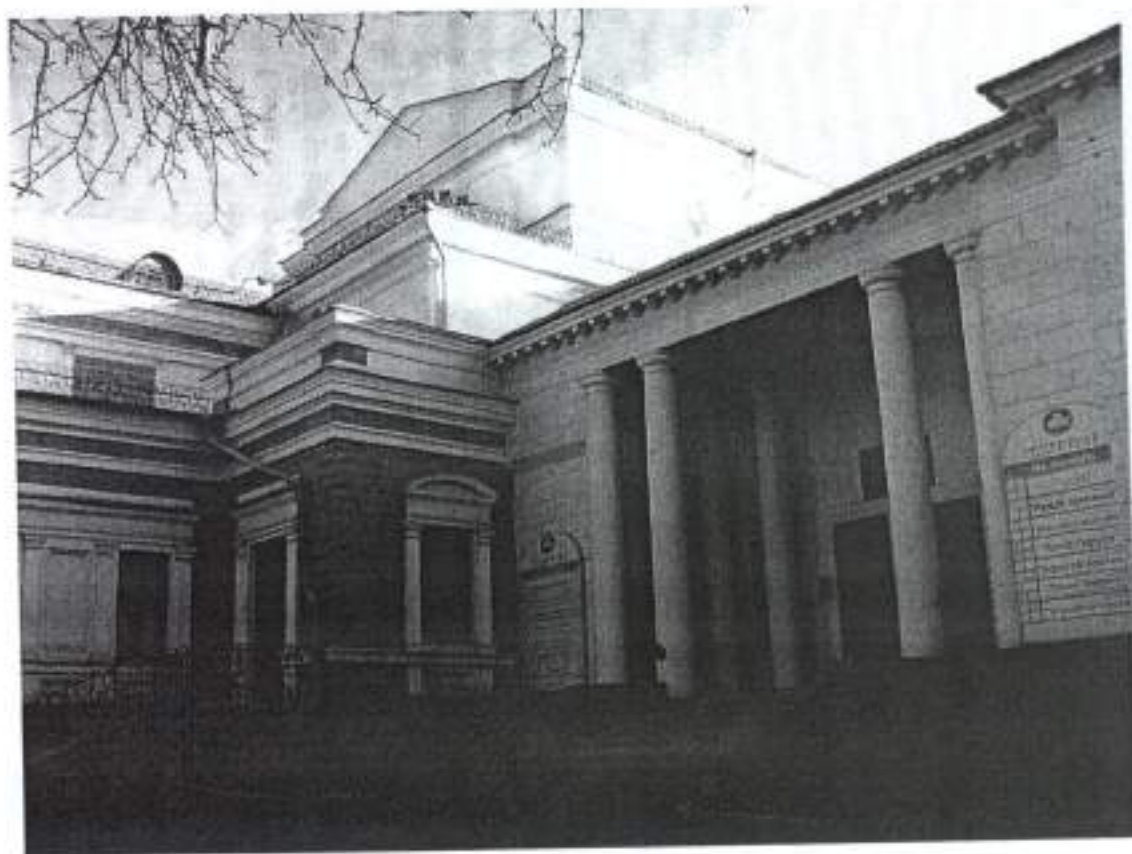
15. Здание театральных касс. Лицевой фасад. Вид с северо-запада. Соединение с театром.
