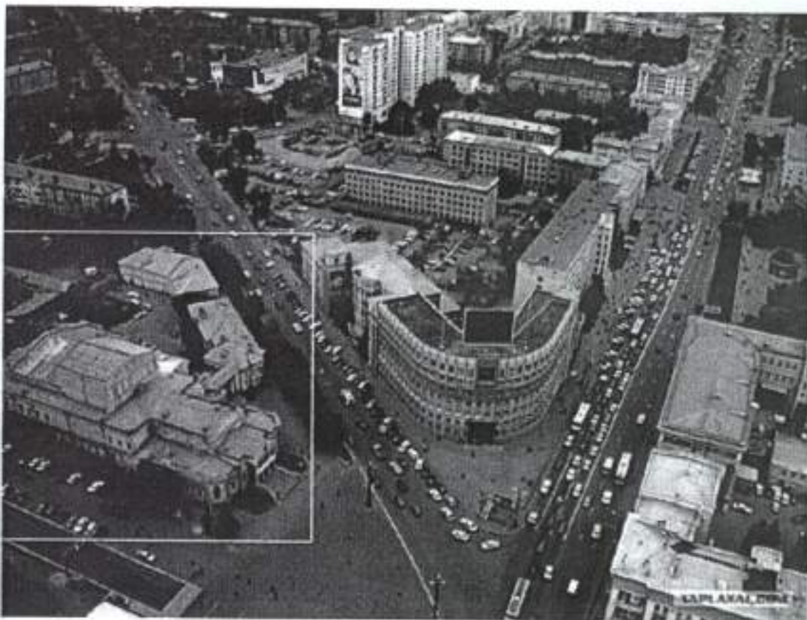
5. Общий вид с северо-востока территории ансамбля «Городской театр».
