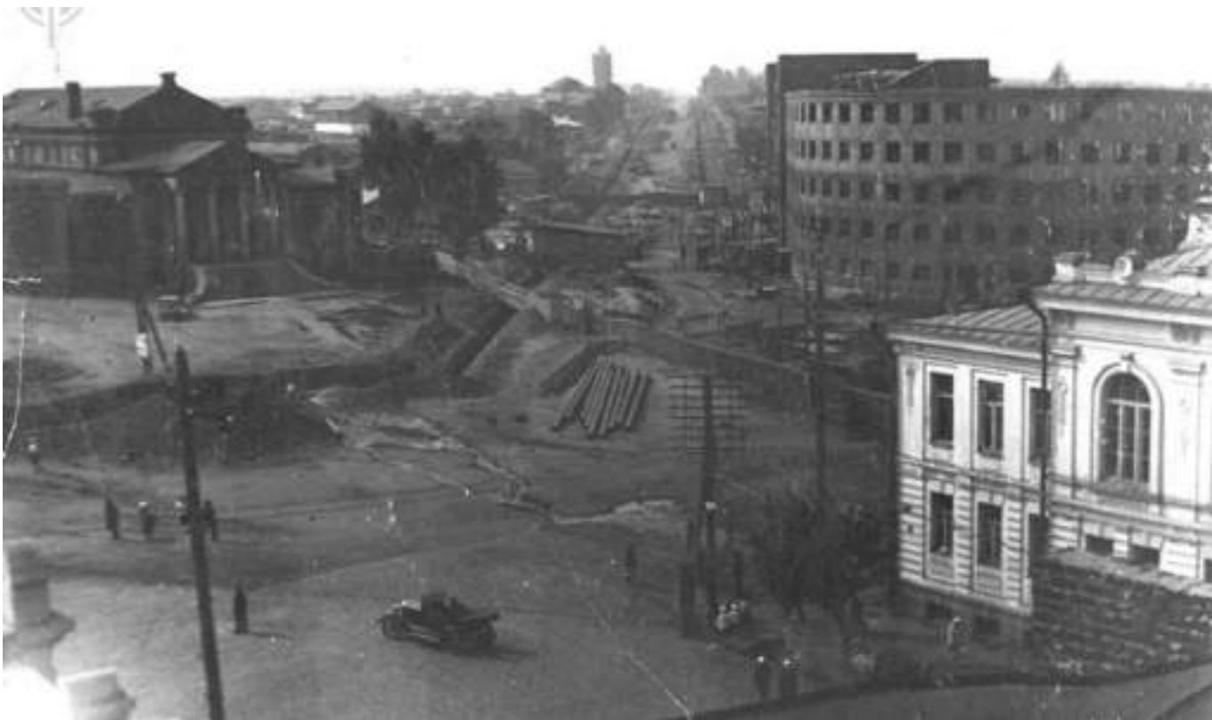
Начало 1930-х гг. Челябинск. Улица Воровского. Народный дом и строящееся здание гостиницы.
