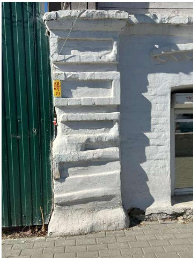
**Рис. 5. Фрагмент главного фасада. Филенчатая лопатка на левом фланге первого этажа**
