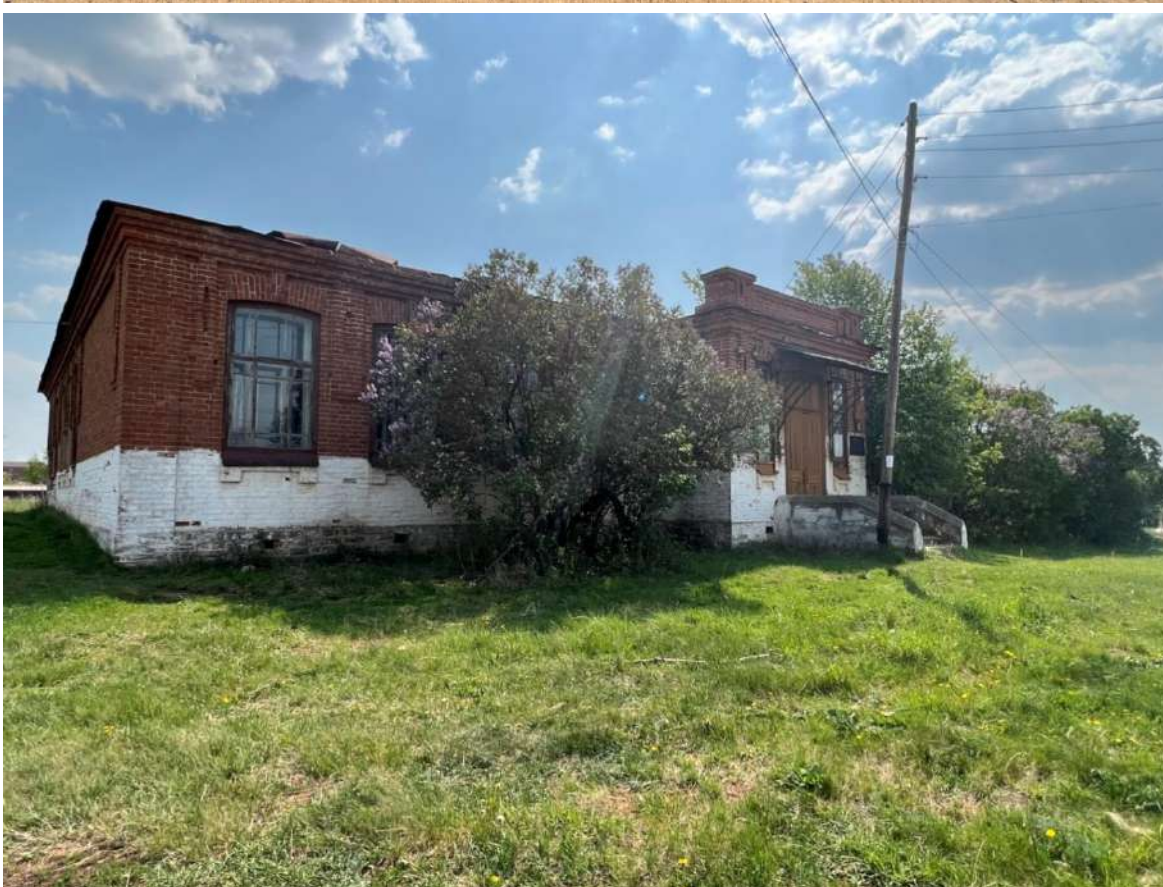
Рис. 3 а, б. Главный, северный фасад. Вид с северо-запада (вверху) и северо-востока (внизу)
