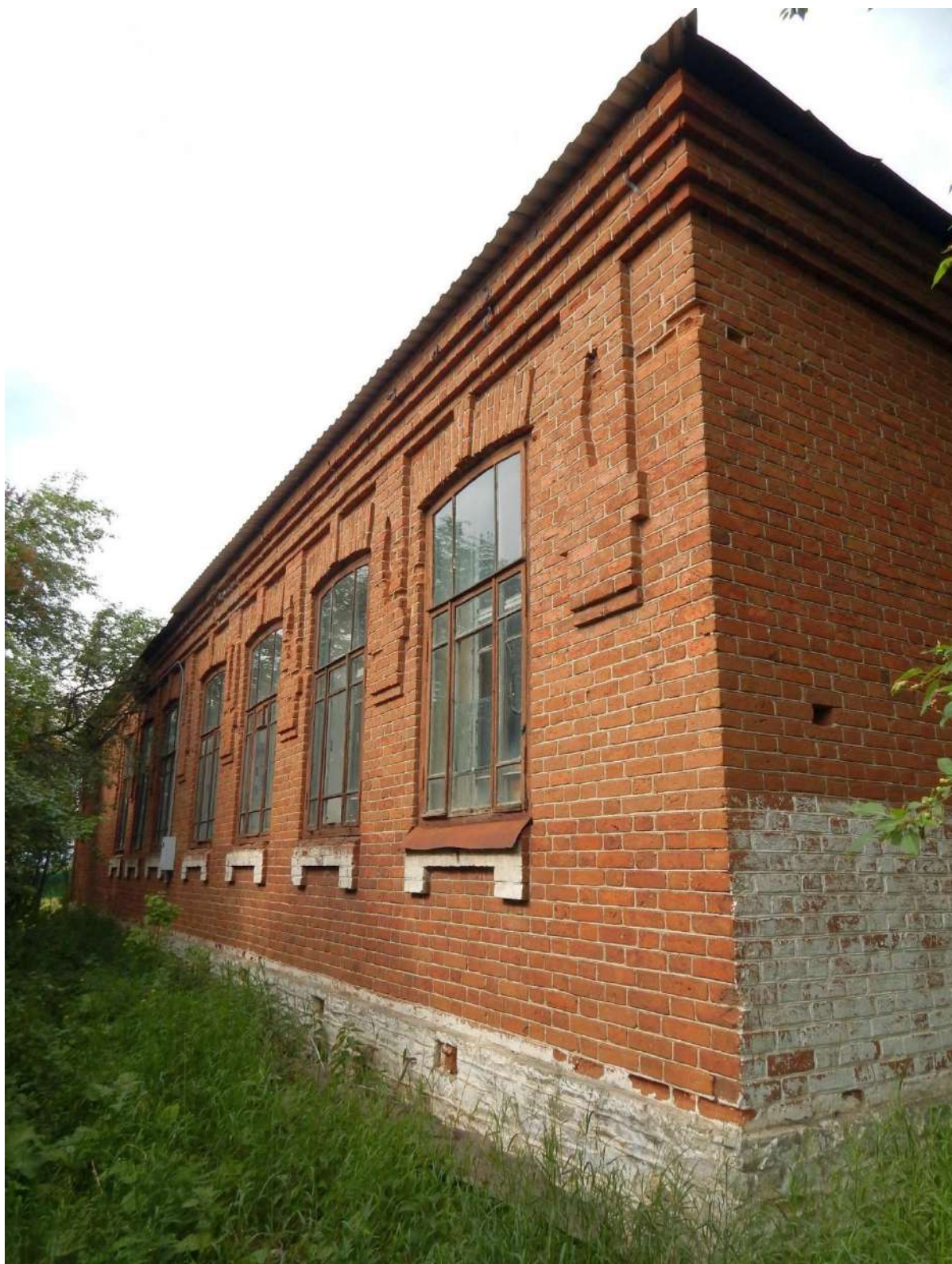
Рис. 7. Боковой, западный фасад. Вид юго-запада
