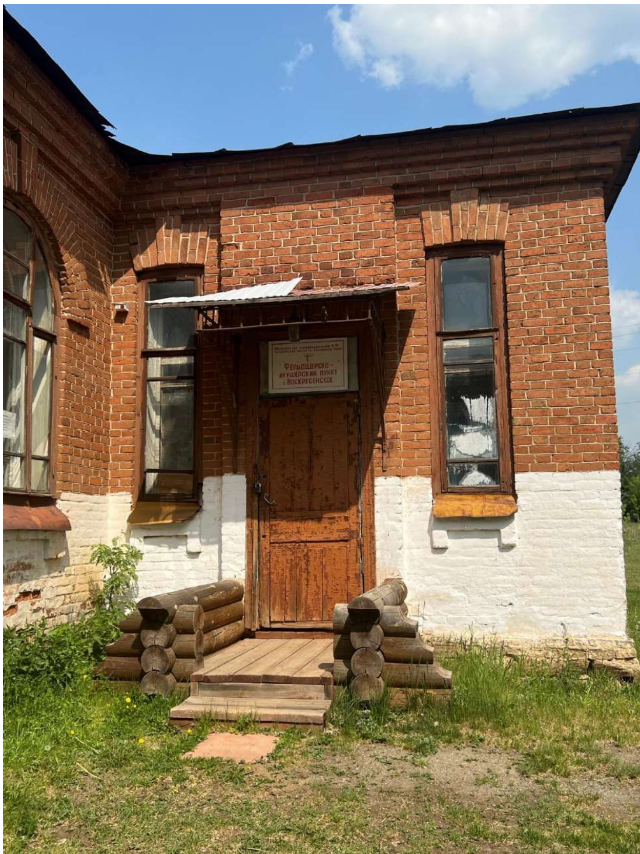
Рис. 10. Дополнительный вход со стороны южного, дворового фасада
