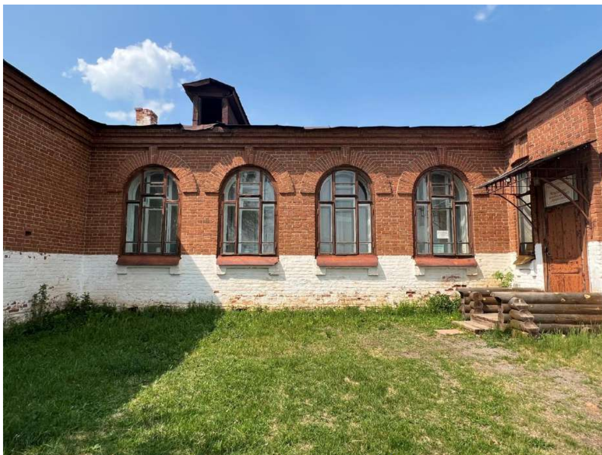
Рис. 9. Фрагмент южного, дворового фасада. Оконные проемы зала-рекреации
