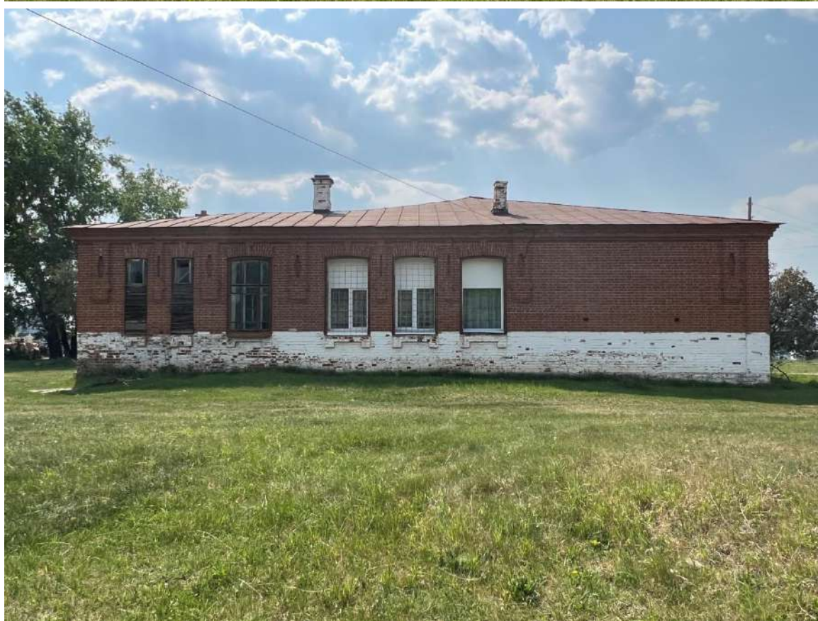
Рис. 6. Боковой, восточный фасад. Вид с юго-востока (вверху) и востока (внизу)
