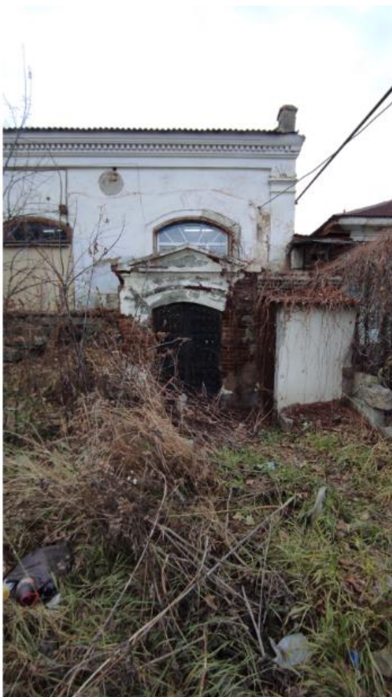
Фото 14. Вид на выявленный объект культурного наследия «Дом жилой», расположенный по адресу: Челябинская область, Миасский городской округ, г. Миасс, пл. Труда.
