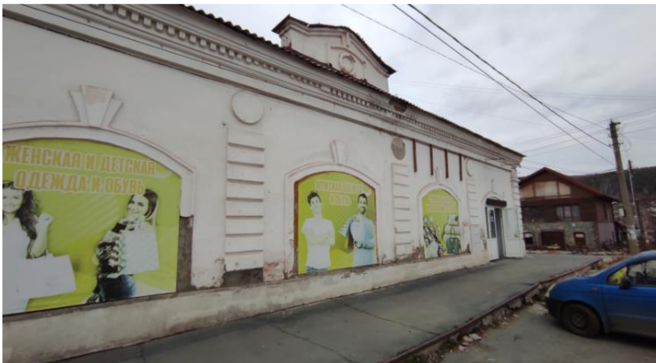
Фото 3. Вид на выявленный объект культурного наследия «Дом жилой», расположенный по адресу: Челябинская область, Миасский городской округ, г. Миасс, пл. Труда.
