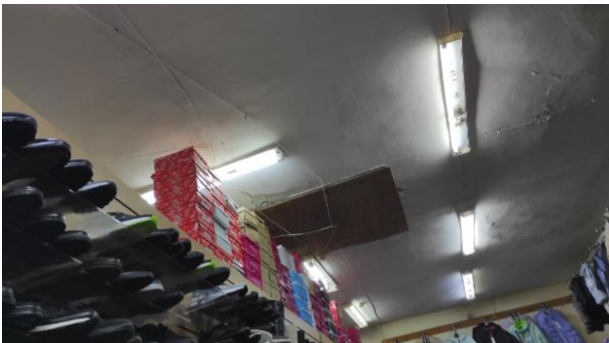
Фото 18. Интерьер выявленного объекта культурного наследия «Дом жилой», расположенного по адресу: Челябинская область, Миасский городской округ, г. Миасс, пл. Труда.
