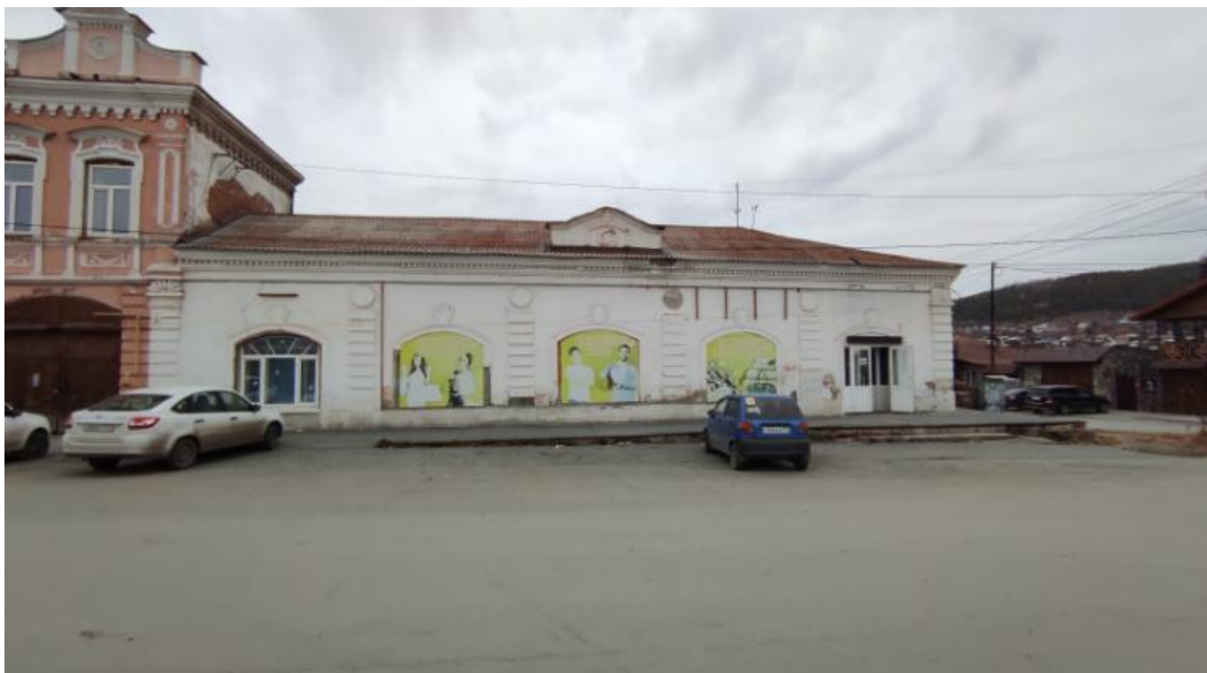
Фото 1. Вид на выявленный объект культурного наследия «Дом жилой», расположенный по адресу: Челябинская область, Миасский городской округ, г. Миасс, пл. Труда.
