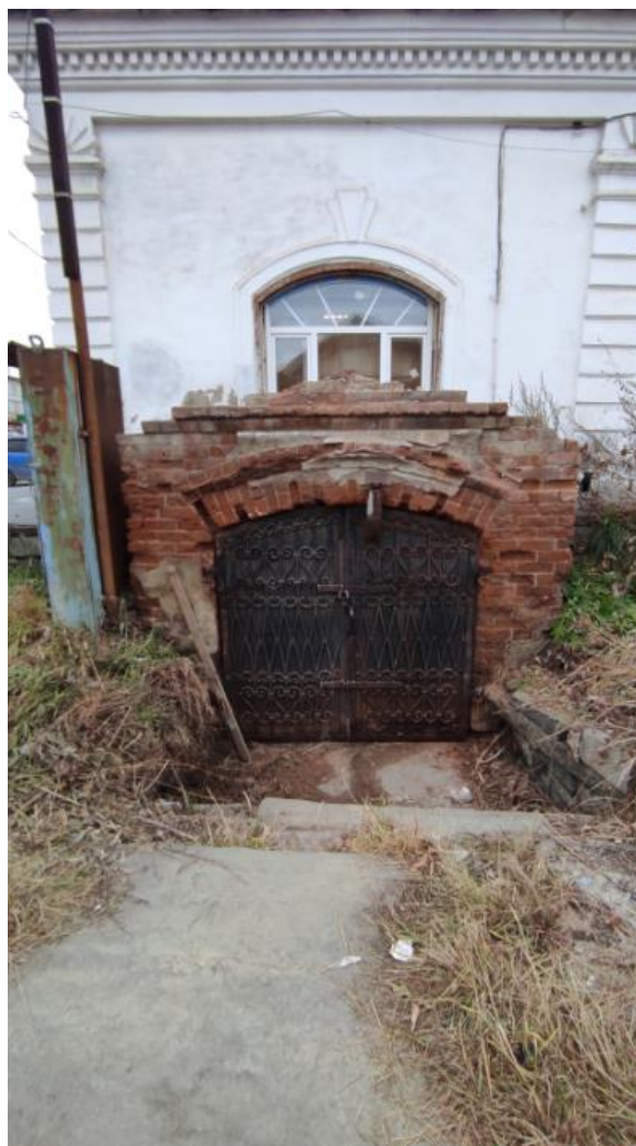
Фото 10. Вид на выявленный объект культурного наследия «Дом жилой», расположенный по адресу: Челябинская область, Миасский городской округ, г. Миасс, пл. Труда.
