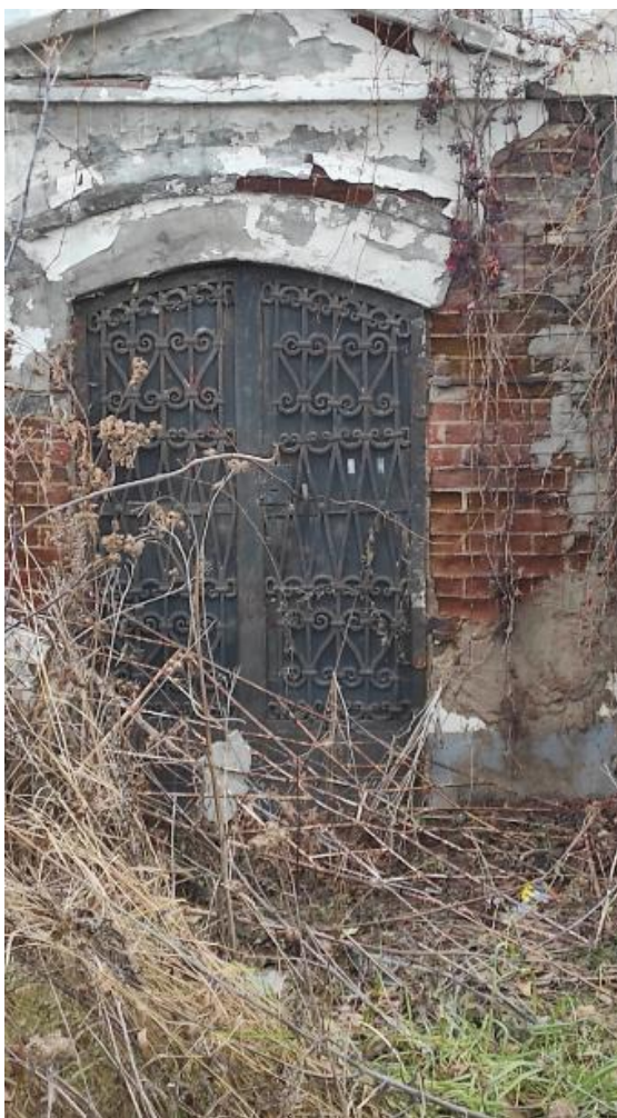
Фото 13. Вид на выявленный объект культурного наследия «Дом жилой», расположенный по адресу: Челябинская область, Миасский городской округ, г. Миасс, пл. Труда.
