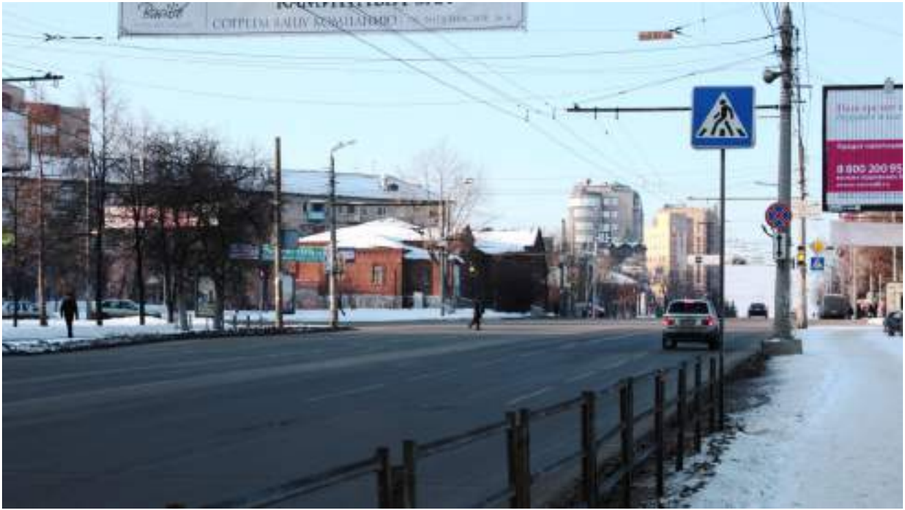
Рис.2. Общий вид на здание-памятник и прилегающую застройку с севера с улицы Воровского (фото авторов, март 2012 г.).
