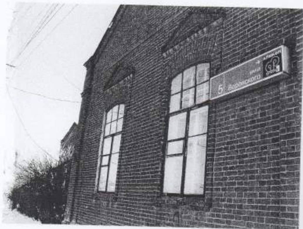
Фото 9. Фрагмент северного фасада (вид на окна с лучковым завершением)
