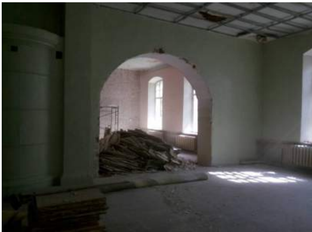
Рис.76. Здание по ул. Воровского, 5. Интерьеры здания. (Фото – 2018 г.) Ссылка: https://ic.pics.livejournal.com/yuvlatyshev/22714000/3174901/3174901_800.jpg .
