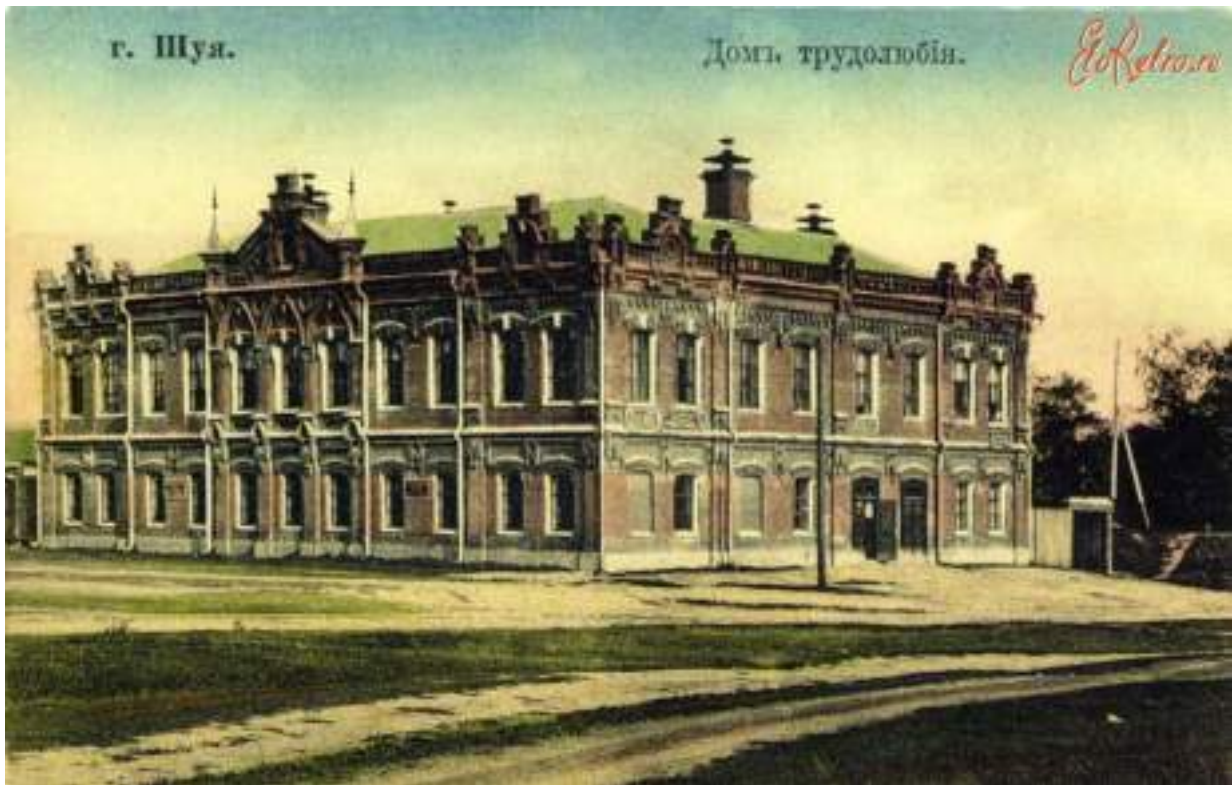
Рис.84. Город Шуя, Покровская площадь. Дом трудолюбия им. С.П. Гессе (открыт к 1900 г.) (Фото – нач. XX в.). Ссылка: https://www.etoretro.ru/data/media/581/13692877026d6.jpg .
