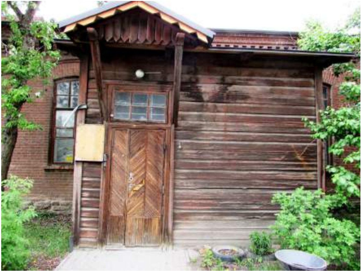
Рис.14. Исторический деревянный пристрой со служебным входом (фото авторов, май 2020г.).
