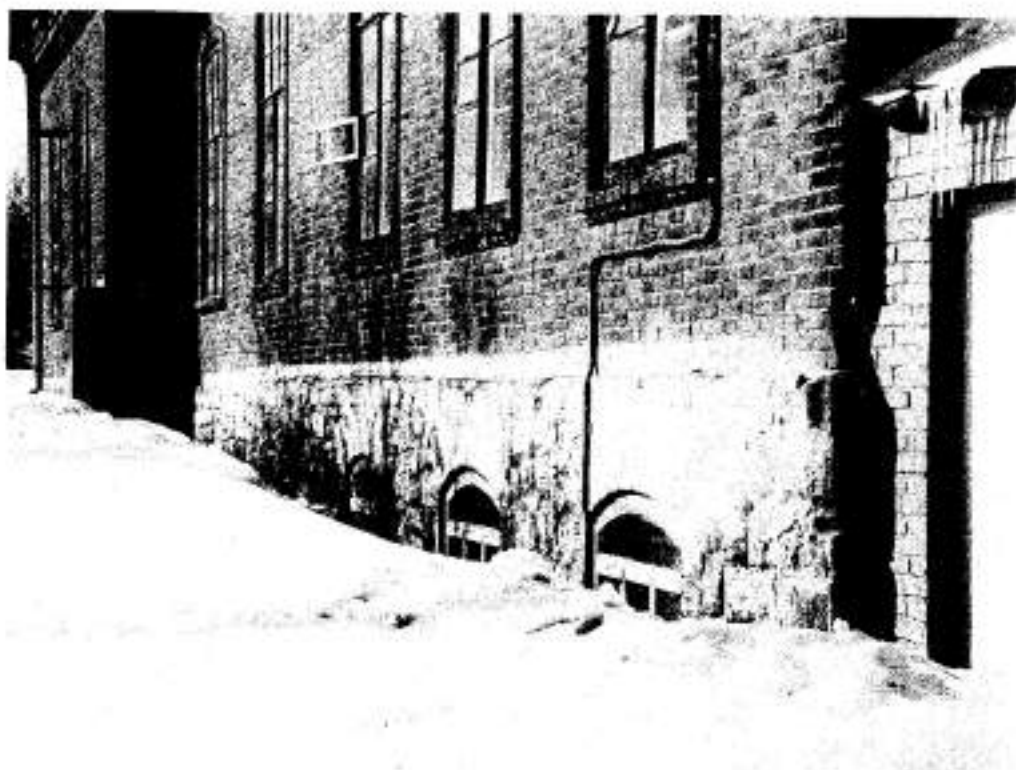
Фото 7. Вид на цокольную часть южного фасада здания
