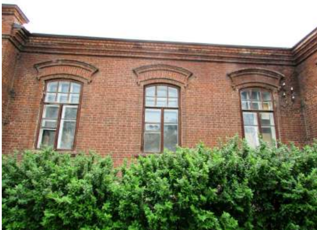
Рис.11. Центральная часть главного фасада (фото авторов, май 2020 г.).
