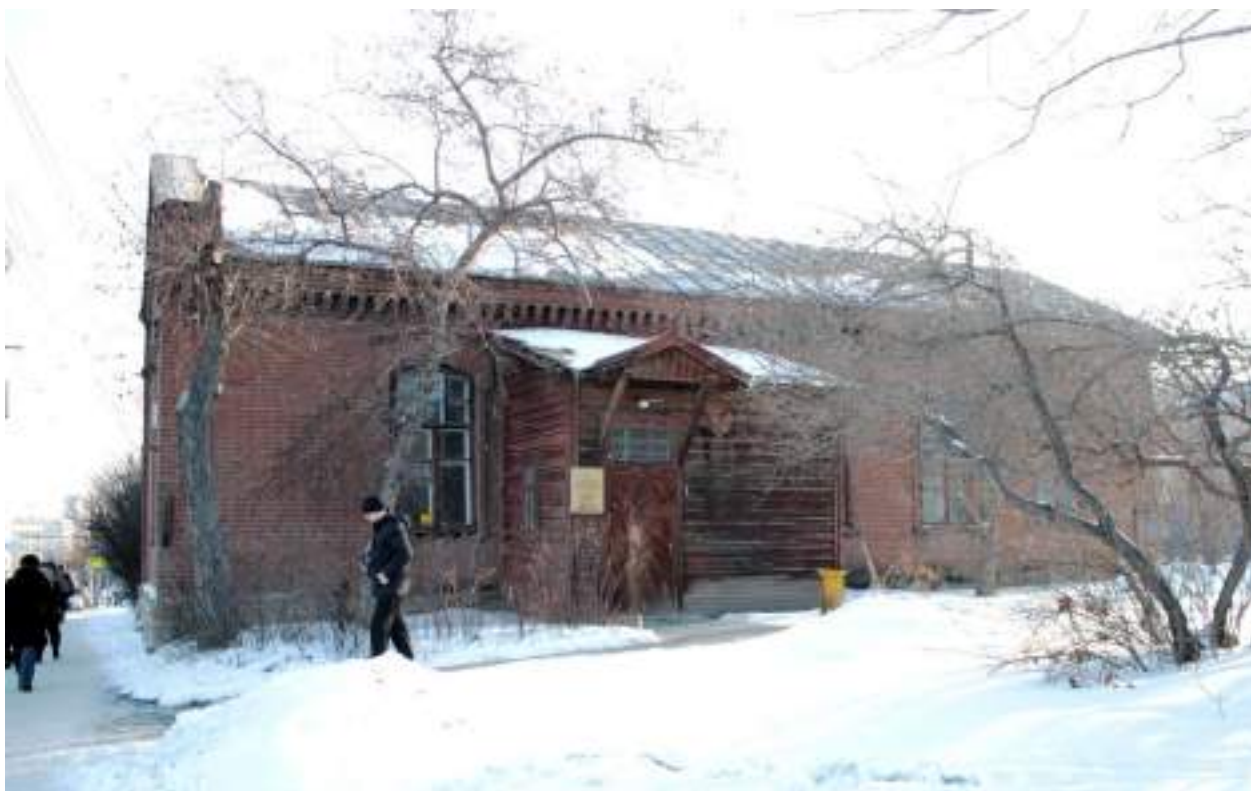
Рис.13. Юго-западный фасад (фото авторов, март 2012 г.).
