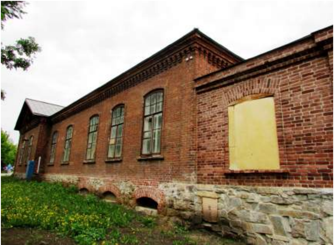
Рис.16. Юго-восточный фасад (фото авторов, май 2020 г.).
