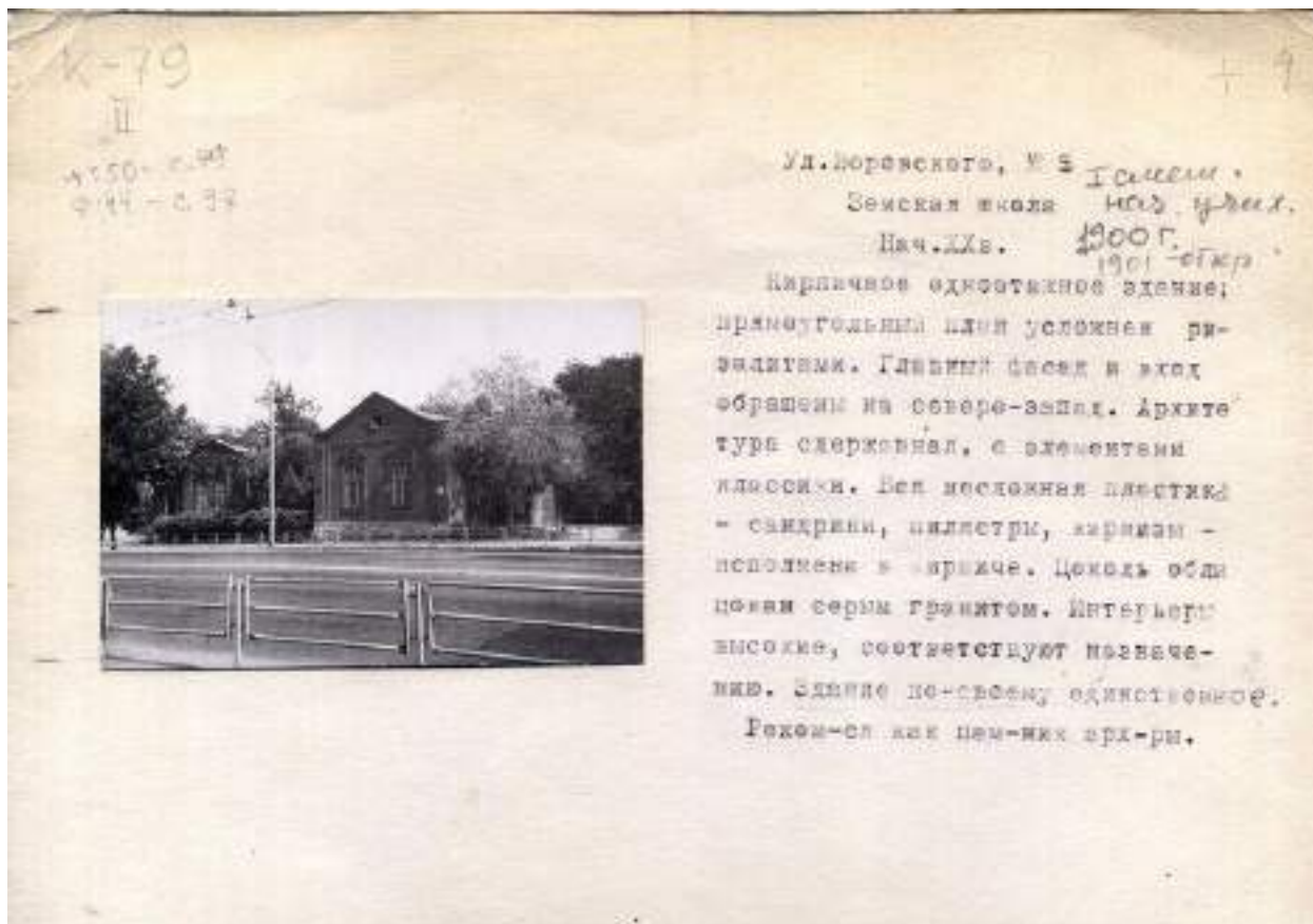
Рис.40. Учетная карточка по зданию по ул. Воровского,5 (Земская школа»), 1990 г. Из фонда Центра историко-культурного наследия Челябинска. Ссылка: https://img-fotki.yandex.ru/get/9797/674039.6ab/0_b9e13_4a28c733_XL.jpg .
