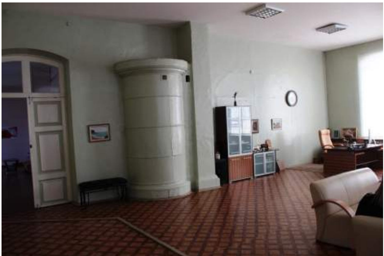
Рис.63. Интерьер юго-восточного помещения. Вид на дверной лучковый проем с деревянной филенчатой дверью, на голландскую печь и на заложенный арочный проем (Фото - 2012г., автор - Маевская Т.И).
