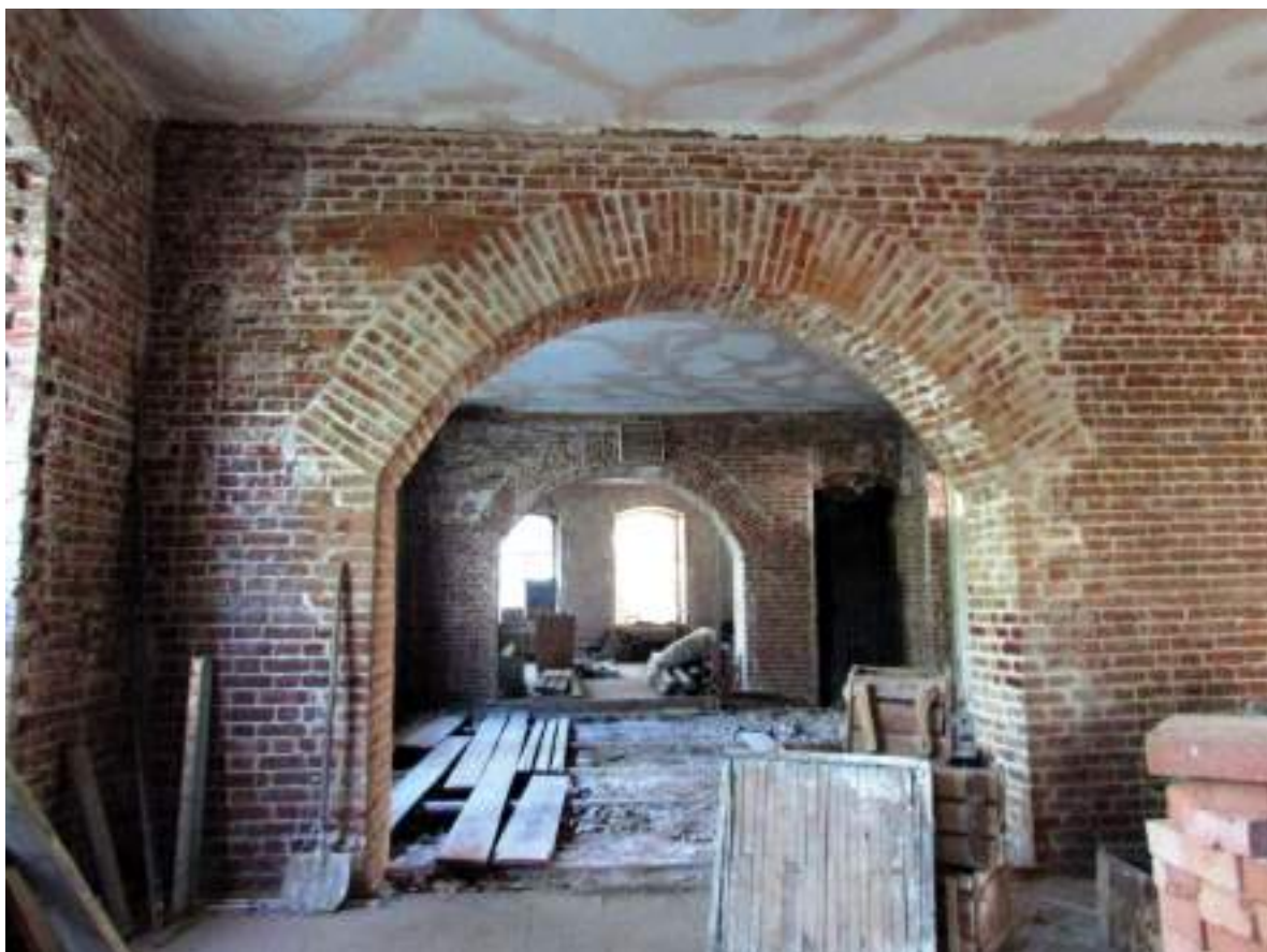
Рис.33. Вид на северо-восточное помещение с расчищенными большими арочными проемами (фото авторов, май 2020 г.).
