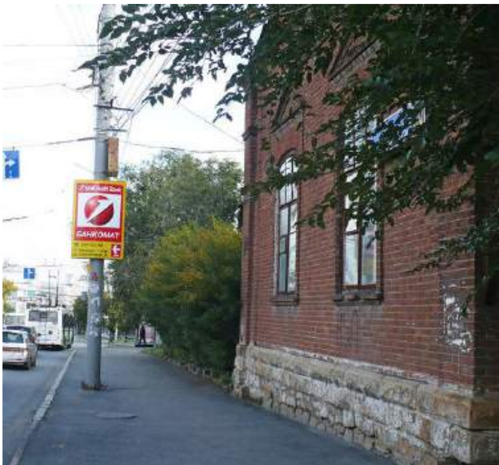
Рис.51. Здание по ул. Воровского, 5. Фрагмент северо-западного (главного) фасада. (Фото – сентябрь 2009 г.) Ссылка: https://img-fotki.yandex.ru/get/3803/ssgen.54/0_3e63b_a636ac51_XL.jpg .
