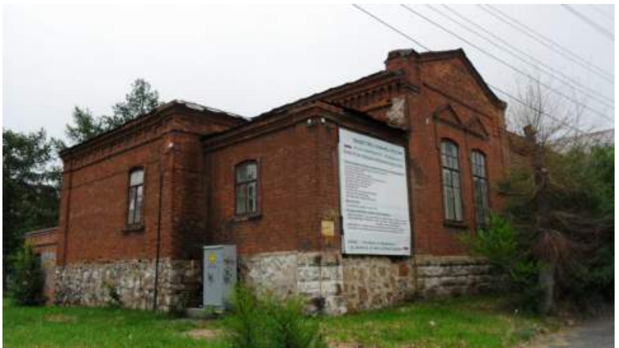
Рис.43. Здание по ул. Воровского, 5. Северо-западный и юго-западный фасады. (Фото – начала 2010-х гг.) Ссылка: http://photos.wikimapia.org/p/00/02/53/09/57_full.jpg .
