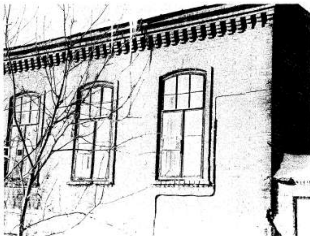
Фото 6. Фрагмент южного фасада (вид на окна с лучковым завершением)
