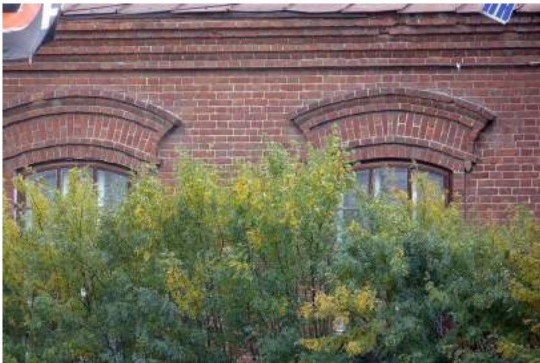
Рис.50. Здание по ул. Воровского, 5. Фрагмент северо-западного (главного) фасада. (Фото – сентябрь 2009 г.) Ссылка: https://img-fotki.yandex.ru/get/3710/ssgen.54/0_3e62d_3120bd4c_XL.jpg .
