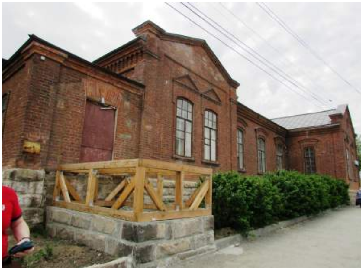
Рис.6. Вид на главный северо-западный фасад с воссоздаваемой главной входной группой с ул. Воровского (фото авторов, май 2020 г.).
