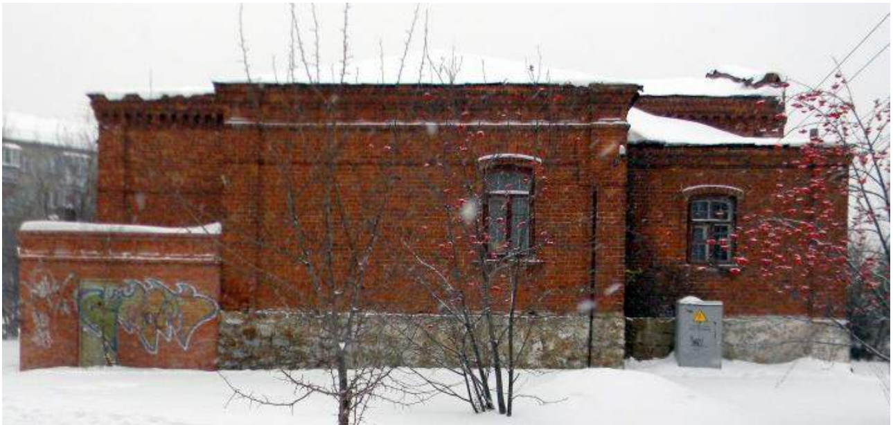
Рис.66. Здание по ул. Воровского, 5. Северо-восточный фасад. (Фото – январь 2013 г., автор – Ю.Латышев) Ссылка: https://ic.pics.livejournal.com/yuvlatyshev/22714000/3171913/3171913_800.jpg .
