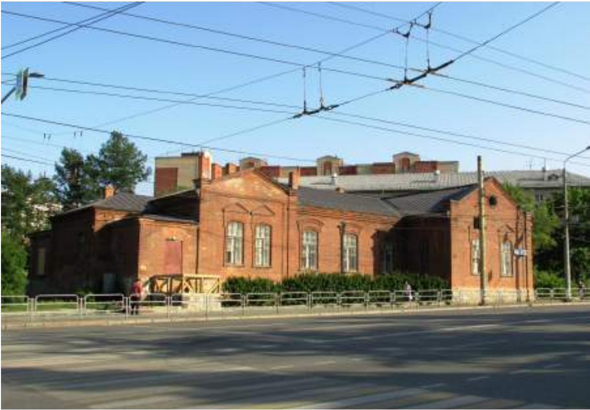
Рис.4. Вид на здание-памятник с севера-запада с ул. Воровского (фото авторов, май 2020г.).
