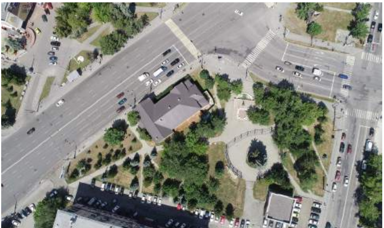
Рис.81. Вид на здание по ул. Воровского,5 и прилегающий к нему сквер сверху (Фото – 2019 г.) Ссылка: https://n1st.ru/cache/realty/photo/f77e5af6147512cc46c08b4ccb56f6_1200_800_p.jpg .
