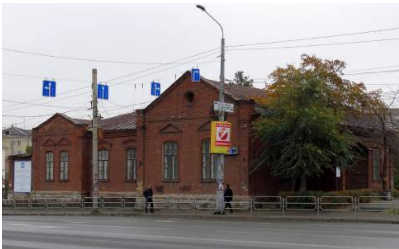
Рис.69. Здание по ул. Воровского, 5. Северо-западный (главный) фасад (Фото – октябрь 2013 г., автор – Ю.В. Латышев) Ссылка: https://i4.photo.2gis.com/images/geo/15/2111062363705144_3401.jpg .
