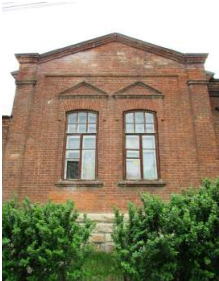
Рис.10. Северо-западный ризалит главного фасада (фото авторов, май 2020 г.).
