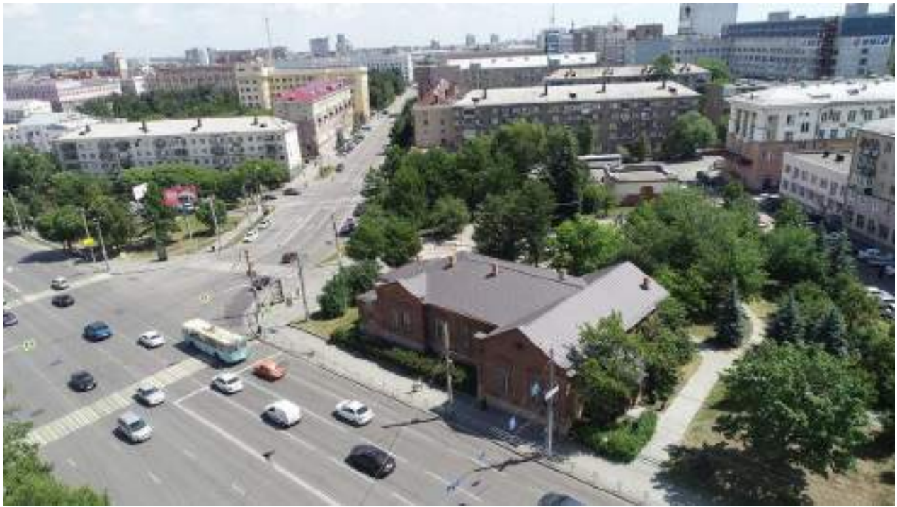
Рис.80. Вид на здание по ул. Воровского,5 и прилегающий к нему сквер сверху (Фото – 2019 г.). Ссылка: https://n1st.ru/cache/realty/photo/7ee1a20653434f382f6397d0f6ea4113_1200_800_p.jpg .
