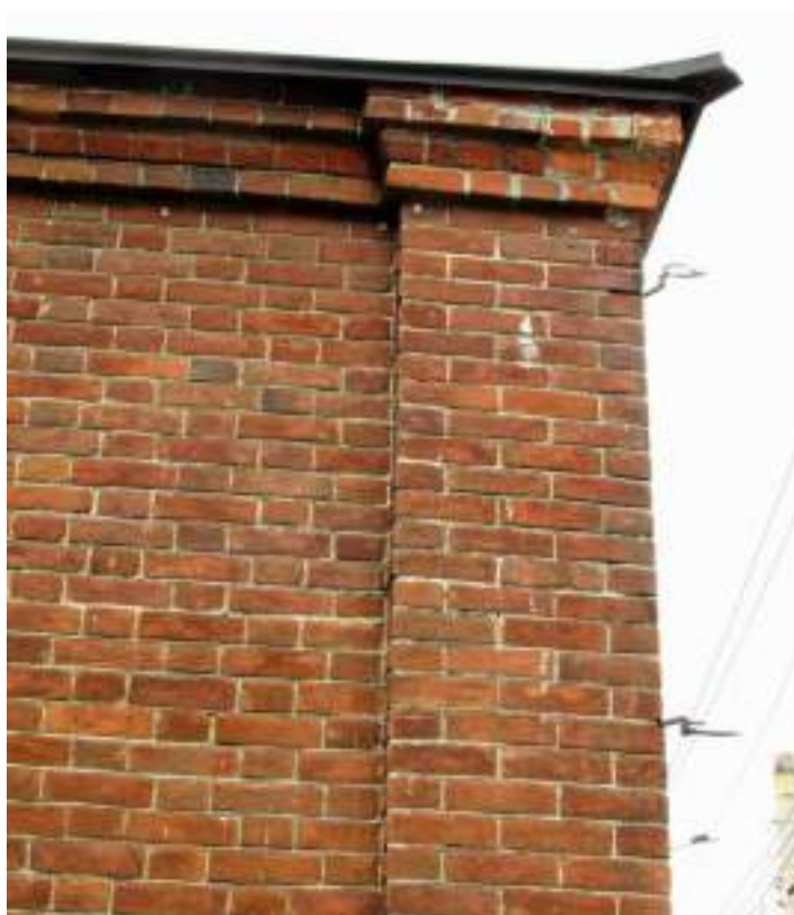
Рис.23. Верх пилястры западного пристроя северо-восточного фасада (фото авторов, май 2020 г.).
