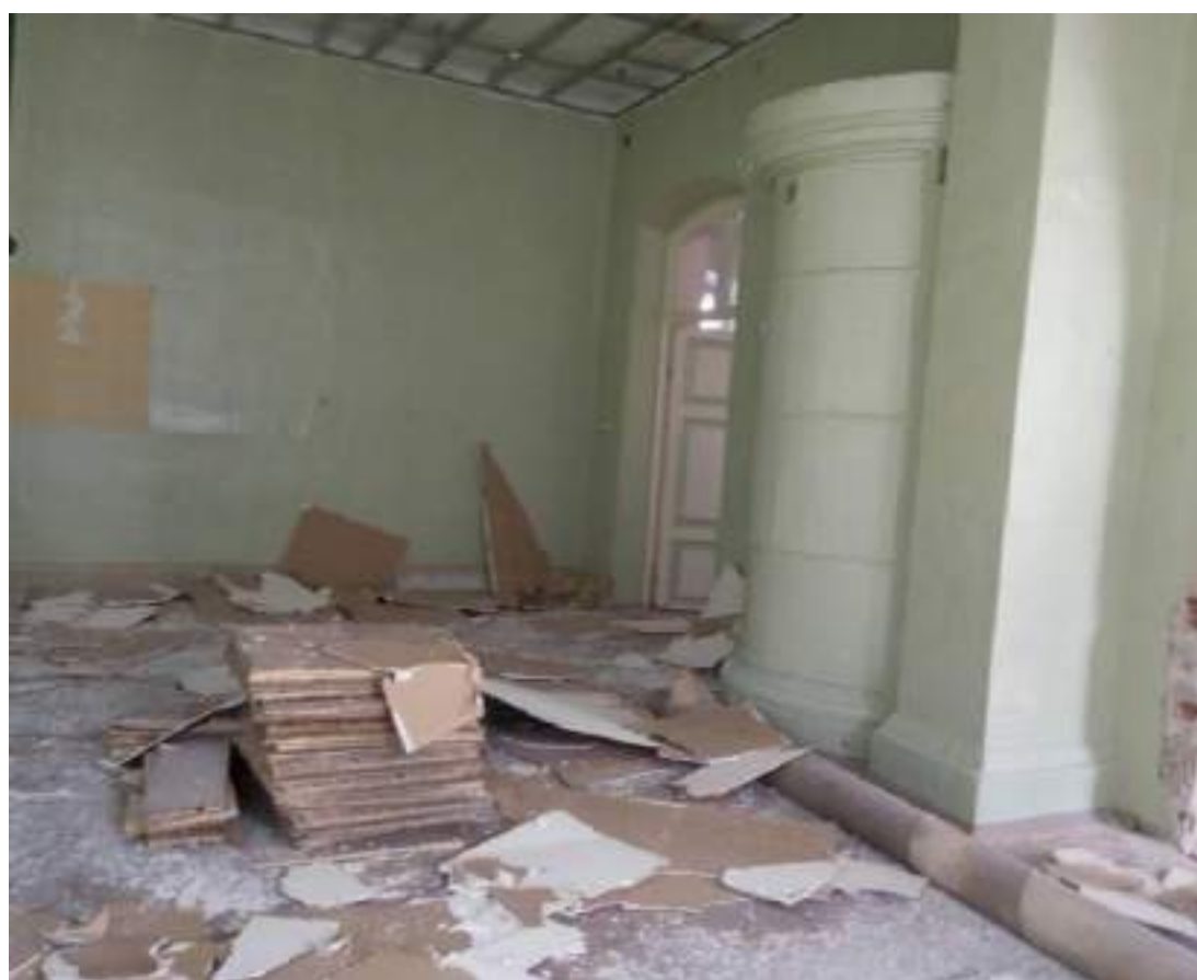
Рис.77. Здание по ул. Воровского, 5. Интерьеры здания. (Фото – 2018 г.) Ссылка: https://ic.pics.livejournal.com/yuvlatyshev/22714000/3175124/3175124_800.jpg .
