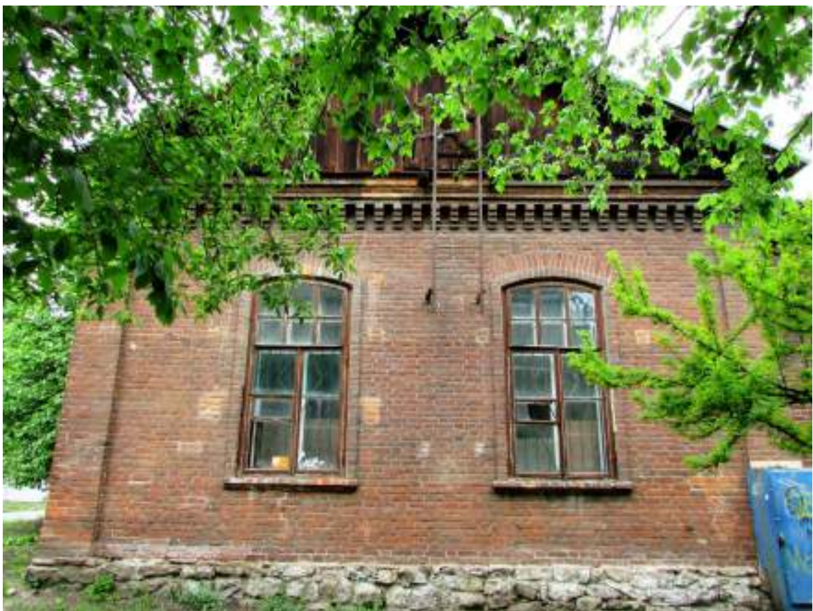
Рис.17. Фасад ризалита юго-восточного фасада (фото авторов, май 2020 г.).
