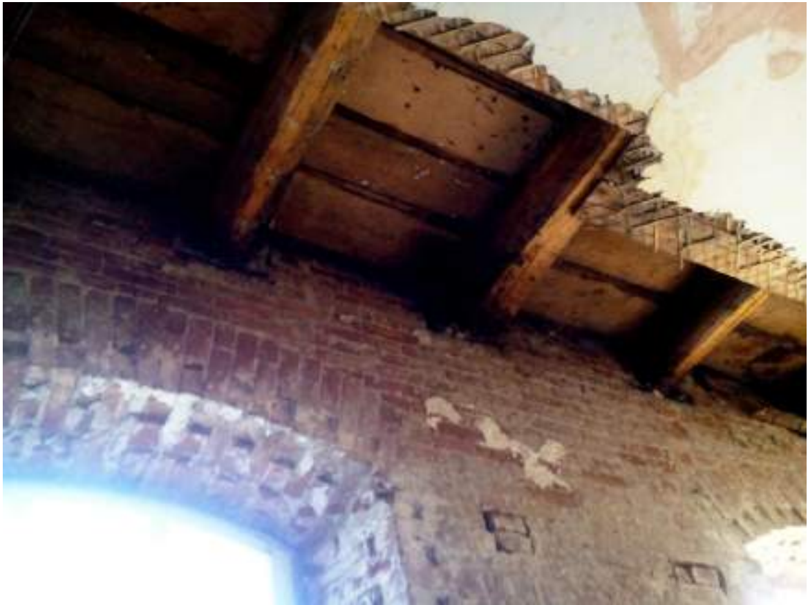
Рис.32. Фрагмент чердачного перекрытия (фото авторов, май 2020 г.).
