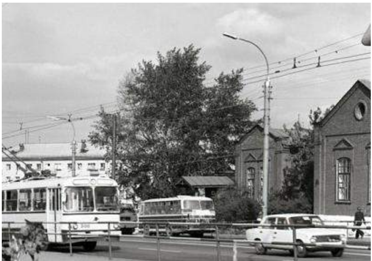
Рис.37. Фрагмент фотографии. Челябинск. Улица Воровского, 1970-е гг. Справа – здание по ул. Воровского,5. Ссылка: https://transphoto.org/photo/09/58/18/958187.jpg .
