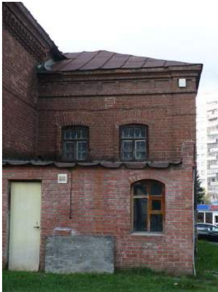
Рис.54. Здание по ул. Воровского, 5. Фрагмент юго-восточного фасада. (Фото – сентябрь 2009 г.) Ссылка: https://img-fotki.yandex.ru/get/3803/ssgen.54/0_3e632_96c9cbbf_XL.jpg .
