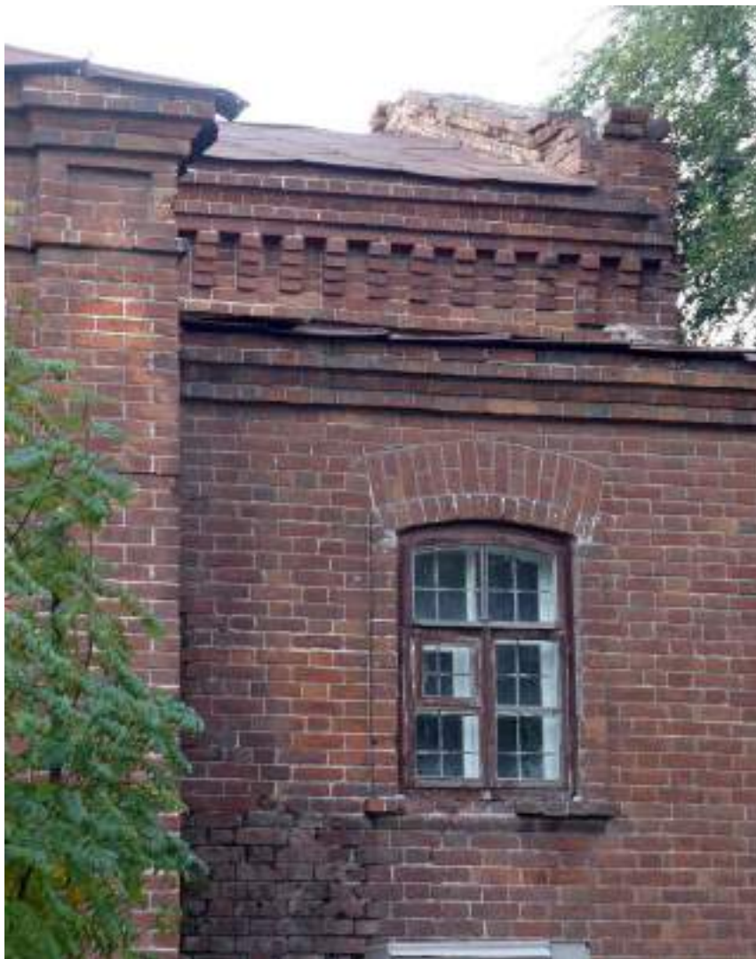
Рис.46. Здание по ул. Воровского, 5. Фрагмент северо-восточного фасада. (Фото – сентябрь 2009 г.) Ссылка: https://img-fotki.yandex.ru/get/3802/ssgen.54/0_3e62f_6a495f29_XL.jpg .
