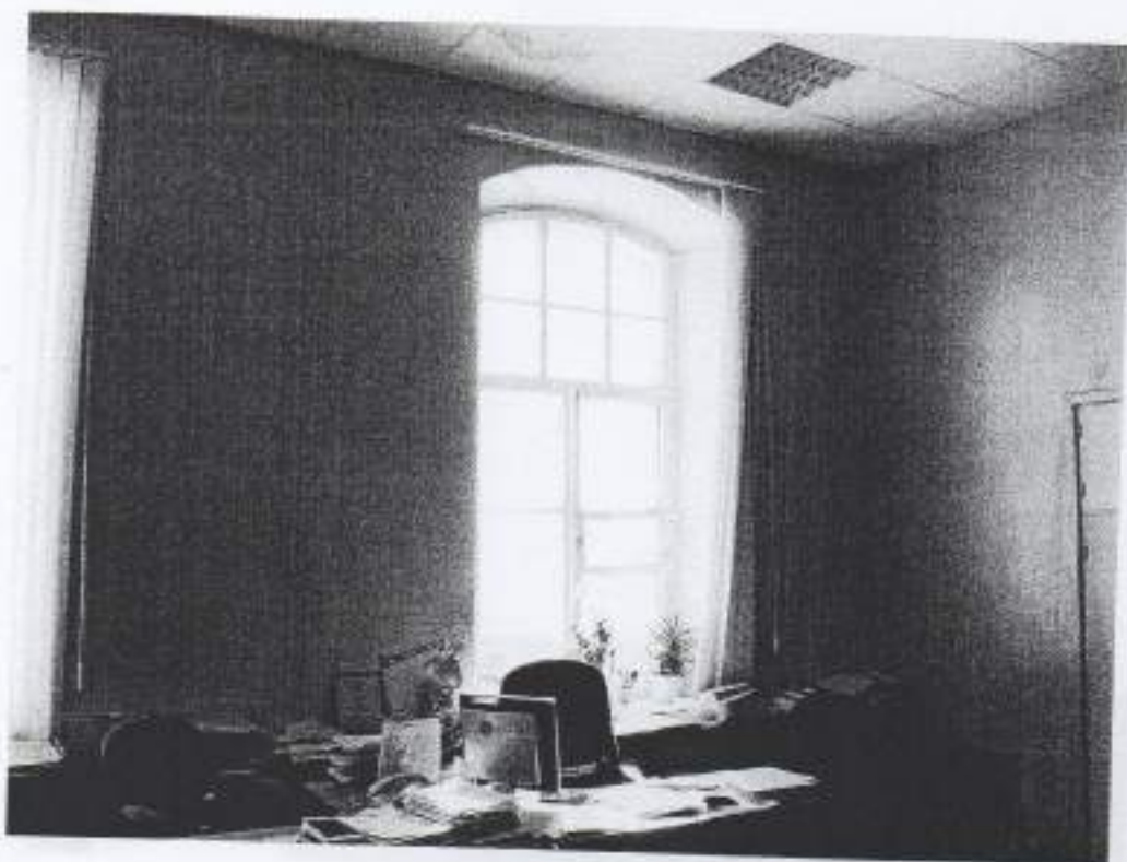
Фото 13. Вид на оконный проем с лучковым завершением в помещении № 17 на 1-м этаже здания
