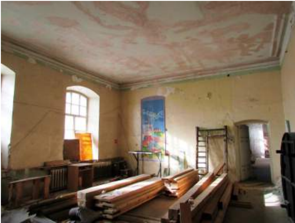
Рис.24. Вид на юго-западное помещение с расчищенным историческим потолком с частично сохранившейся потолочной лепниной (фото авторов, май 2020 г.).
