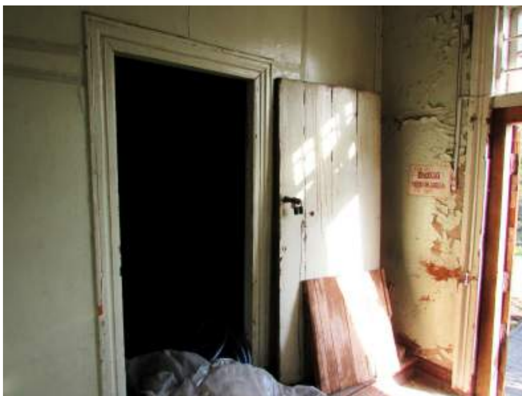
Рис.31. Помещения деревянного исторического прибора (фото авторов, май 2020г.).
