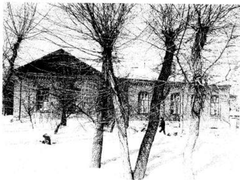
Фото 3. Вид на южный фасад здания
