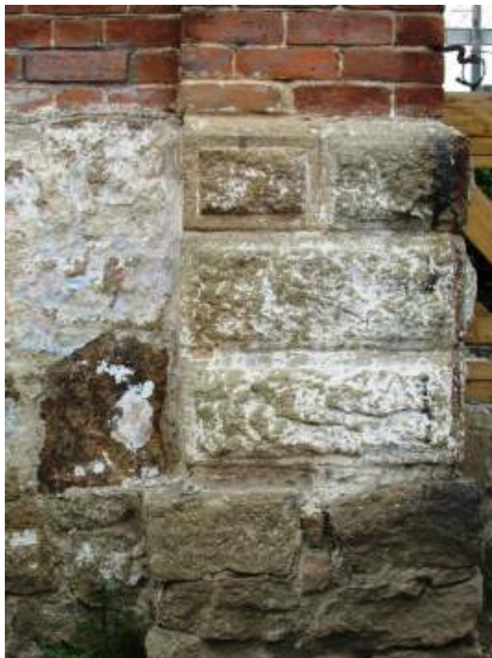
Рис.22. Низ пилястры западного пристроя северо-восточного фасада (фото авторов, май 2020 г.).
