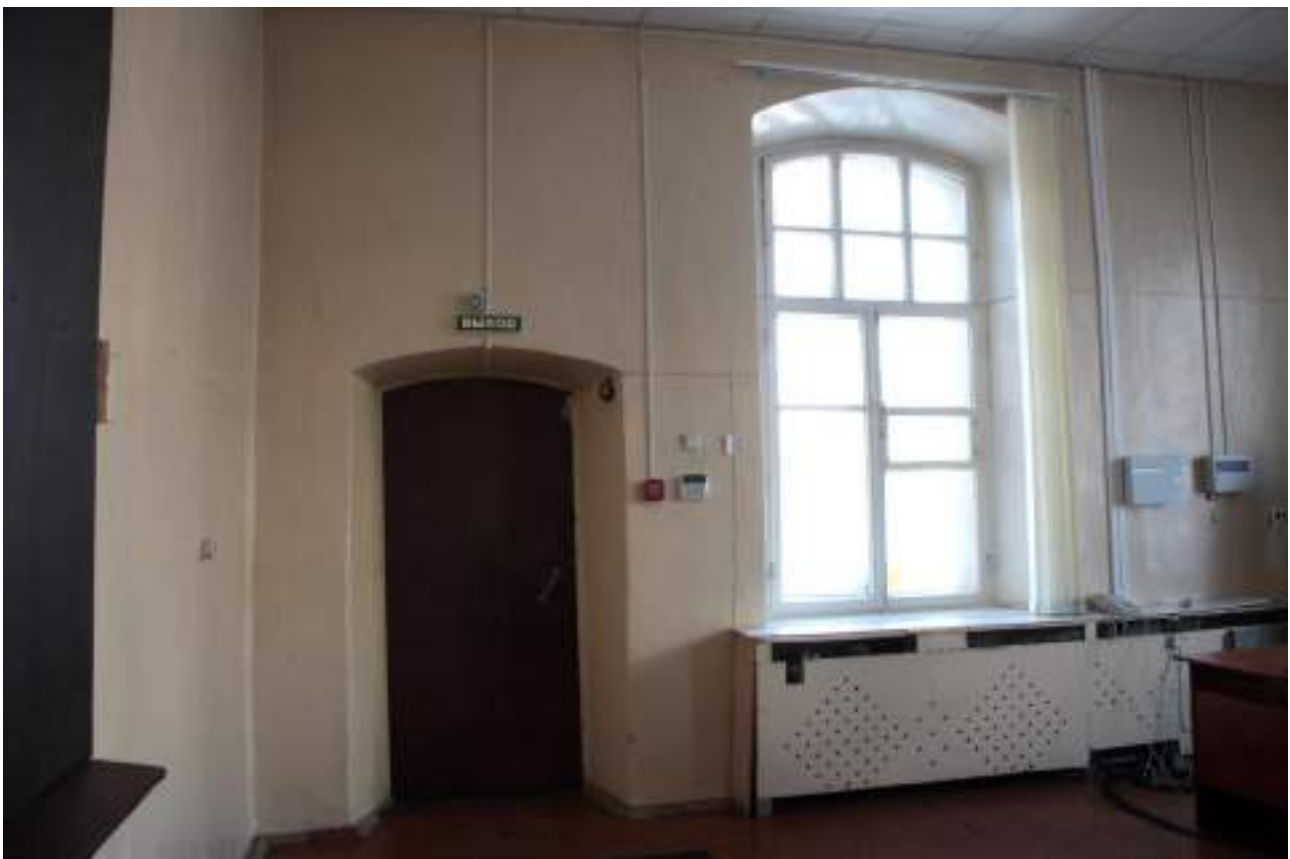
Рис.61. Интерьер юго-западного помещения. Вид на дверной лучковый проем выхода в деревянный пристрой и оконный лучковый проем с откосами «с рассветом» (Фото - 2012г., автор - Маевская Т.И).
