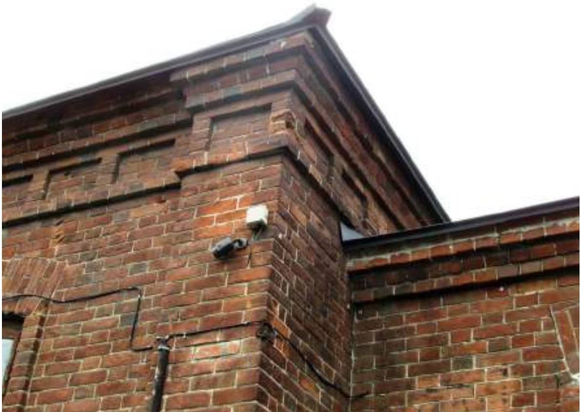
Рис.21. Стык двух исторических пристроев северо-восточного фасада (фото авторов, май 2020 г.).
