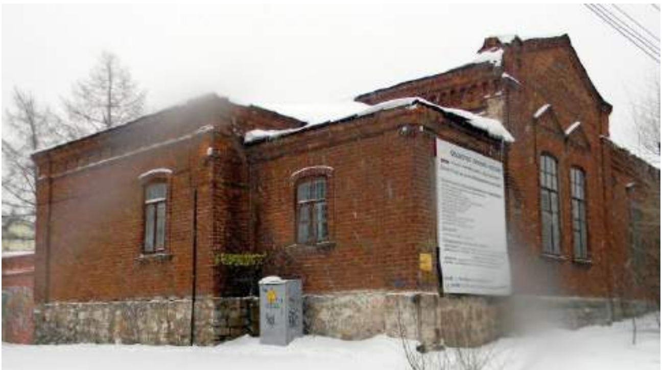
Рис.67. Здание по ул. Воровского, 5. Северо-западный и северо-восточный фасады. (Фото – январь 2013 г., автор – Ю.Латышев) Ссылка: https://ic.pics.livejournal.com/yuvlatyshev/22714000/3172126/3172126_800.jpg .
