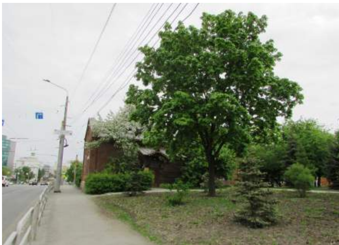
Рис.7. Вид на здание-памятник с юго-запада с ул. Воровского (фото авторов, май 2020 г.).
