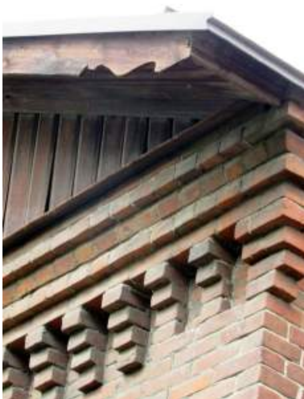
Рис.18. Фрагмент фронтона ризалита юго-восточного фасада (фото авторов, май 2020 г.).
