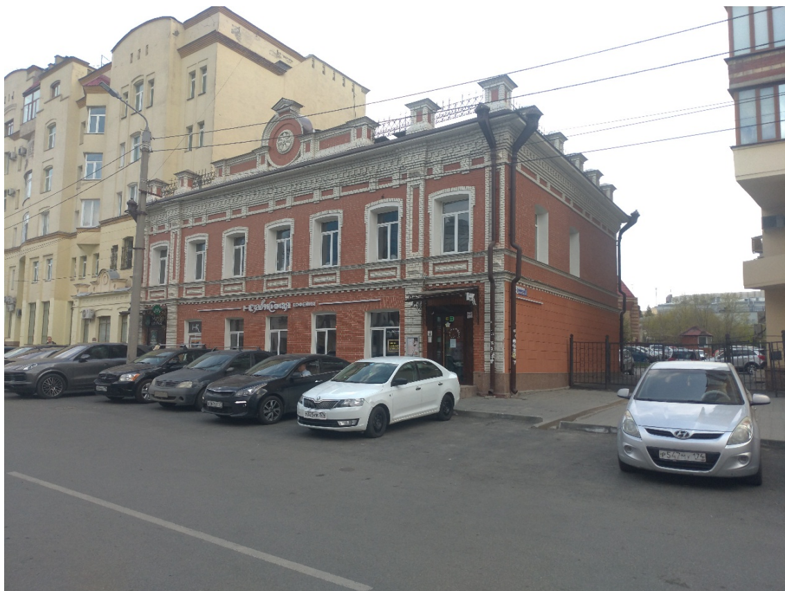
Приложение №9. «Доходный дом К.И. Ростова». Вид с северо-запада. Фото май 2022 года.
