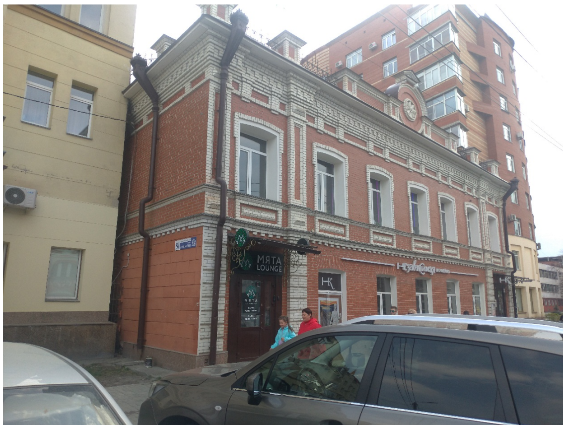
Приложение №7. «Доходный дом К.И. Ростова». Вид с северо-востока. Фото май 2022 года.
