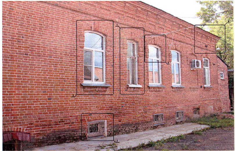
1. Узкий арочный оконный проем с лучковой перемычкой 2. Арочные оконные проёмы с лучковыми перемычками и подоконниками 3. Арочные оконные проемы цокольного этажа с лучковыми перемычками 4. Карниз небольшого выноса на кронштейнах, расположенных на псевдогалтели, пояс ширинок 5. Наличники в 1/3 высоты оконных проёмов с плавным рисунком, имитирующим замковый камень.
