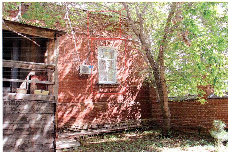
1. Арочный оконный проём с лучковой перемычкой и подоконником 2. Карниз небольшого выноса на кронштейнах, расположенных на псевдогалтели, пояс ширинок
