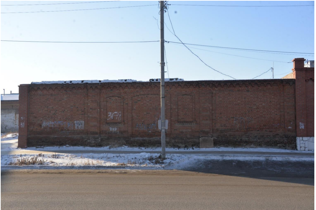
Фото 4. Вид на выявленный объект культурного наследия «Усадьба купца Четыркина», расположенный по адресу: Троицкий городской округ, г. Троицк, ул. им. Ю.А. Гагарина, 114
