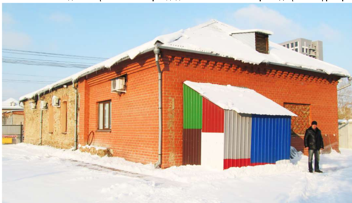
Рис. 7 Вид на юго-восточный фасад здания-памятника со стороны дворовой территории
