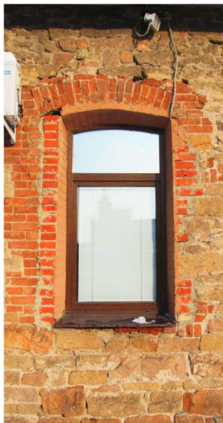
Рис. 18 Вид на оконный проем южного фасада здания
