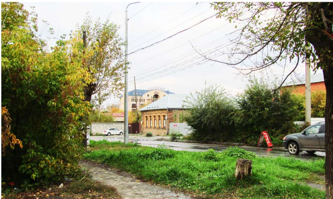
Рис. 2 Вид на здание-памятник с юго-запада со стороны ул. Пушкина
