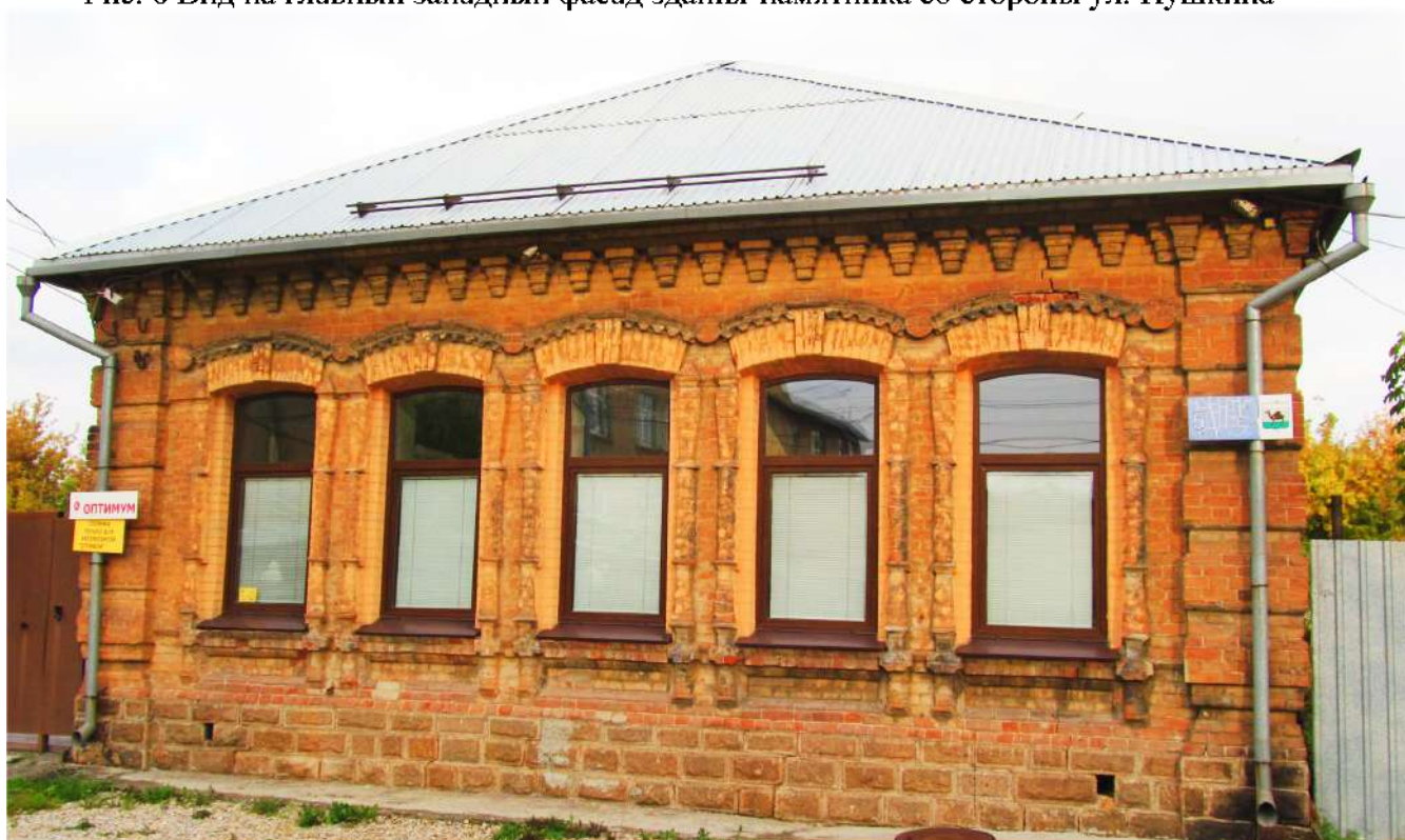
Рис. 9 Вид на главный западный фасад здания-памятника со стороны ул. Пушкина
