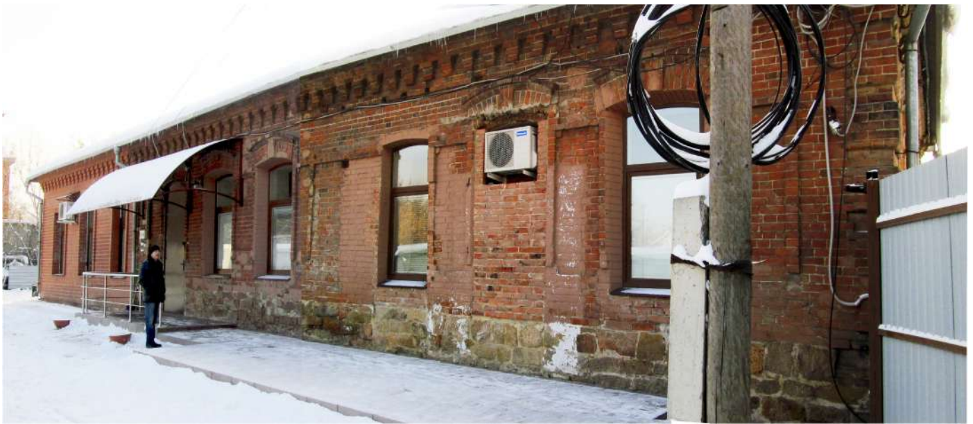
Рис. 10 Вид на северный фасад здания-памятника со стороны дворовой территории с запада
