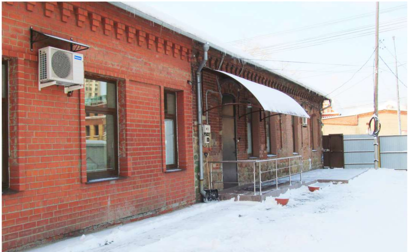
Рис. 11 Вид на северный фасад здания-памятника со стороны дворовой территории с востока
