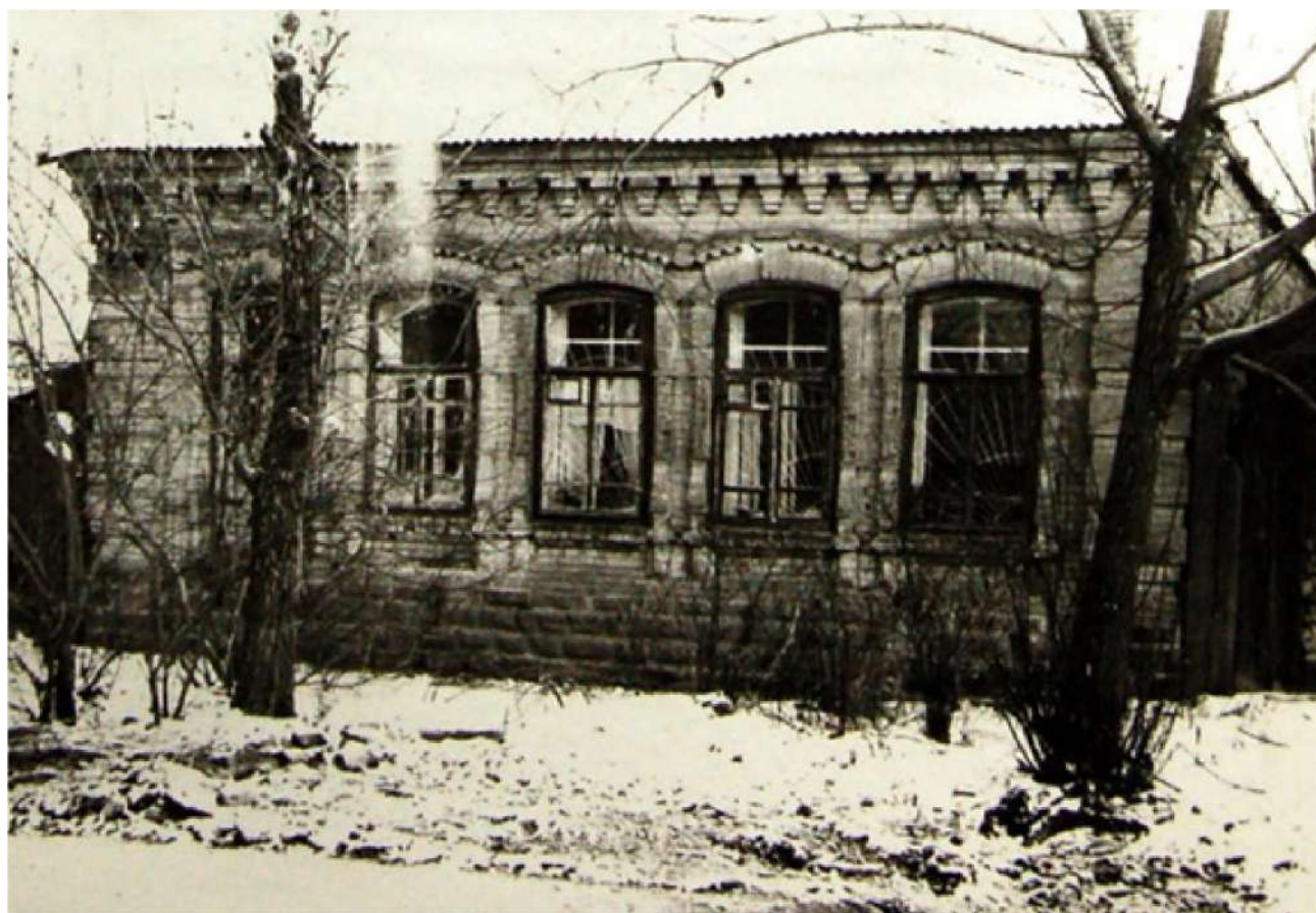
Рис. 45 Одноэтажный дом по ул.Пушкина, 5, (Фото 1979-80 г.г., автор С.И. Загребин). Ссылка: https://fotki.vandex.ru/users/vuvl/view/785581/ .
