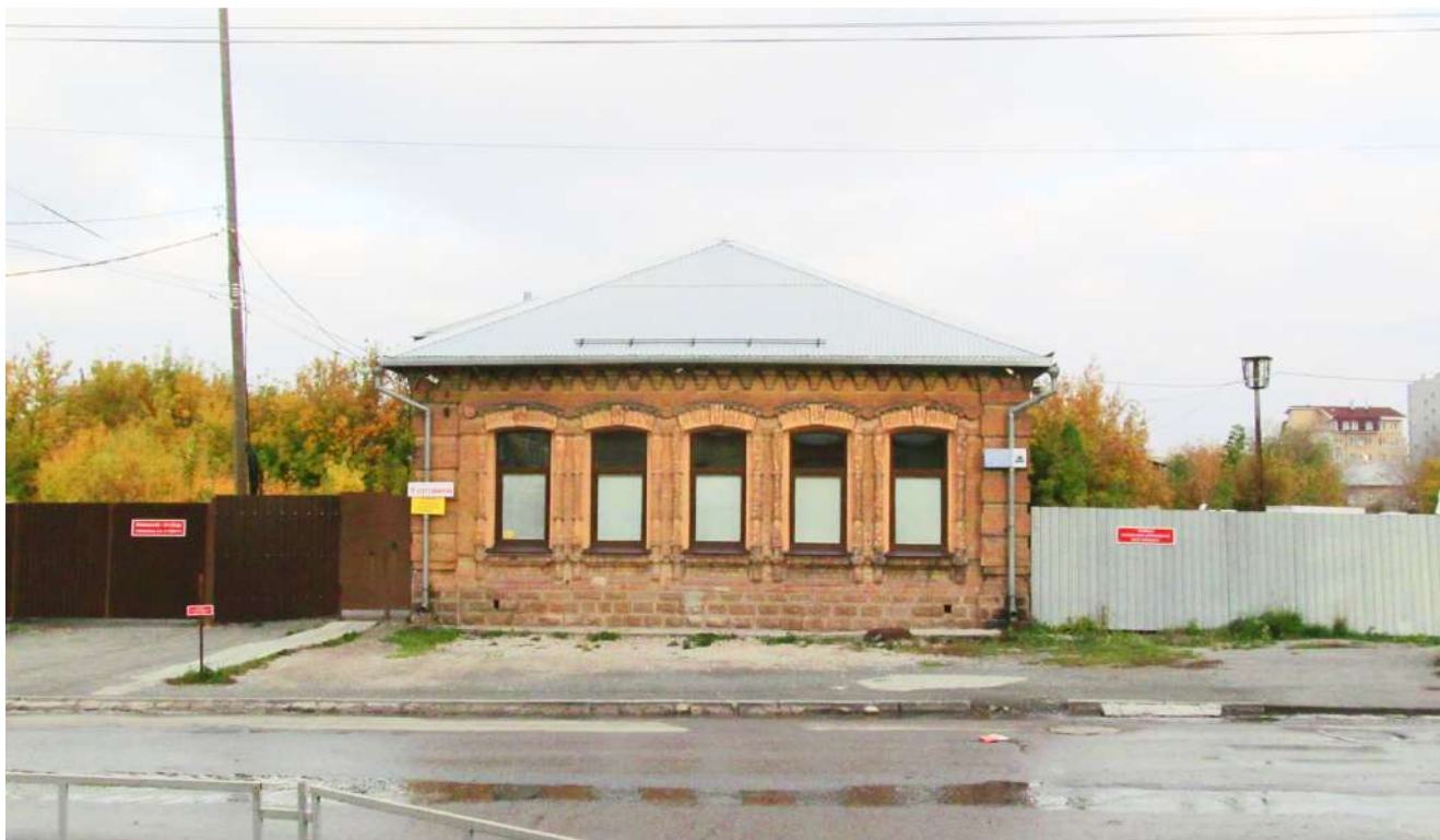
Рис. 8 Вид на главный западный фасад здания-памятника со стороны ул. Пушкина
