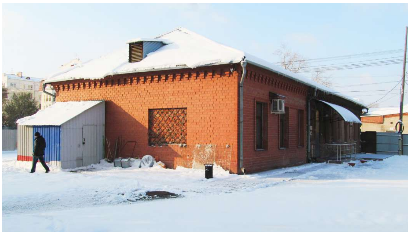
Рис. 6 Вид на северо-восточный фасад здания-памятника со стороны дворовой территории
