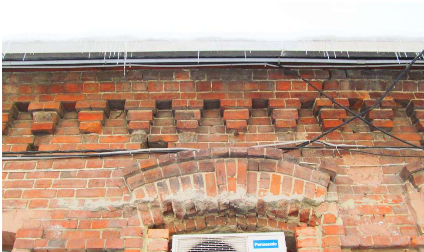
Рис. 24 Вид на карнизную зону северного фасада здания
