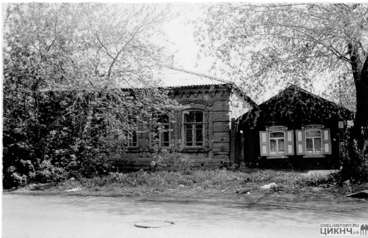
Рис. 49 Фотография из учетной карточки объекта ЦИКНЧ: Одноэтажный кирпичный дом по ул. Пушкина, 5 (Фото 1990-х г.г.) Ссылка: http://img-fotki.vandex.ru/get/9749/674039.6a5/0_b9d04_5575e659_XL.jpg .
