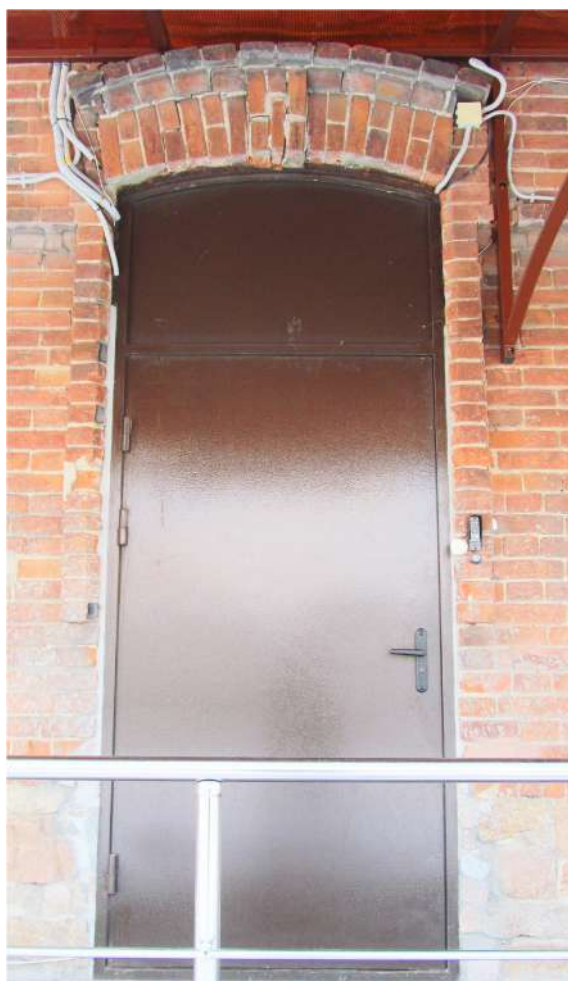
Рис. 15 Вид на проем входной двери северного фасада здания
