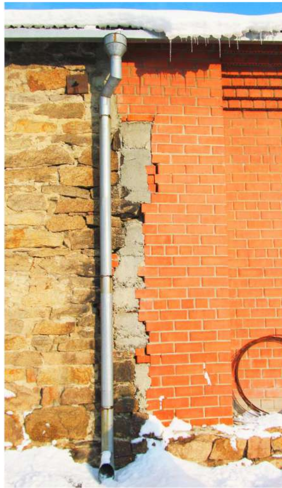
Рис. 22 Вид на место стыка здания-памятника и современного прибора
