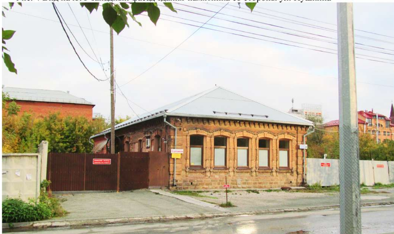
Рис. 5 Вид на юго-восточный фасад здания-памятника со стороны ул. Пушкина
