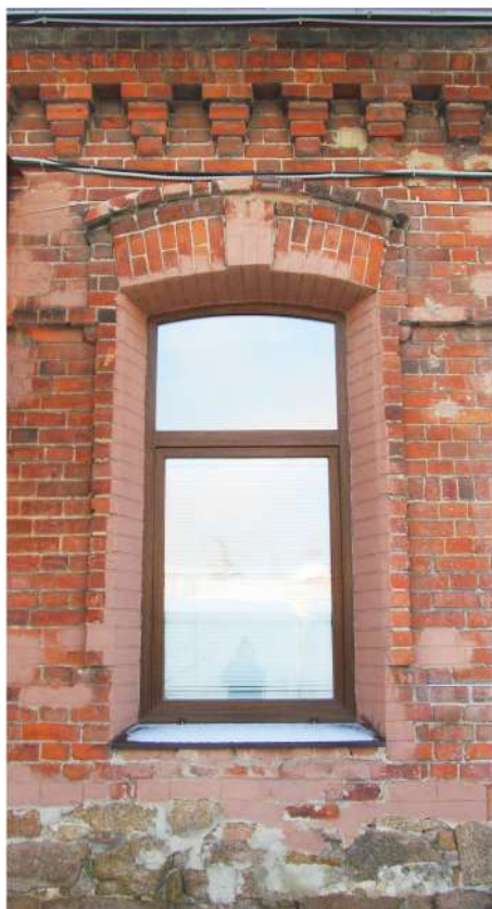
Рис. 17 Вид на оконный проем северного фасада здания
