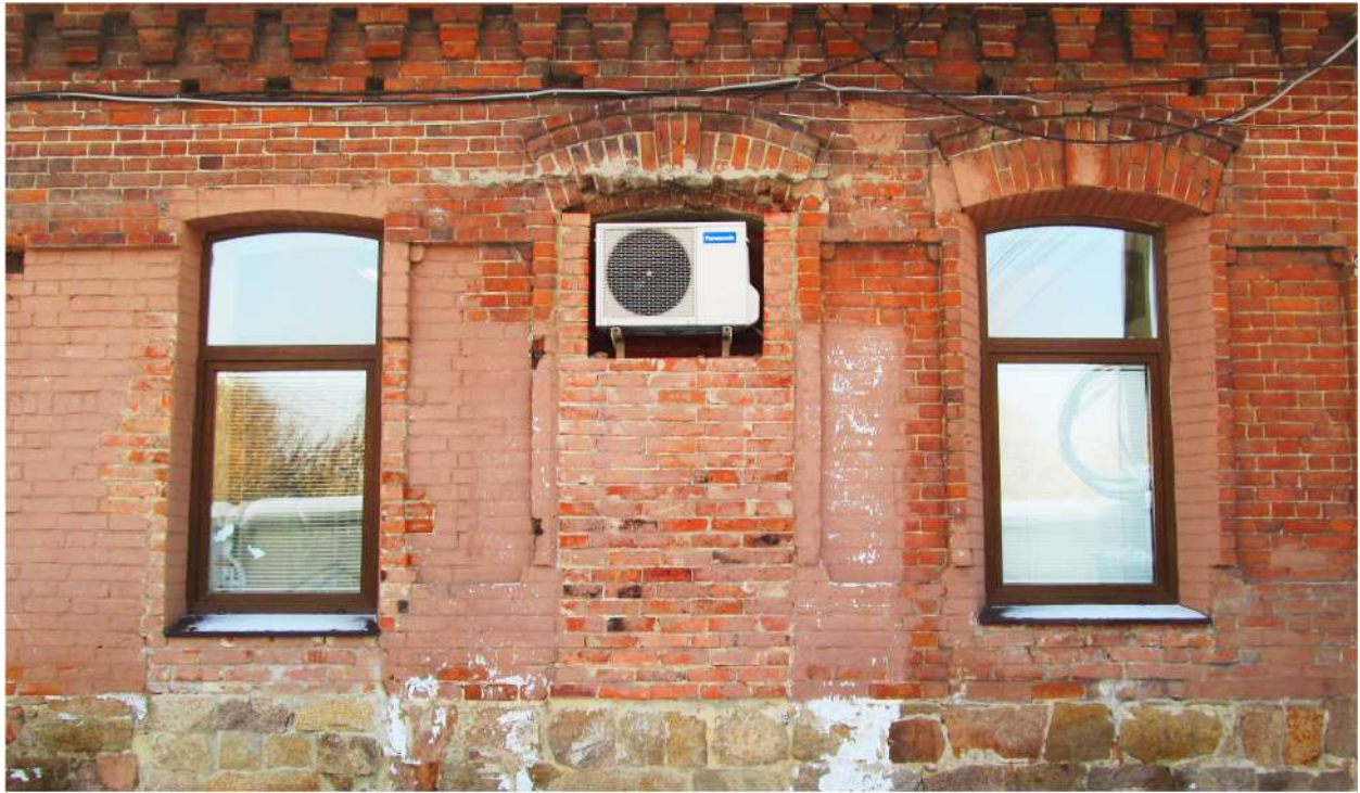
Рис. 19 Вид на заложенный оконный проем (в центре) и проем входной двери, преобразованный в оконный (слева), северного фасада здания
