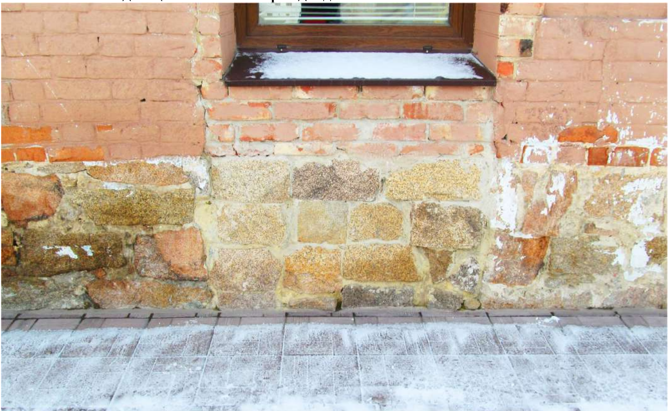
Рис. 27 Вид на цоколь северного фасада здания
