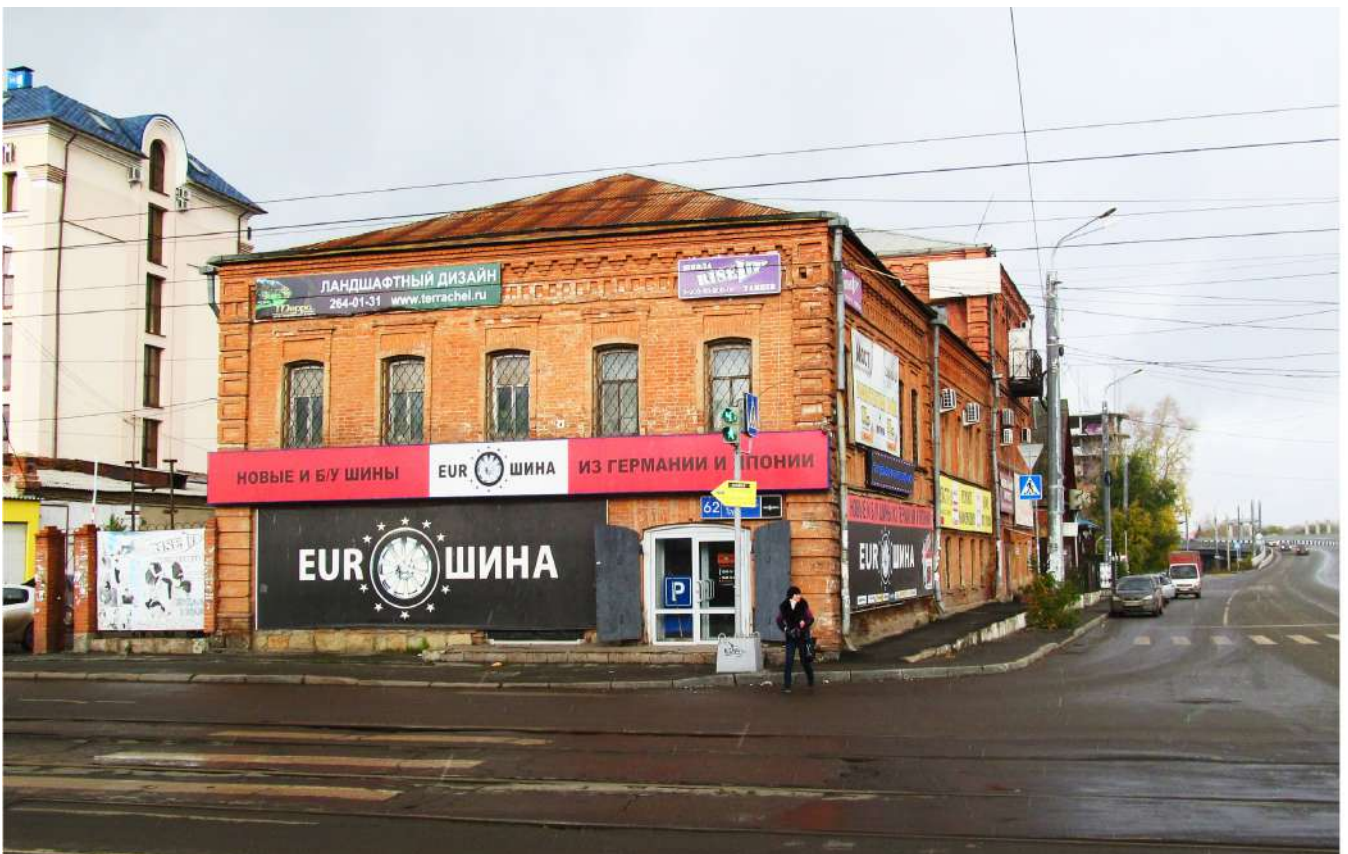
Рис. 65 «Дом Каширина Г.Н.» по ул. Труда, 62 (1885 г.). Схожие элементы прикарнизной зоны-уступчатые консоли.
