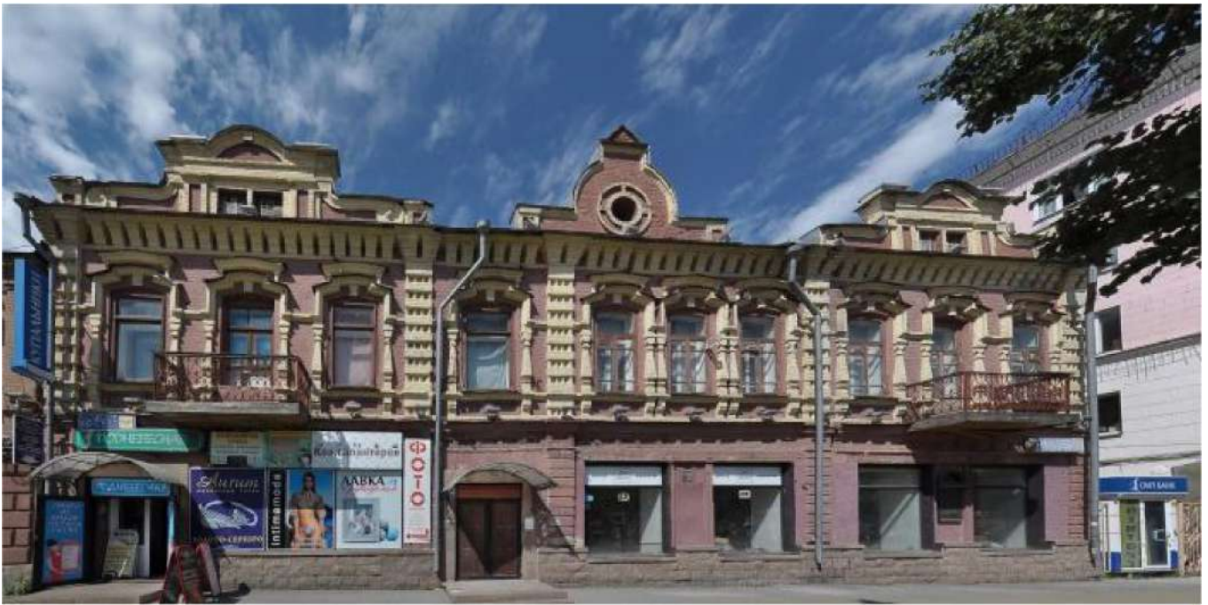
Рис. 64 « Дом М.Я. Мельцера» по ул. Кирова, 88 (1902-1907гг.). Идентичное решение прикарнизной зоны-карниз опирается на уступчатые консоли из лекального кирпича. Боковые ленты наборных наличников также повторяют мотивы наличников Пушкина, 5
