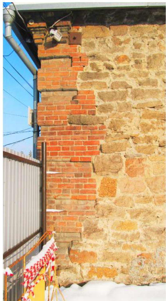
Рис. 21 Вид на рустованную поворотную лопатку южного фасада здания
