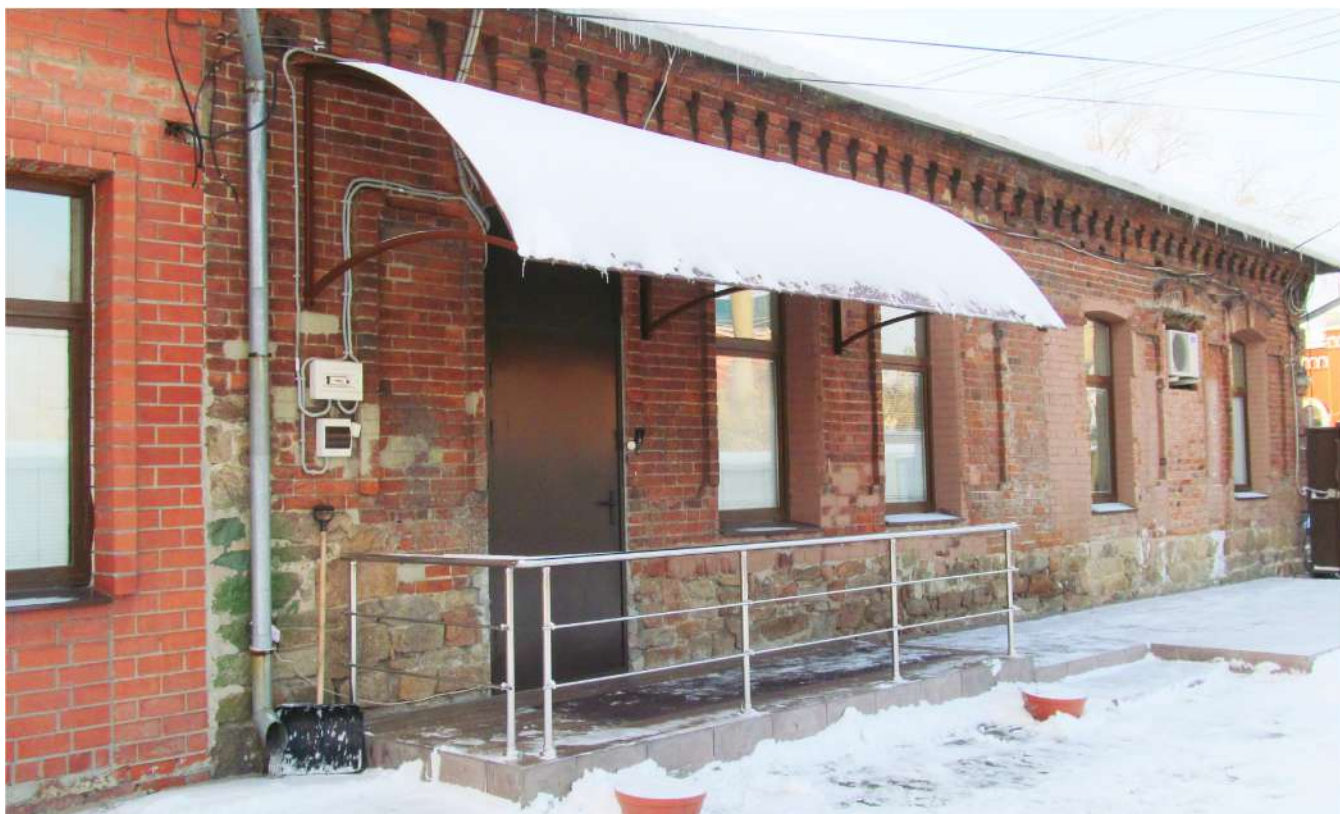
Рис. 14 Вид на крыльцо северного фасада здания
