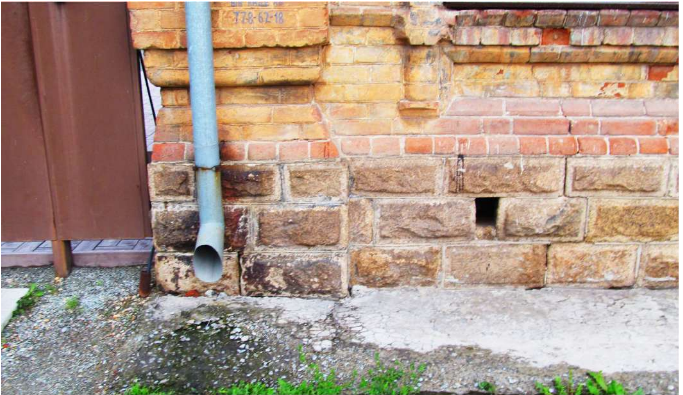
Рис. 26 Вид на цоколь главного фасада здания
