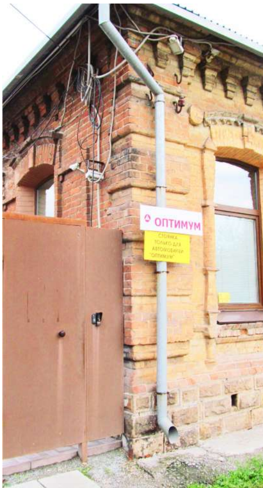
Рис. 20 Вид на рустованную поворотную лопатку северо-восточного фасада здания
