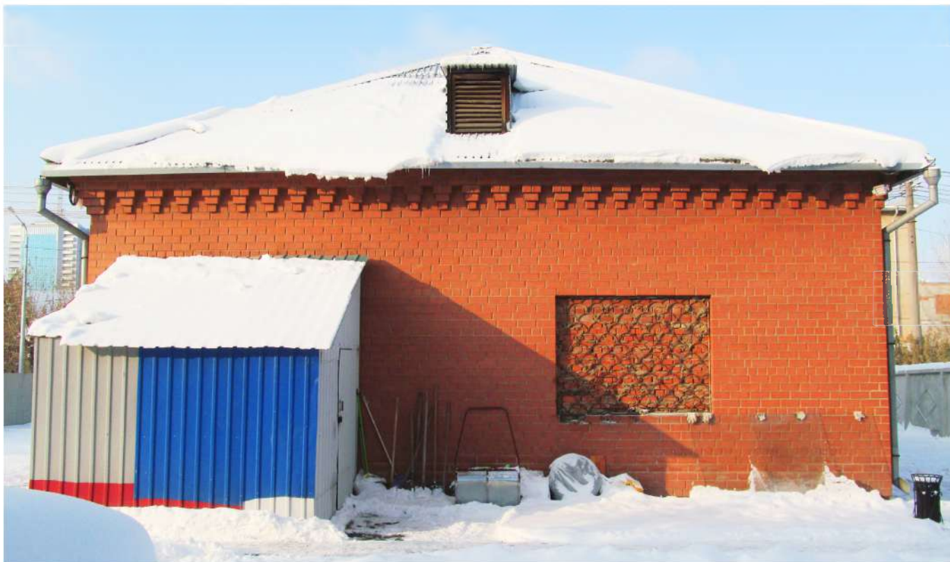
Рис. 12 Вид на восточный фасад здания-памятника со стороны дворовой территории
