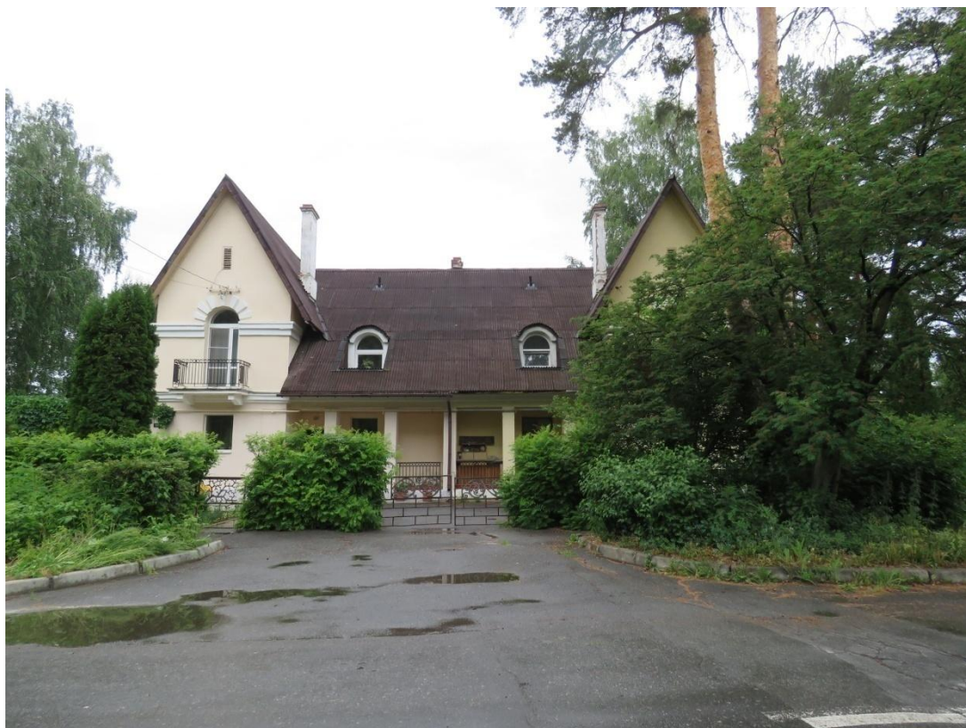
Рис. 3. Вид на главный (южный) фасад с юга
