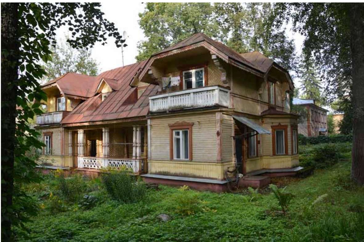
Рис. 14. Саров. Деревянный коттедж по ул. ул. Победы, 9
