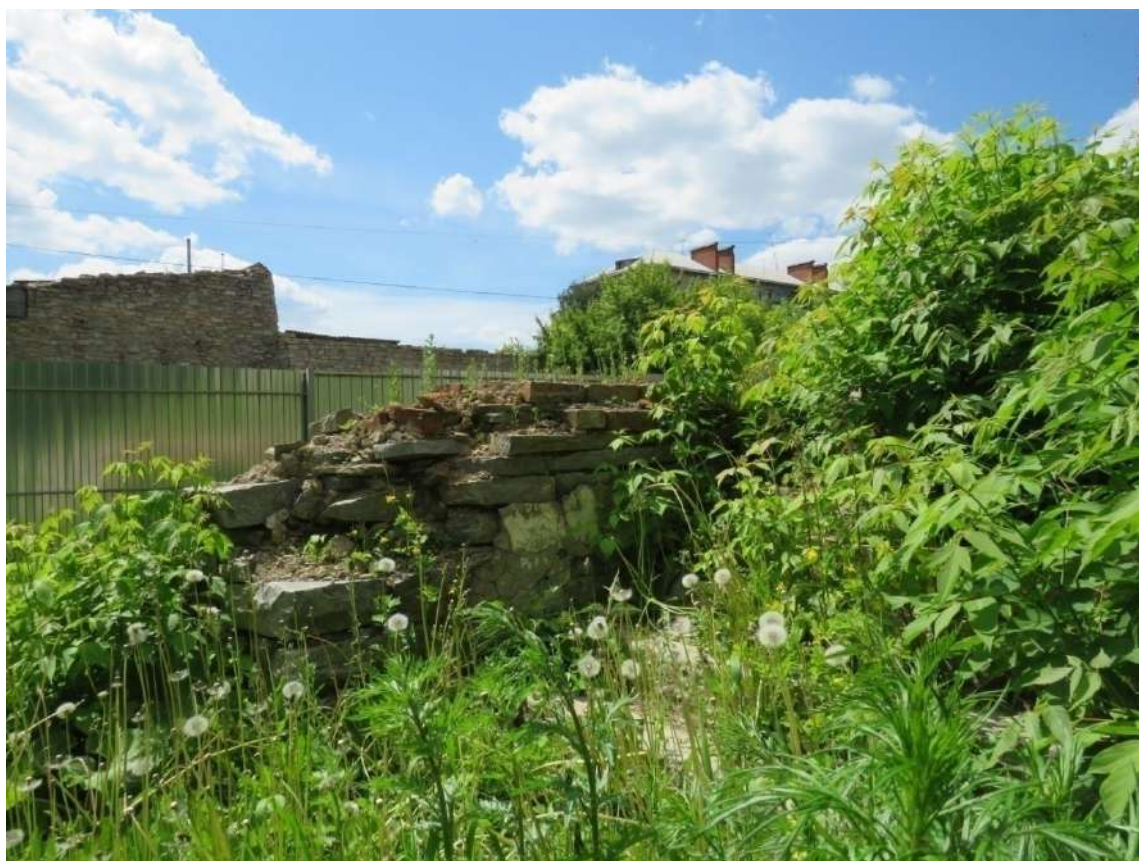
Рис. 4. Бутовая кладка ограждения лестницы.
