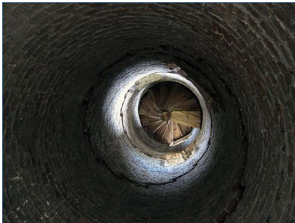
Рис. 20. Ствол минарета с остатками деревянной винтовой лестницы. Источник: https://www.wiki-miass.ru/miass/minaret.html
