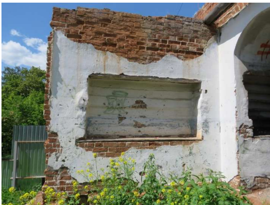
Рис. 15 а, б. Примыкающая стена с нишами
