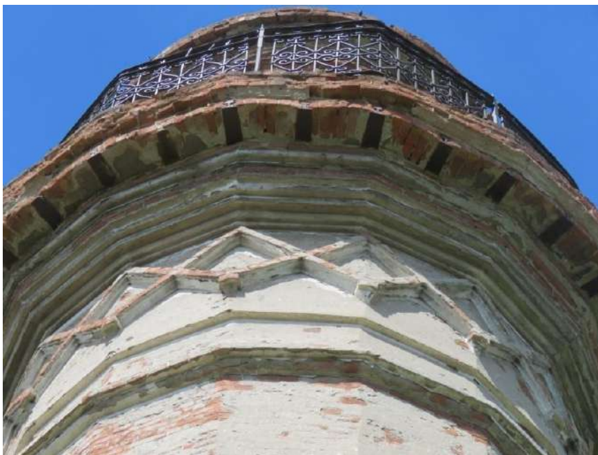
Рис. 12. Верхняя часть ствола минарета с орнаментированным поясом и профилированным карнизом-основанием для галереи-шерёфе
