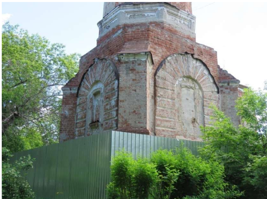
Рис. 7. Ярус-основание минарета. Контрфорсы и ниши на северной и западной гранях. Вид с северо-запада
