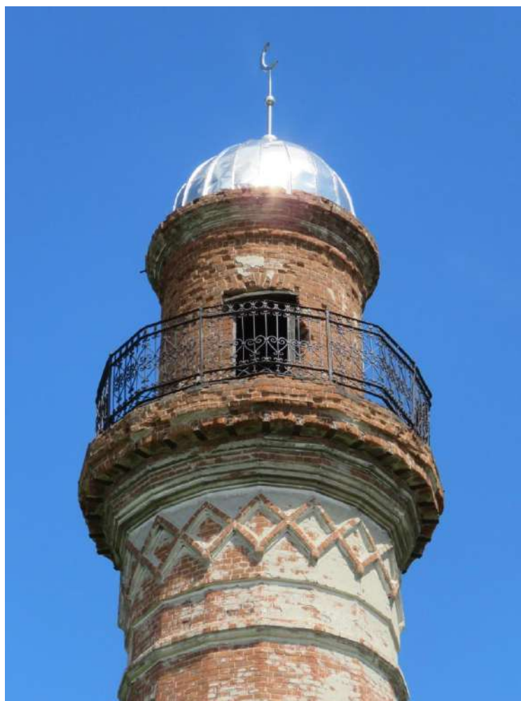
Рис. 13. Верхняя часть ствола минарета с орнаментированным поясом и профилированным карнизом-основанием для галереи-шерёфе; галерея-шерёфе; верхний ярус минарета с цилиндром-петеком, куполом и шпилем
