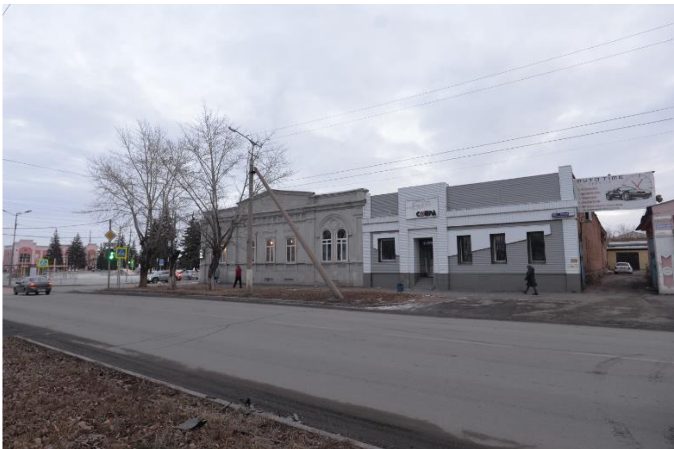
Фото 3. Вид на выявленный объект культурного наследия «Жилой дом», расположенный по адресу: Челябинская область, Троицкий городской округ, г. Троицк, ул. им. Степана Разина, 11.
