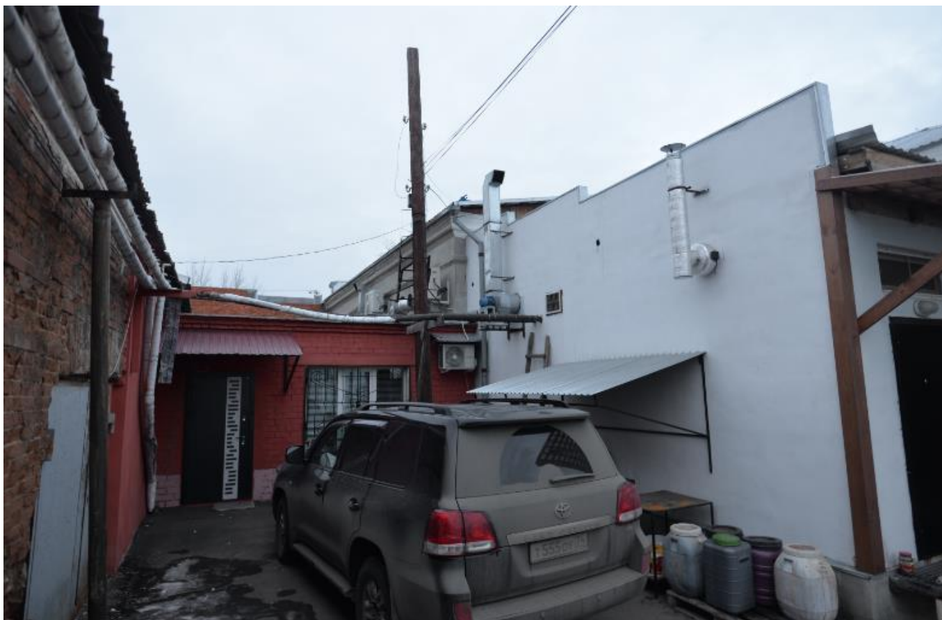
Фото 14. Вид на выявленный объект культурного наследия «Жилой дом», расположенный по адресу: Челябинская область, Троицкий городской округ, г. Троицк, ул. им. Степана Разина, 11.
