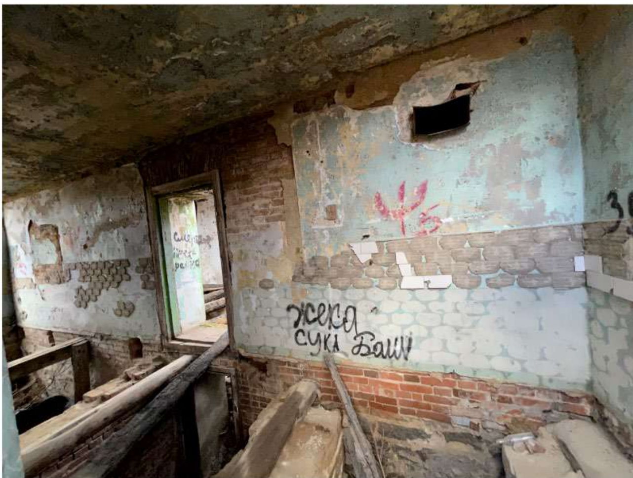
Фото 40. Выявленный объект культурного наследия «Дом купца Гонибесова» по адресу: Челябинская обл., г. Миасс, ул. Спорта, 11. Интерьер выявленного объекта культурного наследия.
