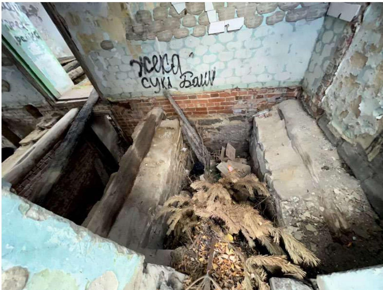
Фото 38. Выявленный объект культурного наследия «Дом купца Гонибесова» по адресу: Челябинская обл., г. Миасс, ул. Спорта, 11. Интерьер выявленного объекта культурного наследия.
