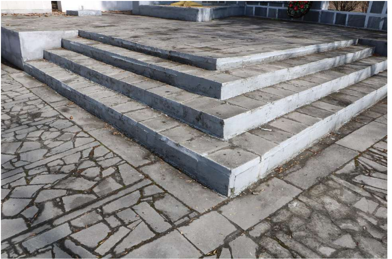
Фото 21. Выявленный объект культурного наследия. Лестница.
