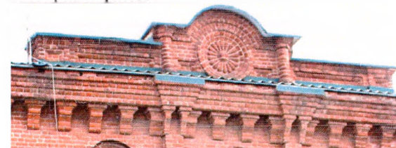
карниз и аттик центральной оси фасада
