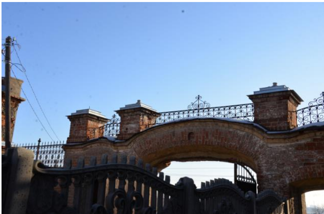
Фото 21. Вид на выявленный объект культурного наследия «Усадебный комплекс», расположенный по адресу: Челябинская область, Троицкий городской округ, г. Троицк, ул. Октябрьская, 83.
