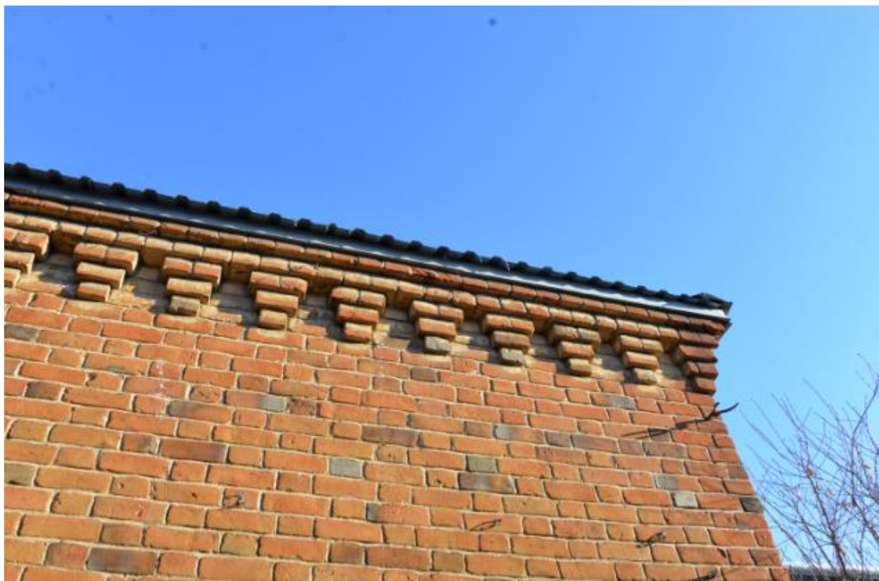
Фото 23. Вид на выявленный объект культурного наследия «Усадебный комплекс», расположенный по адресу: Челябинская область, Троицкий городской округ, г. Троицк, ул. Октябрьская, 83.
