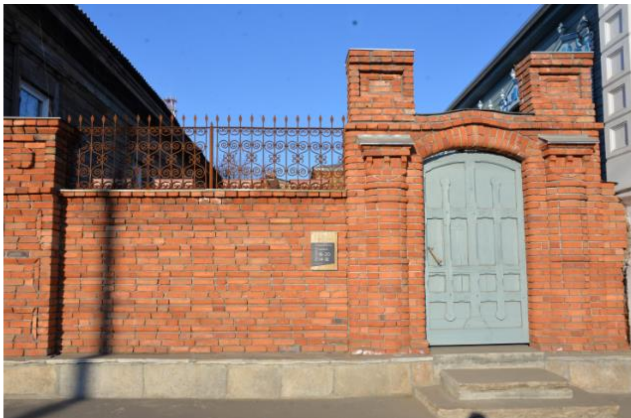
Фото 6. Вид на выявленный объект культурного наследия «Усадебный комплекс», расположенный по адресу: Челябинская область, Троицкий городской округ, г. Троицк, ул. Октябрьская, 83.
