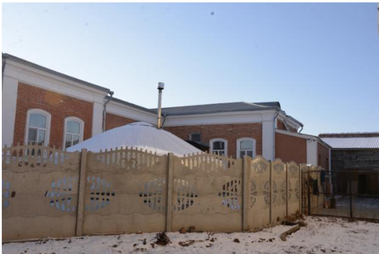
Фото 14. Вид на выявленный объект культурного наследия «Усадебный комплекс», расположенный по адресу: Челябинская область, Троицкий городской округ, г. Троицк, ул. Октябрьская, 83.
