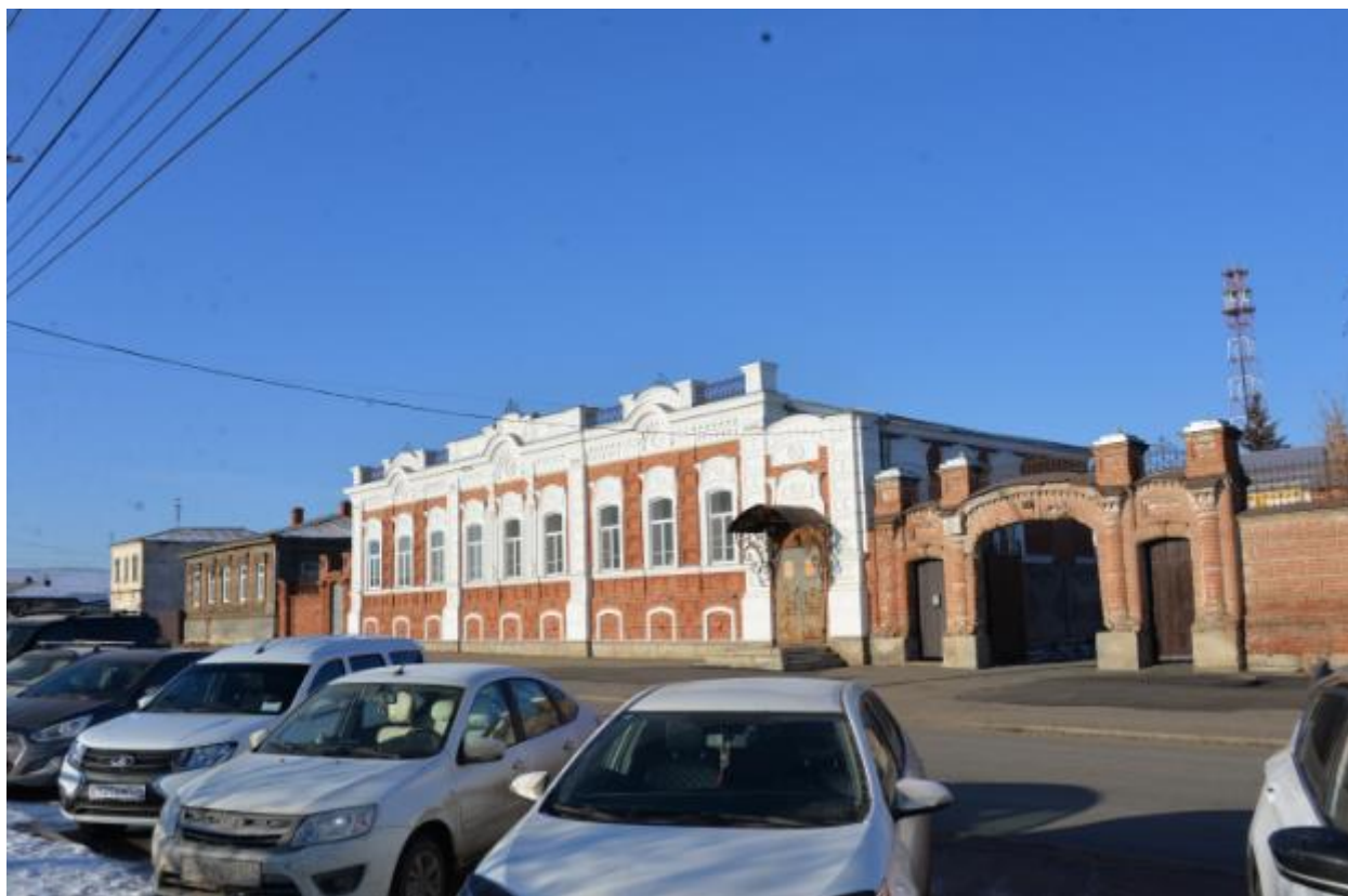
Фото 1. Вид на выявленный объект культурного наследия «Усадебный комплекс», расположенный по адресу: Челябинская область, Троицкий городской округ, г. Троицк, ул. Октябрьская, 83.
