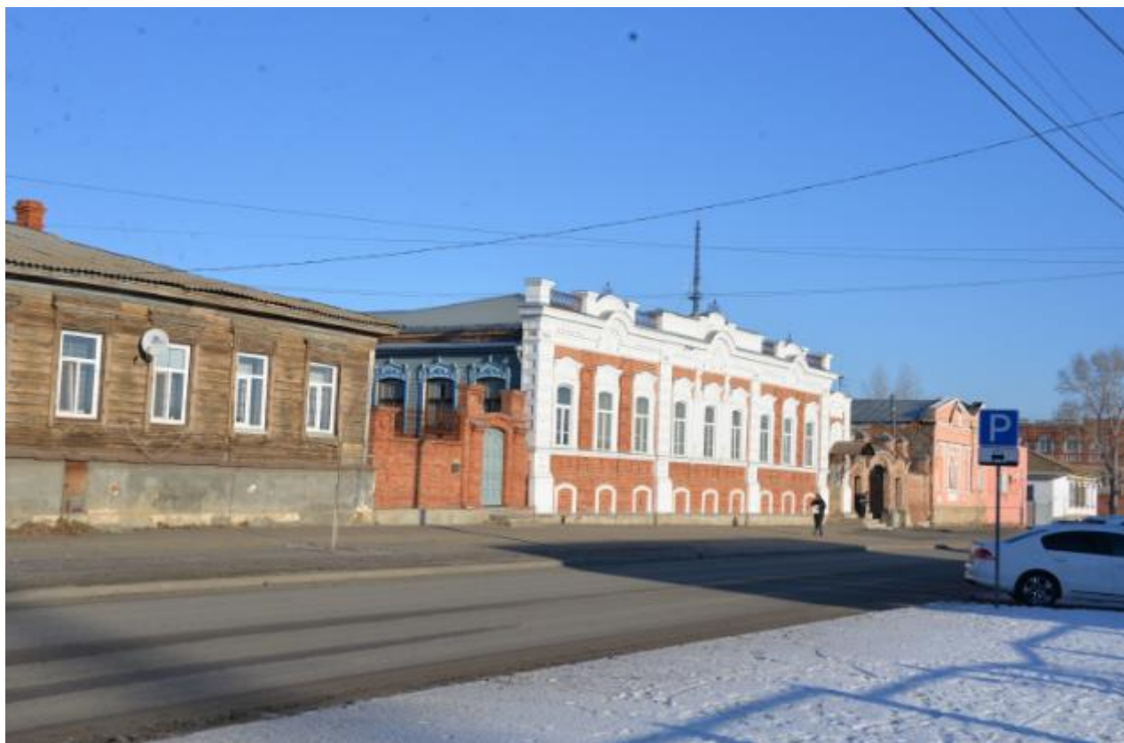
Фото 5. Вид на выявленный объект культурного наследия «Усадебный комплекс», расположенный по адресу: Челябинская область, Троицкий городской округ, г. Троицк, ул. Октябрьская, 83.
