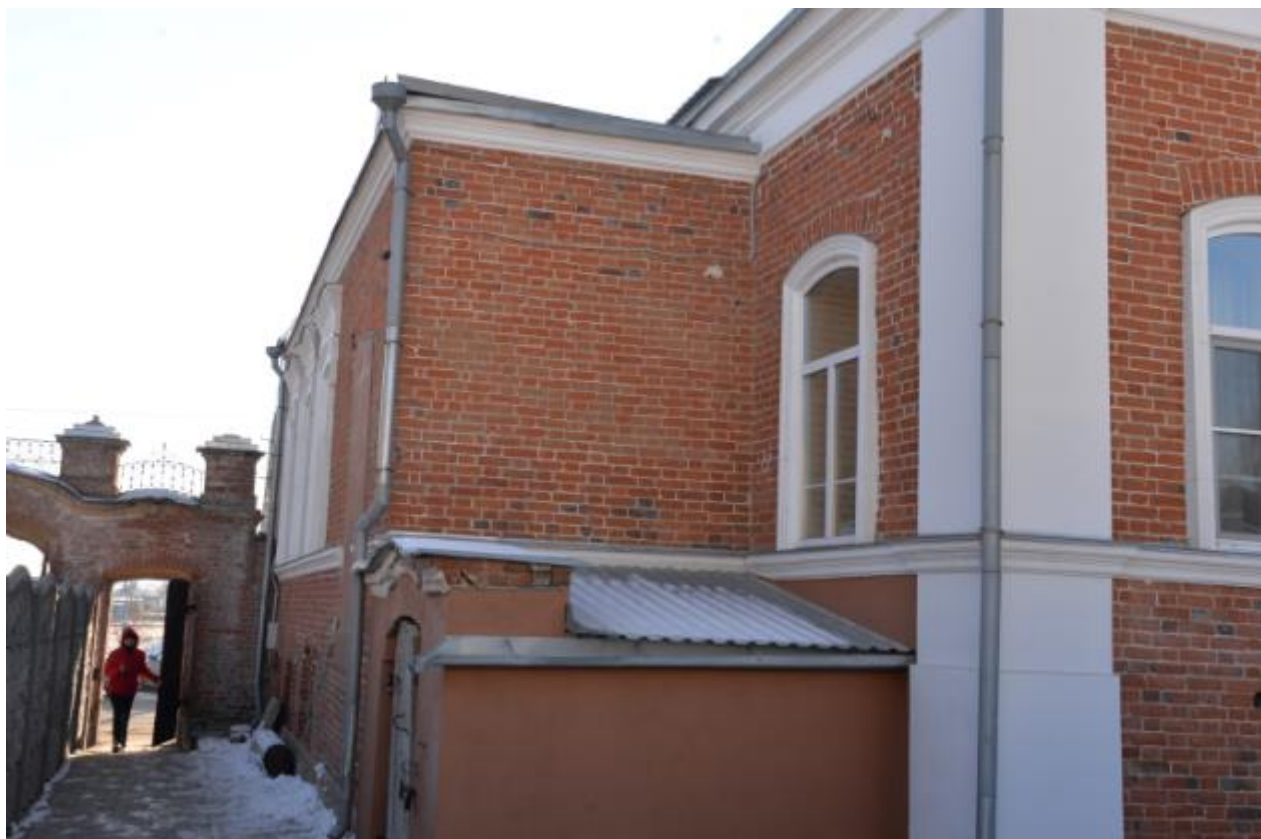
Фото 12. Вид на выявленный объект культурного наследия «Усадебный комплекс», расположенный по адресу: Челябинская область, Троицкий городской округ, г. Троицк, ул. Октябрьская, 83.
