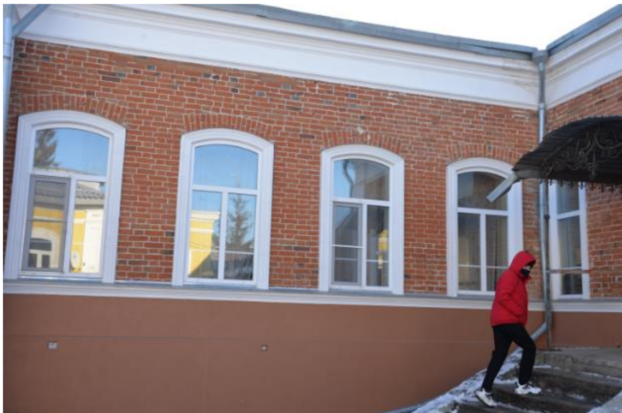
Фото 16. Вид на выявленный объект культурного наследия «Усадебный комплекс», расположенный по адресу: Челябинская область, Троицкий городской округ, г. Троицк, ул. Октябрьская, 83.
