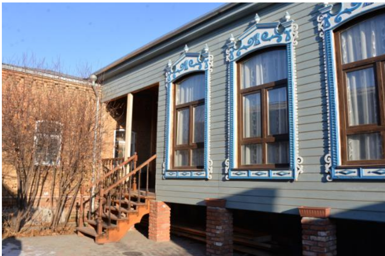
Фото 24. Вид на выявленный объект культурного наследия «Усадебный комплекс», расположенный по адресу: Челябинская область, Троицкий городской округ, г. Троицк, ул. Октябрьская, 83.
