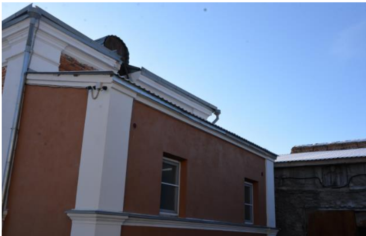
Фото 19. Вид на выявленный объект культурного наследия «Усадебный комплекс», расположенный по адресу: Челябинская область, Троицкий городской округ, г. Троицк, ул. Октябрьская, 83.
