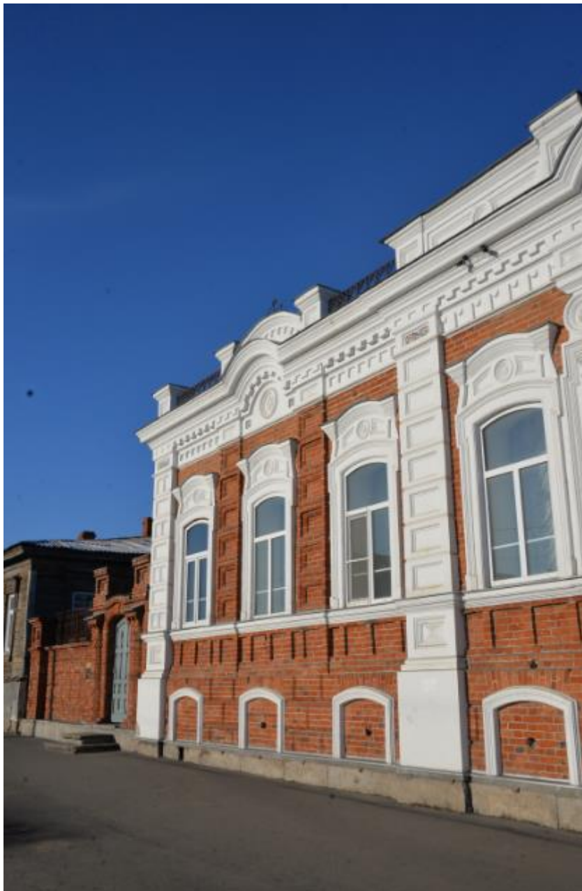
Фото 3. Вид на выявленный объект культурного наследия «Усадебный комплекс», расположенный по адресу: Челябинская область, Троицкий городской округ, г. Троицк, ул. Октябрьская, 83.
