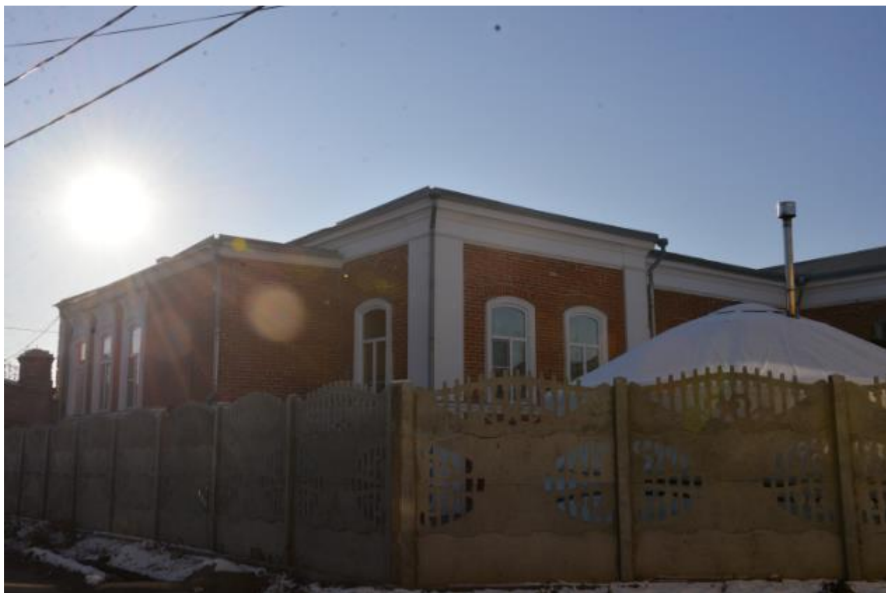
Фото 13. Вид на выявленный объект культурного наследия «Усадебный комплекс», расположенный по адресу: Челябинская область, Троицкий городской округ, г. Троицк, ул. Октябрьская, 83.
