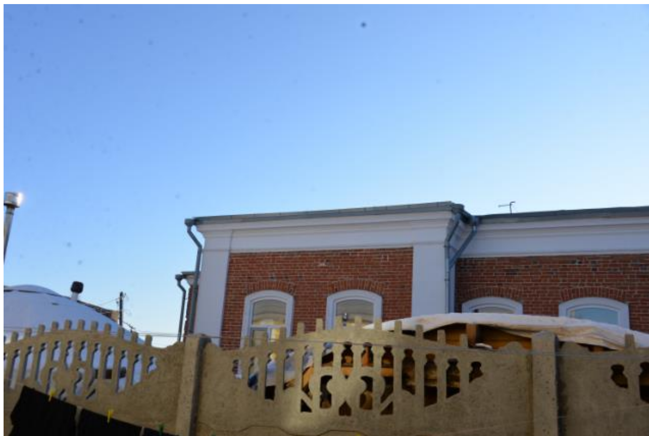
Фото 15. Вид на выявленный объект культурного наследия «Усадебный комплекс», расположенный по адресу: Челябинская область, Троицкий городской округ, г. Троицк, ул. Октябрьская, 83.
