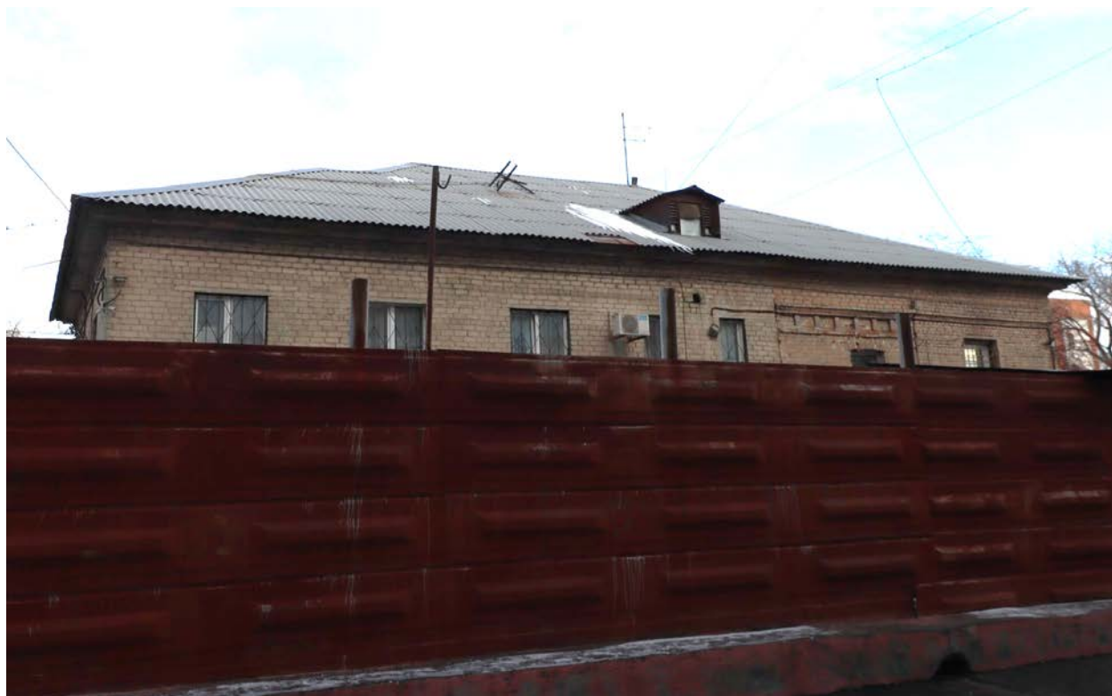
Фото.9 Выявленный объект культурного наследия «Дом Загуменного Ф. (низшая ремесленная школа)», расположенный по адресу: Челябинская область, г. Челябинск, ул. 1 Мая, 38. Южный фасад.
