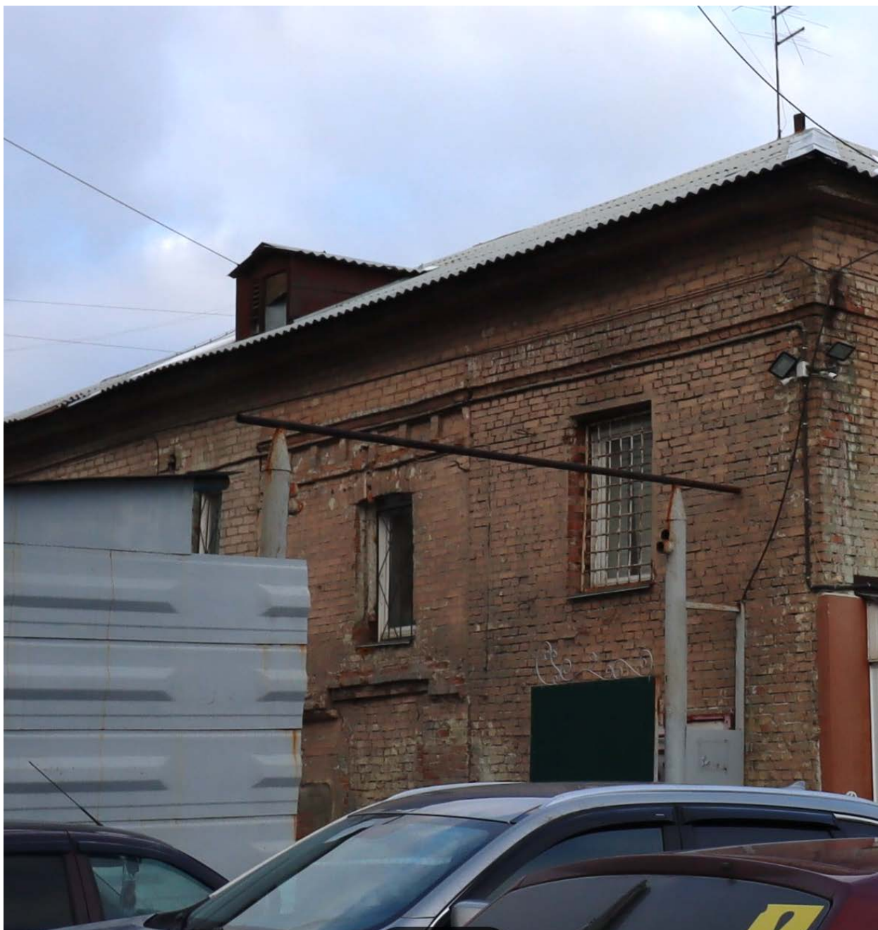
Фото.8 Выявленный объект культурного наследия «Дом Загуменного Ф. (низшая ремесленная школа)», расположенный по адресу: Челябинская область, г. Челябинск, ул. 1 Мая, 38. Южный фасад.
