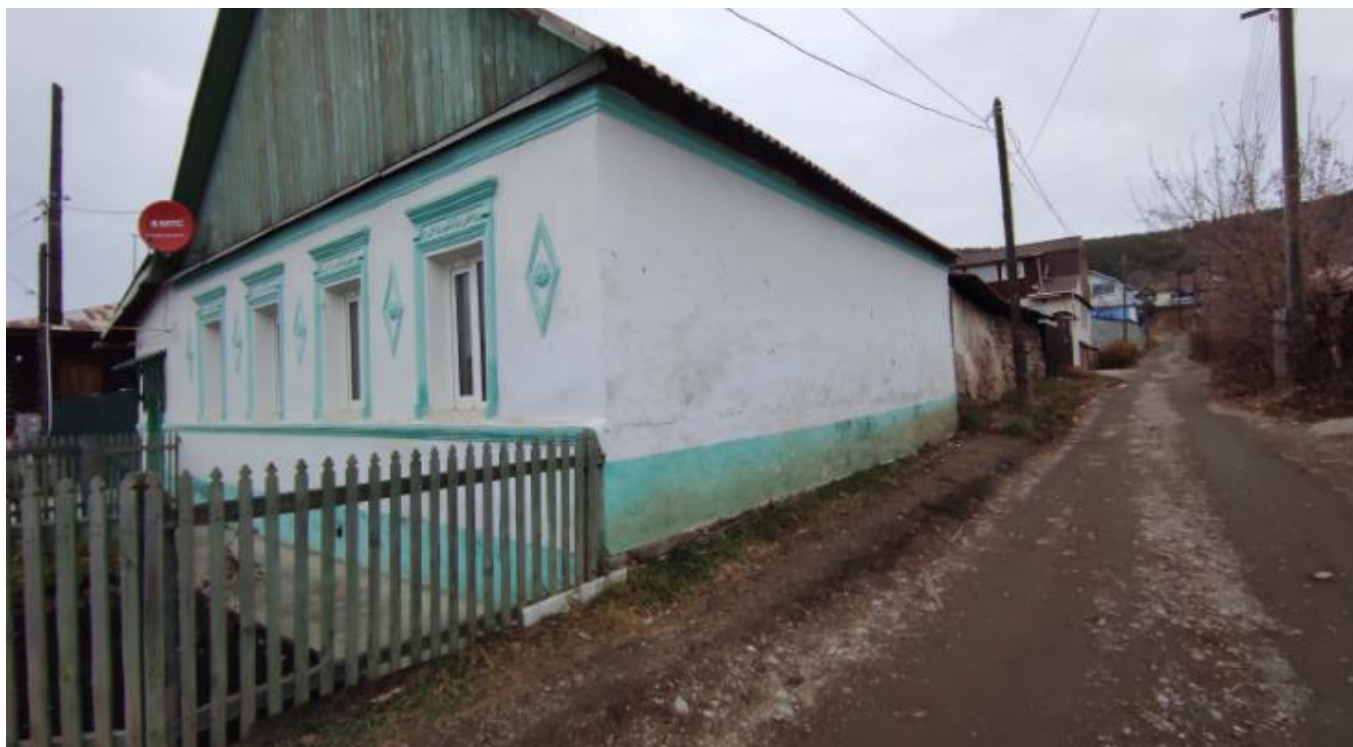
Фото 4. Вид на выявленный объект культурного наследия «Дом жилой 1-этажный каменный», расположенный по адресу: Челябинская область, Миасский городской округ, г. Миасс, Советская, 130.
