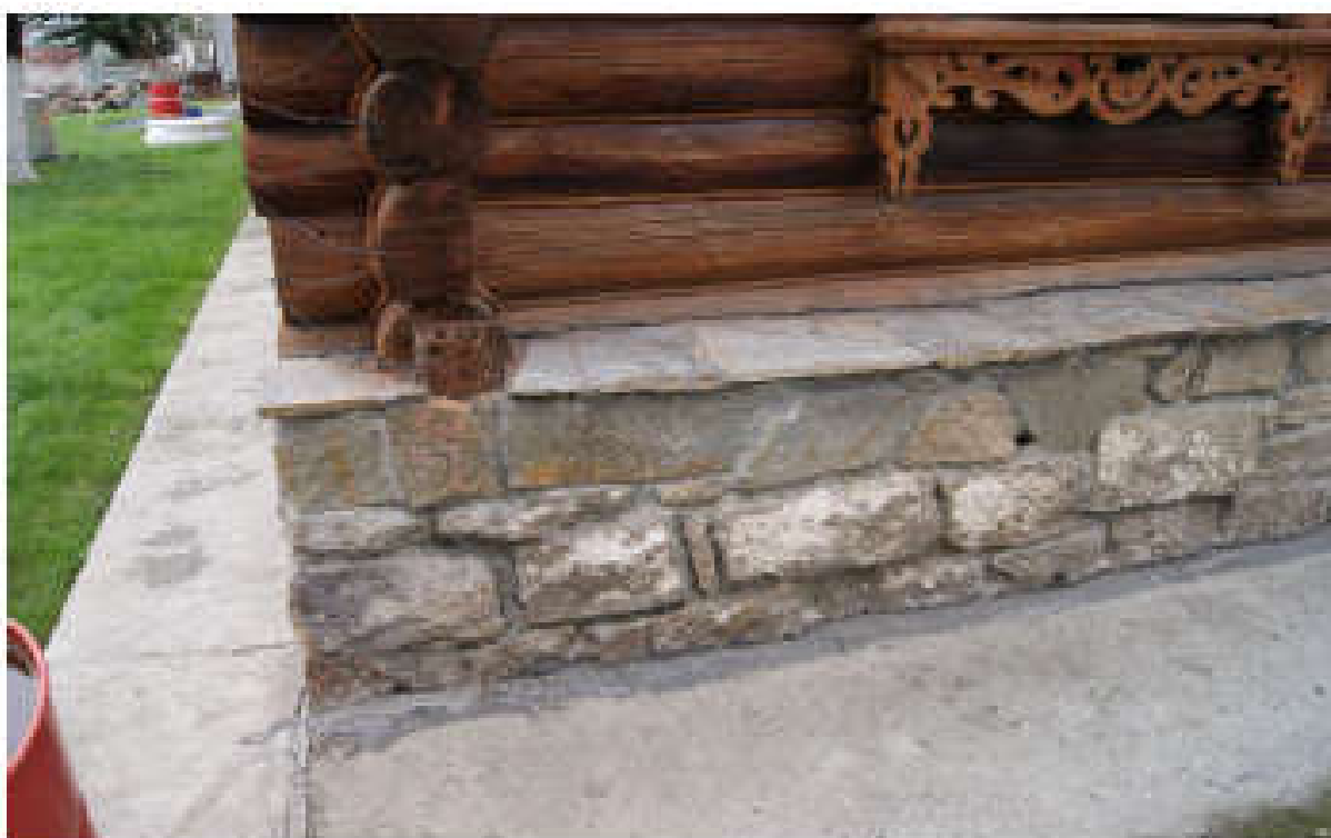
Фото 12. Фрагмент поковой части здания с западной стороны
