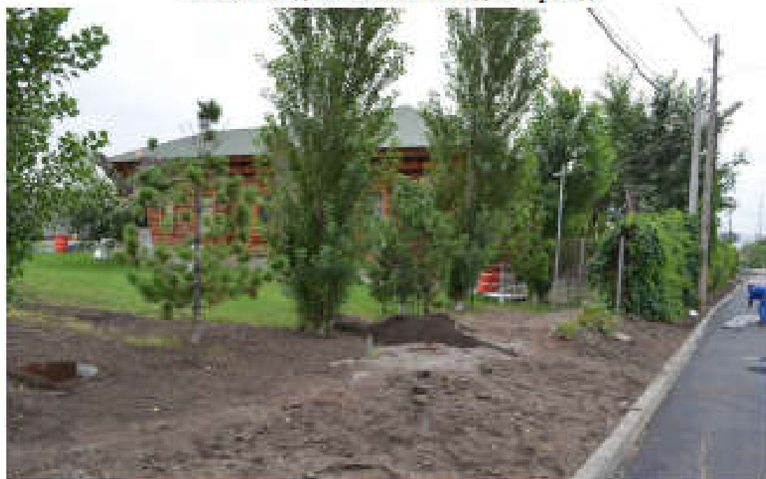
Фото 2. Вид на здание с северо-западной стороны
