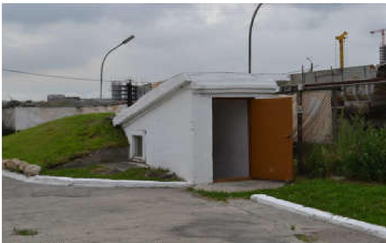
Фото 30. Вид на сохранившийся ледник, расположенный на участке дома
