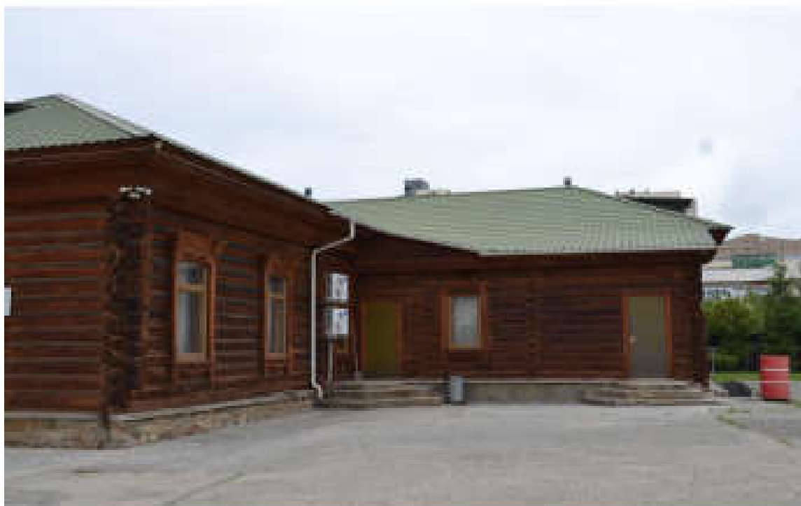
Фото 8. Вид на юго-восточную часть здания
