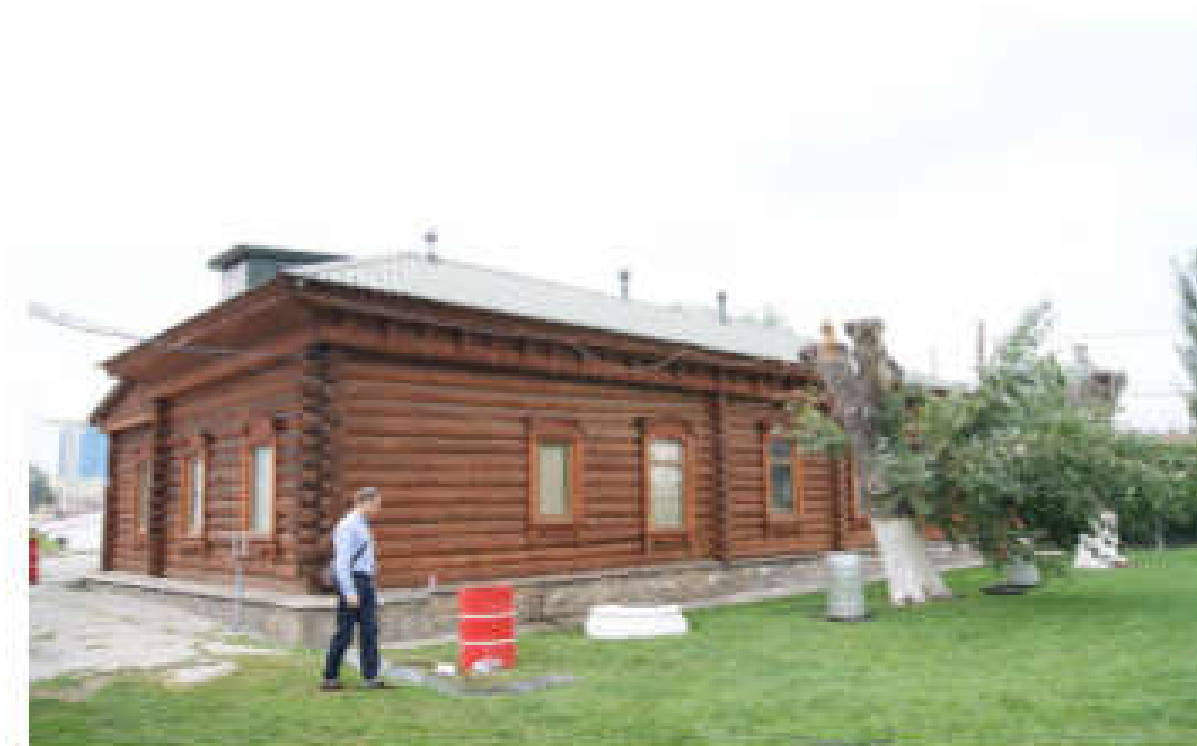
Фото 5. Вид на здание с северо-восточной стороны
