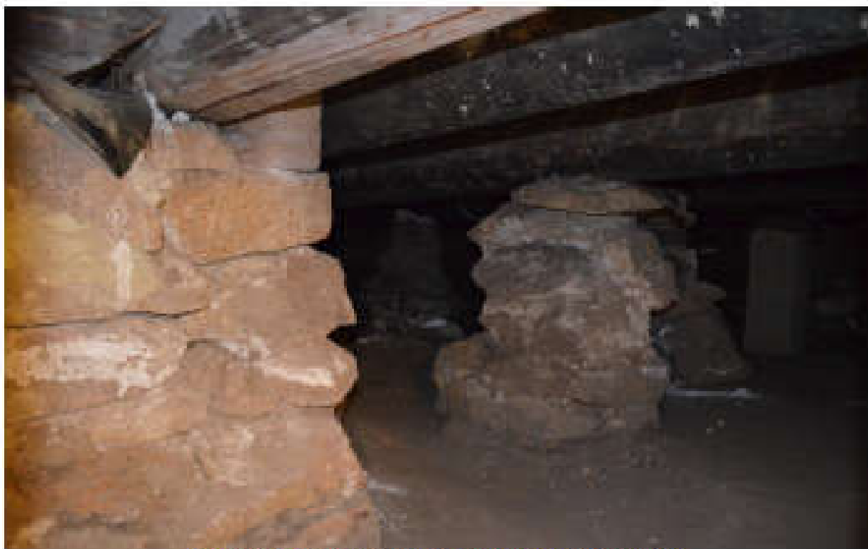
Фото 29. Внутреннее пространство подпола.
