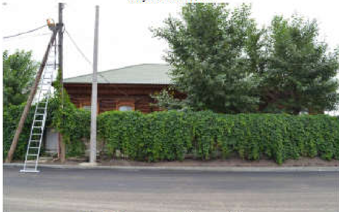
Фото 1. Вид на главный западный фасад
