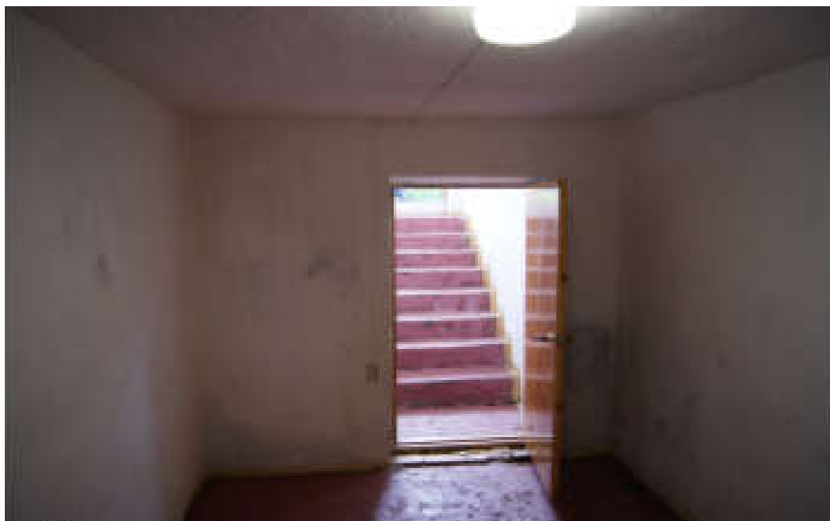
Фото 31. Помещение сохранившегося ледника с бетонным лестничным маршем
