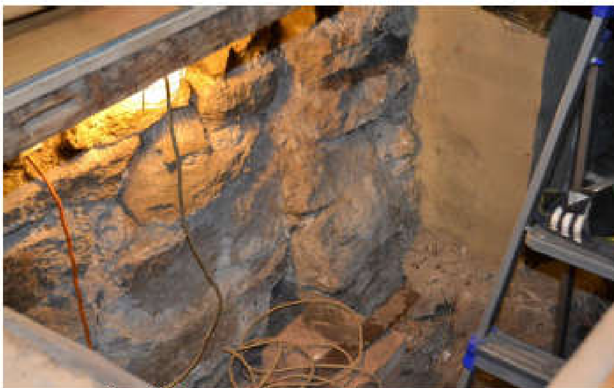
Фото 28. Фрагмент бутового фундамента в подполе
