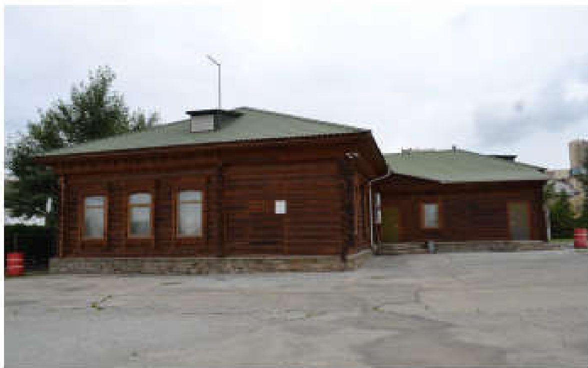
Фото 6. Вид на здание с юго-восточной стороны
