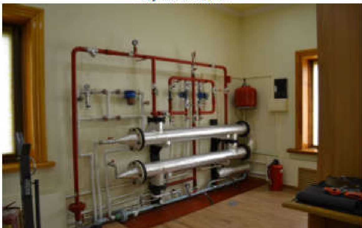
Фото 25. Фрагмент интерьера помещения № 4 (по техпаспорту БТИ)
