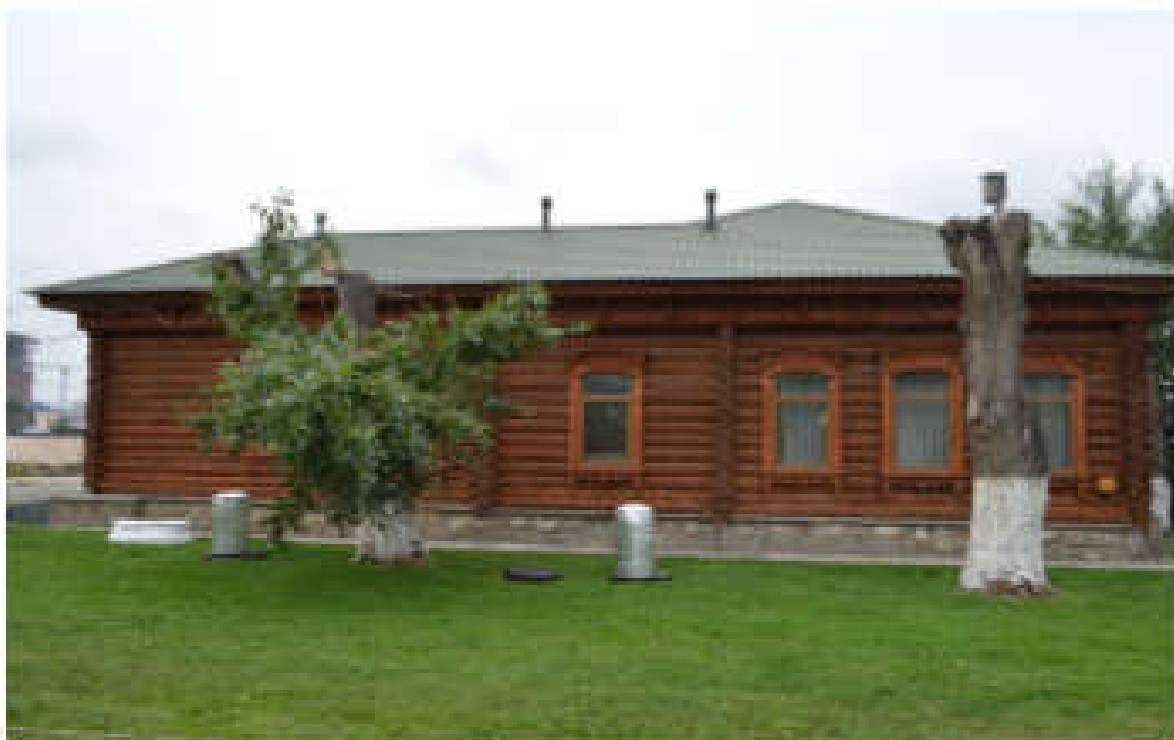
Фото 3. Вид на северный фасад здания
