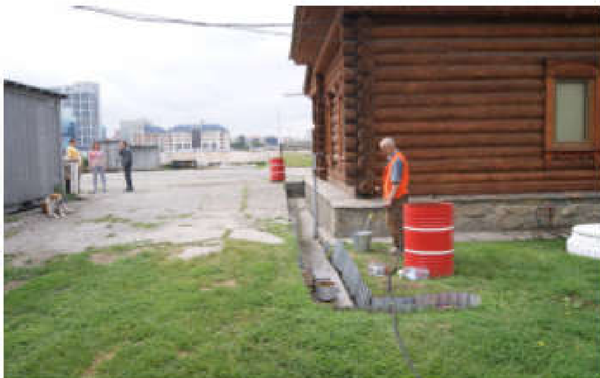
Фото 13. Вид на здание с северо-востока с открытым водоотводом
