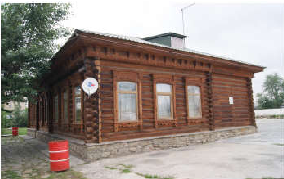
Фото 4. Вид на здание с юго-западной стороны
