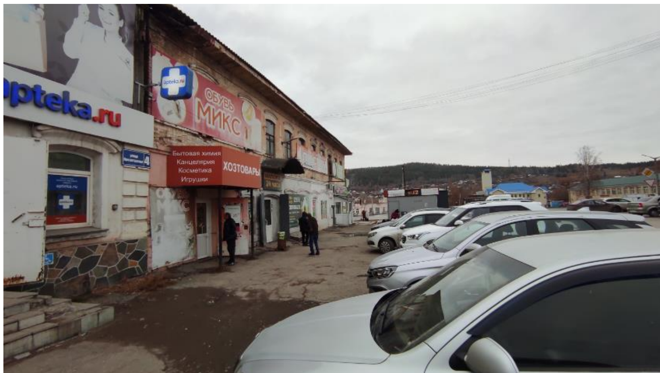
Фото 11. Вид на выявленный объект культурного наследия «Дом жилой 2-этажный каменный», расположенный по адресу: Челябинская область, Миасский городской округ, г. Миасс, ул. Пролетарская, 4.
