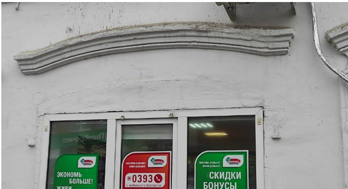
Фото 7. Вид на выявленный объект культурного наследия «Дом жилой 2-этажный каменный», расположенный по адресу: Челябинская область, Миасский городской округ, г. Миасс, ул. Пролетарская, 4.
