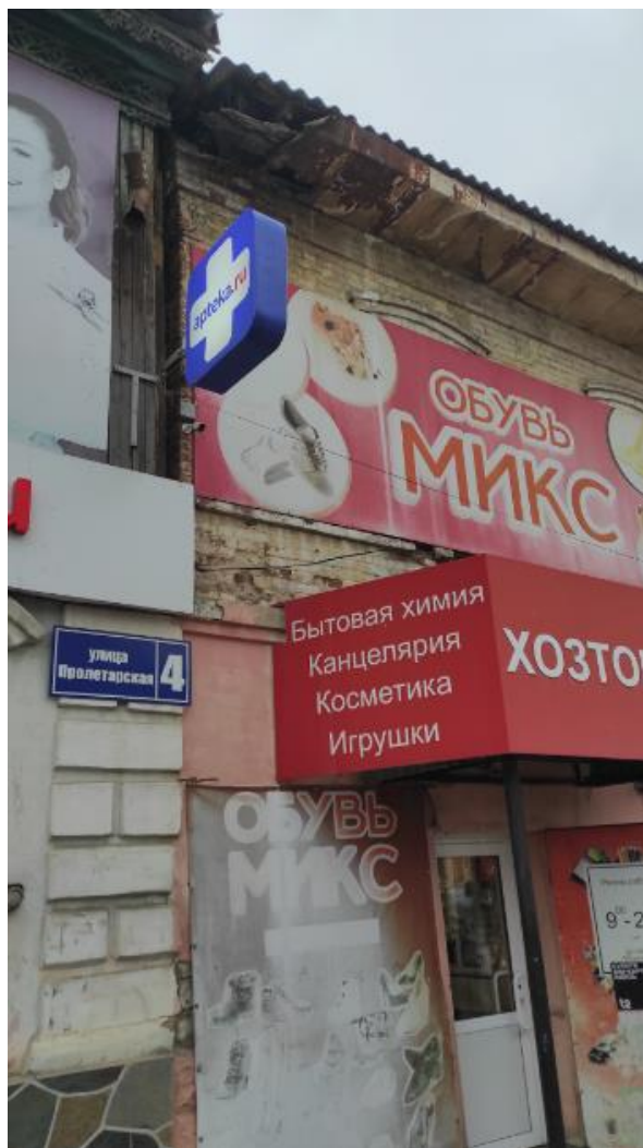
Фото 10. Вид на выявленный объект культурного наследия «Дом жилой 2-этажный каменный», расположенный по адресу: Челябинская область, Миасский городской округ, г. Миасс, ул. Пролетарская, 4.
