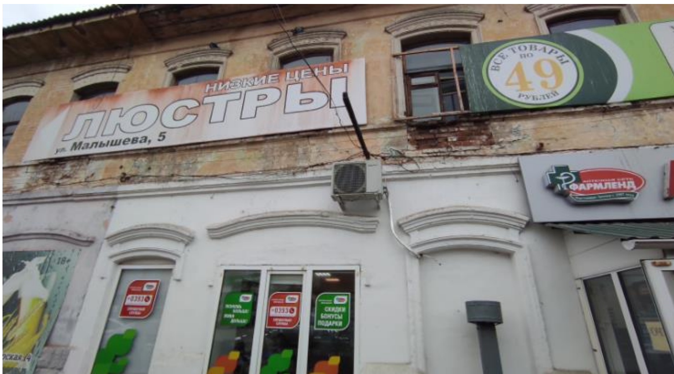
Фото 8. Вид на выявленный объект культурного наследия «Дом жилой 2-этажный каменный», расположенный по адресу: Челябинская область, Миасский городской округ, г. Миасс, ул. Пролетарская, 4.
