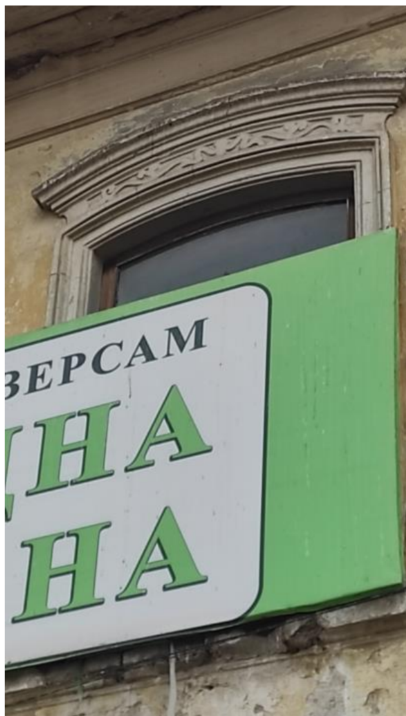
Фото 2. Вид на выявленный объект культурного наследия «Дом жилой 2-этажный каменный», расположенный по адресу: Челябинская область, Миасский городской округ, г. Миасс, ул. Пролетарская, 4.
