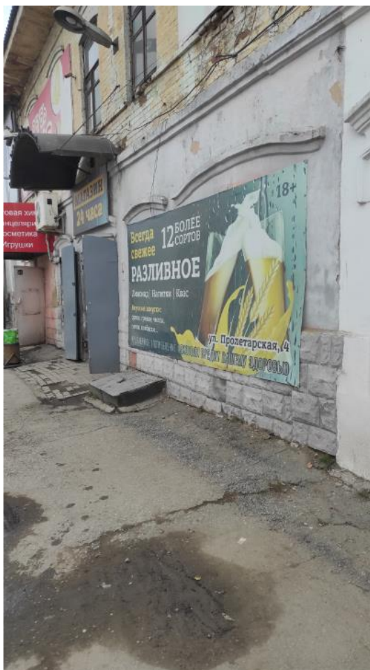
Фото 9. Вид на выявленный объект культурного наследия «Дом жилой 2-этажный каменный», расположенный по адресу: Челябинская область, Миасский городской округ, г. Миасс, ул. Пролетарская, 4.
