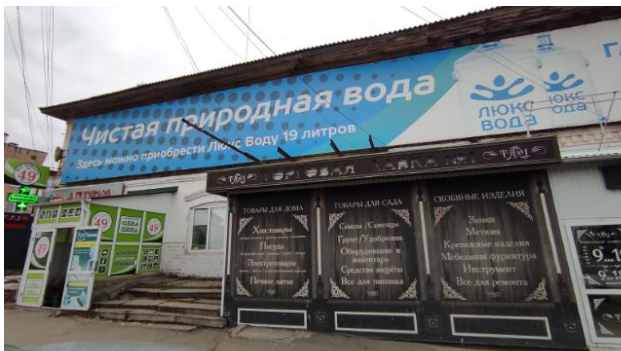
Фото 6. Вид на выявленный объект культурного наследия «Дом жилой 2-этажный каменный», расположенный по адресу: Челябинская область, Миасский городской округ, г. Миасс, ул. Пролетарская, 4.
