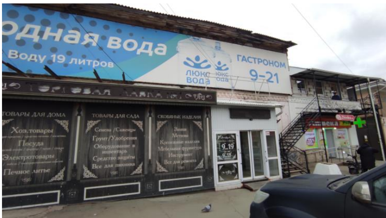
Фото 5. Вид на выявленный объект культурного наследия «Дом жилой 2-этажный каменный», расположенный по адресу: Челябинская область, Миасский городской округ, г. Миасс, ул. Пролетарская, 4.
