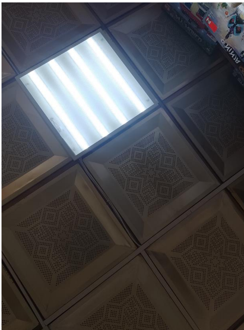
Фото 12. Интерьер выявленного объекта культурного наследия «Дом жилой 2-этажный каменный», расположенного по адресу: Челябинская область, Миасский городской округ, г. Миасс, ул. Пролетарская, 4.
