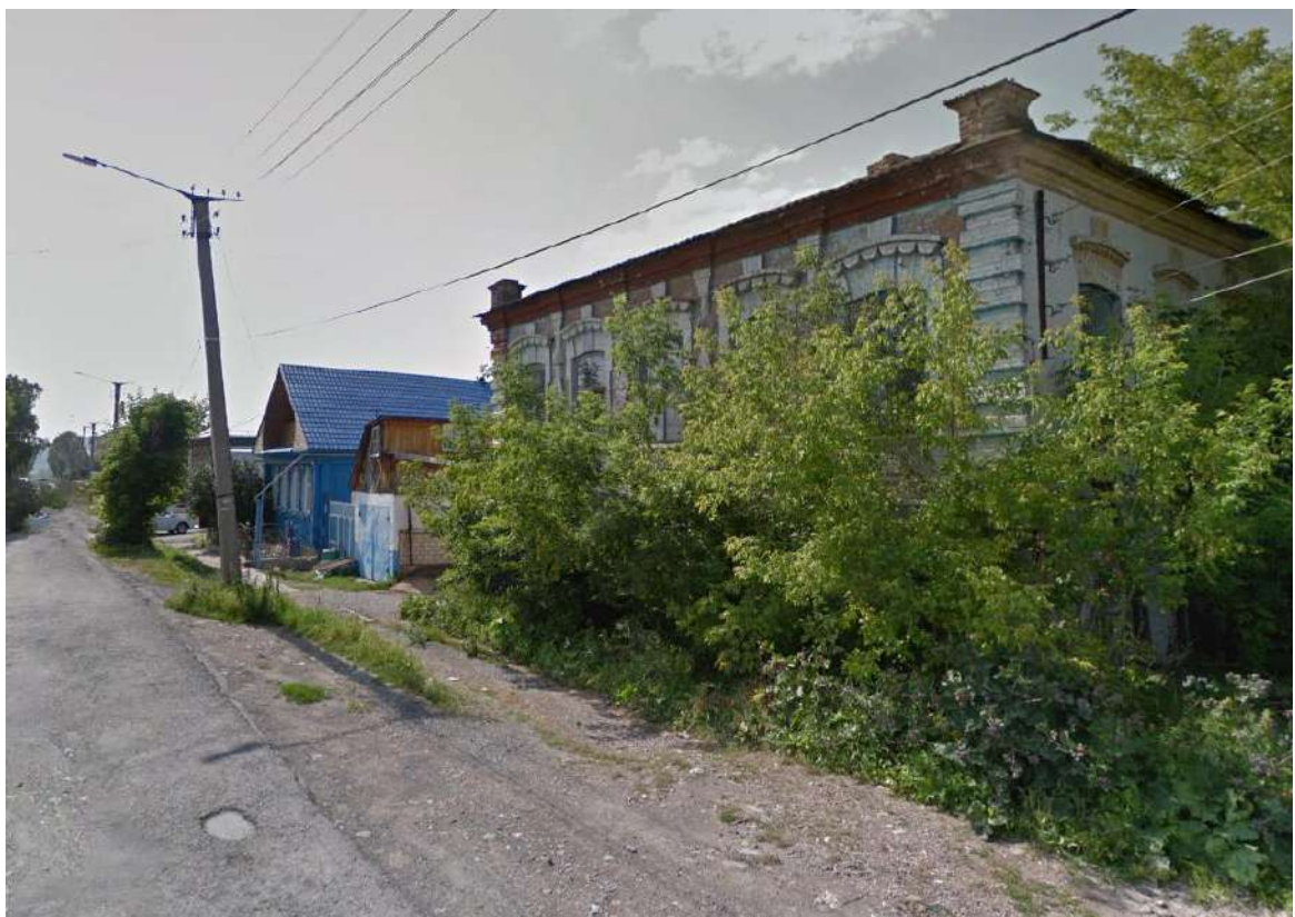
Фото 3. Вид на памятник в застройке с восточной стороны ул.К.Маркса. 06.07.2020г.
