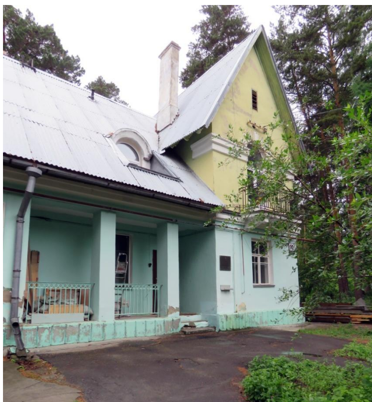
Рис. 5 а, б. Фрагменты главного фасада
