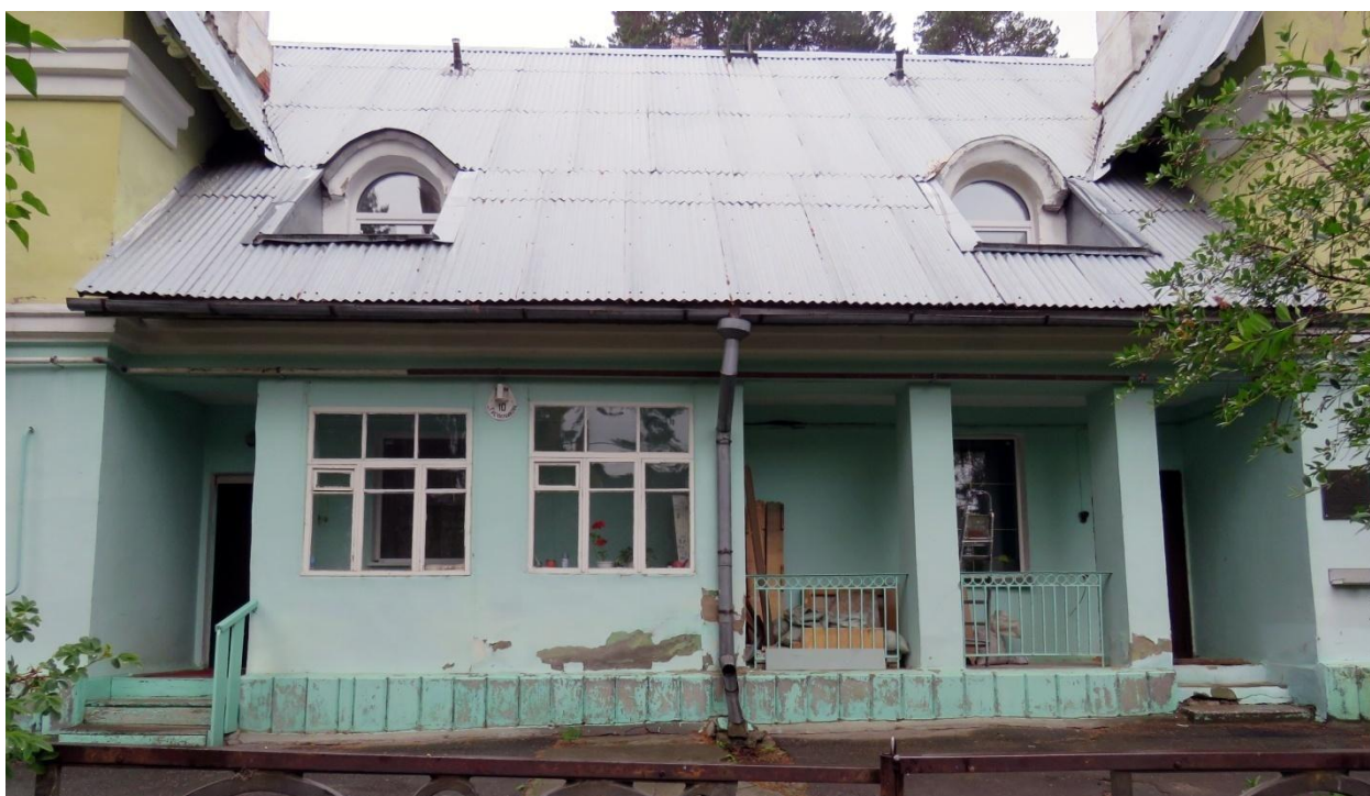
Рис. 4. Фрагмент главного фасада. Решение лицевого фасада среднего объема.
