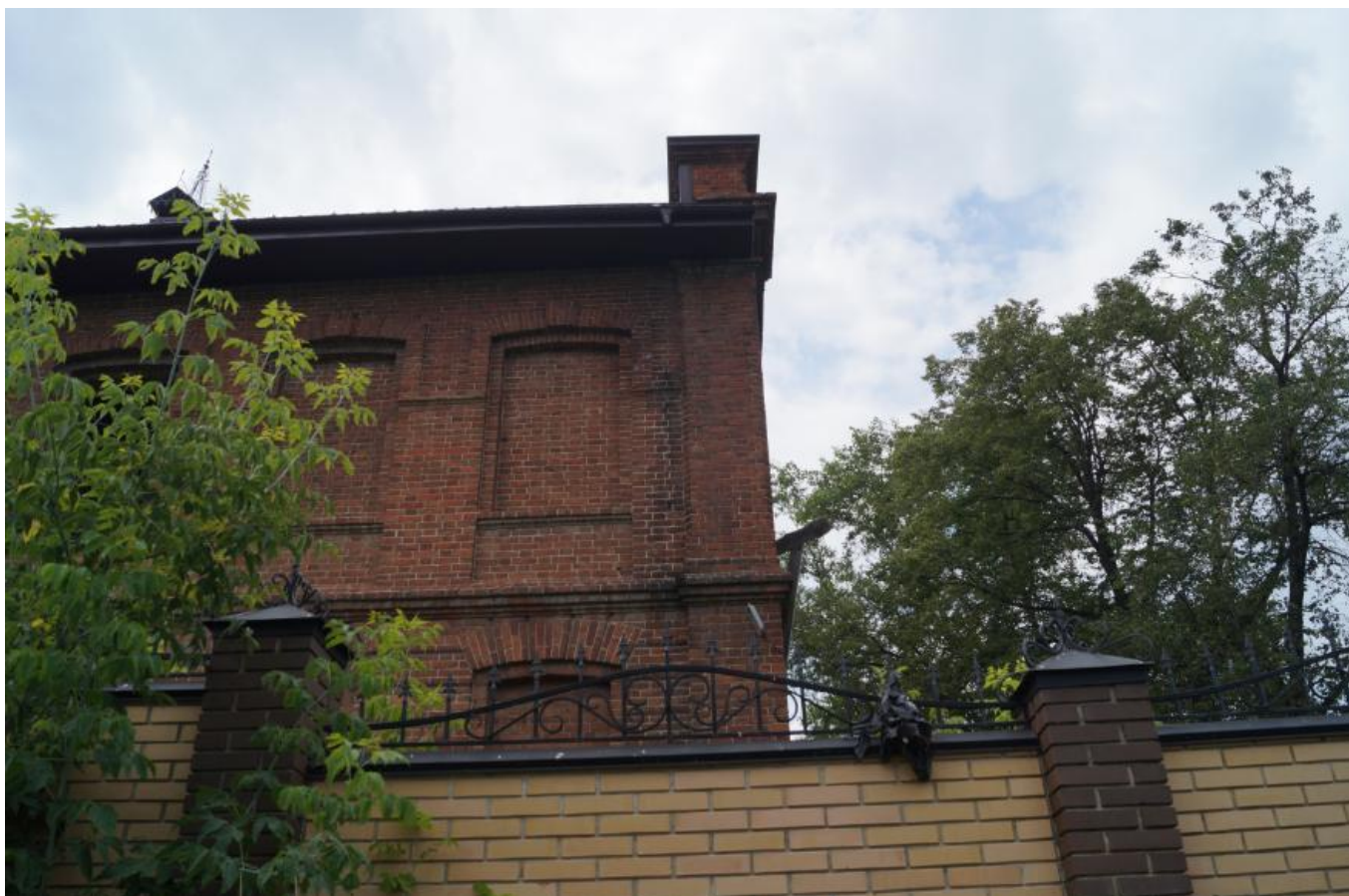
Фото 5. Вид на выявленный объект культурного наследия «Ремесленная школа», расположенный по адресу: Челябинская область, Миасский городской округ, г. Миасс, ул. Ремесленная, 8а.
