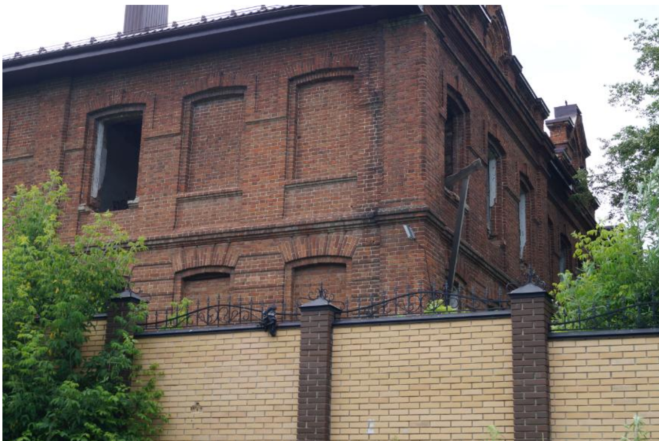
Фото 11. Вид на выявленный объект культурного наследия «Ремесленная школа», расположенный по адресу: Челябинская область, Миасский городской округ, г. Миасс, ул. Ремесленная, 8а.
