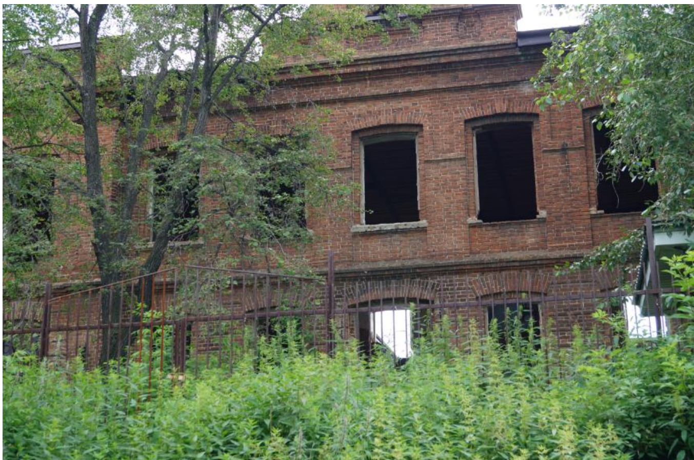
Фото 9. Вид на выявленный объект культурного наследия «Ремесленная школа», расположенный по адресу: Челябинская область, Миасский городской округ, г. Миасс, ул. Ремесленная, 8а.
