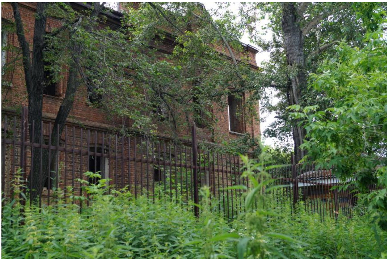
Фото 8. Вид на выявленный объект культурного наследия «Ремесленная школа», расположенный по адресу: Челябинская область, Миасский городской округ, г. Миасс, ул. Ремесленная, 8а.
