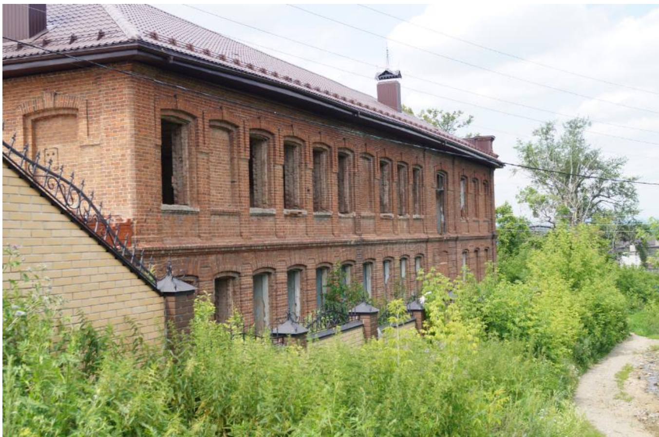
Фото 1. Вид на выявленный объект культурного наследия «Ремесленная школа», расположенный по адресу: Челябинская область, Миасский городской округ, г. Миасс, ул. Ремесленная, 8а.
