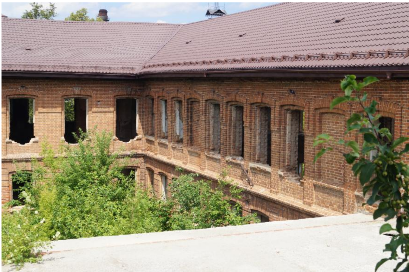
Фото 13. Вид на выявленный объект культурного наследия «Ремесленная школа», расположенный по адресу: Челябинская область, Миасский городской округ, г. Миасс, ул. Ремесленная, 8а.
