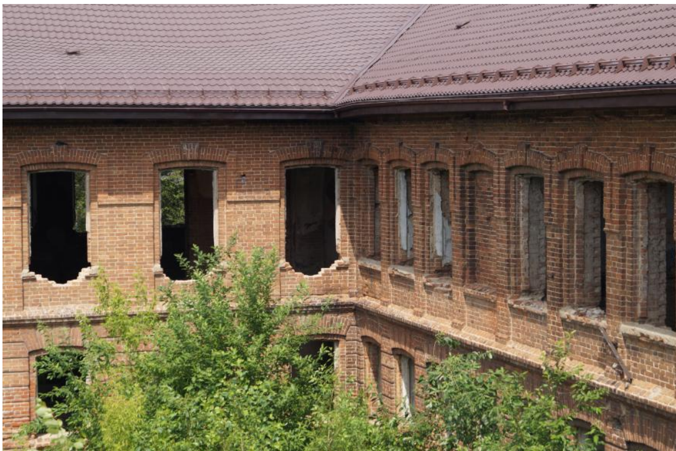
Фото 14. Вид на выявленный объект культурного наследия «Ремесленная школа», расположенный по адресу: Челябинская область, Миасский городской округ, г. Миасс, ул. Ремесленная, 8а.
