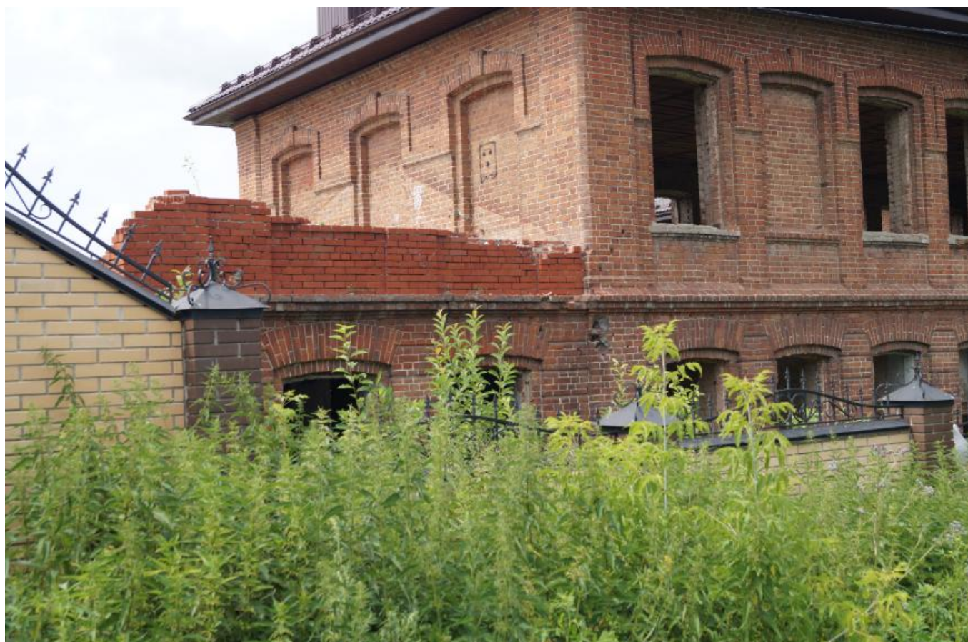
Фото 2. Вид на выявленный объект культурного наследия «Ремесленная школа», расположенный по адресу: Челябинская область, Миасский городской округ, г. Миасс, ул. Ремесленная, 8а.
