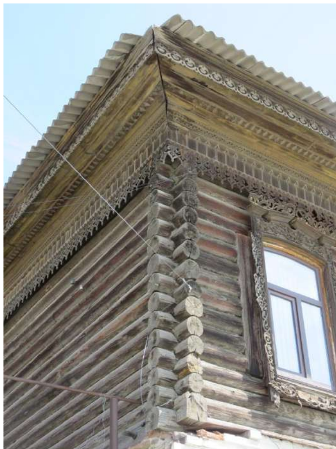
Рис. 9. Выпуск бревен сруба второго этажа и решение венчающей части
