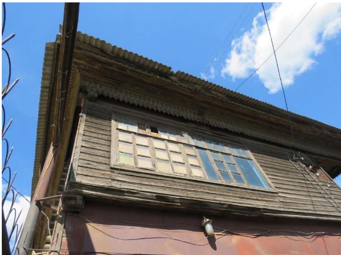
Рис. 18. Лестничный пристрой со стороны бокового, восточного фасада. Второй этаж
