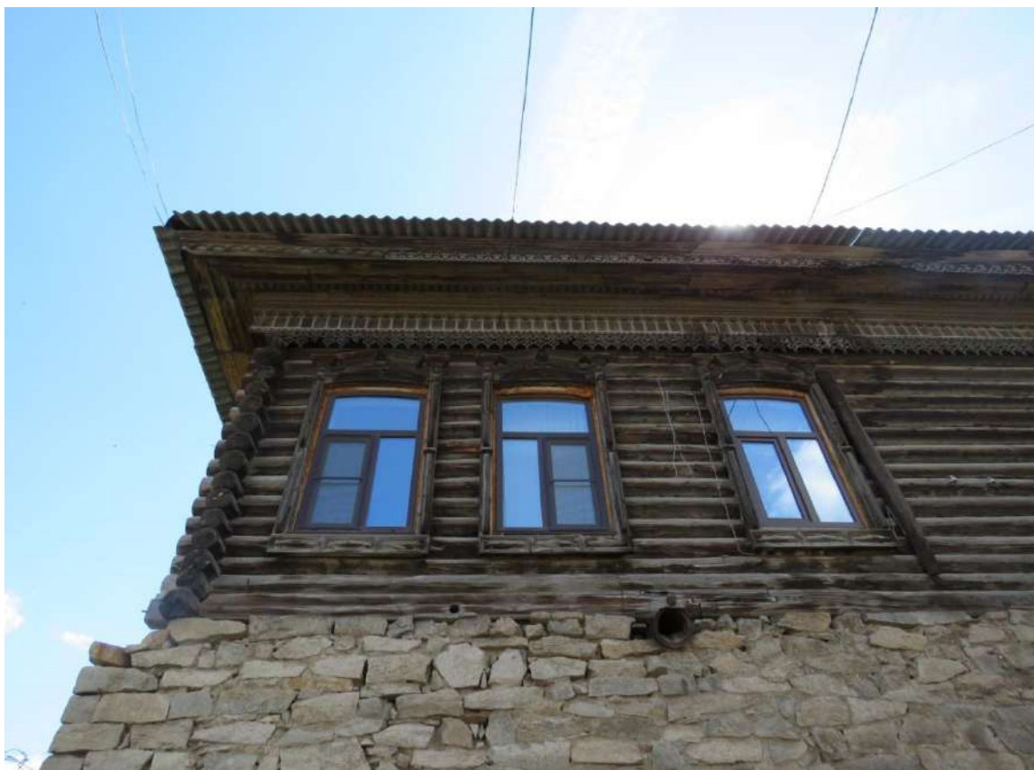
Рис. 12. Фрагмент бокового, западного фасада
