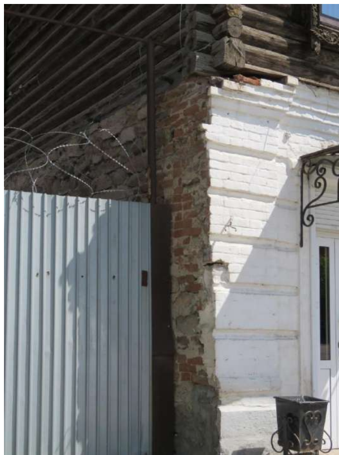
Рис. 6. Кирпичная кладка лицевой стены первого этажа
