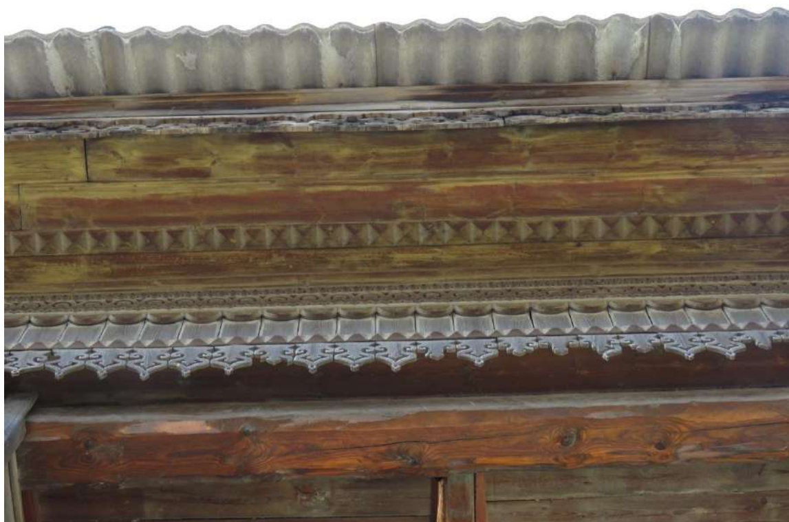
Рис. 19. Лестничный пристрой со стороны бокового, восточного фасада. Карниз
