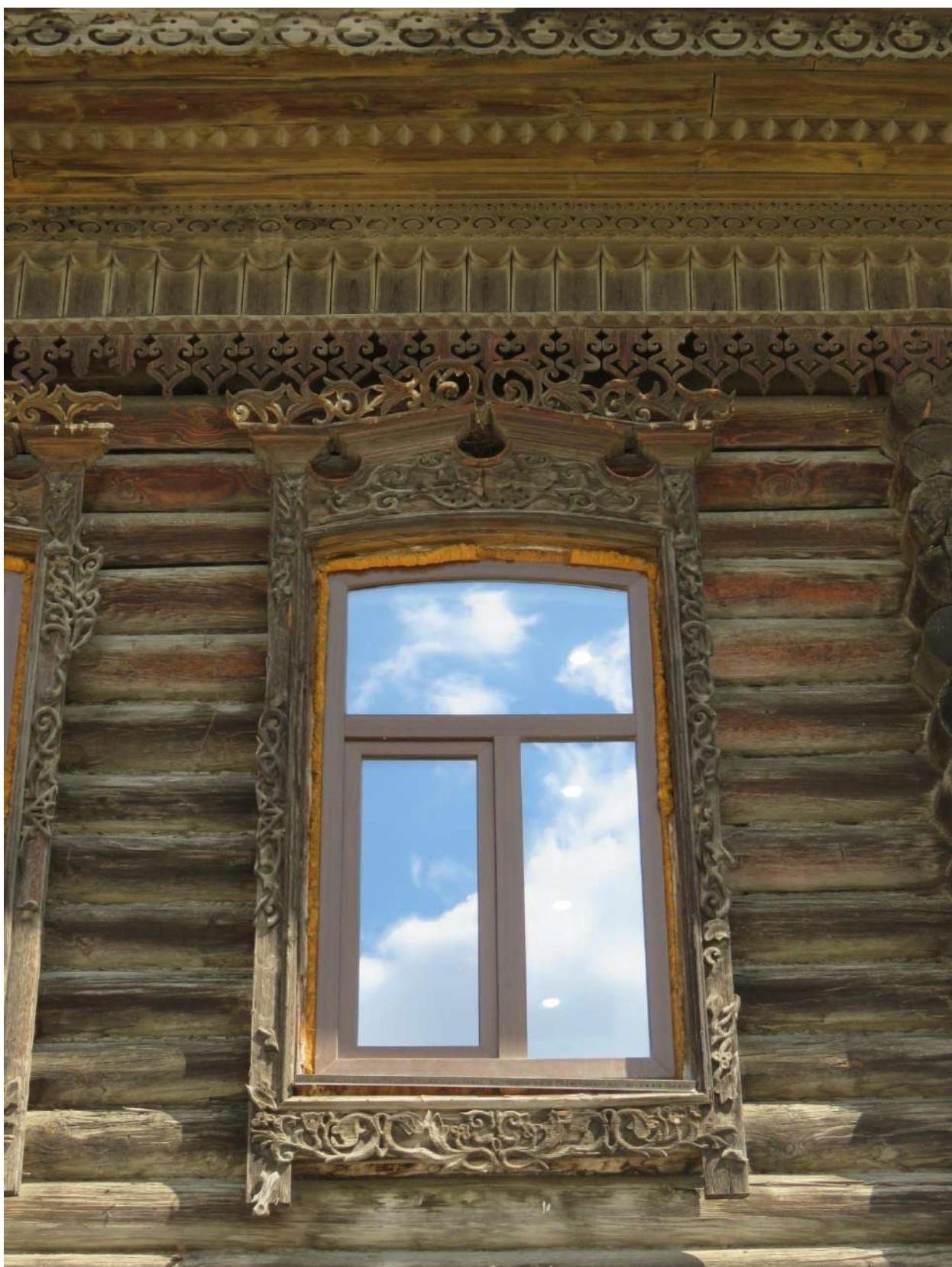
Рис. 8. Фрагмент главного фасада. Оформление оконного проема второго этажа
