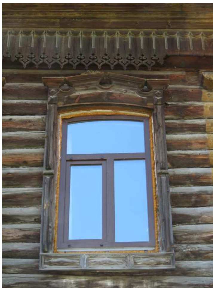
Рис. 15. Оформление оконного проема второго этажа дворового фасада
