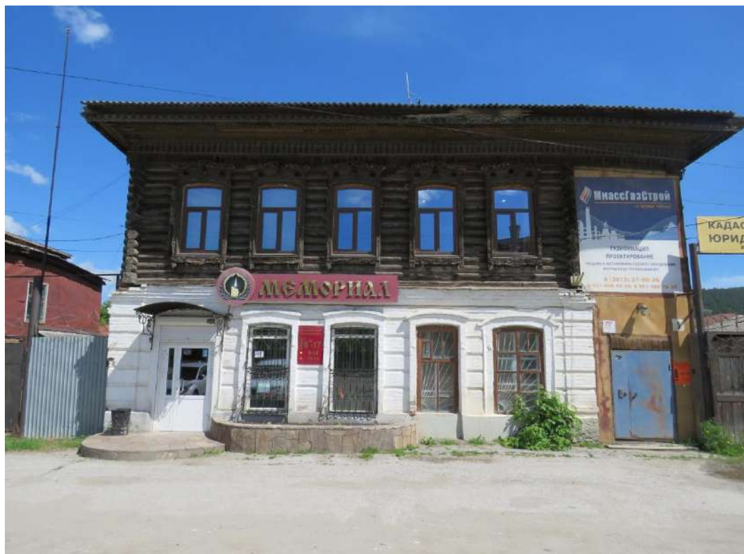
Рис. 5. Главный, южный фасад
