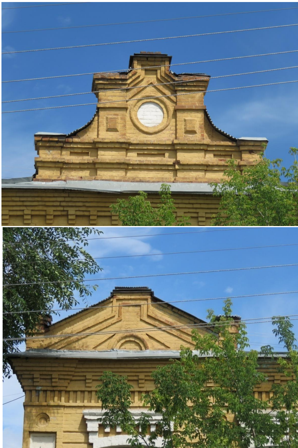
Рис. 7, 8. Фрагмент главного фасада здания магазина. Центральная и фланговая парпетные стенки
