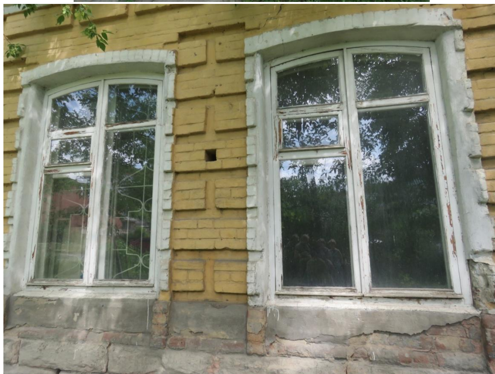
Рис. 3,4. Фрагмент главного фасада здания магазина. Оконные проемы первого этажа
