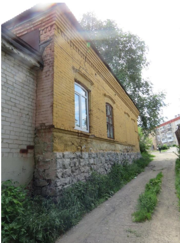
Рис. 14. Здание «Пивного зала». Боковой, западный фасад. Вид с северо-запада
