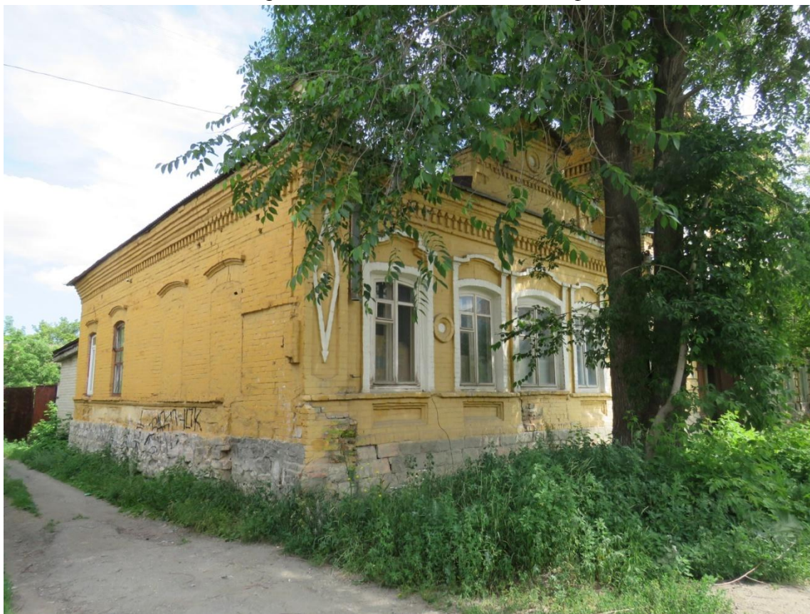
Рис. 10. Здание «Пивного зала». Фрагмент главного и боковой, западный фасад. Вид с юго-запада.
