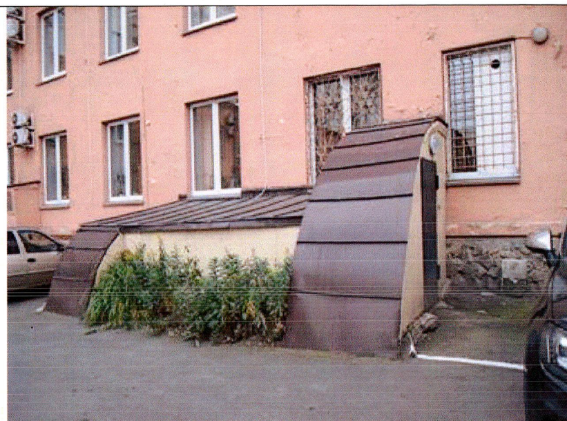
Вход в подвал из крытого приямка
