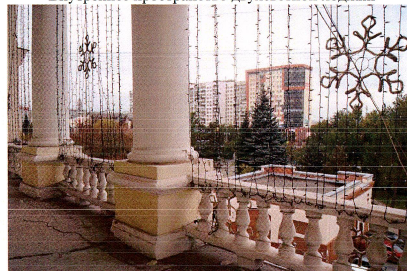
Вид на ограждение из балюстрады между квадратными постаментами для колонн коринфского ордера
