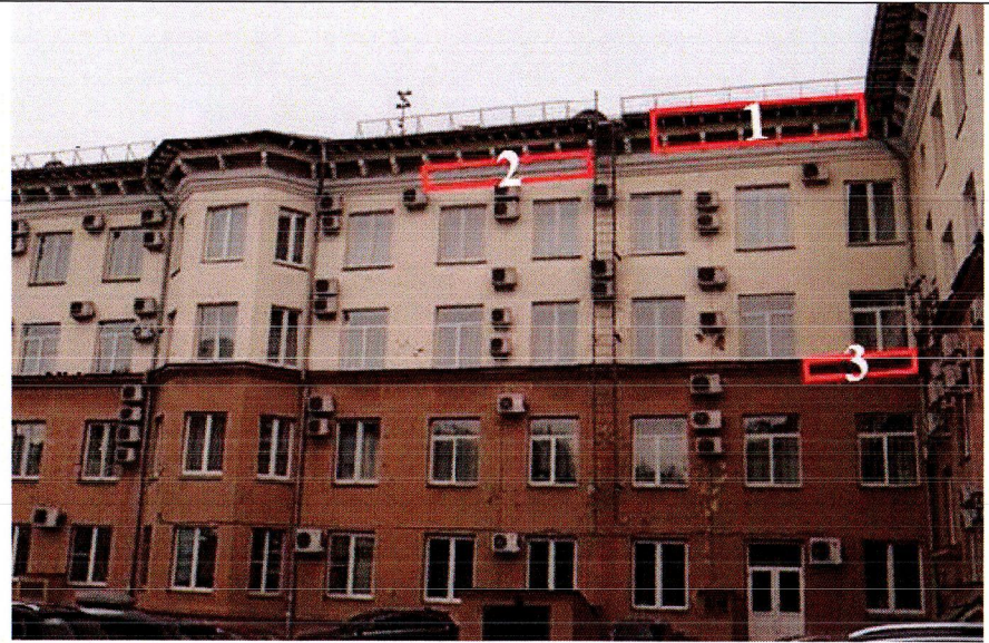
Фрагмент западного дворового фасада
