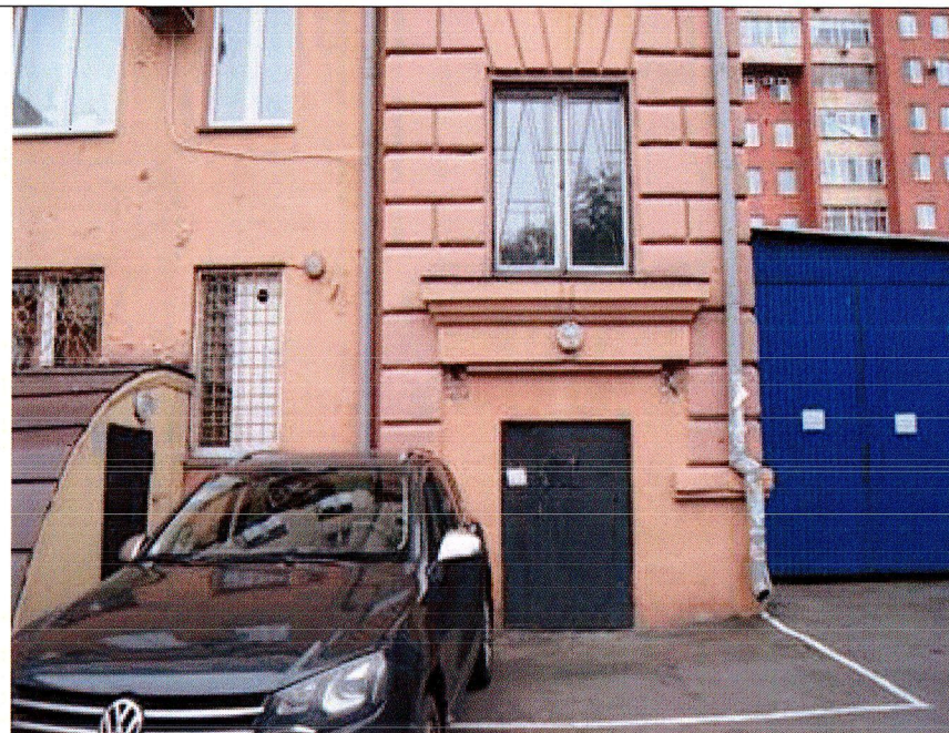
Вид на служебный вход в здание со стороны северного дворового фасада
