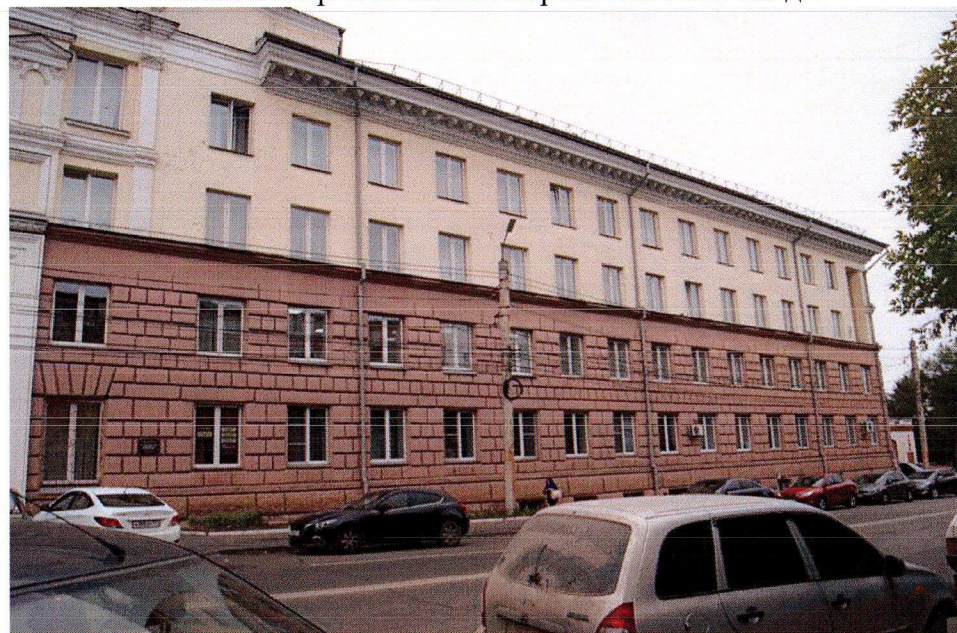
Фрагмент главного восточного фасада
