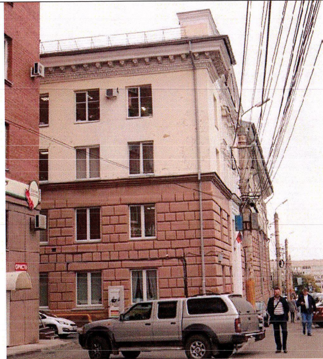
Фрагмент южного фасада. Вид с юго-востока
