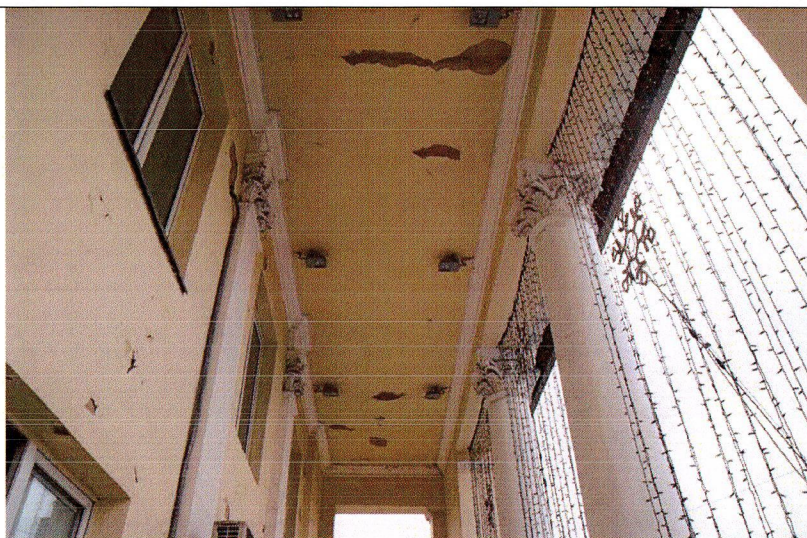
Вид на потолок двухсветной лоджии, обработанный карнизными тягами по всему периметру
