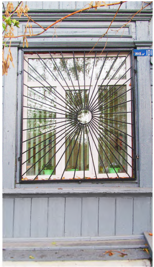
Рис. 17 Вид на декоративное оформление трехстворчатого окна главного фасада здания
