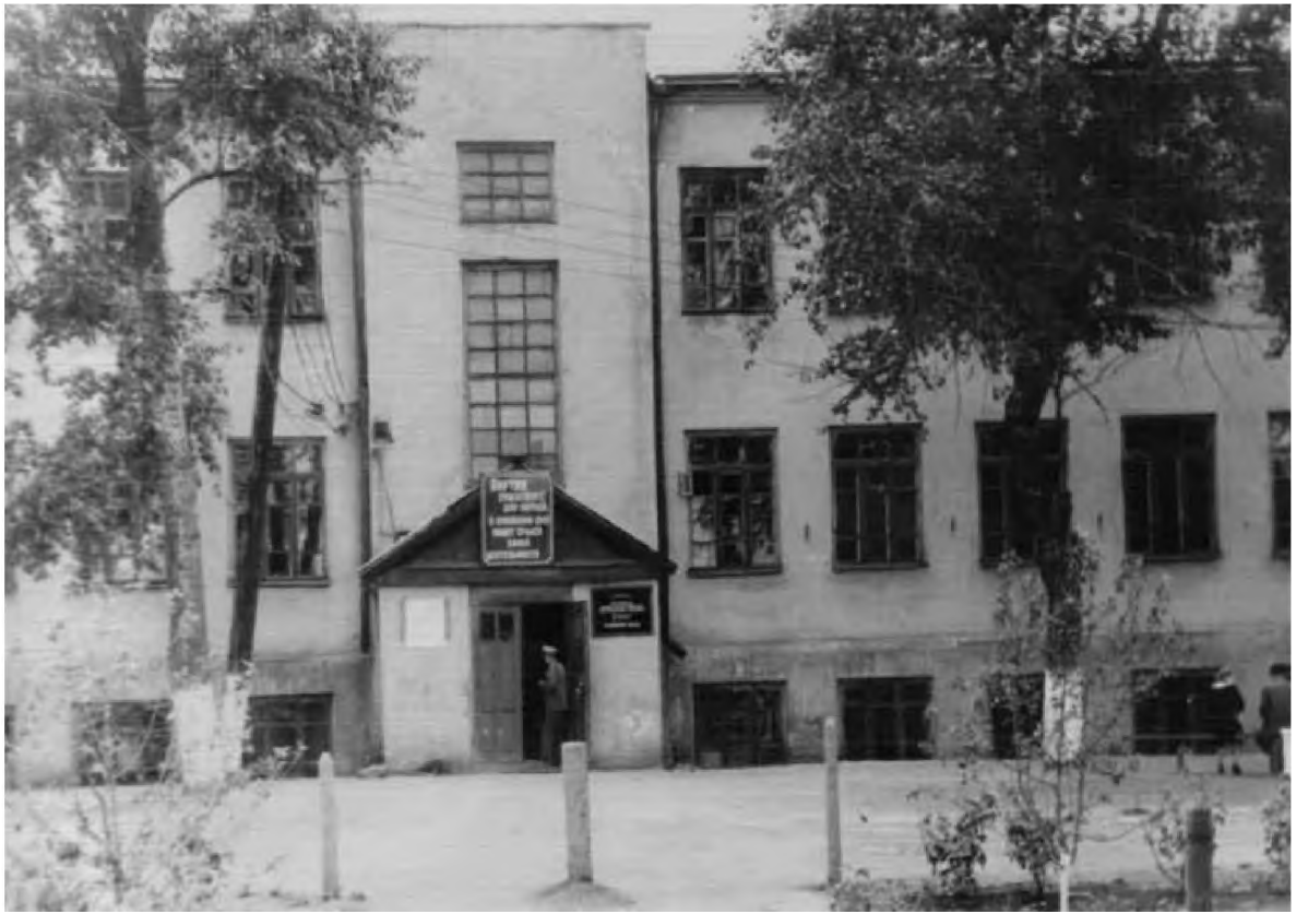
Рис. 16 Здание Учебно-консультационного пункта Всесоюзного заочного института инженеров железнодорожного транспорта по ул.Свободы, 106Б (Фото 1950-60-х гг.)// Фонды Музея истории Челябинского института путей сообщения. Ссылка: https://img-fotki.yandex.ru/get/4130/674039.508/0_a0 a7d_41817147_orig .
