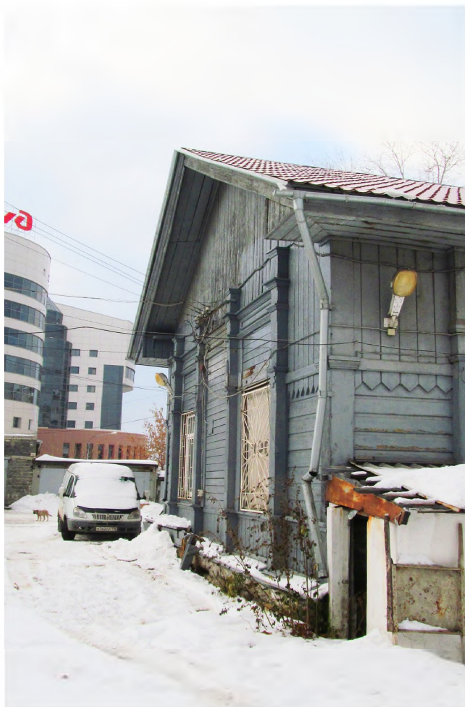
Рис. 12 Вид на северный ризалит восточного фасада здания со стороны дворовой территории
