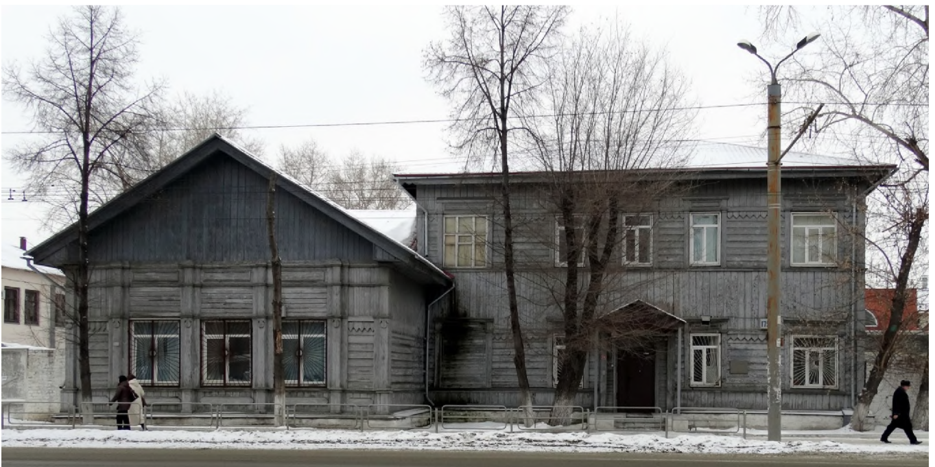
Рис. 42 Здание Следственной части Южно-Уральского УВД на транспорте (бывшее «2-классное мужское железнодорожное училище») по ул. Свободы, 175 (Фото – декабрь, 2014 г.). Ссылка: https://pp.vk.me/c627119/v627119914/46ea9/AfZh1oxyZZo.jpg .
