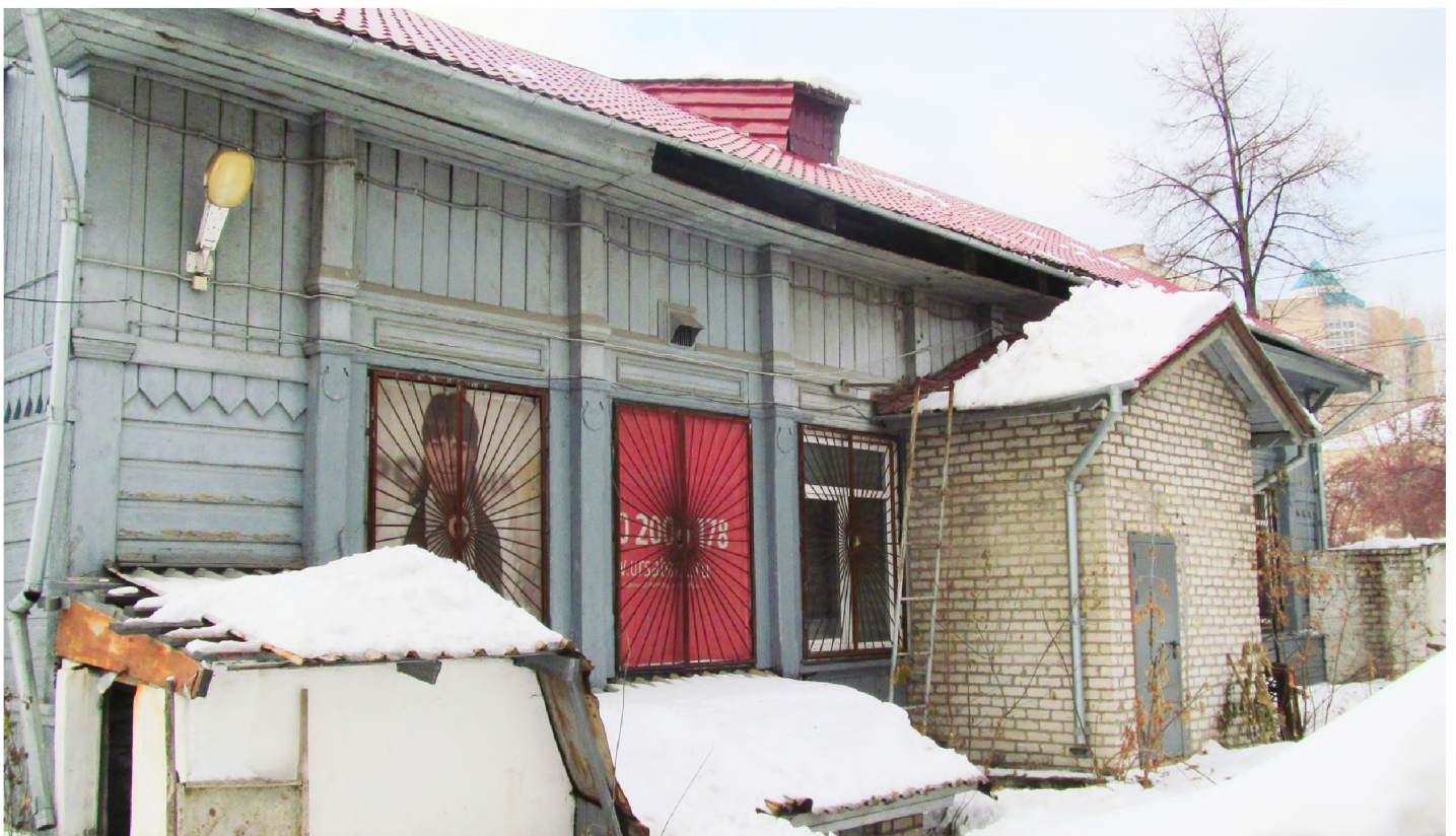
Рис. 9 Вид на северный фасад здания со стороны дворовой территории
