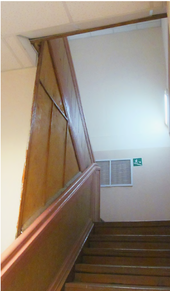
Рис. 33 Вид на лестничную клетку с 1-го этажа
