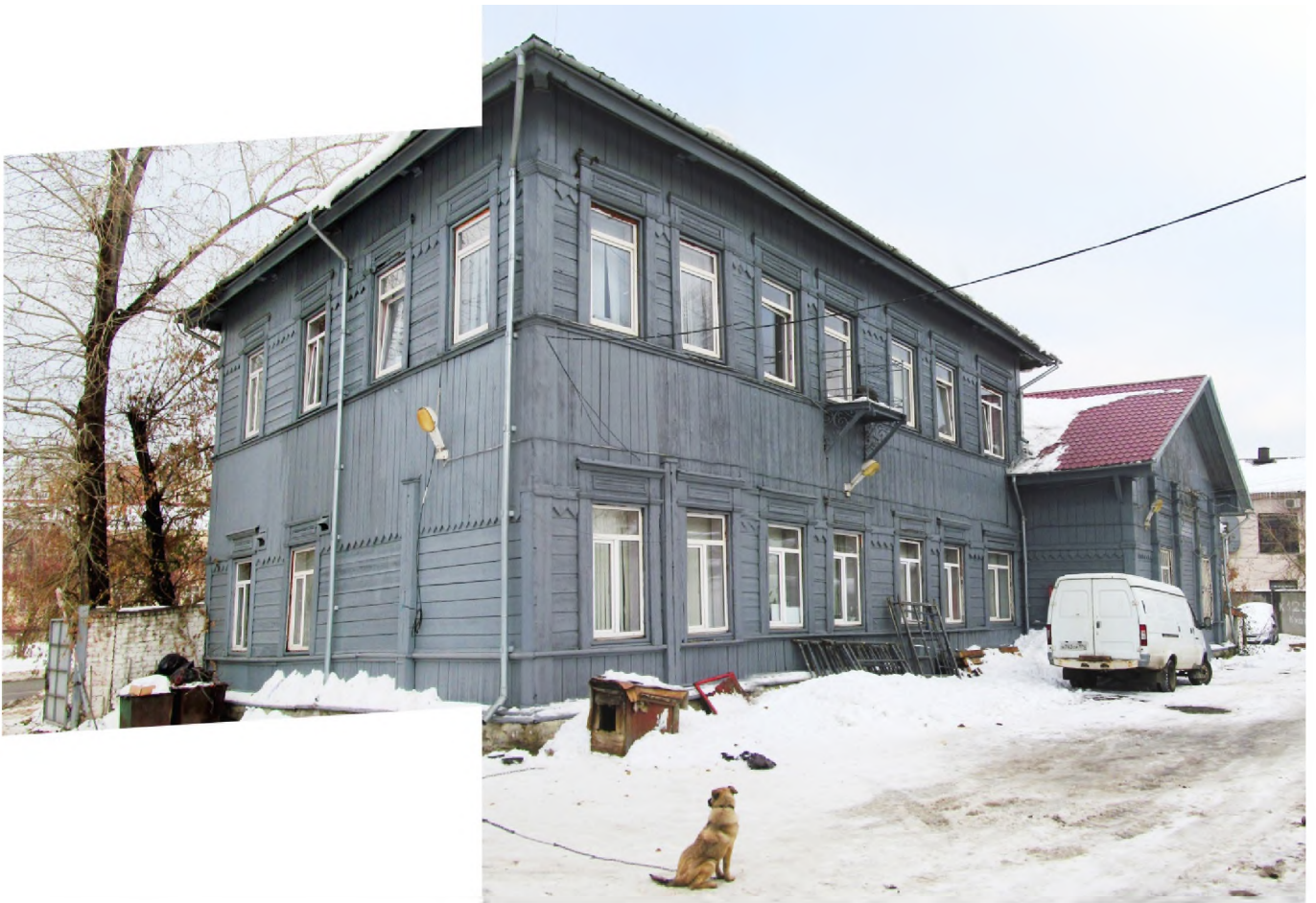
Рис. 8 Вид на юго-восточный фасад здания со стороны дворовой территории
