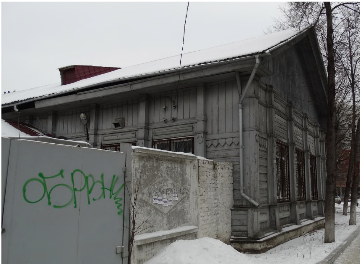
Рис. 44 Фрагмент южного фасада здания Следственной части Южно-Уральского УВД на транспорте (бывшее «2-классное мужское железнодорожное училище») по ул. Свободы, 175 (Фото – декабрь, 2014 г.) Ссылка: https://pp.vk.me/c627119/v627119914/46ebc/Os1cn-JzNvI.jpg .
