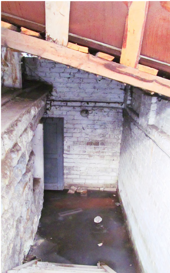
Рис. 27 Вид на спуск в неэксплуатируемый подвал, со стороны восточного фасада
