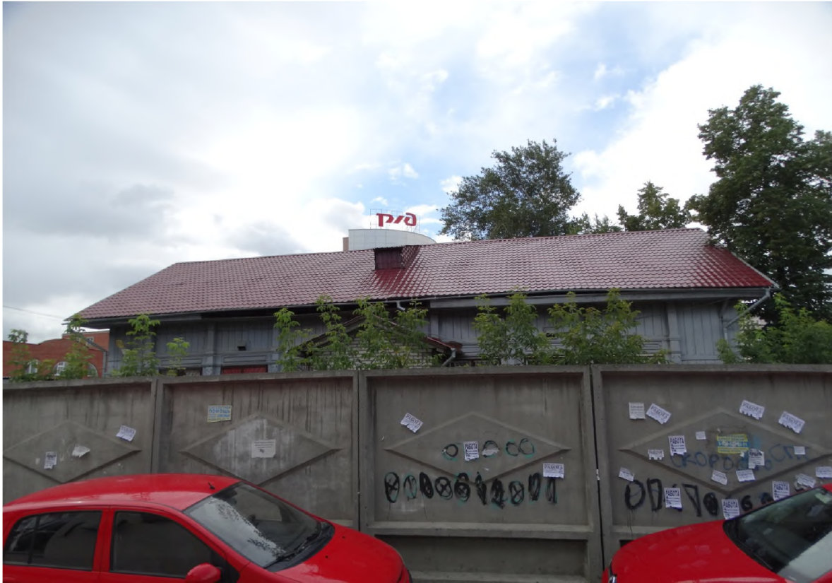
Рис. 49 Западный фасад здания Следственной части Южно-Уральского УВД на транспорте (бывшее «2-классное мужское железнодорожное училище») по ул. Свободы, 175 (Фото – август, 2015 г., автор – Ю. Латышев). Ссылка: https://pp.vk.me/c627119/v627119914/46e95/Zk29Yvpdn_c0.jpg .
