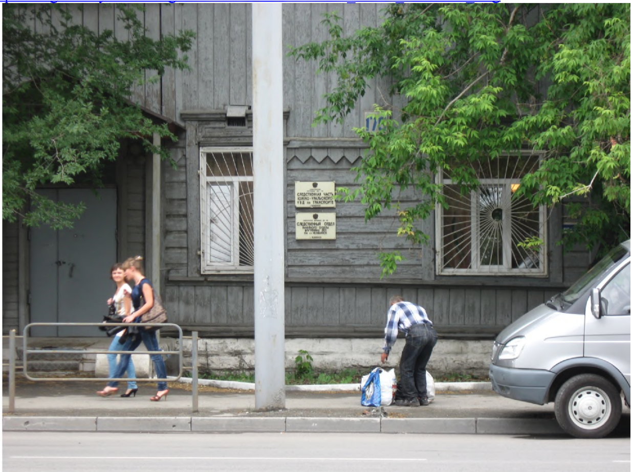
Рис. 32 Фрагмент фасада здания Следственной части Южно-Уральского УВД на транспорте (бывшее «2-классное мужское железнодорожное училище») по ул. Свободы, 175 (Фото – 2010 г.). Ссылка: https://img-fotki.yandex.ru/get/4206/vedmed1969.c1/0_32168_bf8f07f9_orig .
