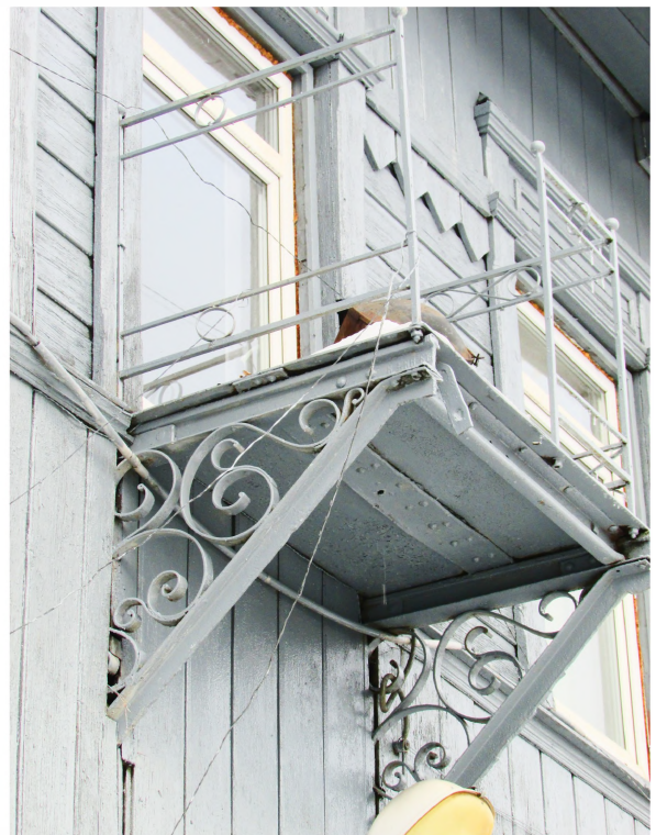
Рис. 19 Вид на балкон восточного фасада здания
