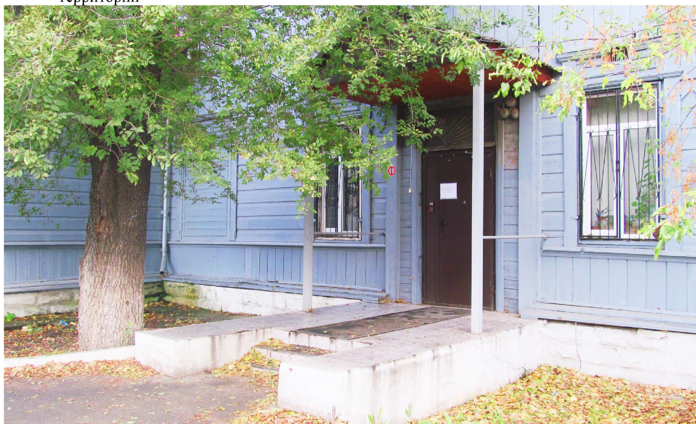
Рис. 13 Вид на крыльцо главного фасада здания
