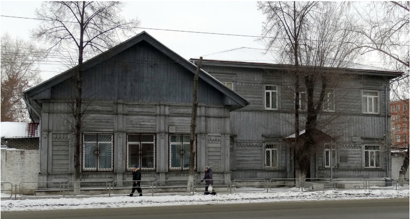
Рис. 43 Здание Следственной части Южно-Уральского УВД на транспорте (бывшее «2-классное мужское железнодорожное училище») по ул. Свободы, 175 (Фото – декабрь, 2014 г.). Ссылка: https://img-fotki.yandex.ru/get/15584/5661614.9c/0_ad27b_4a_e3d97c_orig .
