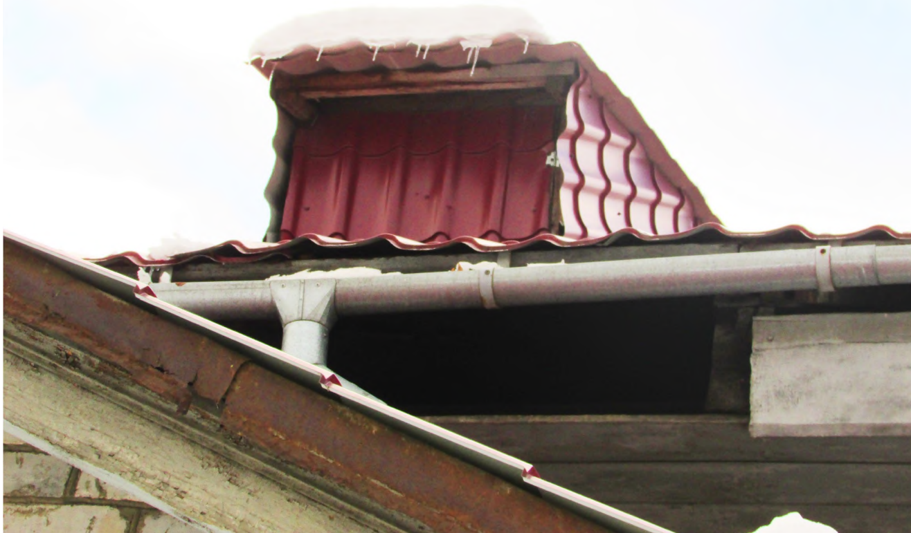
Рис. 20 Вид на слуховое окно северного фасада здания
