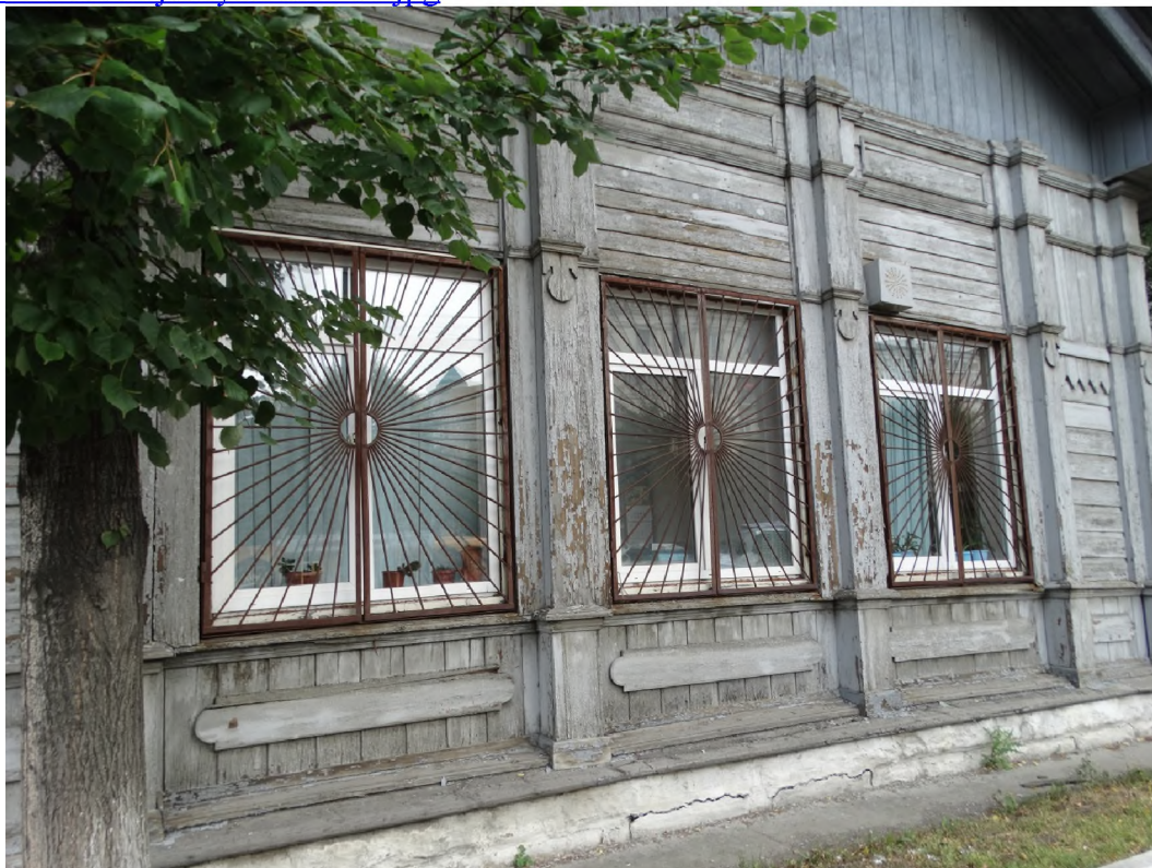
Рис. 48 Фрагмент южного фасада здания Следственной части Южно-Уральского УВД на транспорте (бывшее «2-классное мужское железнодорожное училище») по ул. Свободы, 175 (Фото – август, 2015 г., автор – Ю. Латышев). Ссылка: https://pp.vk.me/c627119/v627119914/46e9f/xklhj2SBEM0.jpg .
