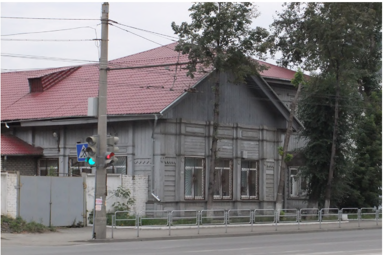
Рис. 34 Здание Следственной части Южно-Уральского УВД на транспорте (бывшее «2-классное мужское железнодорожное училище») по ул. Свободы, 175 (Фото – сентябрь, 2011 г.). Ссылка: https://img-fotki.yandex.ru/get/4414/32494785.21a/0_727ba_f50d980d_orig .
