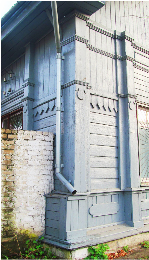
Рис. 22 Вид на угловую лопатку северного ризалита здания
