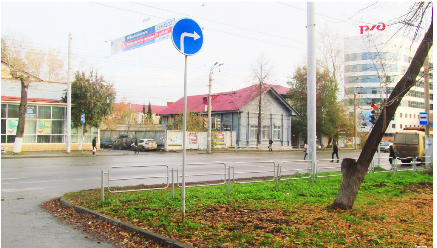
Рис. 2 Вид на здание бывшего мужского училища с северо-запада со стороны ул. Свободы
