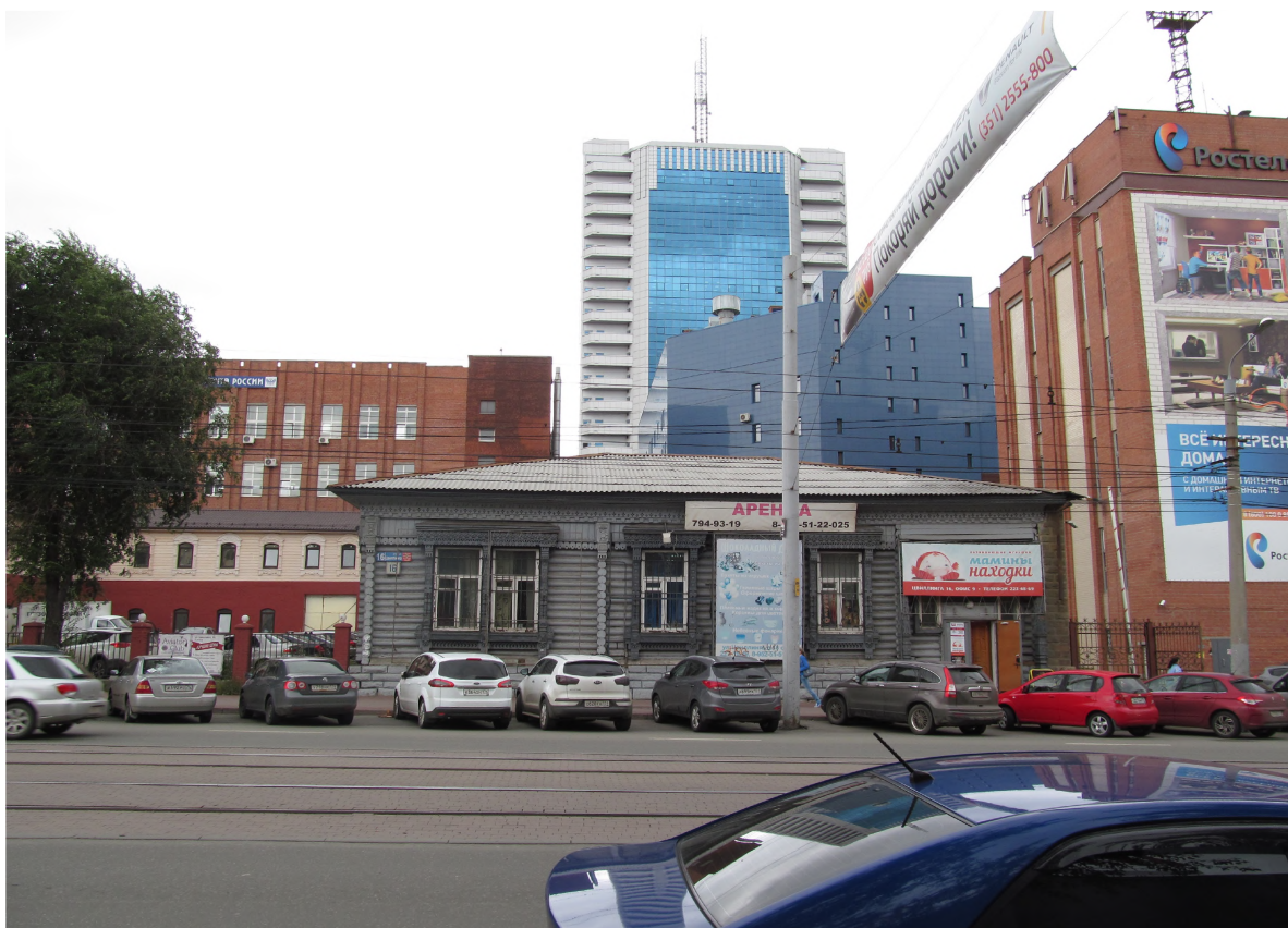
Рис. 27 «Дом П.А. Агапова» по ул. Цвиллинга, 16 (1906-1907гг.). Аналогичное композиционное построение. Схожее решение прикарнизной зоны - вертикальные ламели вагоки перерезает пояс, ниже пояса выпуски с фигурным завершением. Переход от деревянной стены к гранитному цоколю. Совпадает цвет стен — серый.
