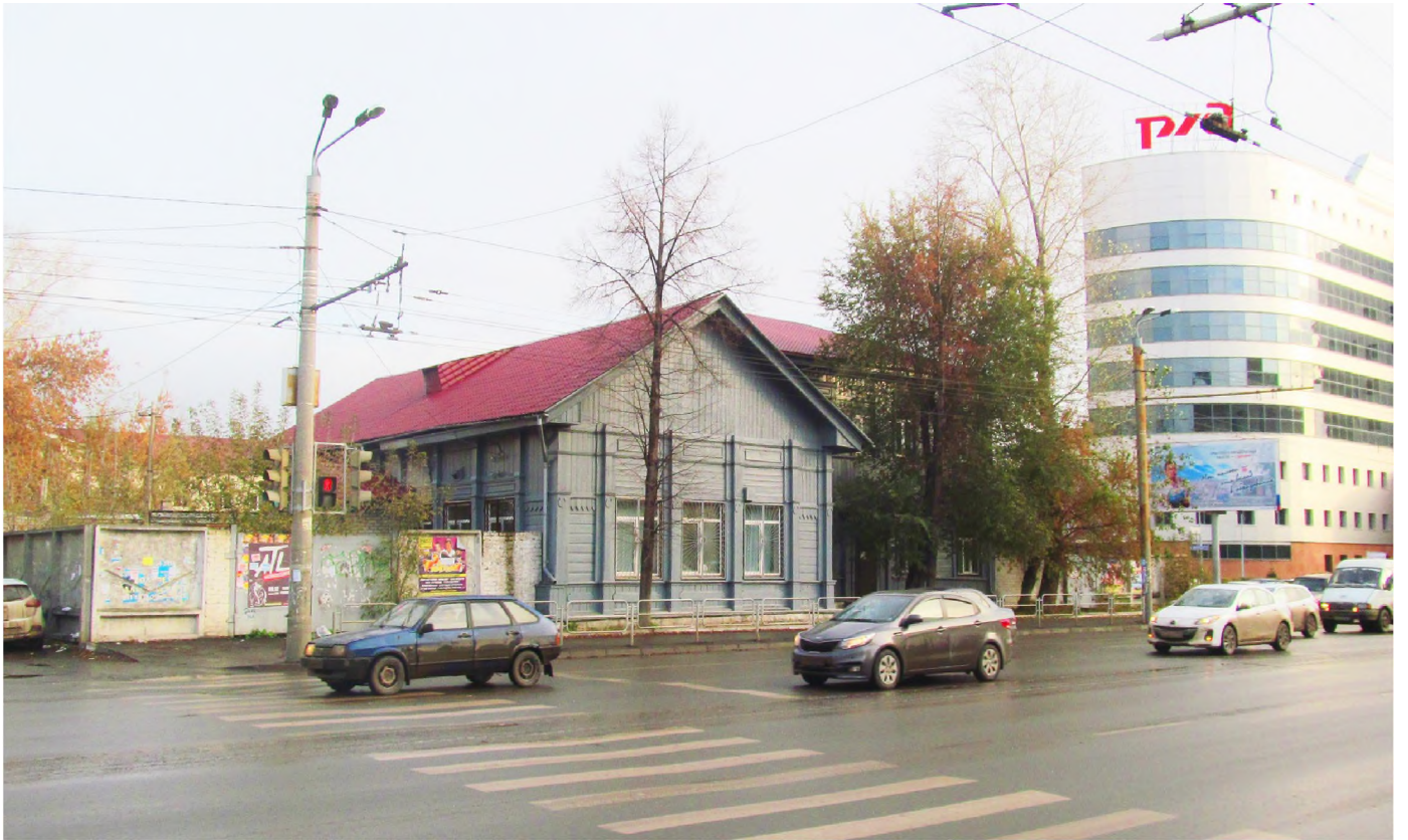
Рис. 4 Вид на здание бывшего мужского училища с северо-запада со стороны ул. Свободы
