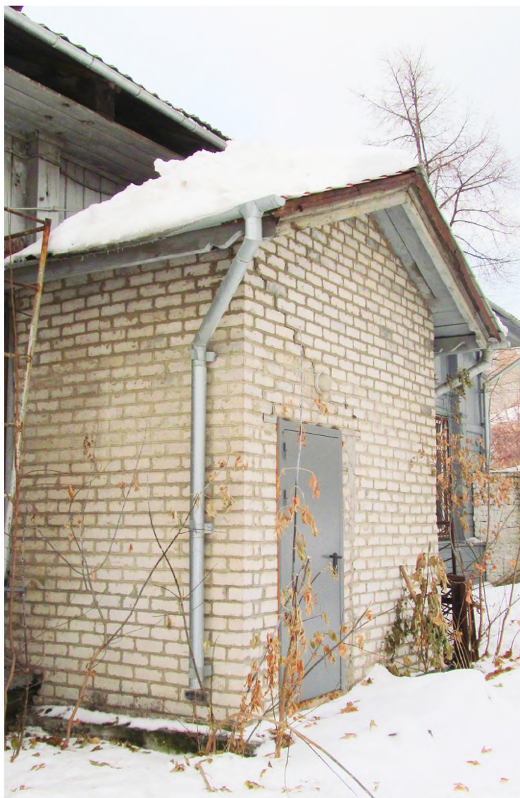
Рис. 14 Вид на кирпичный пристрой северного фасада со стороны дворовой территории
