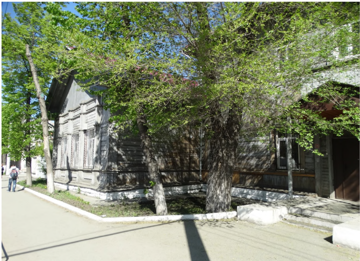
Рис. 50 Здание Следственной части Южно-Уральского УВД на транспорте (бывшее «2-классное мужское железнодорожное училище») по ул. Свободы, 175 (Фото – май, 2016 г.) Ссылка: https://pp.vk.me/c627119/v627119914/46f35/XgkOvuam_AE.jpg .
