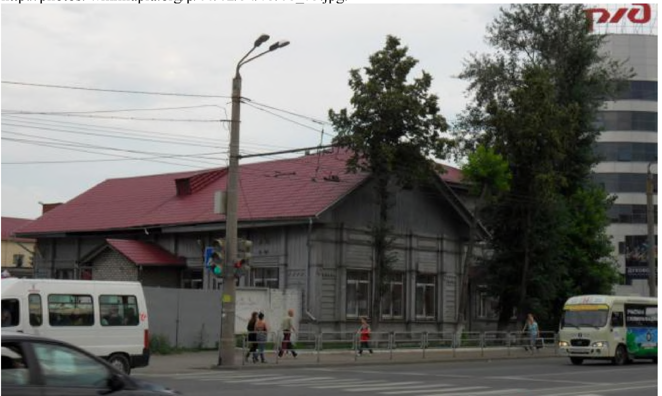
Рис. 38 Здание Следственной части Южно-Уральского УВД на транспорте (бывшее «2-классное мужское железнодорожное училище») по ул. Свободы, 175 (Фото – 2012 г.). Ссылка: http://photos.wikimania.org/p/00/02/54/75/06_75.jpg .
