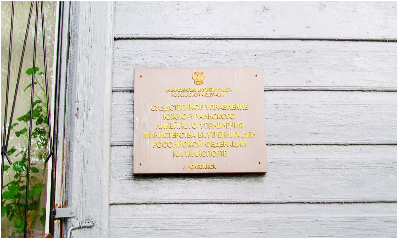
Рис. 26 Вид на информационную доску, расположенную на главном фасаде здания
