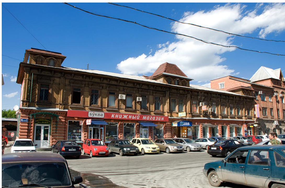
Рис. 28 «Дом жилой» (по «Списку №13») по ул. К. Маркса, 70 (1860-е гг.). Совпадает направление раскладки вагонки — вертикально в прикарнизной зоне и подоконном фризе, горизонтально в межоконных простенках. Опираение пилястр на тумбы по такому же типу как на ул. Свободы 175. Конфигурация пилястр в сечении также трехступенчатая.
