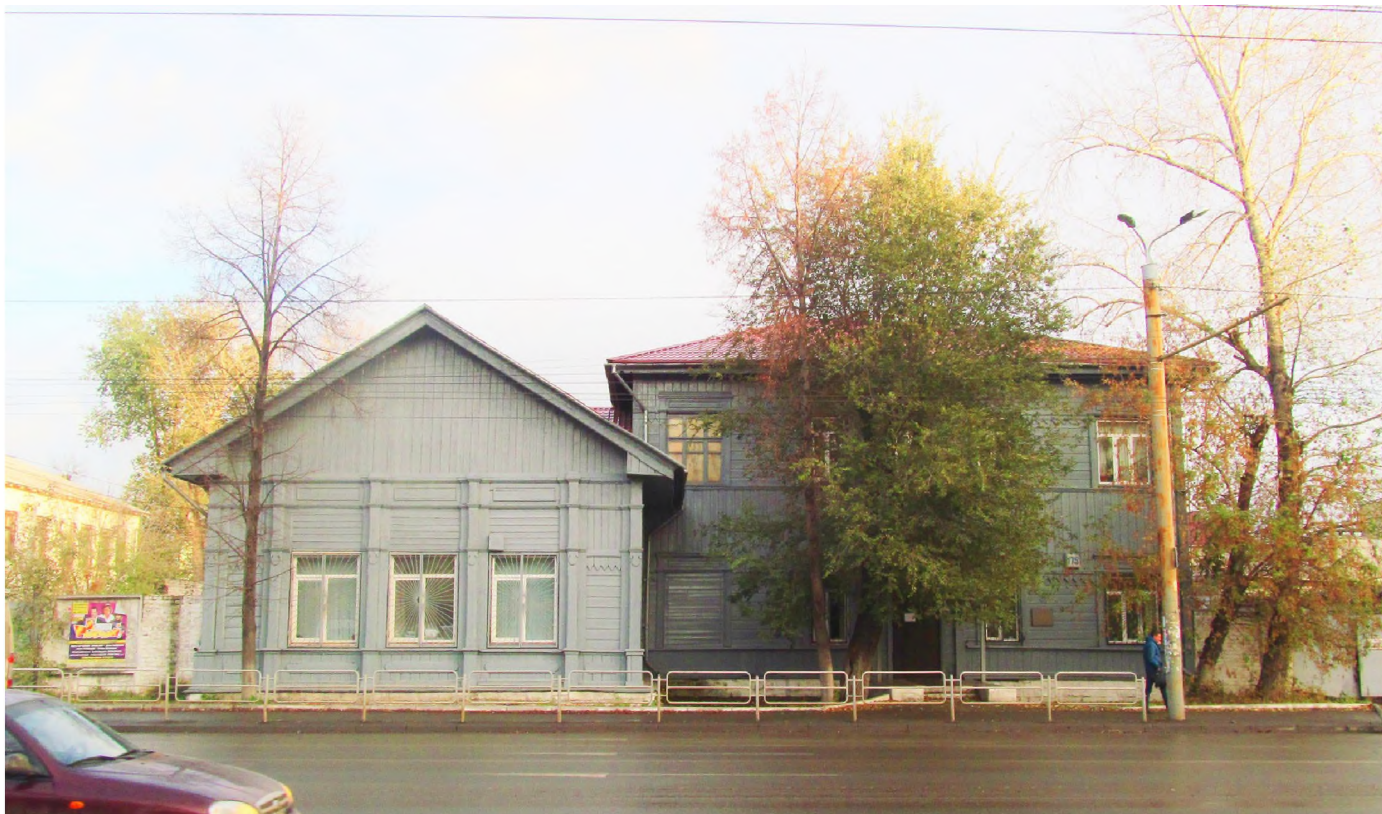
Рис. 6 Вид на западный главный фасад здания со стороны ул. Свободы
