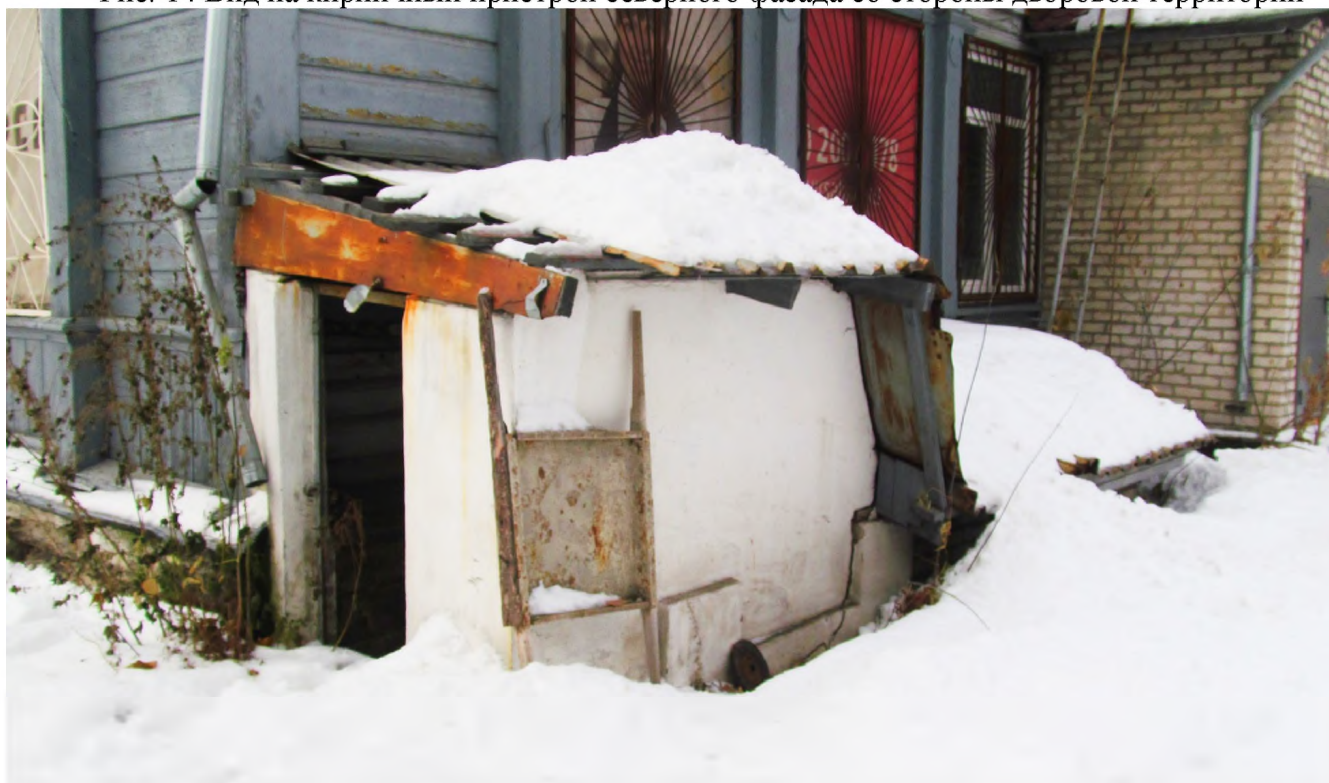
Рис. 15 Вид на спуск в подвал со стороны северного фасада
