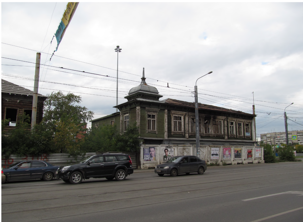
Рис. 29 «дом Д. Почелина» по ул. Труда 57 кон. XIXв. . Аналогичное композиционное построение фасадов, раскладка вагонки второго этажа. Опираение пилястр на тумбы.
