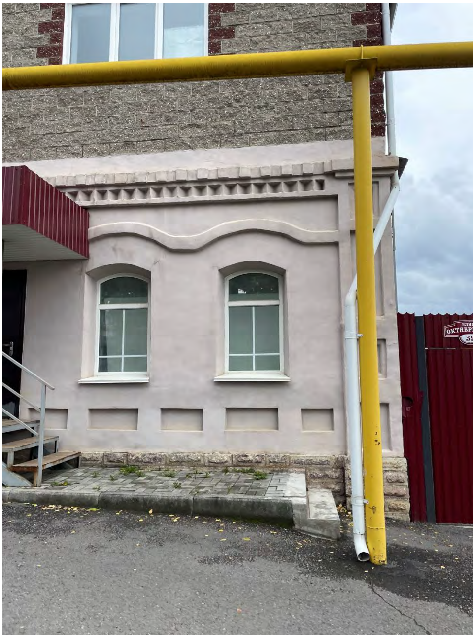
Фото.5. Выявленный объект культурного наследия «Дом купеческий», расположенный по адресу: Катав-Ивановский муниципальный район, г. Юрюзань, ул. Октябрьская, 39.
