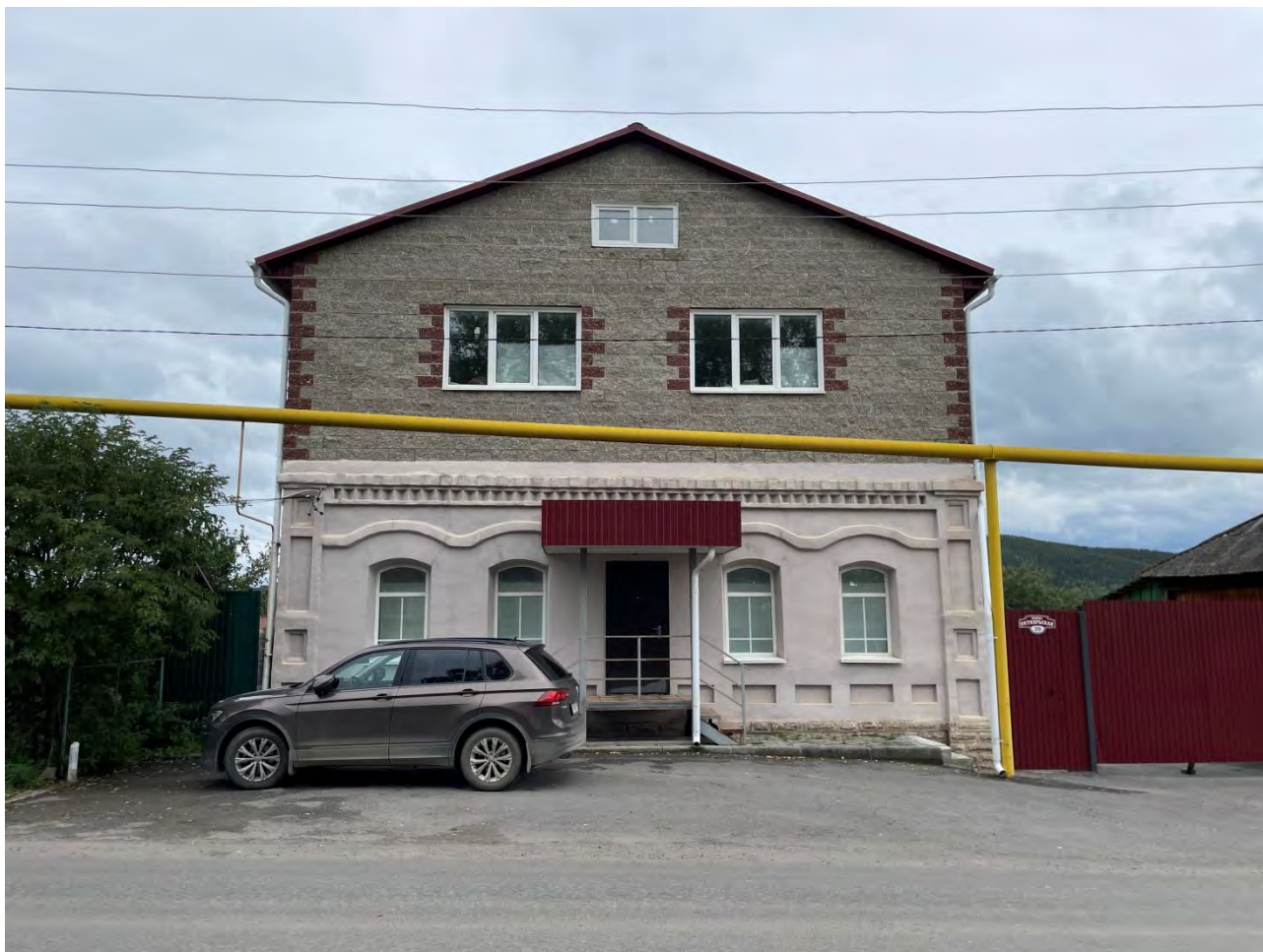
Фото.4. Выявленный объект культурного наследия «Дом купеческий», расположенный по адресу: Катав-Ивановский муниципальный район, г. Юрюзань, ул. Октябрьская, 39.
