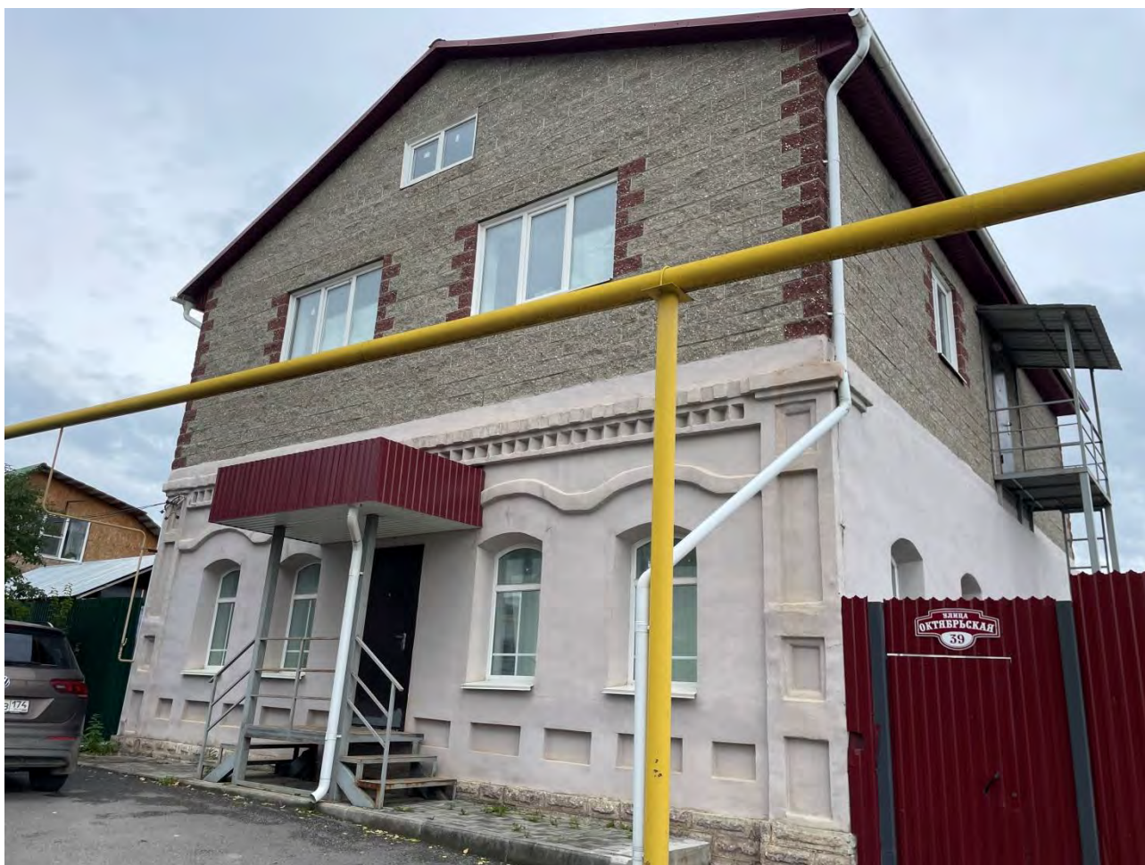
Фото.3. Выявленный объект культурного наследия «Дом купеческий», расположенный по адресу: Катав-Ивановский муниципальный район, г. Юрюзань, ул. Октябрьская, 39.
