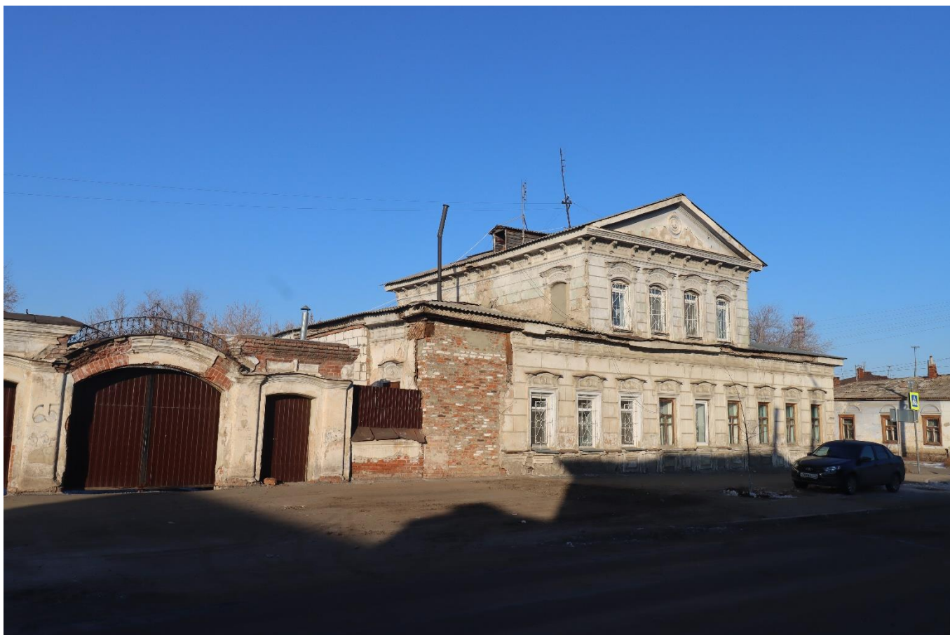
Фото 6. Вид на выявленный объект культурного наследия «Жилой дом», расположенный по адресу: Челябинская область, Троицкий городской округ, г. Троицк, ул. Октябрьская, 65.
