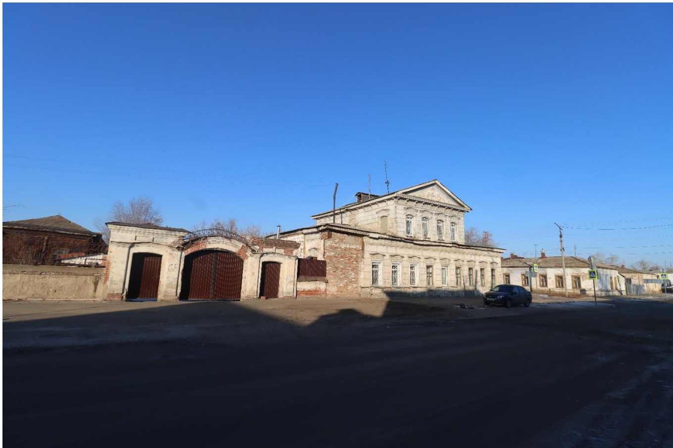
Фото 5. Вид на выявленный объект культурного наследия «Жилой дом», расположенный по адресу: Челябинская область, Троицкий городской округ, г. Троицк, ул. Октябрьская, 65.
