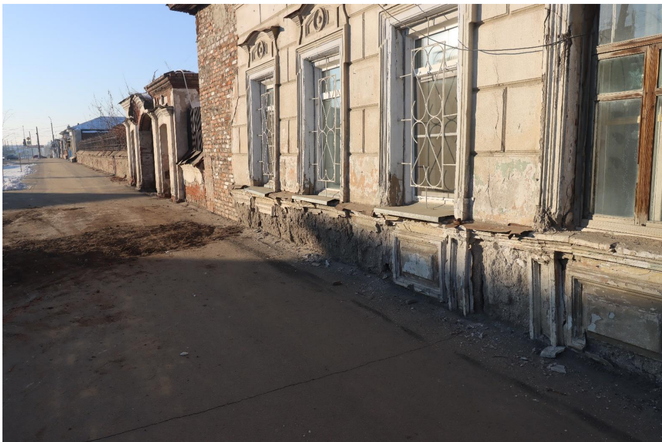
Фото 18. Вид на выявленный объект культурного наследия «Жилой дом», расположенный по адресу: Челябинская область, Троицкий городской округ, г. Троицк, ул. Октябрьская, 65.
