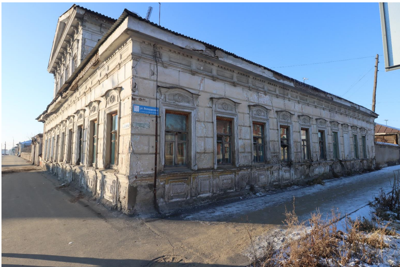
Фото 7. Вид на выявленный объект культурного наследия «Жилой дом», расположенный по адресу: Челябинская область, Троицкий городской округ, г. Троицк, ул. Октябрьская, 65.
