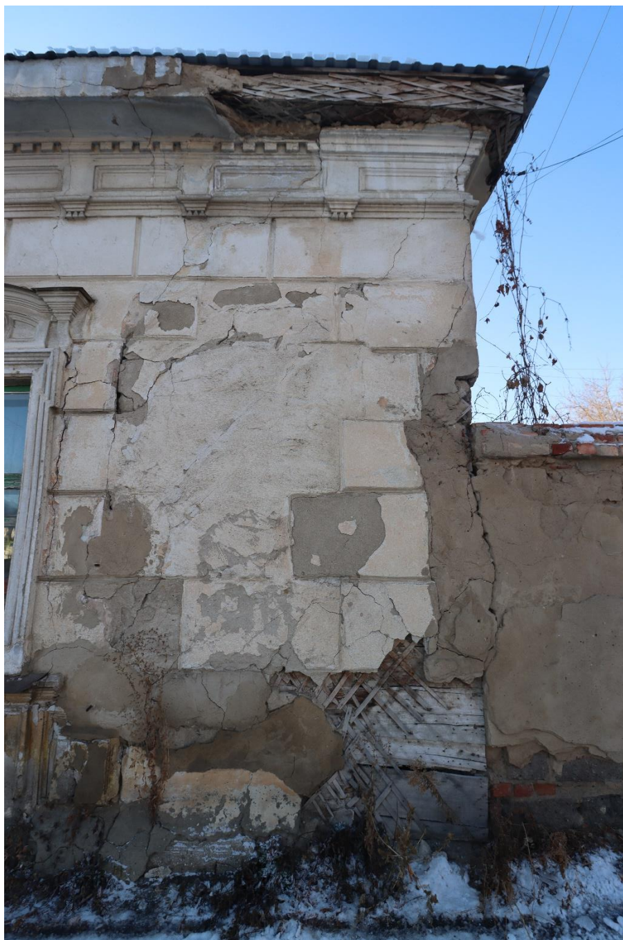
Фото 11. Вид на выявленный объект культурного наследия «Жилой дом», расположенный по адресу: Челябинская область, Троицкий городской округ, г. Троицк, ул. Октябрьская, 65.
