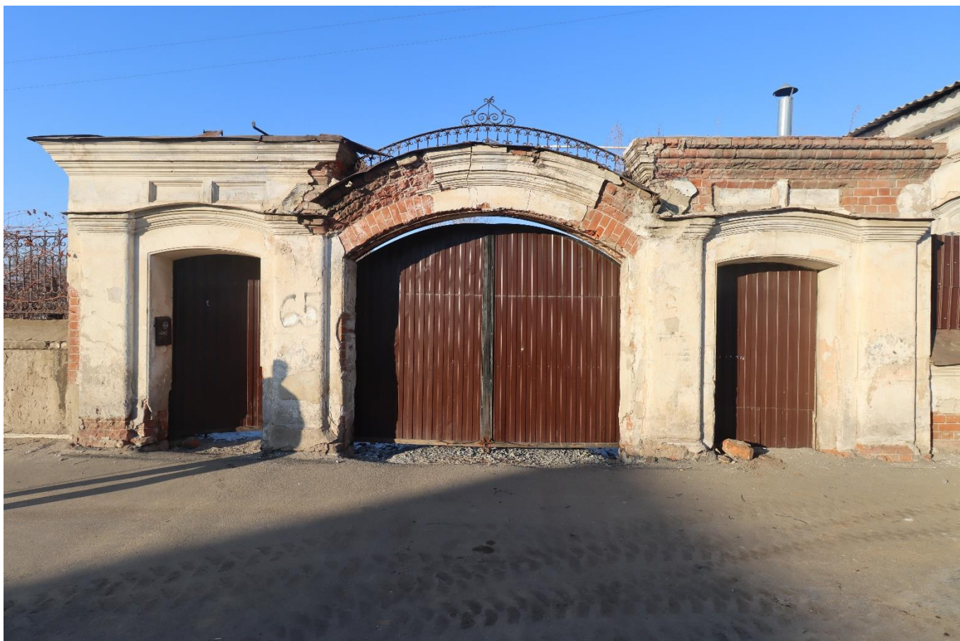
Фото 20. Вид на выявленный объект культурного наследия «Жилой дом», расположенный по адресу: Челябинская область, Троицкий городской округ, г. Троицк, ул. Октябрьская, 65.
