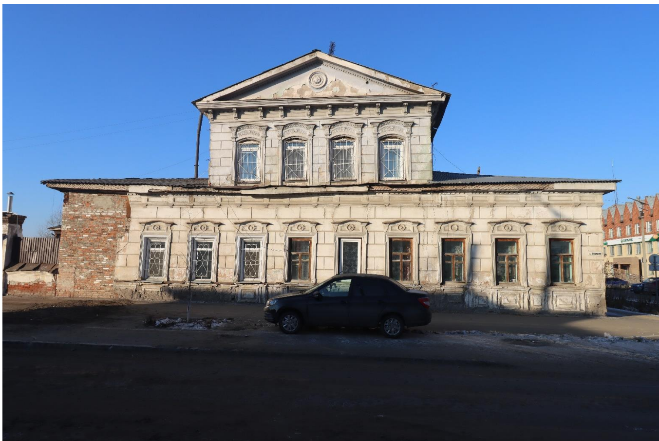
Фото 2. Вид на выявленный объект культурного наследия «Жилой дом», расположенный по адресу: Челябинская область, Троицкий городской округ, г. Троицк, ул. Октябрьская, 65.
