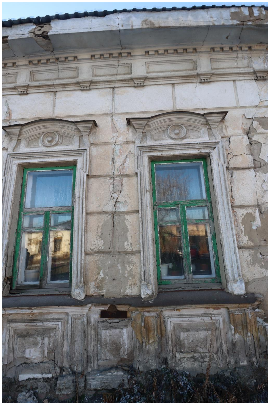
Фото 12. Вид на выявленный объект культурного наследия «Жилой дом», расположенный по адресу: Челябинская область, Троицкий городской округ, г. Троицк, ул. Октябрьская, 65.
