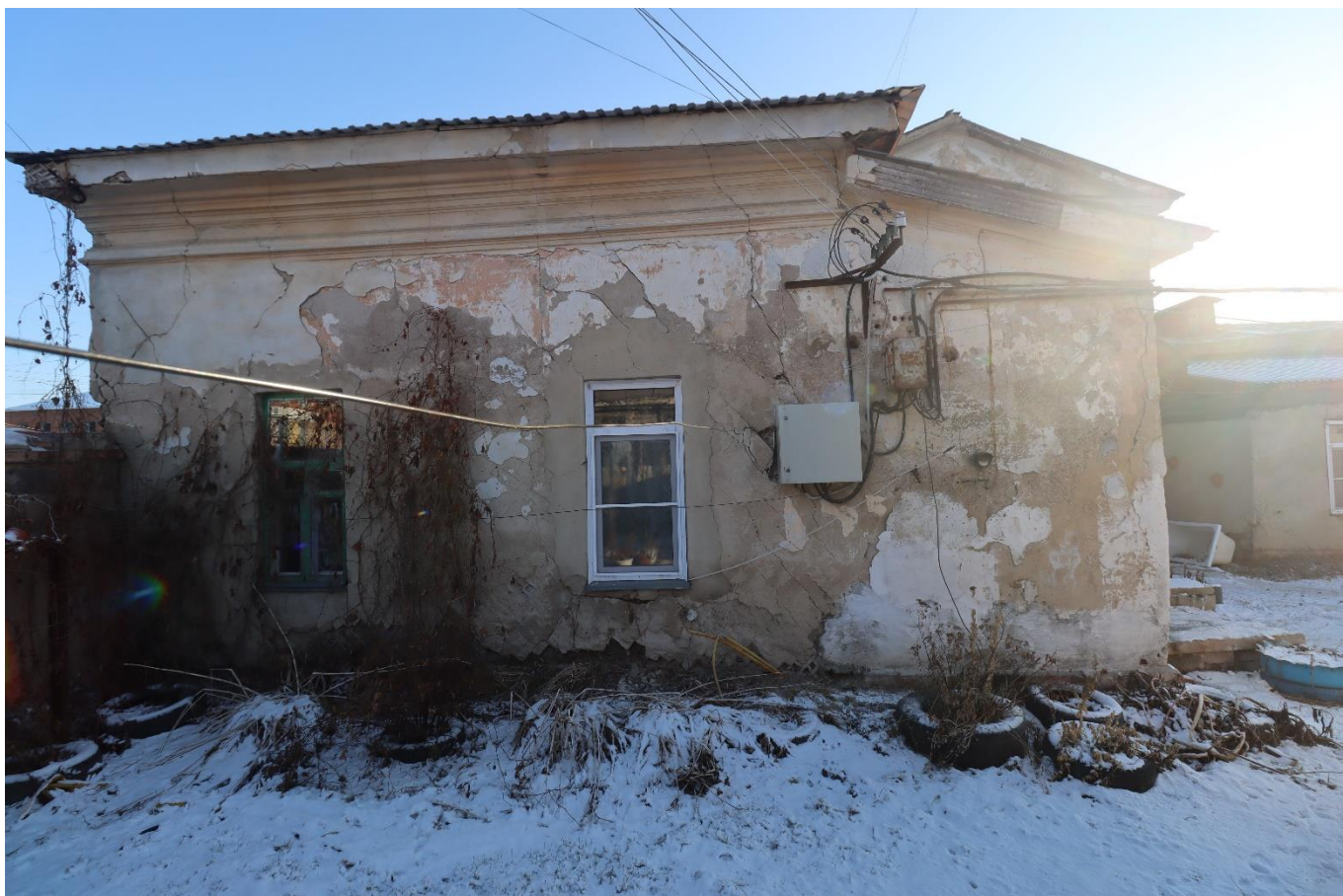
Фото 30. Вид на выявленный объект культурного наследия «Жилой дом», расположенный по адресу: Челябинская область, Троицкий городской округ, г. Троицк, ул. Октябрьская, 65.
