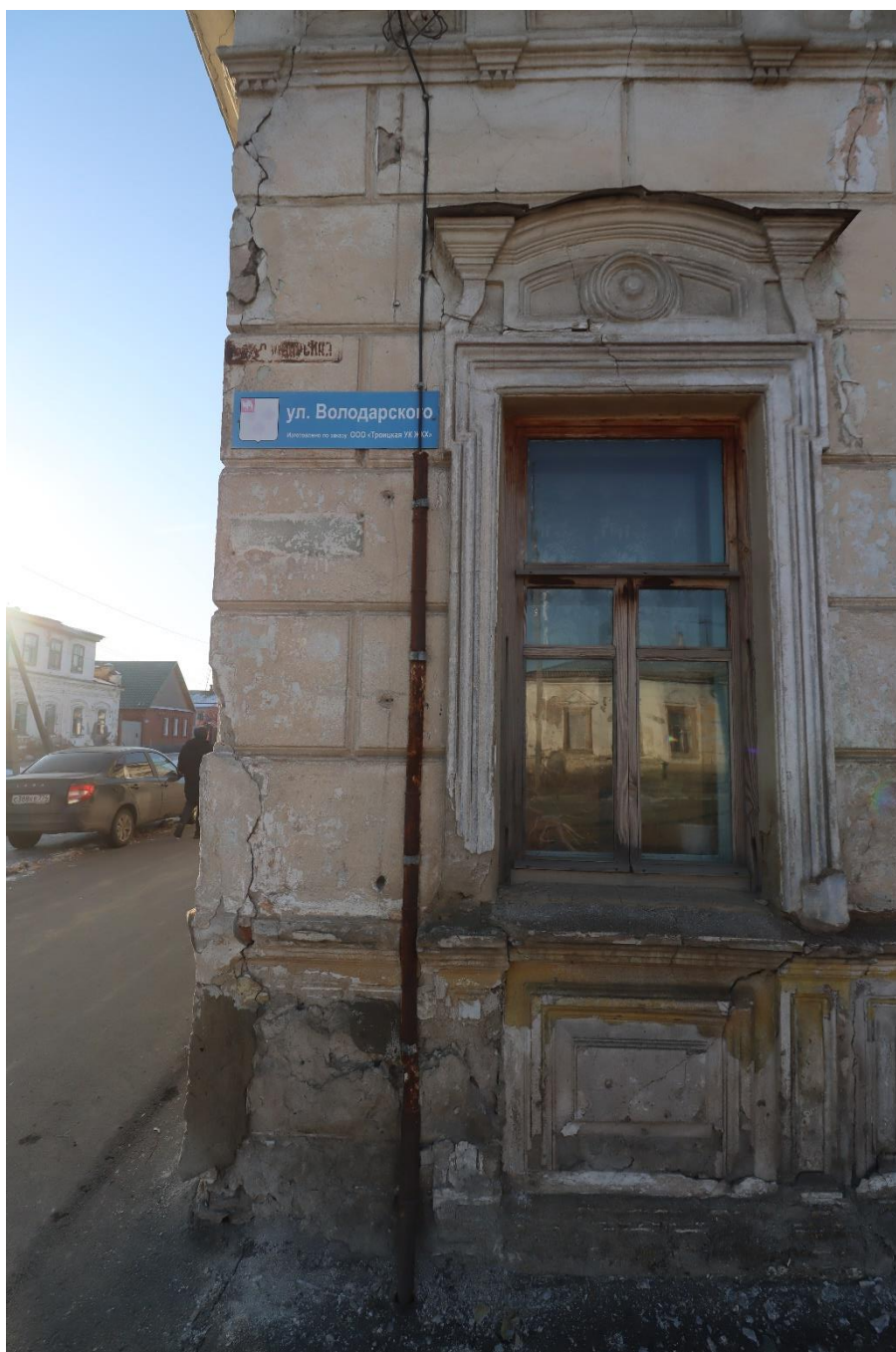
Фото 15. Вид на выявленный объект культурного наследия «Жилой дом», расположенный по адресу: Челябинская область, Троицкий городской округ, г. Троицк, ул. Октябрьская, 65.
