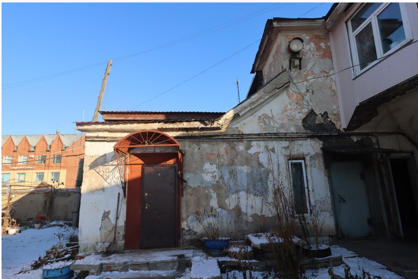
Фото 26. Вид на выявленный объект культурного наследия «Жилой дом», расположенный по адресу: Челябинская область, Троицкий городской округ, г. Троицк, ул. Октябрьская, 65.
