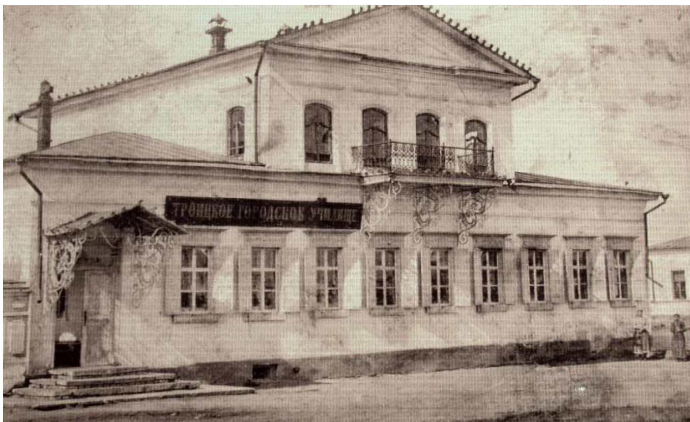
Фото 6. Историческое фото Объекта, 1890-е.
