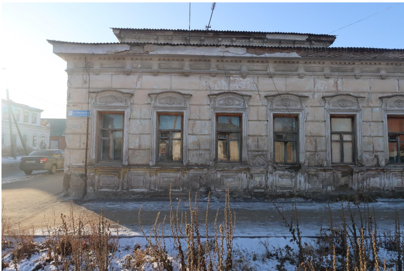
Фото 8. Вид на выявленный объект культурного наследия «Жилой дом», расположенный по адресу: Челябинская область, Троицкий городской округ, г. Троицк, ул. Октябрьская, 65.
