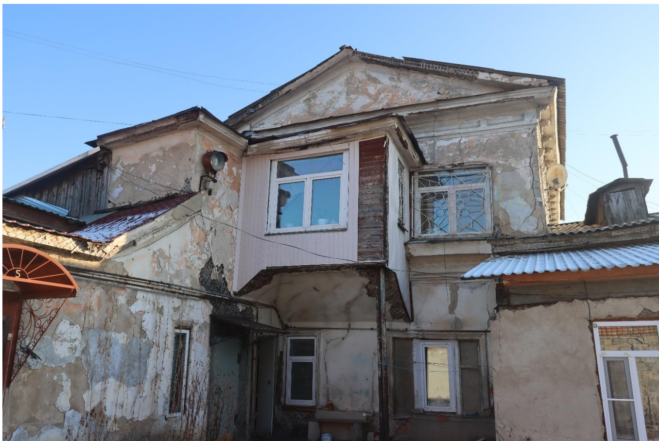
Фото 24. Вид на выявленный объект культурного наследия «Жилой дом», расположенный по адресу: Челябинская область, Троицкий городской округ, г. Троицк, ул. Октябрьская, 65.
