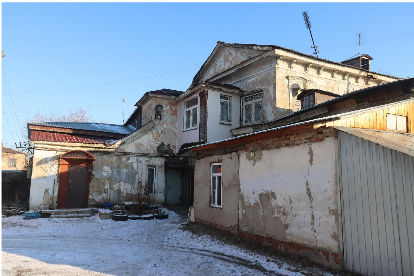
Фото 22. Вид на выявленный объект культурного наследия «Жилой дом», расположенный по адресу: Челябинская область, Троицкий городской округ, г. Троицк, ул. Октябрьская, 65.
