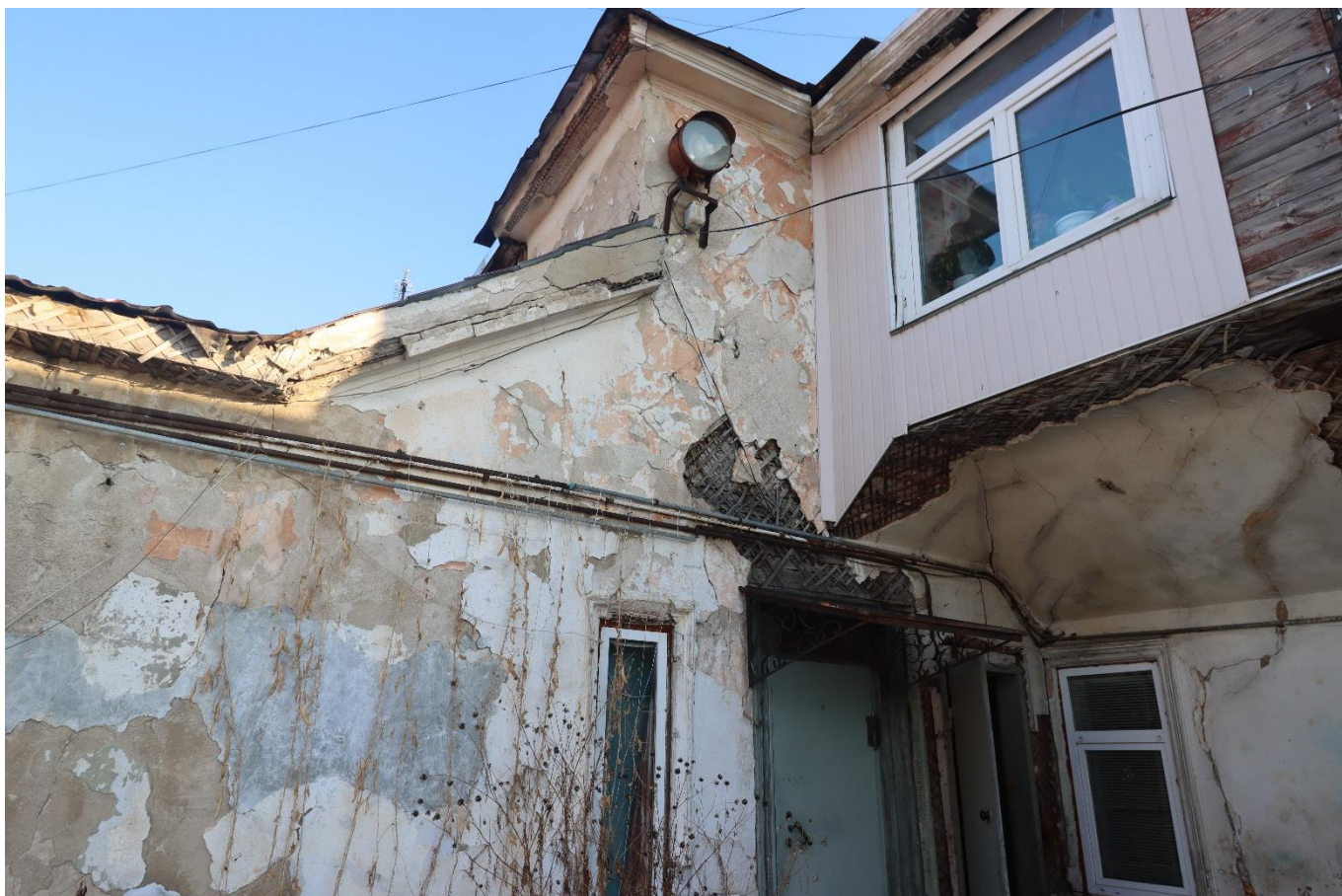
Фото 27. Вид на выявленный объект культурного наследия «Жилой дом», расположенный по адресу: Челябинская область, Троицкий городской округ, г. Троицк, ул. Октябрьская, 65.
