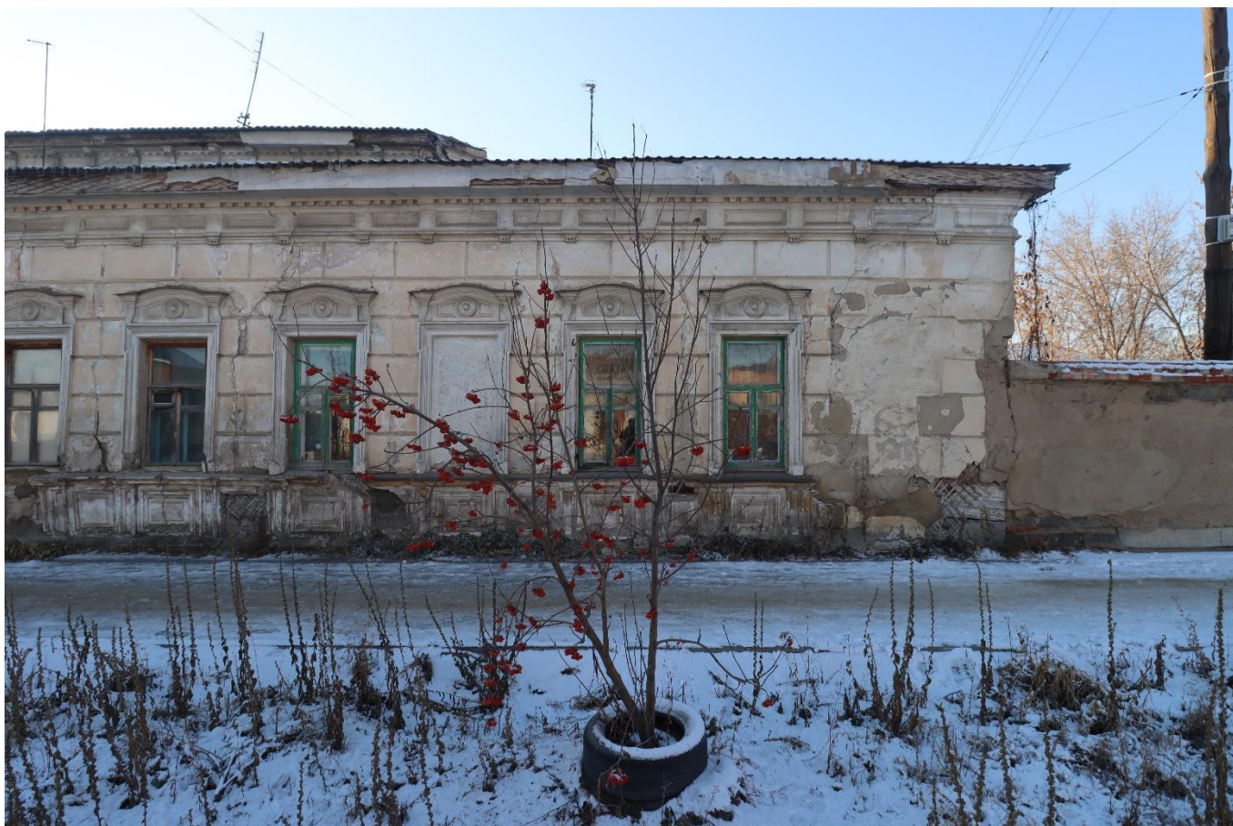
Фото 9. Вид на выявленный объект культурного наследия «Жилой дом», расположенный по адресу: Челябинская область, Троицкий городской округ, г. Троицк, ул. Октябрьская, 65.
