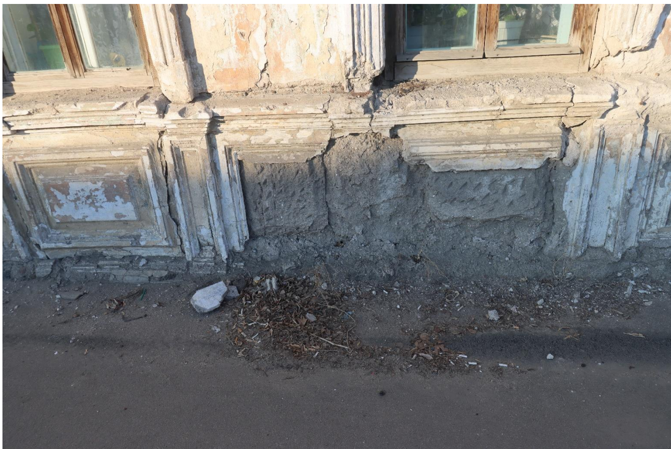
Фото 17. Вид на выявленный объект культурного наследия «Жилой дом», расположенный по адресу: Челябинская область, Троицкий городской округ, г. Троицк, ул. Октябрьская, 65.
