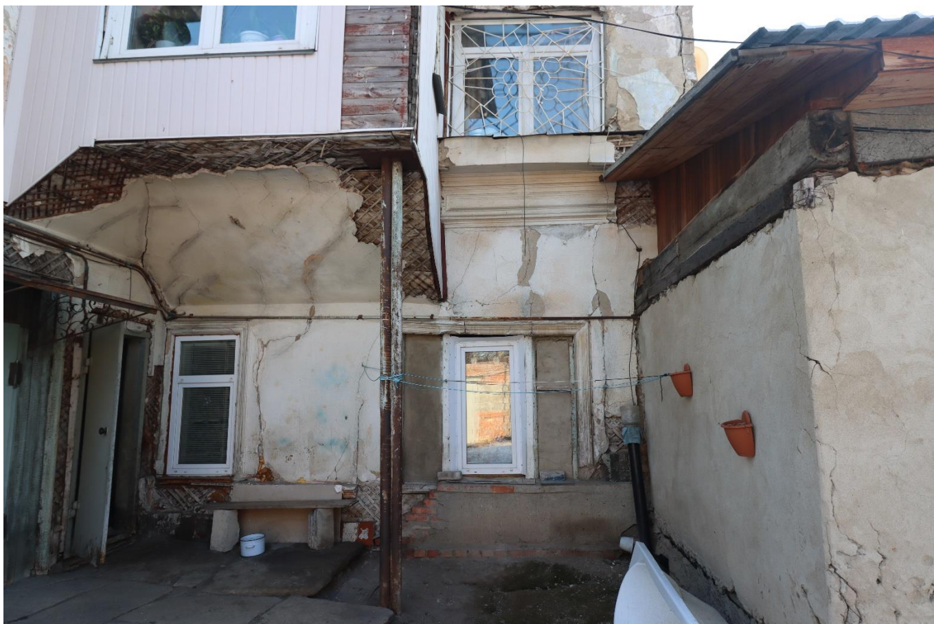
Фото 28. Вид на выявленный объект культурного наследия «Жилой дом», расположенный по адресу: Челябинская область, Троицкий городской округ, г. Троицк, ул. Октябрьская, 65.
