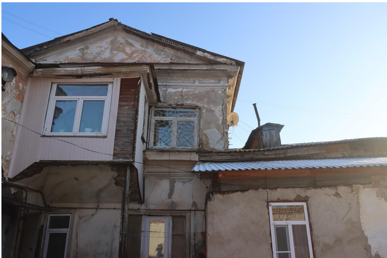
Фото 25. Вид на выявленный объект культурного наследия «Жилой дом», расположенный по адресу: Челябинская область, Троицкий городской округ, г. Троицк, ул. Октябрьская, 65.
