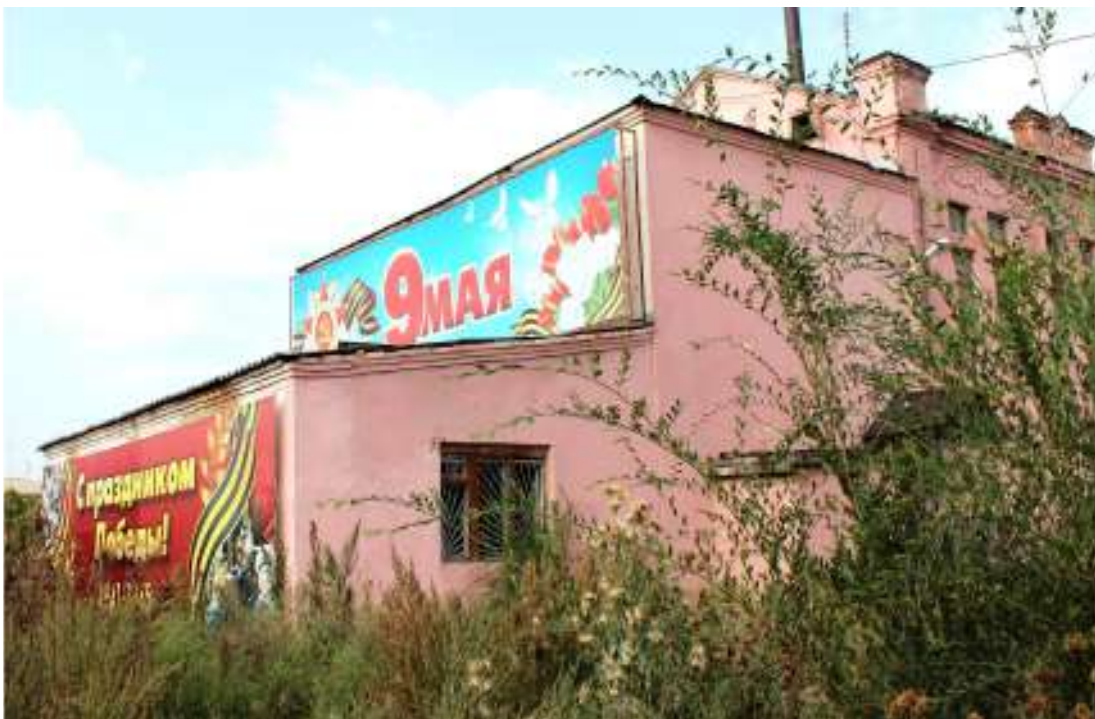
8. Троицк. Ул. Бр. Малышевых, 31. Дворовый фасад. Пристрои. Фото 2017г
