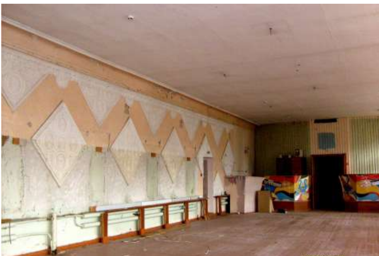
24. Троицк. Ул. Бр. Малышевых, 31. 2-й этаж. Общий вид. Фото 2017г
