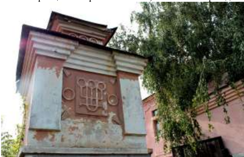
14. Троицк. Ул. Бр. Малышевых, 31. Фрагмент завершения устоев ворот.
