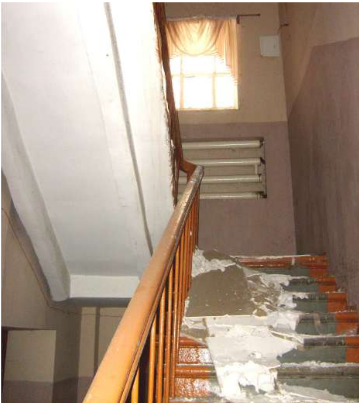
22. Троицк. Ул. Бр. Малышевых, 31. Пристрой. Лестница на 2-й этаж. Фото 2017г.
