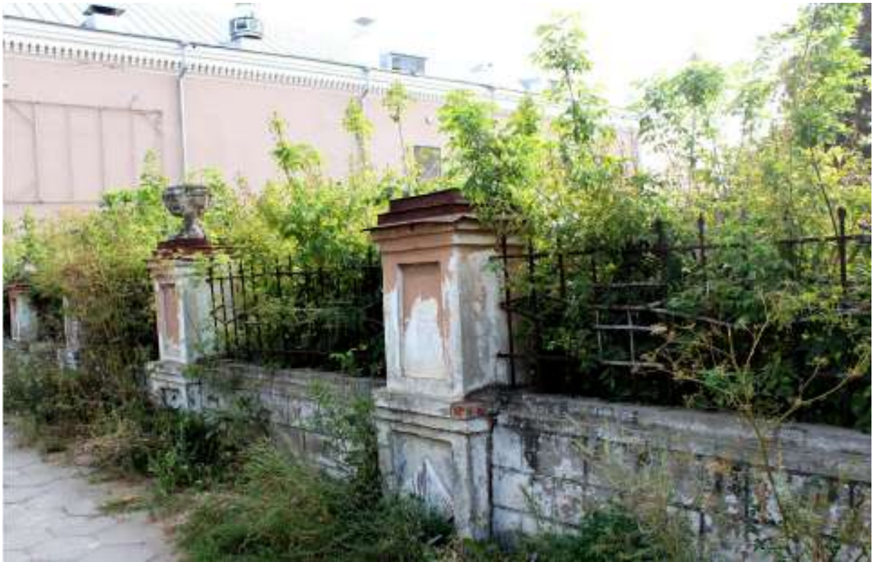
15. Троицк. Ул. Бр. Малышевых, 31. Ограда дома. Фото 2017г.
