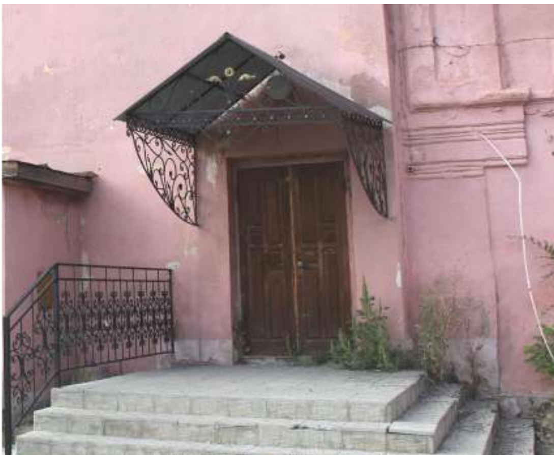
17. Троицк. Ул. Бр. Малышевых, 31. Крыльцо входа. Фото 2017г.
