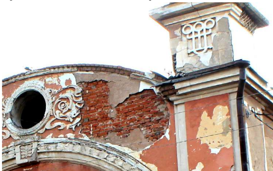
Фрагмент завершения главного фасада с окном-люкарной в тимпане.
