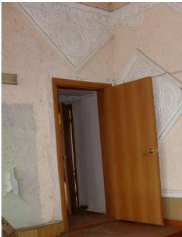
26. Троицк. Ул. Бр. Малышевых, 31. 2-й этаж. Дверь в пристрой. 2017г
