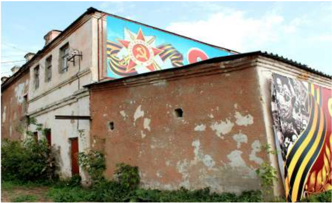
9. Троицк. Ул. Бр. Малышевых, 31. Дворовый фасад. Пристрои. Фото 2017г
