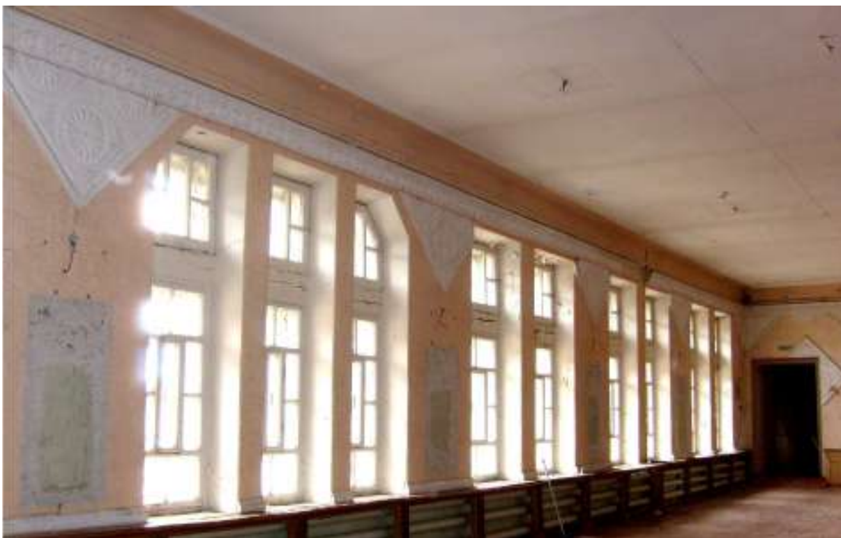
25. Троицк. Ул. Бр. Малышевых, 31. 2-й этаж. Общий вид. Фото 2017г.
