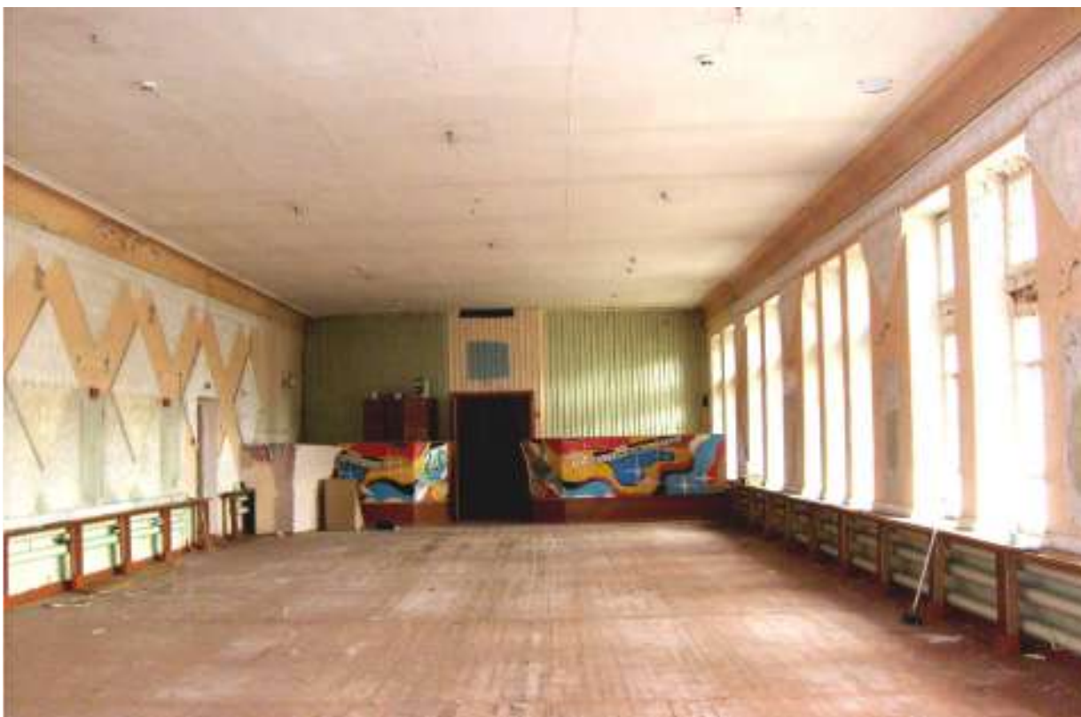
23. Троицк. Ул. Бр. Малышевых, 31. 2-й этаж. Общий вид. Фото 2017г.
