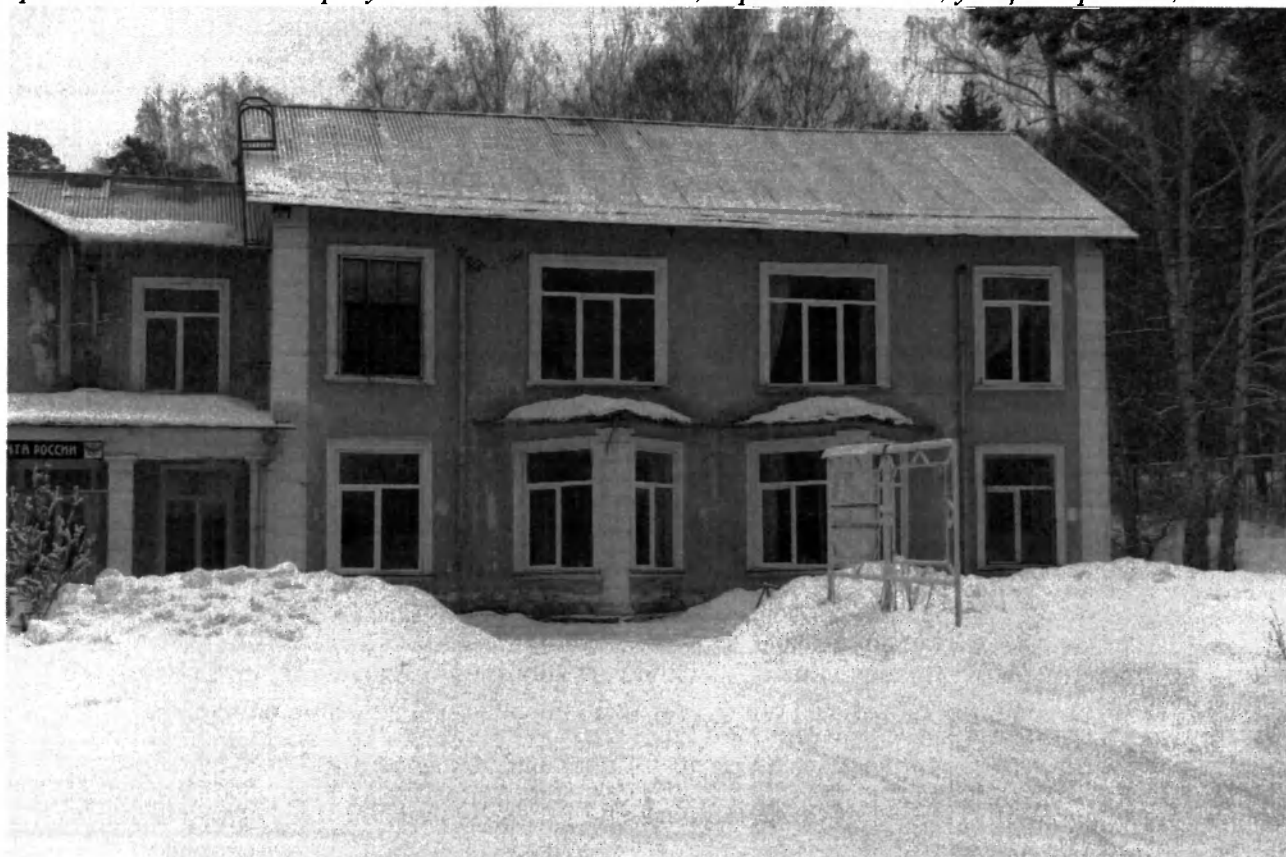
Вид на южный фасад восточного крыла здания со стороны двора
