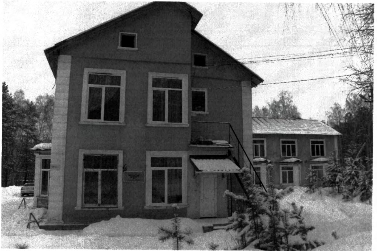
Вид на южный фасад здания со стороны двора
