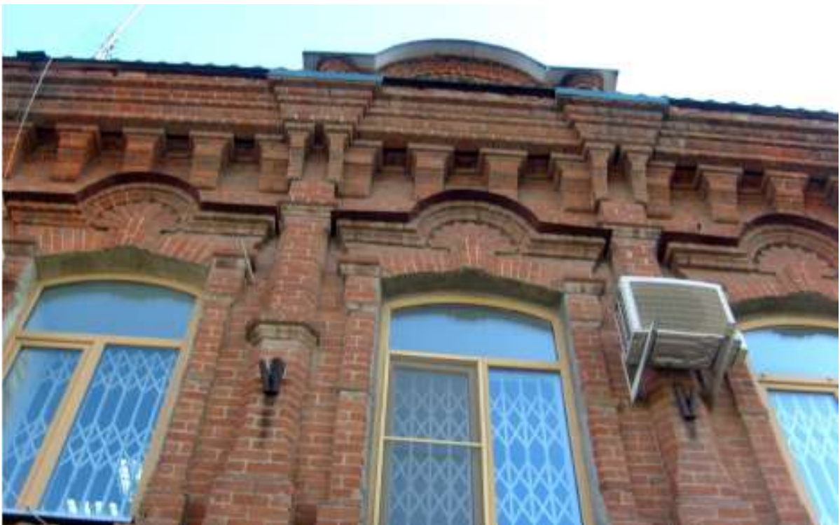
2. Троицк, ул. Фрунзе, 6. Главный фасад. Центральная часть. 2-й этаж. Фото 2017г.
