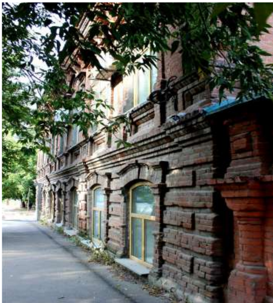
13.Троицк, ул. Фрунзе, б. Фрагмент фасада по ул. Красноармейской. 2017г.
