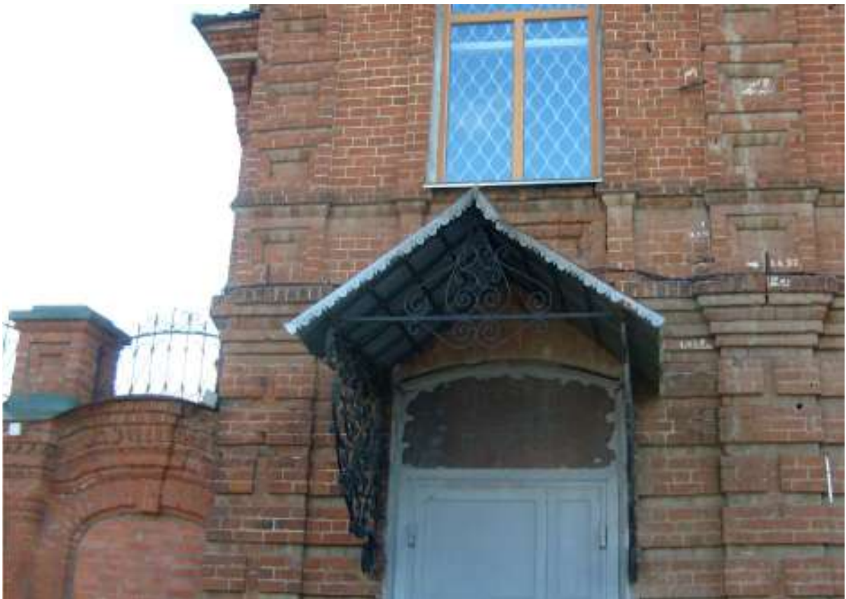
3. Троицк, ул. Фрунзе, 6. Главный фасад. Исторический вход в здание. 2017г.
