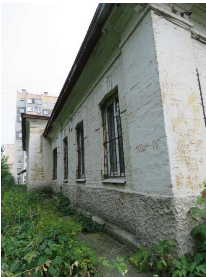
Рис. 8 а, б. Фрагменты лицевого северного фасада северного крыла
