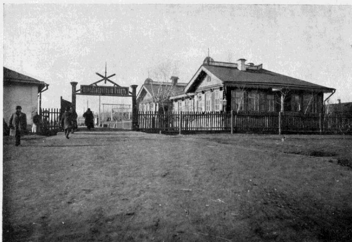
Главный въездъ на Челябинскій переселенческій пунктъ. Рис. 2.
