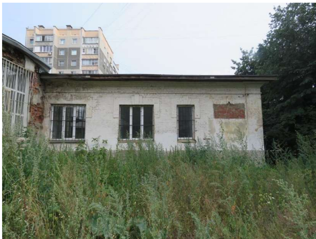
Рис. 12 а, б. Фрагменты дворового фасада. Дворовый, южный фасад северного крыла (вверху), дворовый, западный фасад восточного крыла (внизу). На флангах – заложены исторические дверные проемы
