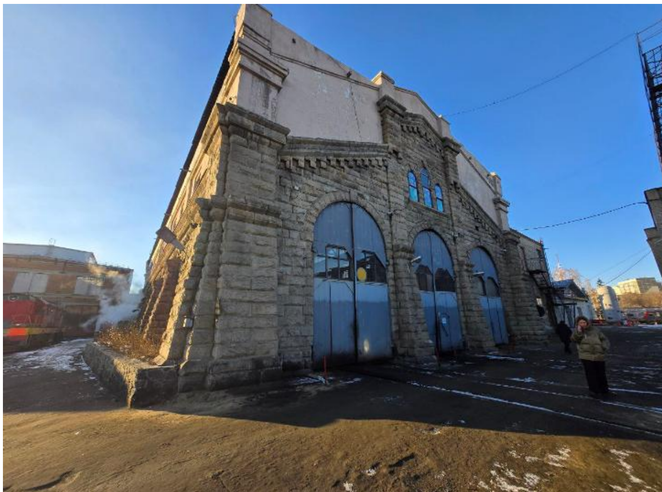
Фото 5. Вид на выявленный объект культурного наследия «Локомотивное депо - центр революционного движения в Челябинске 1903-1919 гг.», расположенный по адресу: Челябинская область, г. Челябинск, ул. Красноармейская, 101.
