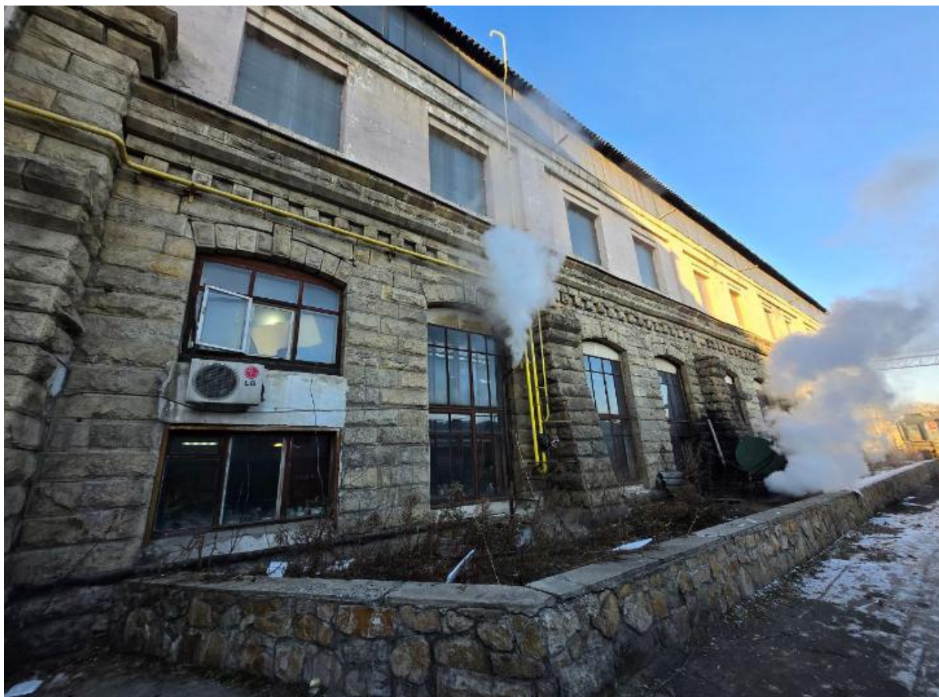
Фото 9. Вид на выявленный объект культурного наследия «Локомотивное депо - центр революционного движения в Челябинске 1903-1919 гг.», расположенный по адресу: Челябинская область, г. Челябинск, ул. Красноармейская, 101.
