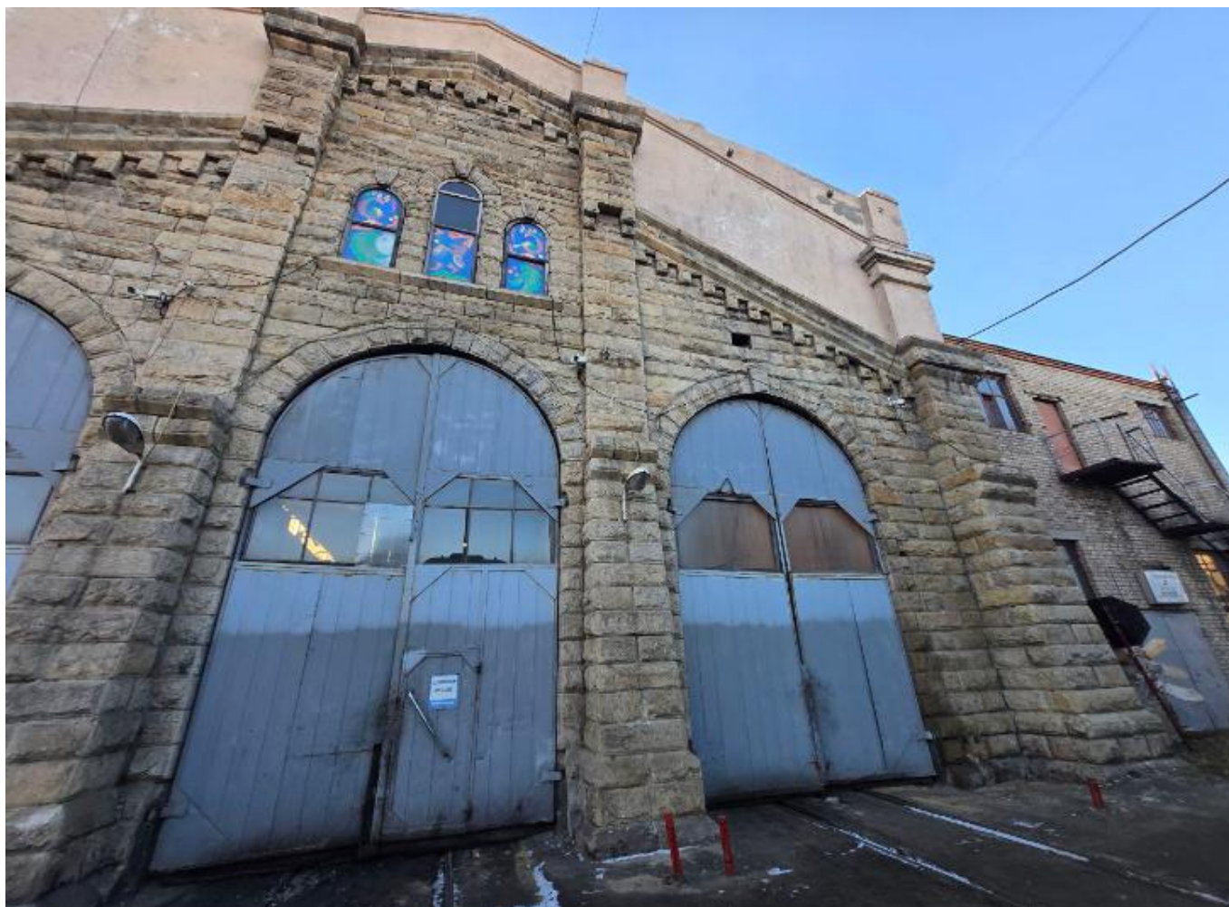
Фото 4. Вид на выявленный объект культурного наследия «Локомотивное депо - центр революционного движения в Челябинске 1903-1919 гг.», расположенный по адресу: Челябинская область, г. Челябинск, ул. Красноармейская, 101.
