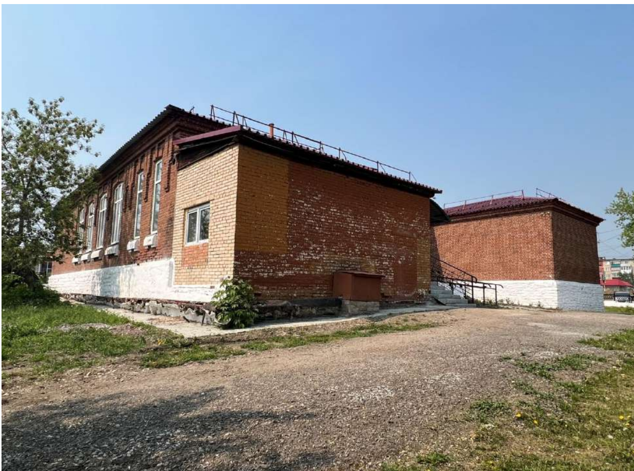
Рис. 9. Западное и восточное крылья, торцевые фасады; объем пристроя к восточному крылу
