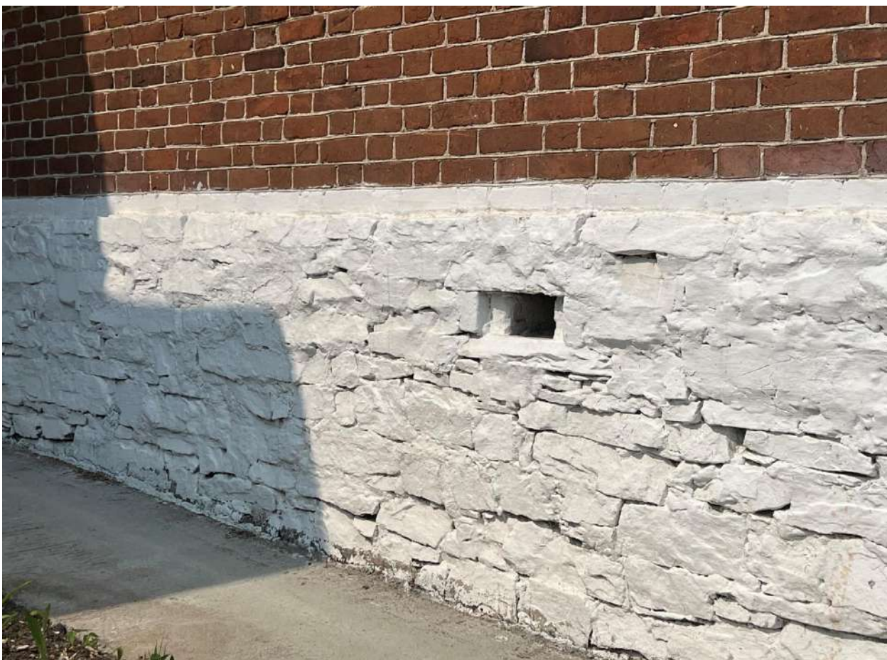
Рис. 13. Кладка цоколя и стен
