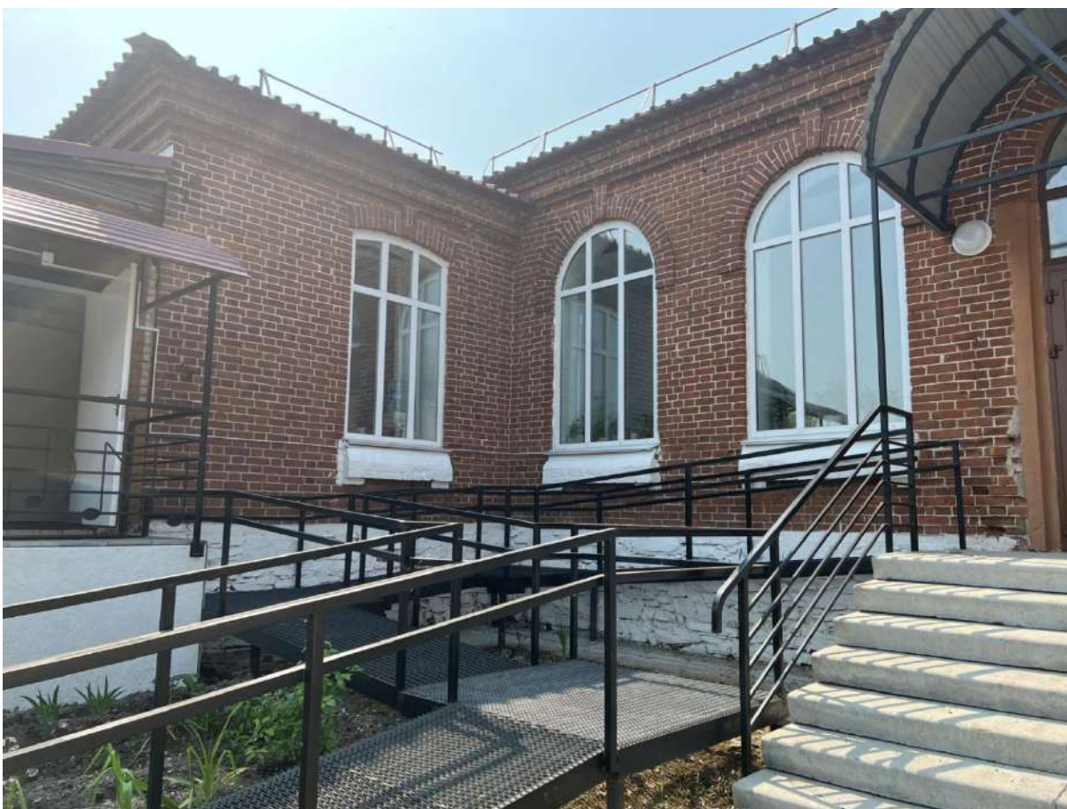
Рис. 11 а, б. Фрагменты дворового, северного фасада
