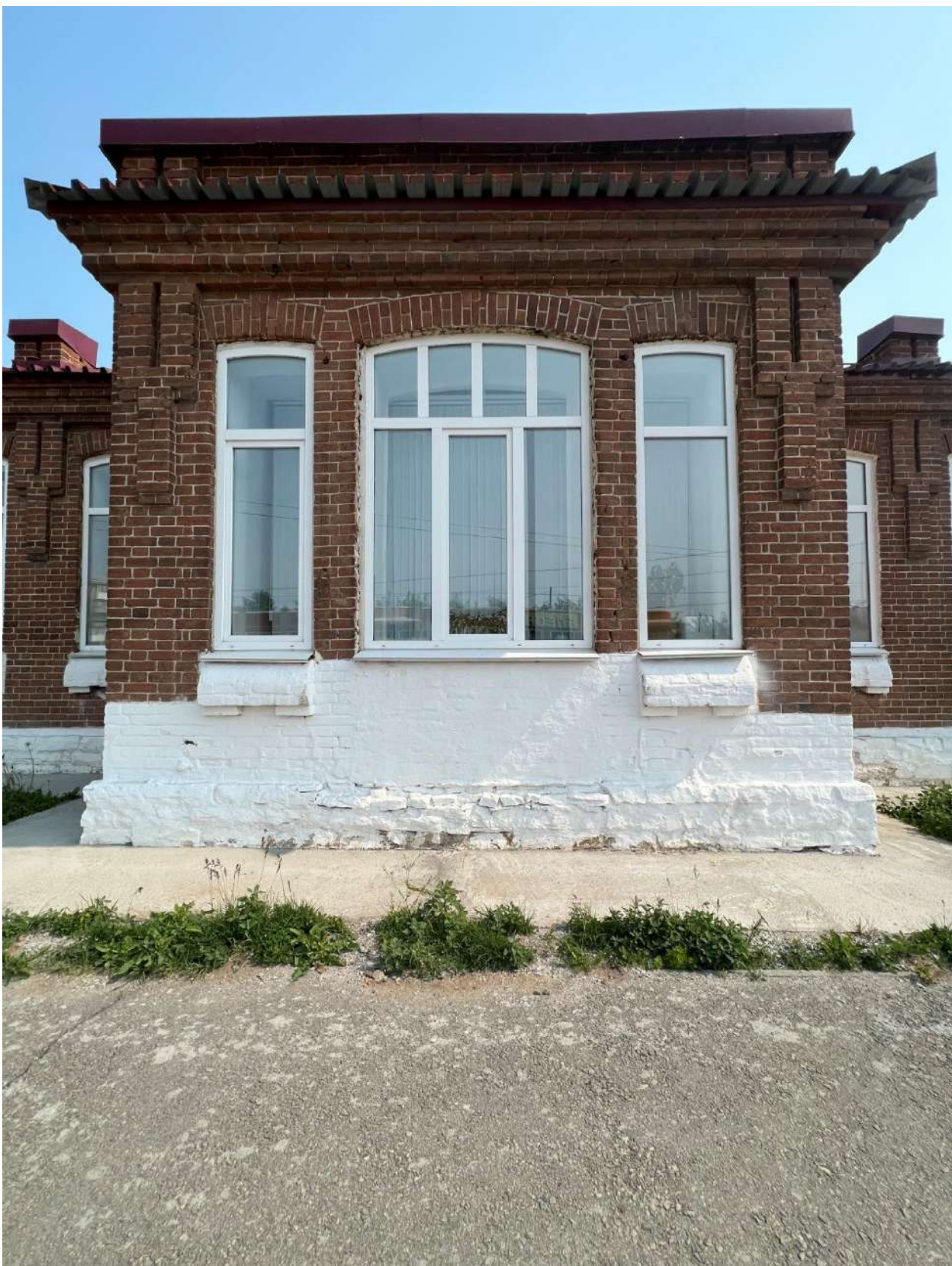
Рис. 3. Фрагмент главного, южного фасада. Объем исторического входного тамбура
