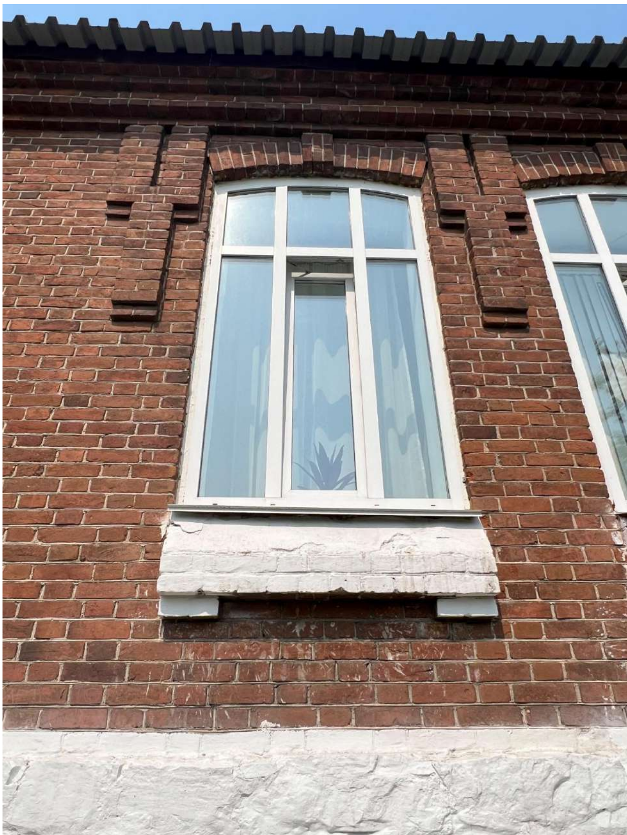
Рис. 8. Фрагмент бокового, восточного фасада
