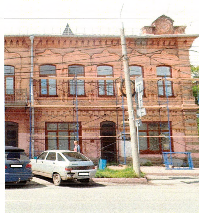
Правая часть главного фасада
