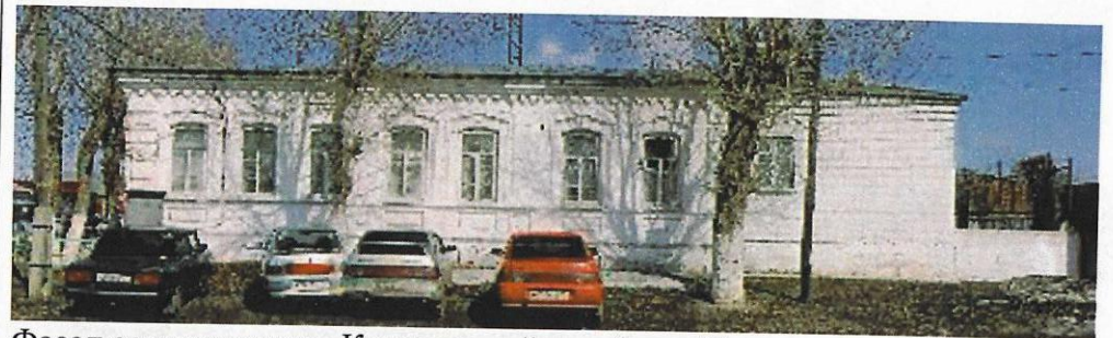
Фасад со стороны ул. Красноармейская (лит. А)
