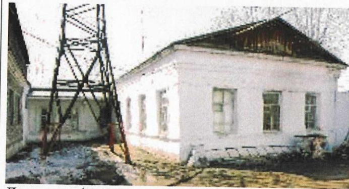
Дворовые фасады со стороны домовладения
