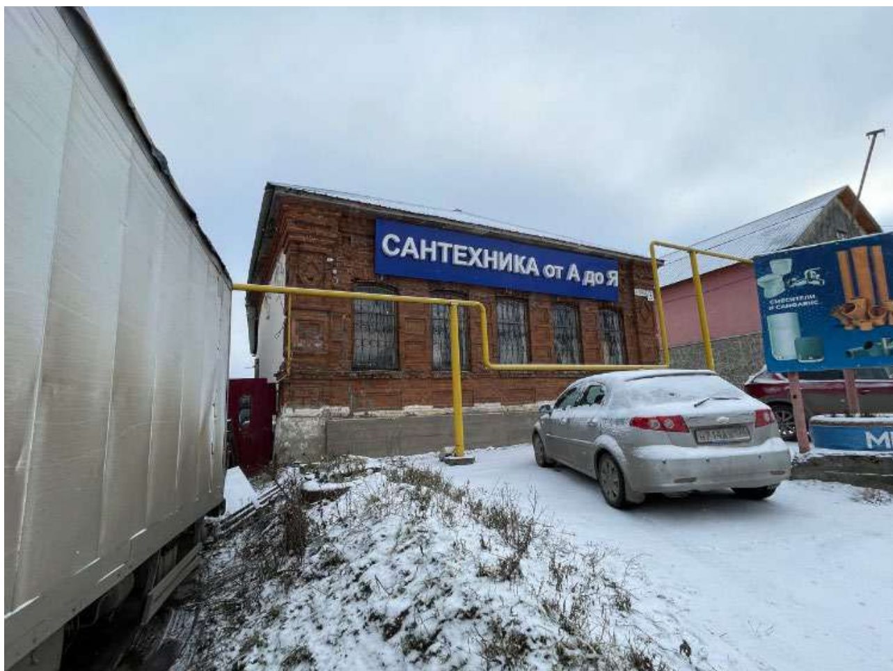
Фото 7. Выявленный объект культурного наследия «Дом купеческий» по адресу: Челябинская обл., г. Юрюзань, ул. Карла Маркса, 3. Общий вид выявленного объекта культурного наследия.
