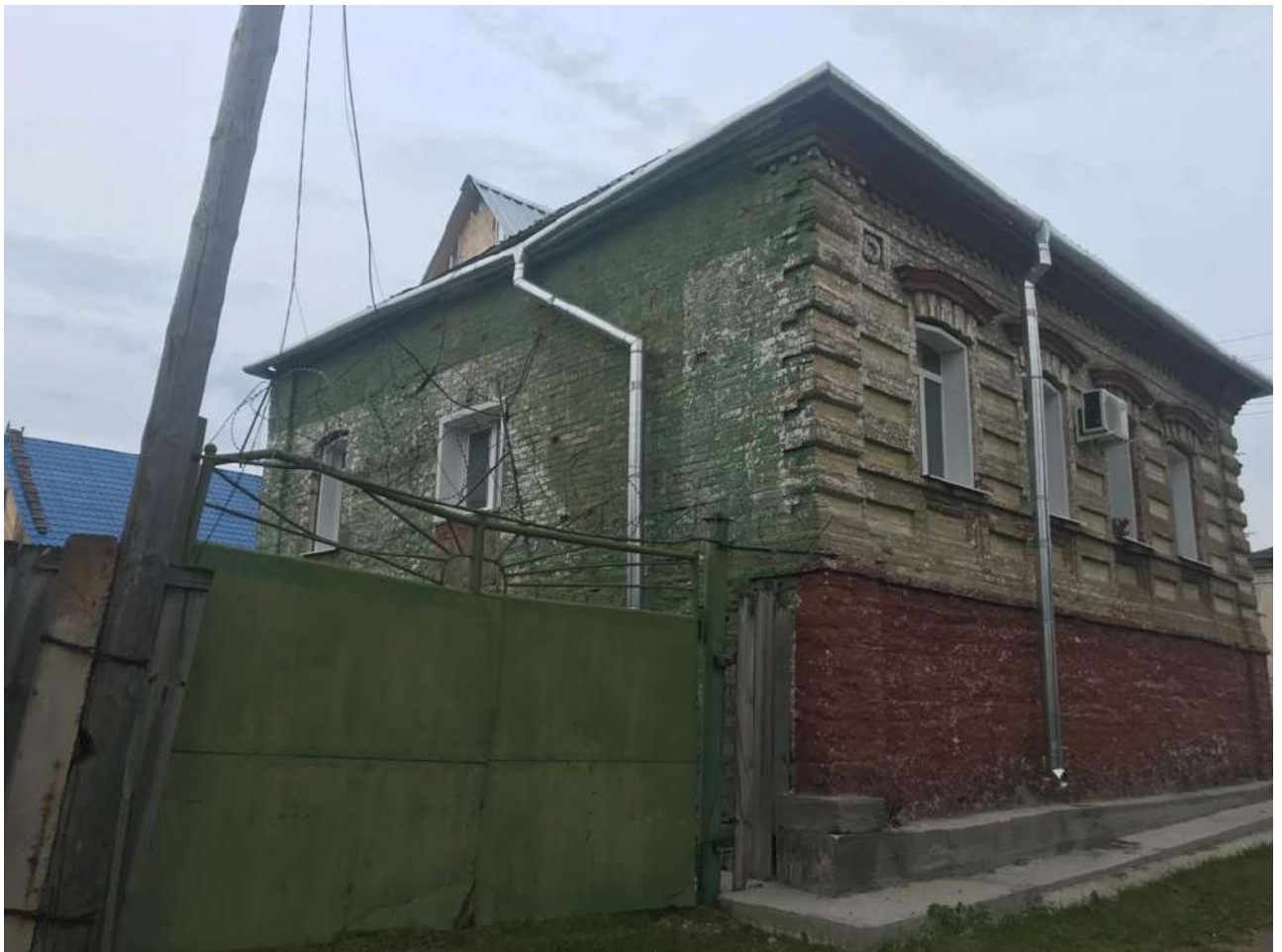
Фото 4. Дворовая территория с металлическими воротами. Вид на юго-западный и северо-западный фасады здания-памятника. 06.07.2020г.
