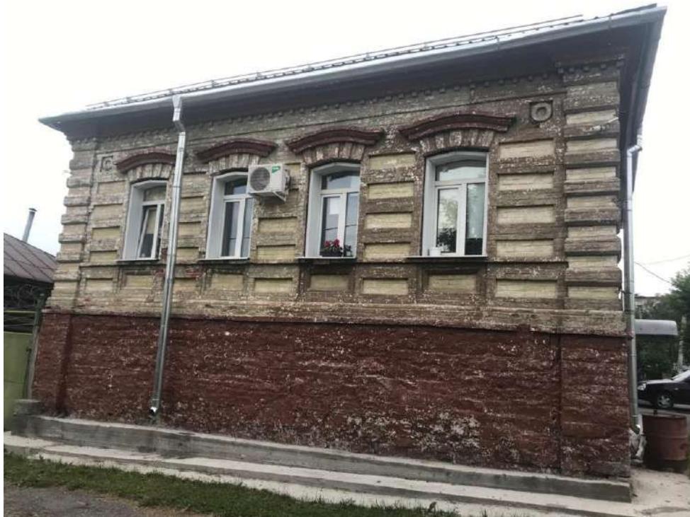
Фото 2. Общий вид здания-памятника «Дом Чижова» с юго-западной стороны. 06.07.2020г.
