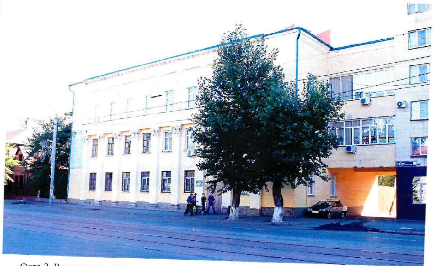
Фото 2. Вид на главный фасад с юга.
