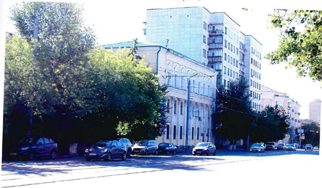
Фото 1. Общий вид на здание. Вид с северо-востока.
