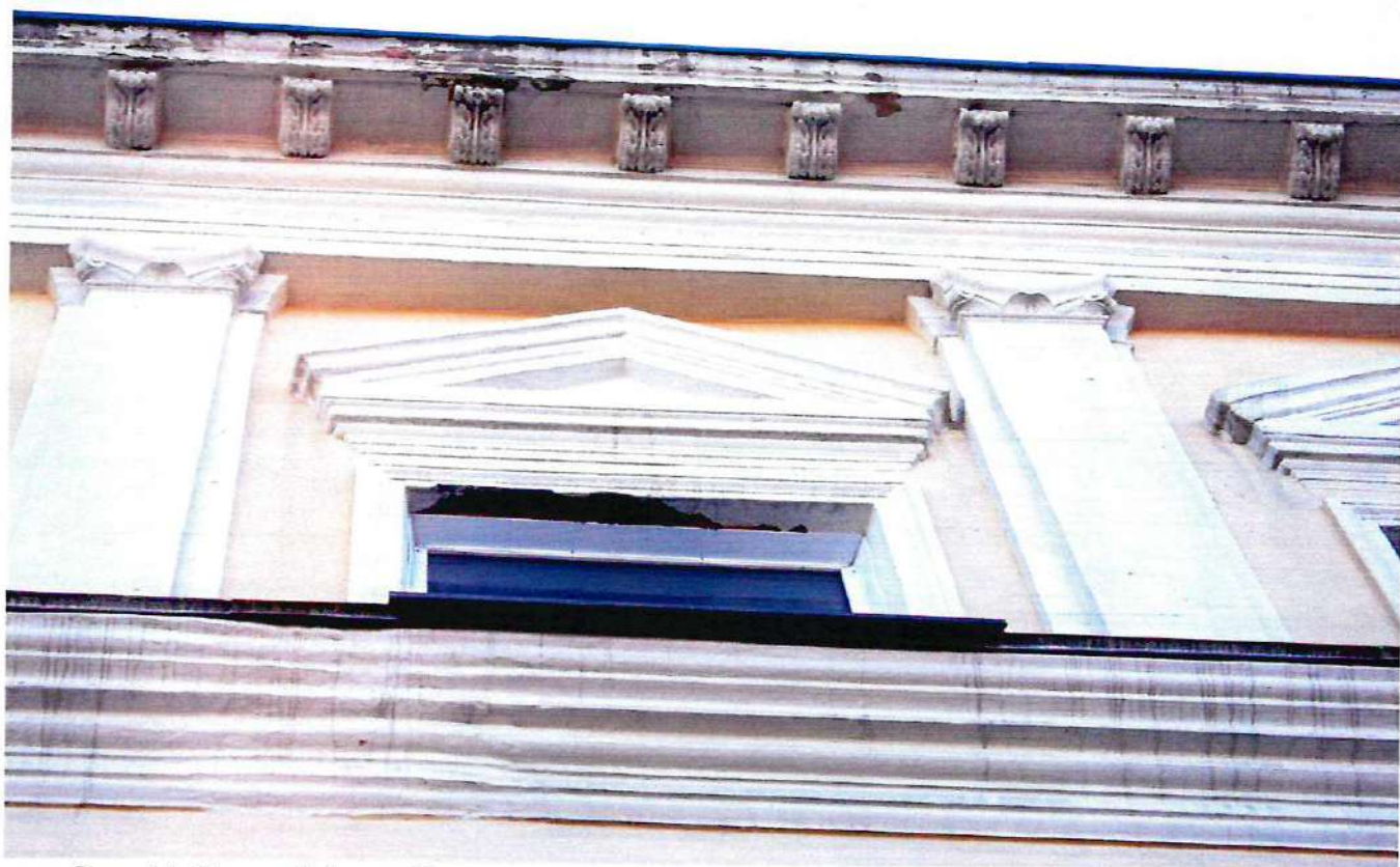
Фото 14. Главный фасад. Вид снизу на верхний ярус: карниз с лепными модильонами, раскрепованные пилястры, сандрик.
