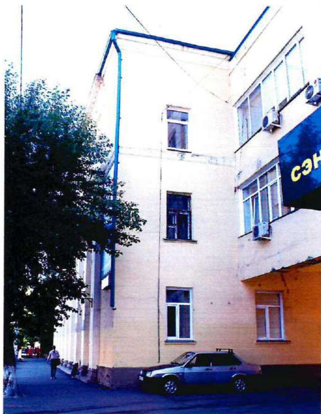
Фото 6. Фрагмент бокового фасада. Вид с юга.
