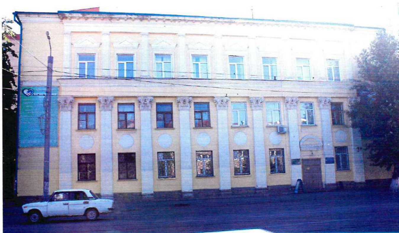
Фото 3. Главный фасад здания.
