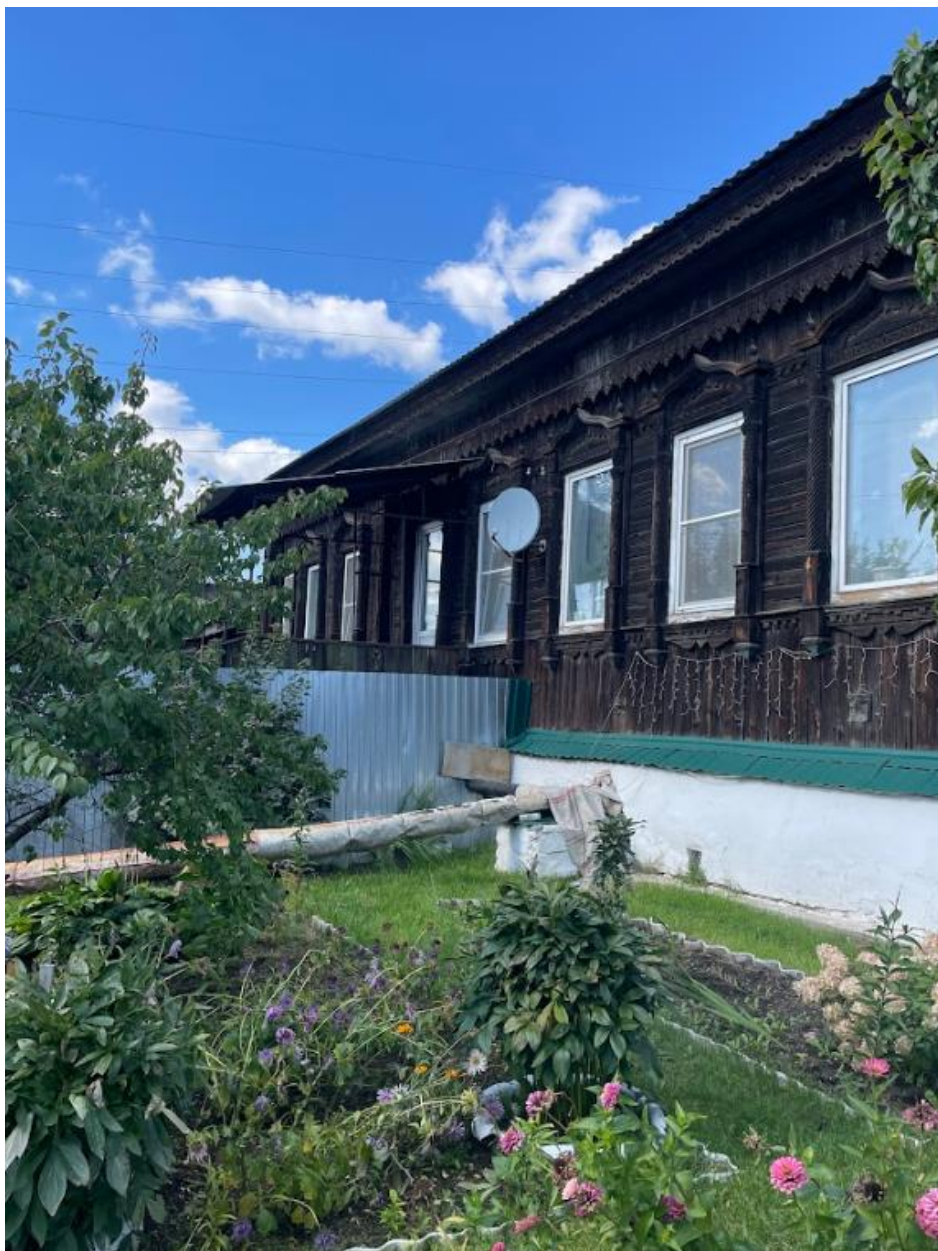
Фото 2. Выявленный объект культурного наследия «Дом жилой», расположенный по адресу: Челябинская область, Кыштымский городской округ, г. Кыштым, ул. Володарского,1. Фрагмент южного фасада выявленного объекта культурного наследия.
