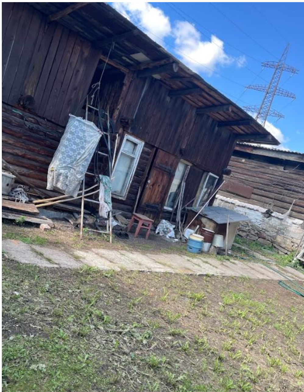
Фото 10. Выявленный объект культурного наследия «Дом жилой», расположенный по адресу: Челябинская область, Кыштымский городской округ, г. Кыштым, ул. Володарского,1. Фрагмент южного фасада выявленного объекта культурного наследия.
