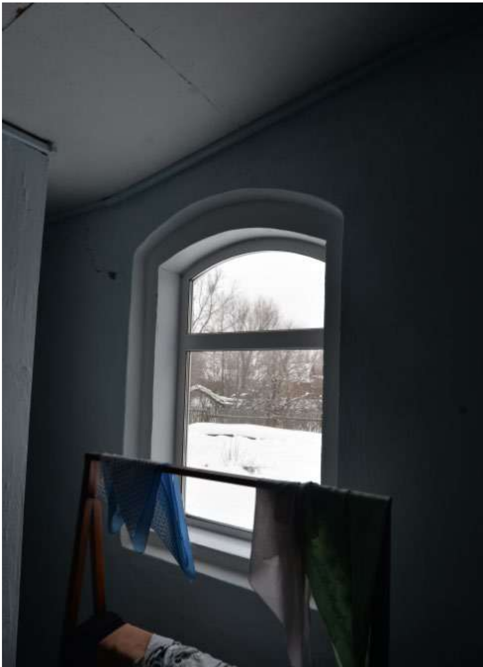
Фото 23. Выявленный объект культурного наследия «Церковь святых апостолов Петра и Павла» по адресу: Челябинская область, г. Аша, ул. Лесная, 6. Интерьер выявленного объекта культурного наследия.
