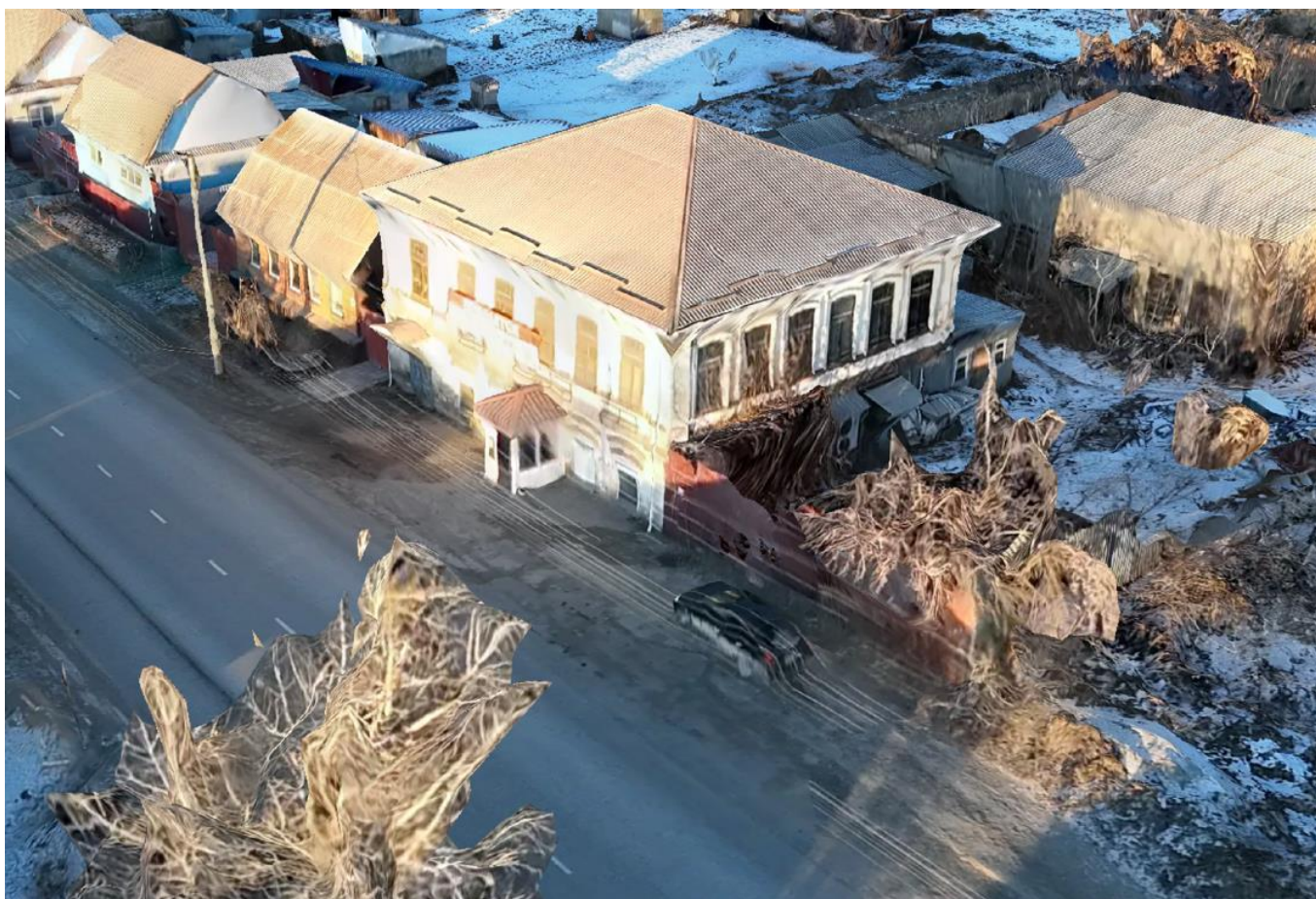
Фото 2. Вид на выявленный объект культурного наследия «Дом жилой 2-этажный каменный», расположенный по адресу: Челябинская область, Миасский городской округ, г. Миасс, Советская ул., 92.
