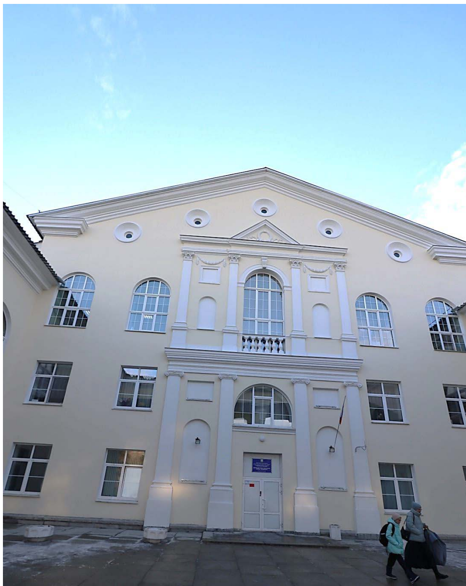
Фото.5 Выявленный объект культурного наследия «Здание дома культуры имени Колющенко», расположенный по адресу: Челябинская область, г. Челябинск, ул. Доватора, 15. Северо-восточный фасад.
