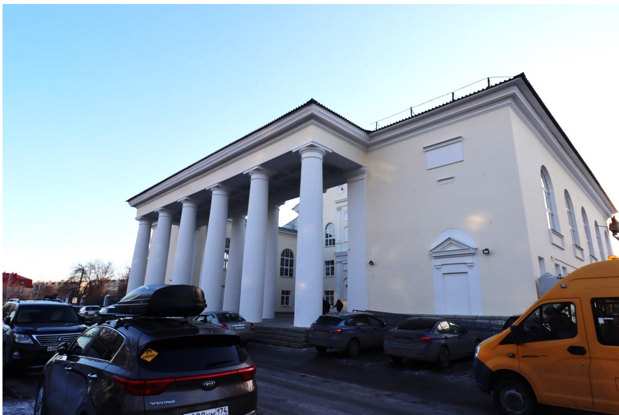
Фото.13 Выявленный объект культурного наследия «Здание дома культуры имени Колющенко», расположенный по адресу: Челябинская область, г. Челябинск, ул. Доватора, 15. Северо-восточный фасад.
