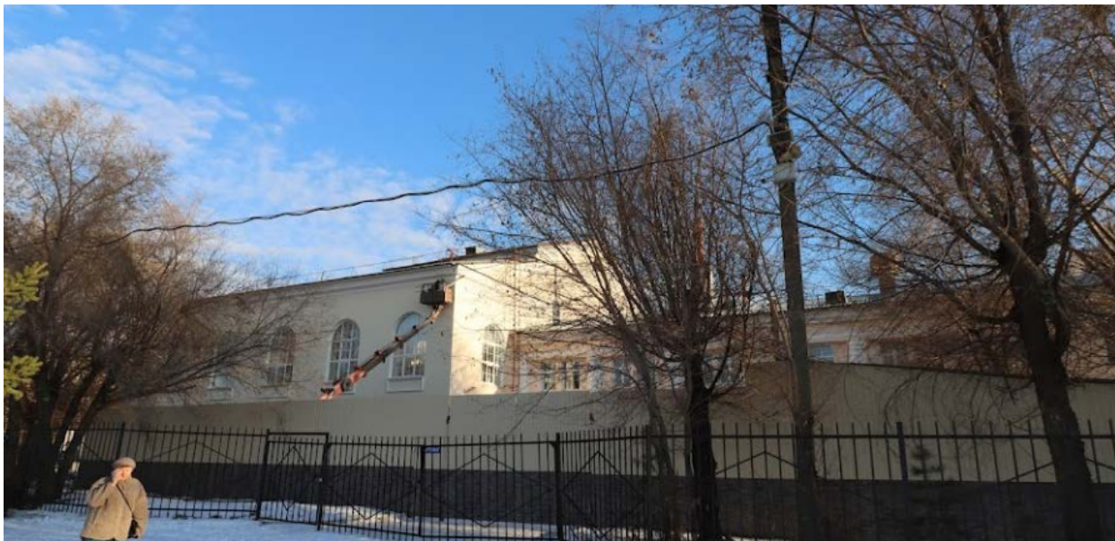
Фото.19 Выявленный объект культурного наследия «Здание дома культуры имени Колющенко», расположенный по адресу: Челябинская область, г. Челябинск, ул. Доватора, 15. Северо-западный фасад.
