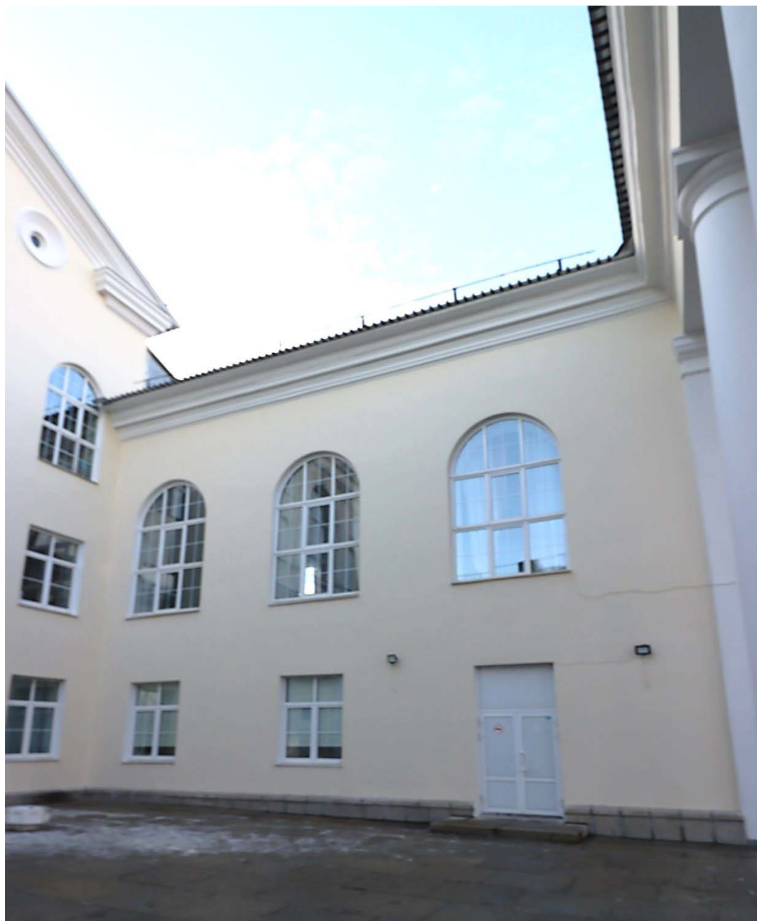
Фото.8 Выявленный объект культурного наследия «Здание дома культуры имени Коллющенко», расположенный по адресу: Челябинская область, г. Челябинск, ул. Доватора, 15. Северо-восточный фасад.
