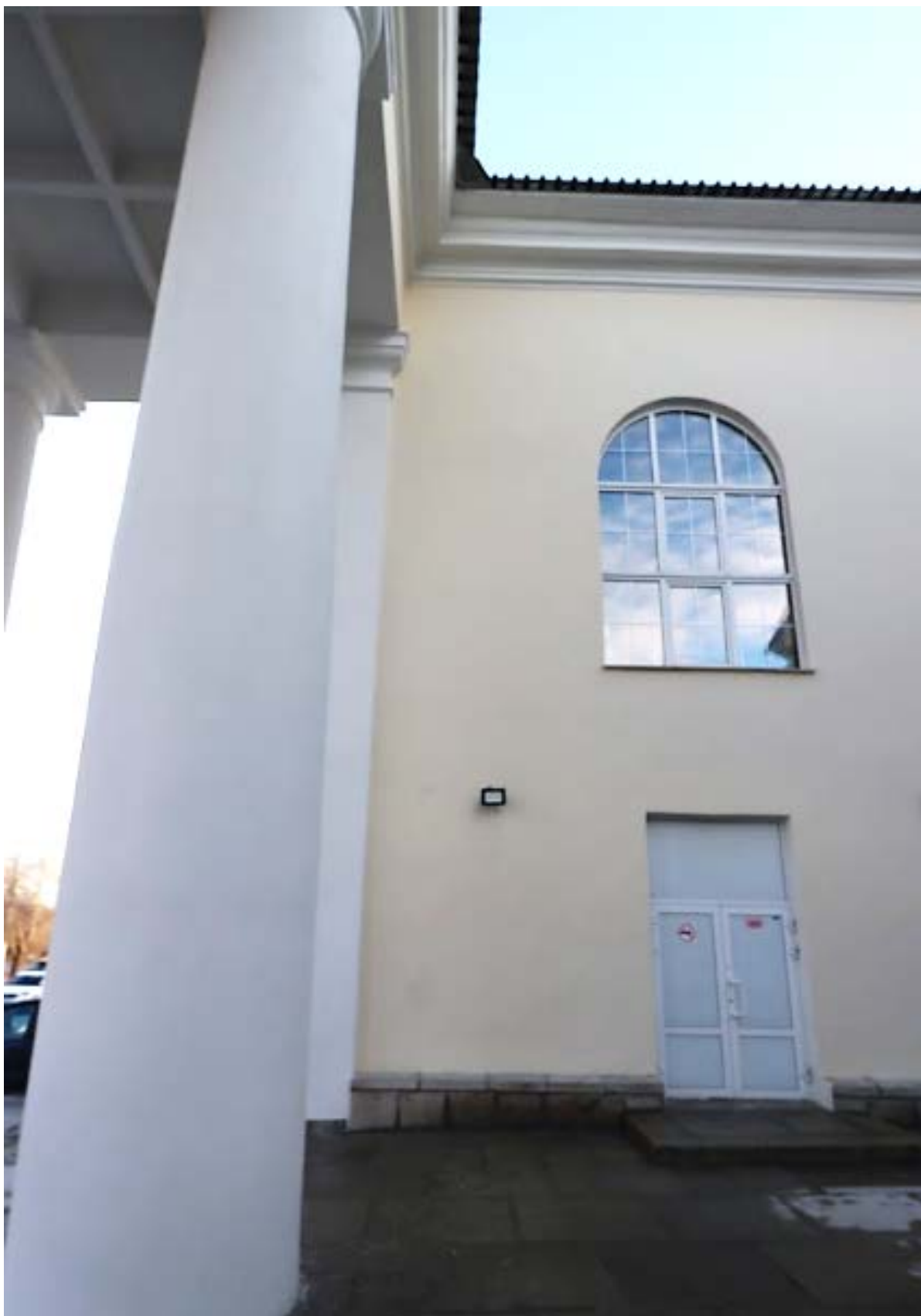
Фото.12 Выявленный объект культурного наследия «Здание дома культуры имени Колющенко», расположенный по адресу: Челябинская область, г. Челябинск, ул. Доватора, 15. Северо-восточный фасад.
