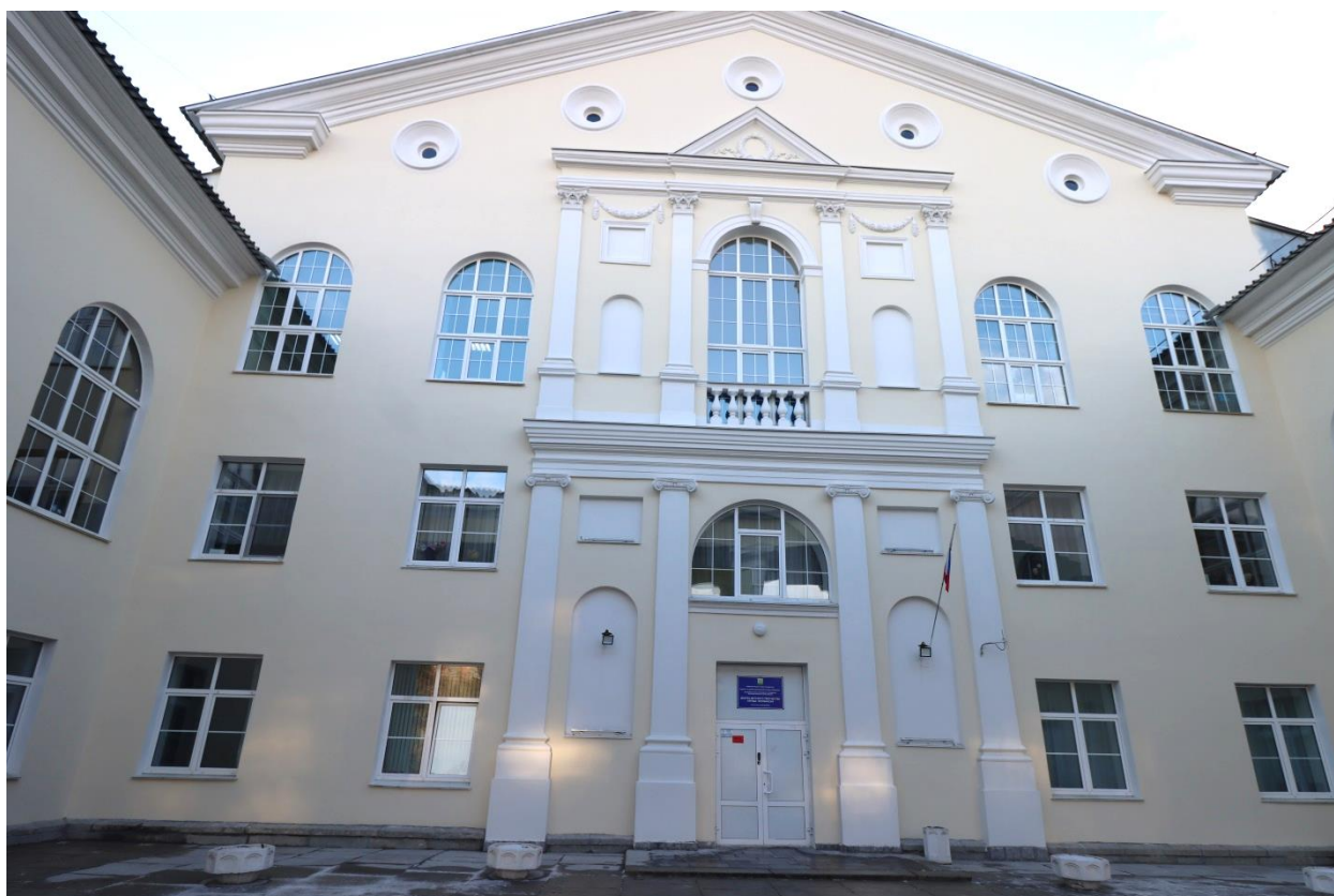
Фото.6 Выявленный объект культурного наследия «Здание дома культуры имени Колющенко», расположенный по адресу: Челябинская область, г. Челябинск, ул. Доватора, 15. Северо-восточный фасад.
