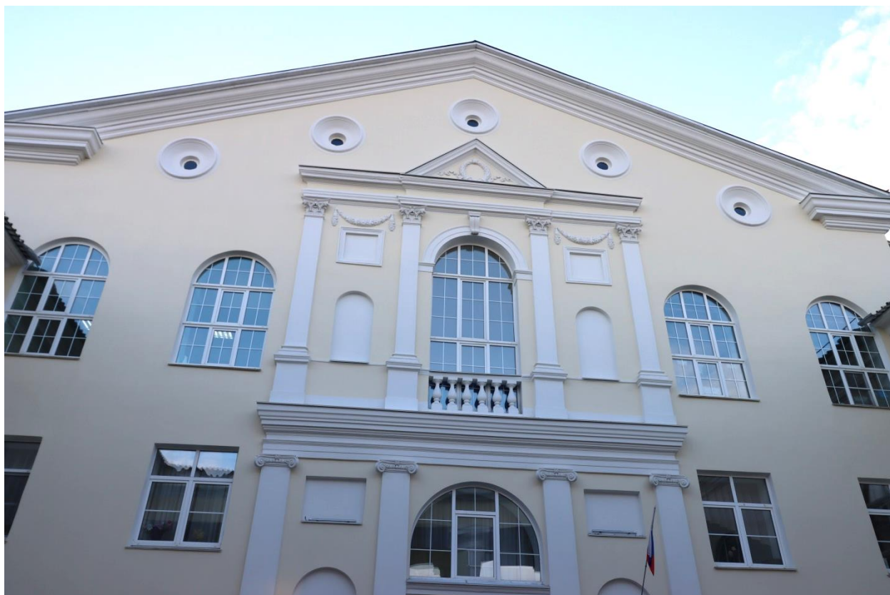
Фото.7 Выявленный объект культурного наследия «Здание дома культуры имени Колющенко», расположенный по адресу: Челябинская область, г. Челябинск, ул. Доватора, 15. Северо-восточный фасад.
