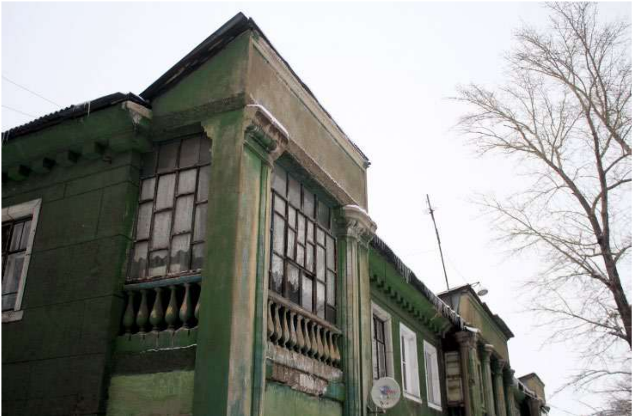
Фото 13. Выявленный объект культурного наследия «Дом жилой многоквартирный двухэтажный» по адресу: Челябинская область, г. Магнитогорск, ул. Бибишева, 16. Фрагмент восточного фасада выявленного объекта культурного наследия.
