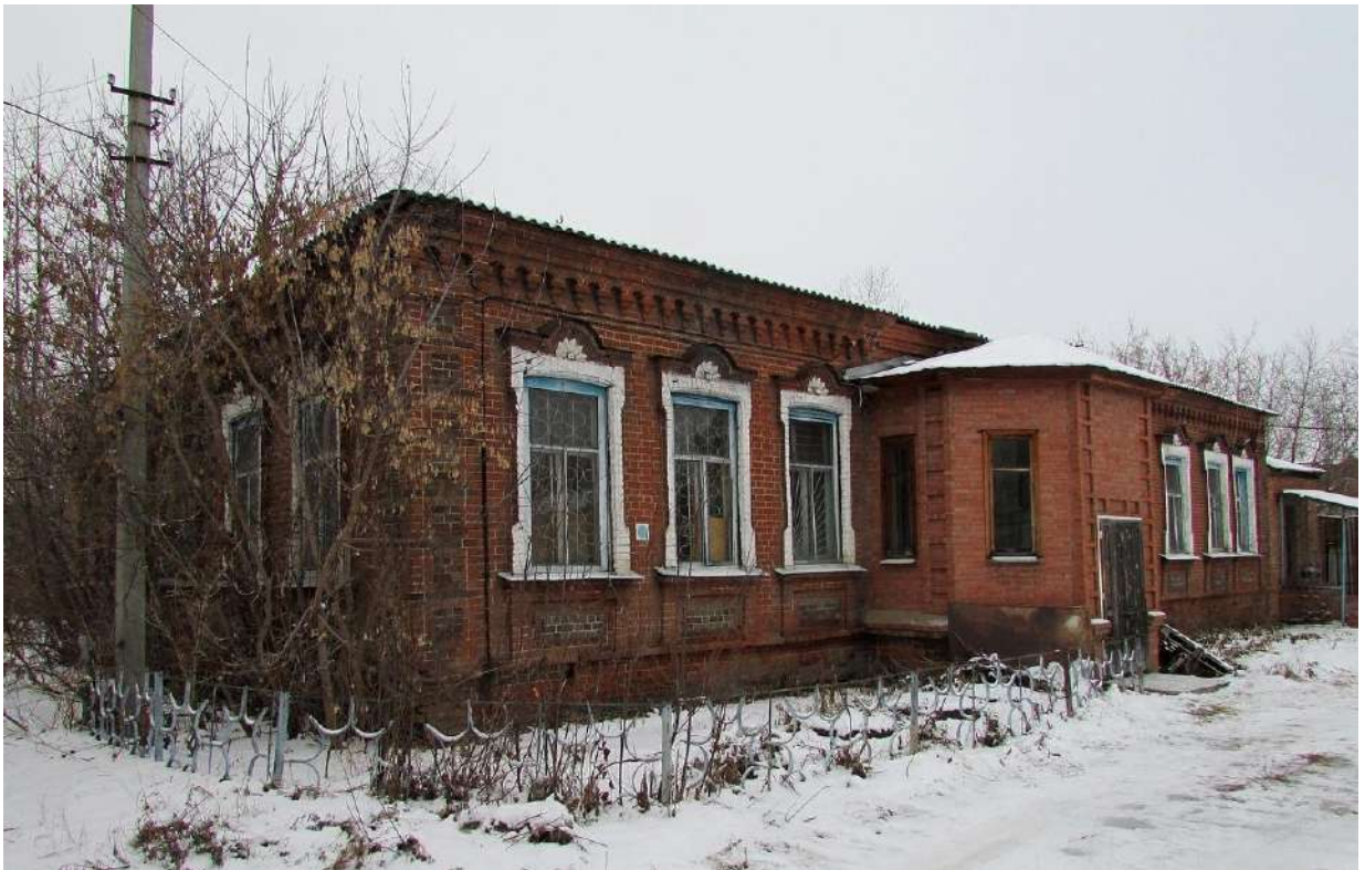
41. Главный фасад с поздним тамбуром здания конторы бывшего пивоваренного завода Я.Э.Зуккера (Фото – 2021г.). Ссылка: https://avatars.mds.yandex.net/get-zen_doc/1640581/pub_6182a8ec4598a221ee420be1_6182abbe7b6ef47a60d1d6a7/scale_2400 .
