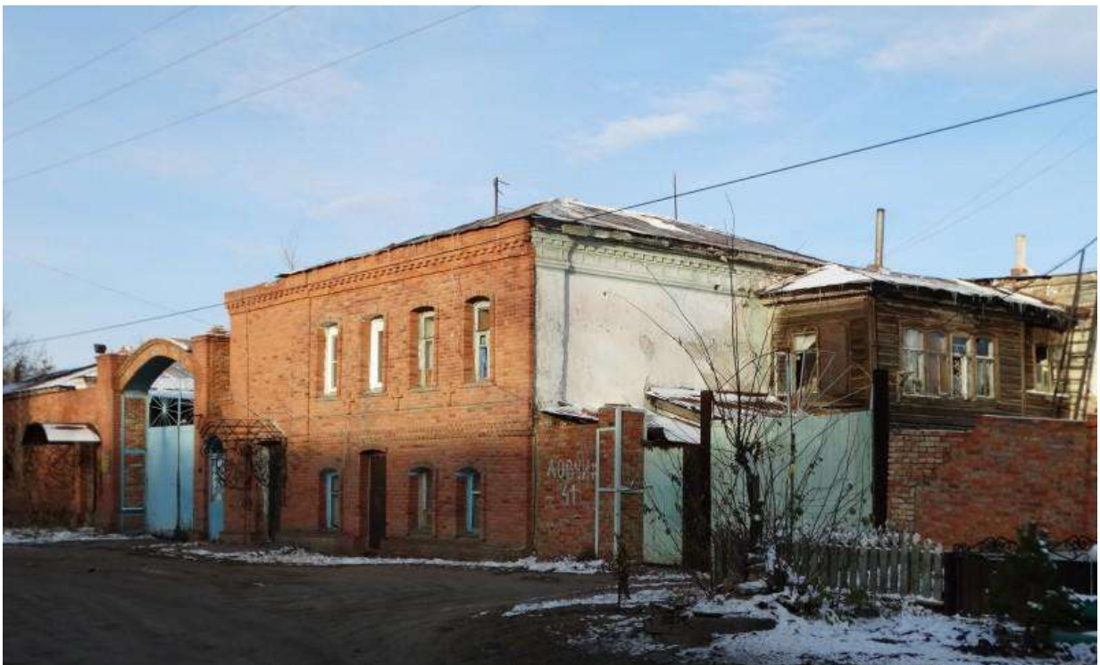
58. Исторический главный фасад с поздними кирпичными стенами и фрагмент исторического северо-восточного фасада жилого дома (особняка) Зуккера. (Фото – 2019 г., автор – Ю.Латышев). Ссылка: https://ic.pics.livejournal.com/yuvlatyshev/22714000/4773492/4773492_800.jpg .
