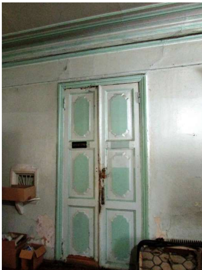
47. Деревянная филенчатая двухстворчатая дверь помещений здания конторы бывшего пивоваренного завода Я.Э.Зуккера (Фото - февраль 2022г., автор Маевская Т.И.).
