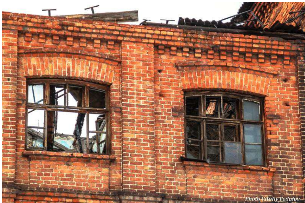
21. Окна главного фасада варочного цеха бывшего пивоваренного завода Я.Э. Зуккера (фото – 2017 г., автор – В.Федулов). Ссылка: https://ic.pics.livejournal.com/yuvlatyshev/22714000/4763223/4763223_800.jpg .
