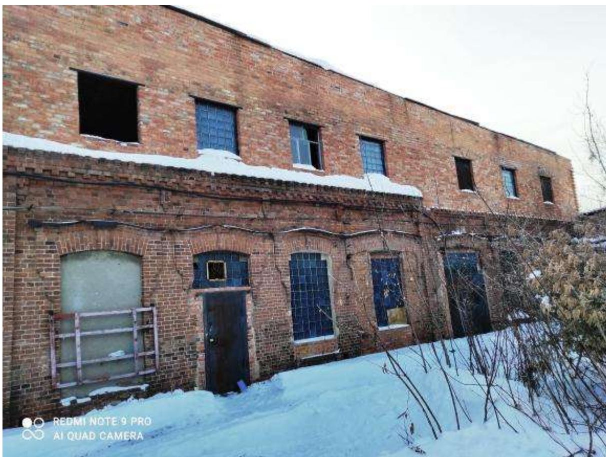
14. Задний северо-западный фасад цеха розлива бывшего пивоваренного завода Я.Э. Зуккера (Фото - февраль 2022г., автор Дьячков А.Н.).
