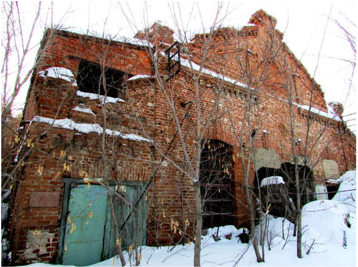
22. Главный фасад здания котельной бывшего пивоваренного завода Я.Э. Зуккера (Фото - февраль 2022г., автор Маевская Т.И.).
