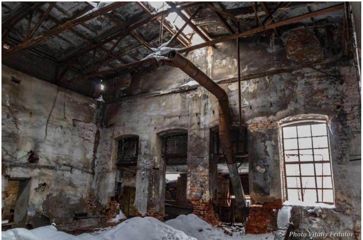
27. Фрагмент помещения котельной с лучковыми окнами бывшего пивоваренного завода Я.Э. Зуккера (фото – 2017 г., автор – В.Федулов). Ссылка: https://ic.pics.livejournal.com/yuvlatyshev/22714000/4768785/4768785_800.jpg .
