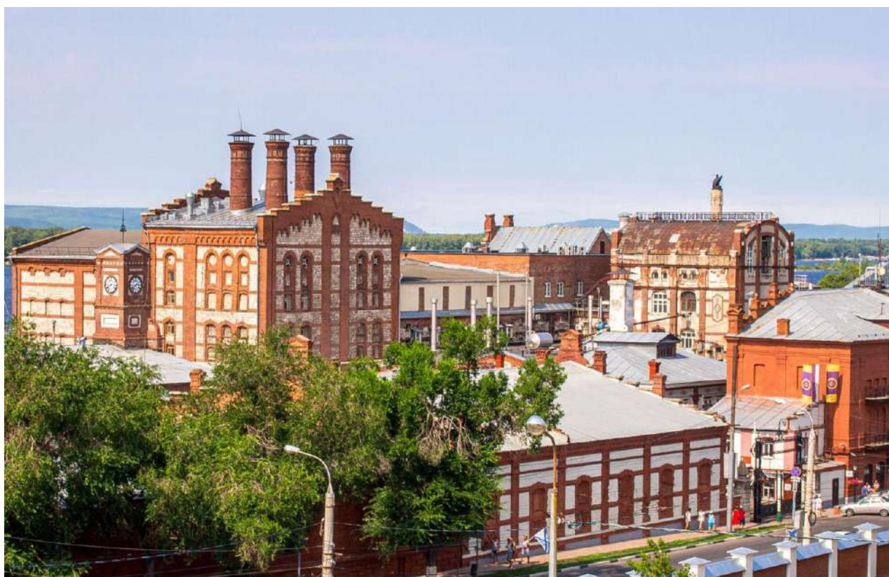
Рис.54. г.Самара. Вид на комплекс зданий Жигулёвского пивоваренного завода (Фото – 2018 г.). Ссылка: https://tybins.ru/wp-content/uploads/2020/02/P7295619-840x630.jpg .
