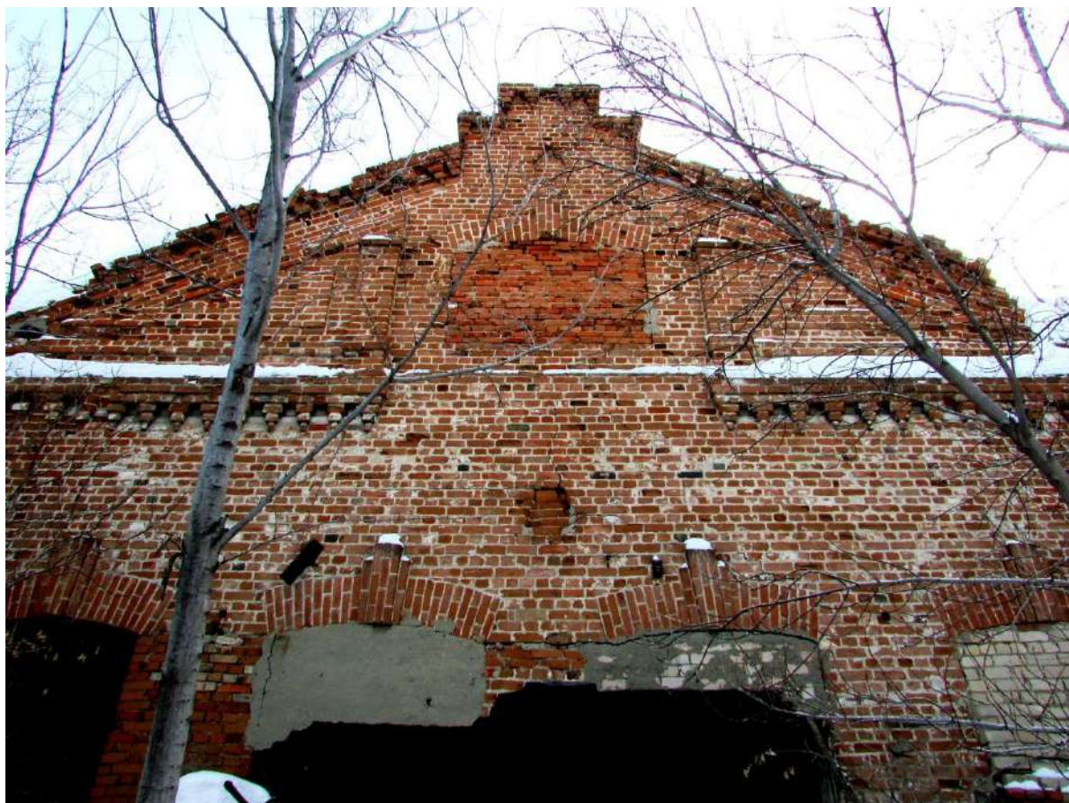
24. Фрагмент главного фасада с аттиком здания котельной бывшего пивоваренного завода Я.Э. Зуккера (Фото - февраль 2022г., автор Маевская Т.И.).
