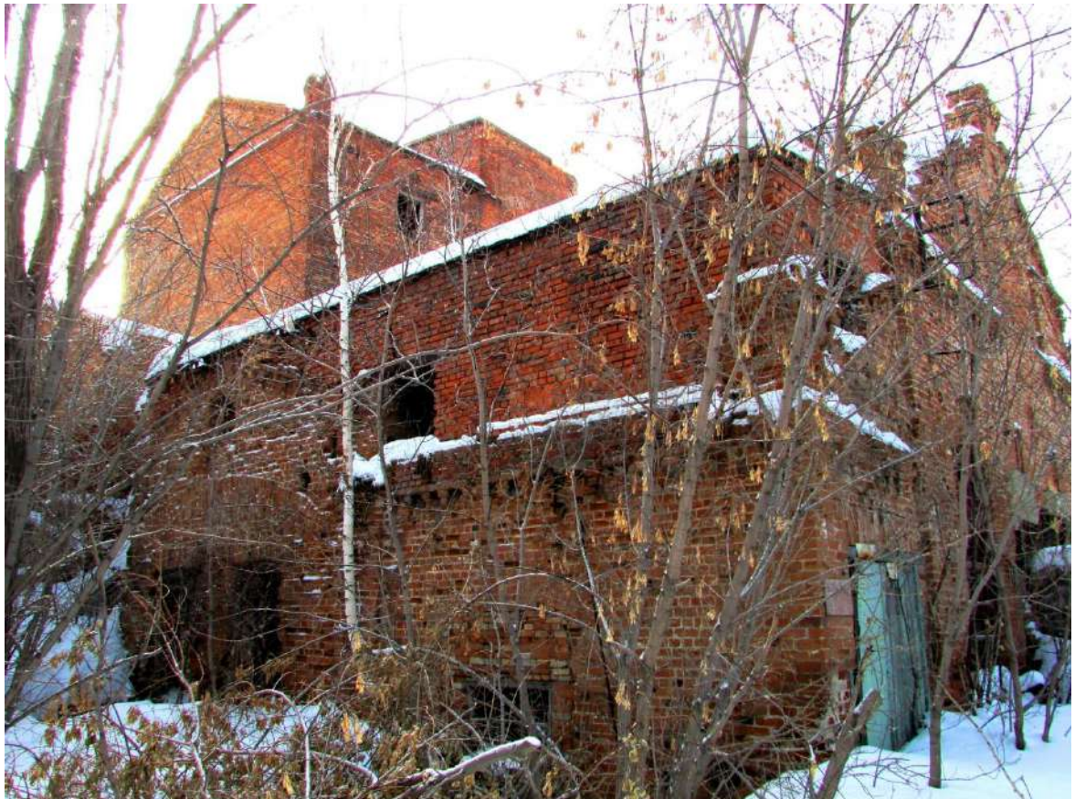
23. Боковой северо-восточный фасад здания котельной бывшего пивоваренного завода Я.Э.Зуккера (Фото- февраль 2022г., автор Маевская Т.И.).
