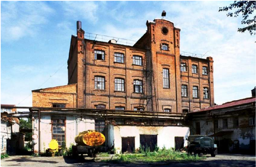
Рис.43. Вид на здание варочного цеха пивного завода Э.Я.Зуккера, г.Троицк (Фото – 19 июля 2003 г., автор – У.Брумфилд). Ссылка: http://cultinfo.ru/brumfield/photoarchive/chelyabinsk_troitsk/brumfieldchel-22-23_10173_b.htm .
