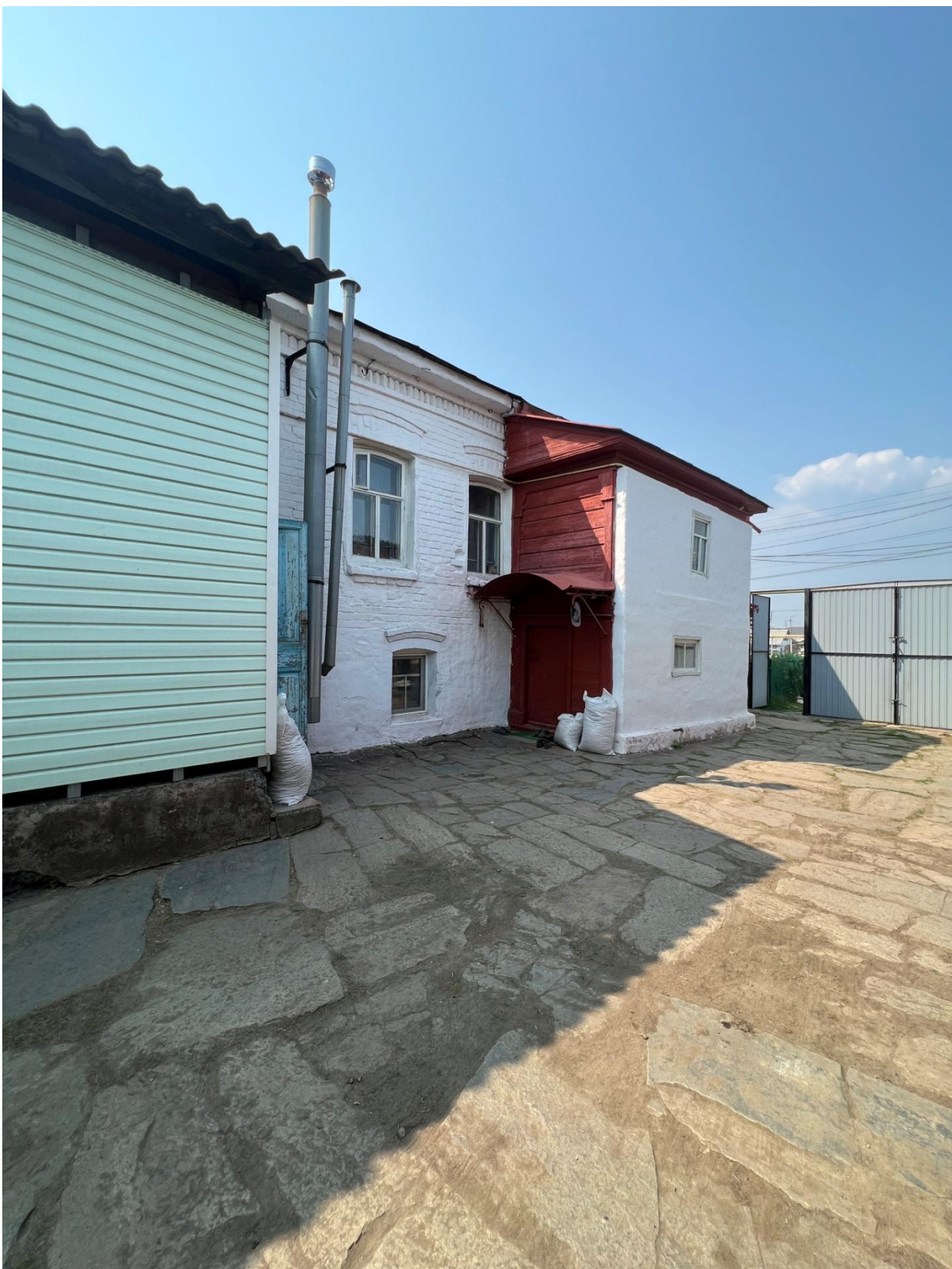
Рис. 10. Боковой, северный фасад
