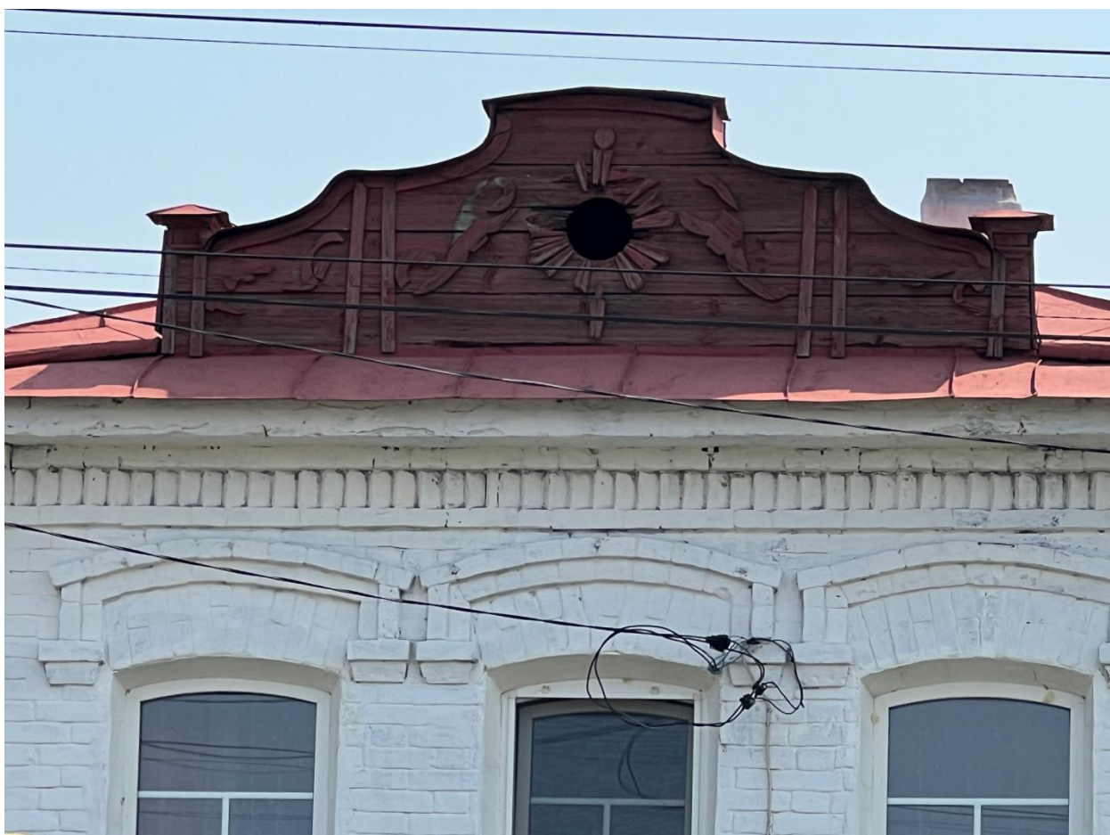
Рис. 7. Парапетная стенка над кровлей со стороны лицевого, западного фасада
