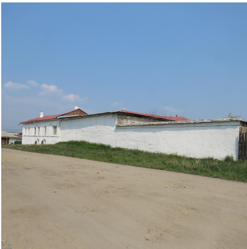
Рис. 8 а, б. Боковой, южный фасад с примыкающим с востока объемом хозяйственной постройки (литера «Г» технического плана) и брандмауэрной стеной
