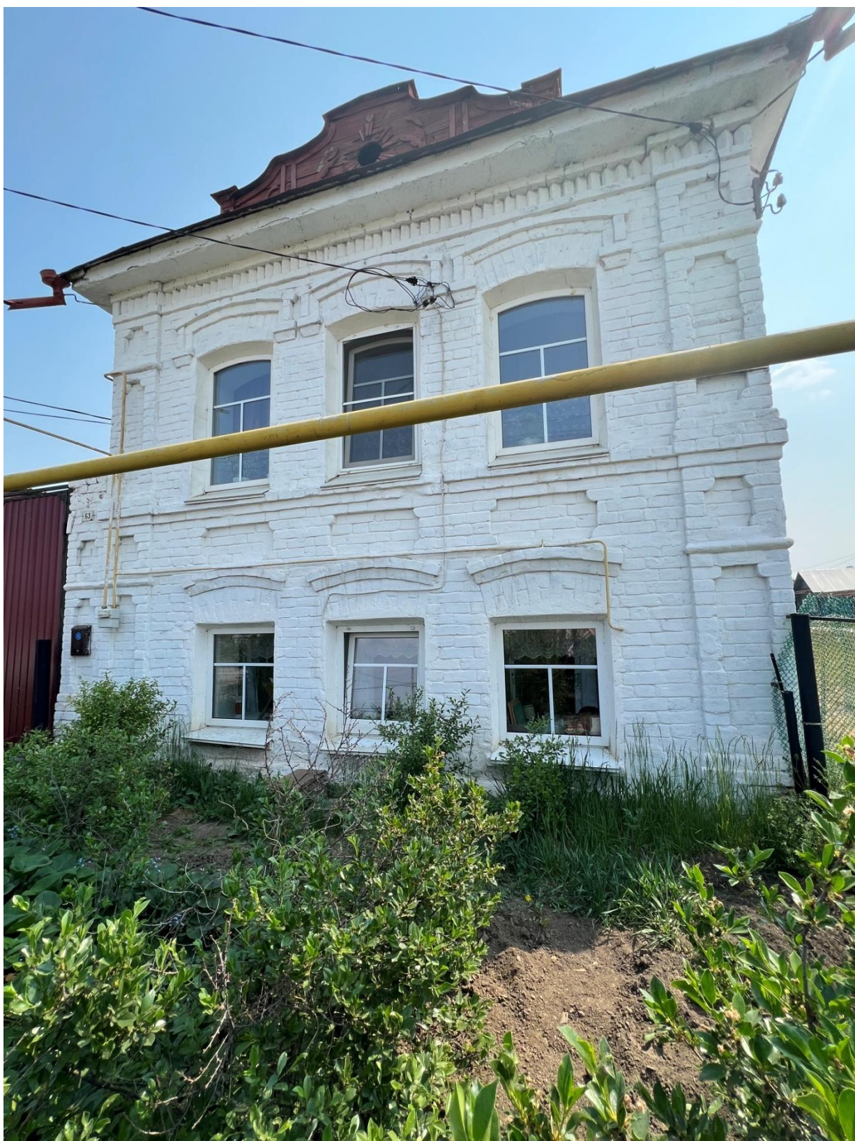
Рис. 5. Главный, западный фасад
