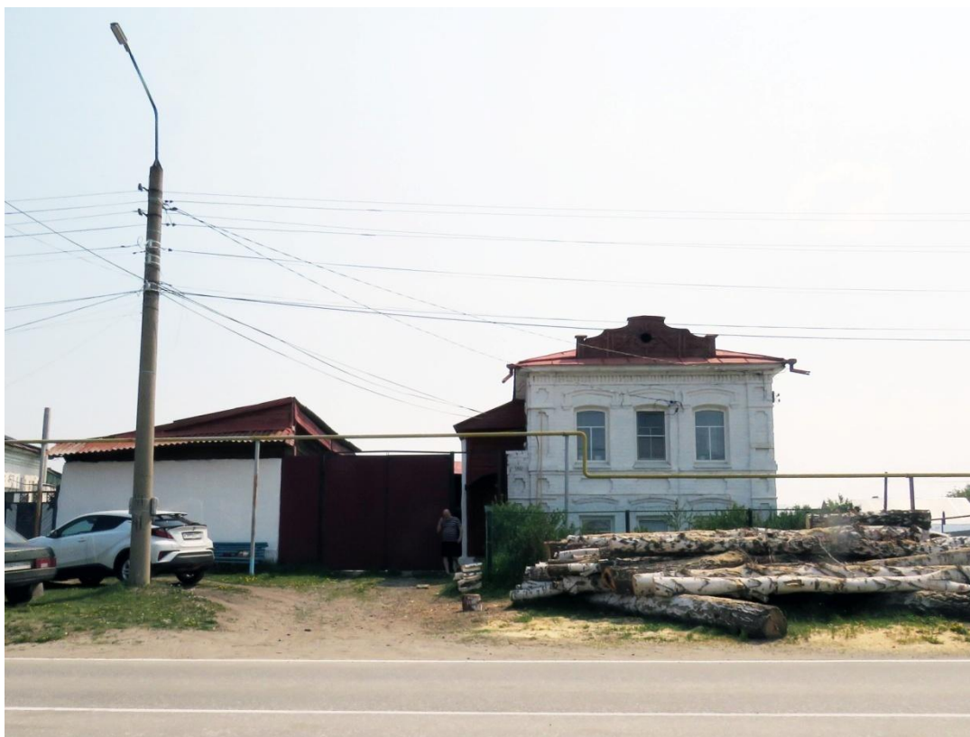
Рис. 3. Вид усадебного комплекса со стороны ул. Энгельса
