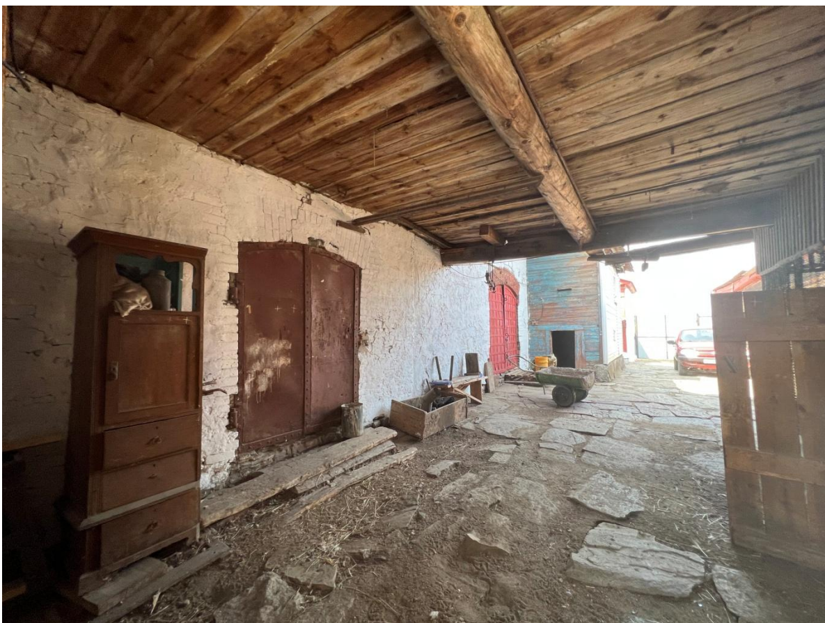
Рис. 13 а, б. Хозяйственная постройка, примыкающая к жилому дому со стороны восточного фасада (литера «Г» технического плана). Дворовый, северный фасад
