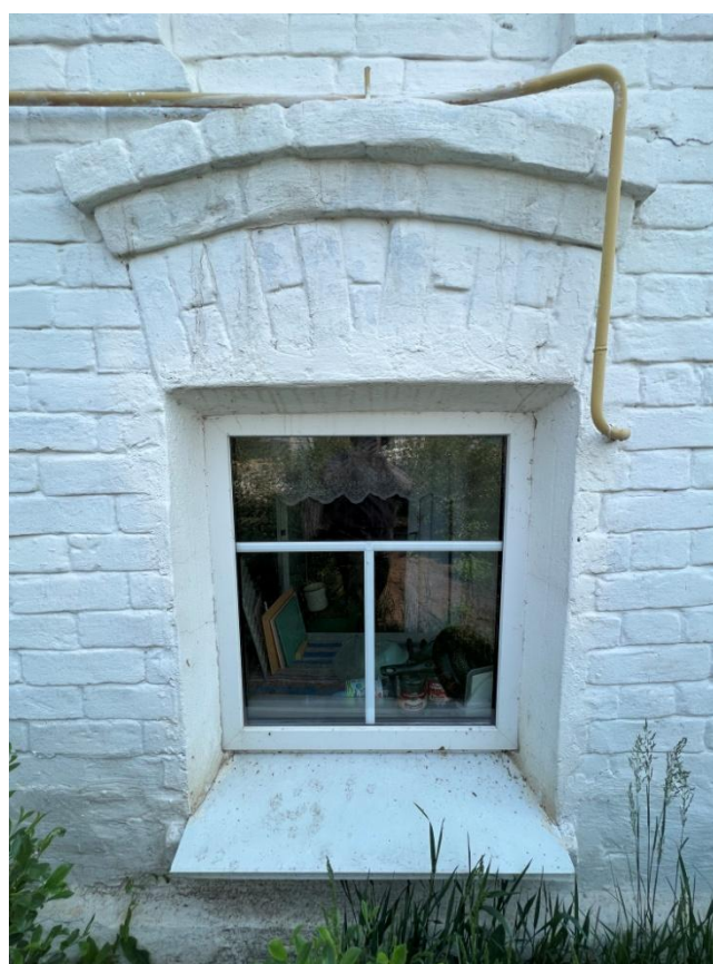
Рис. 6 а, б. Фрагмент главного, западного фасада. Решение оконных проемов первого (внизу) и второго (вверху) этажей
