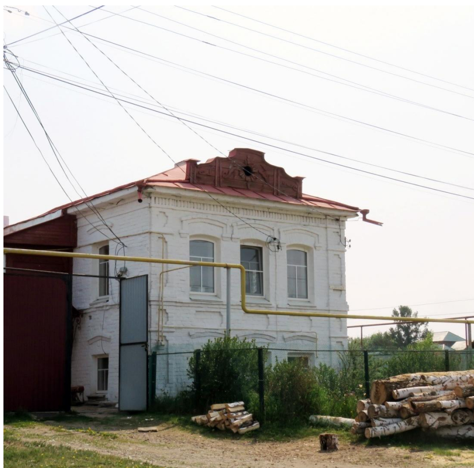
Рис. 4. Главный, западный фасад
