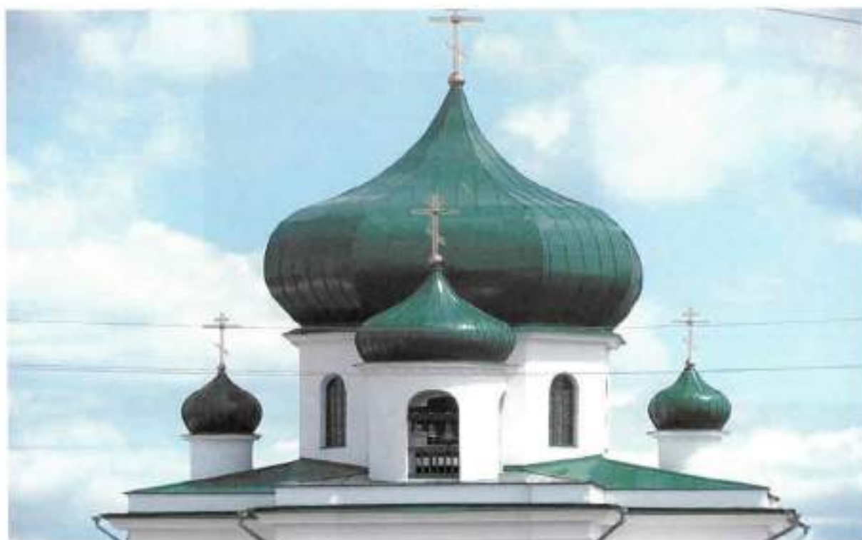
Фото 7. Вид на купола храма с запада
