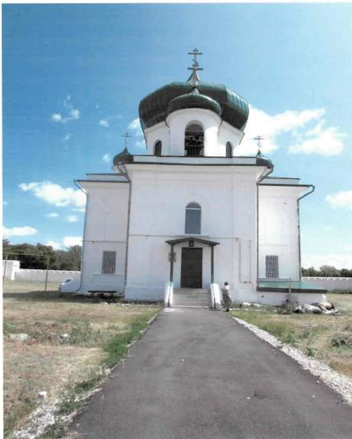
Фото 4. Вид на церковь с запада
